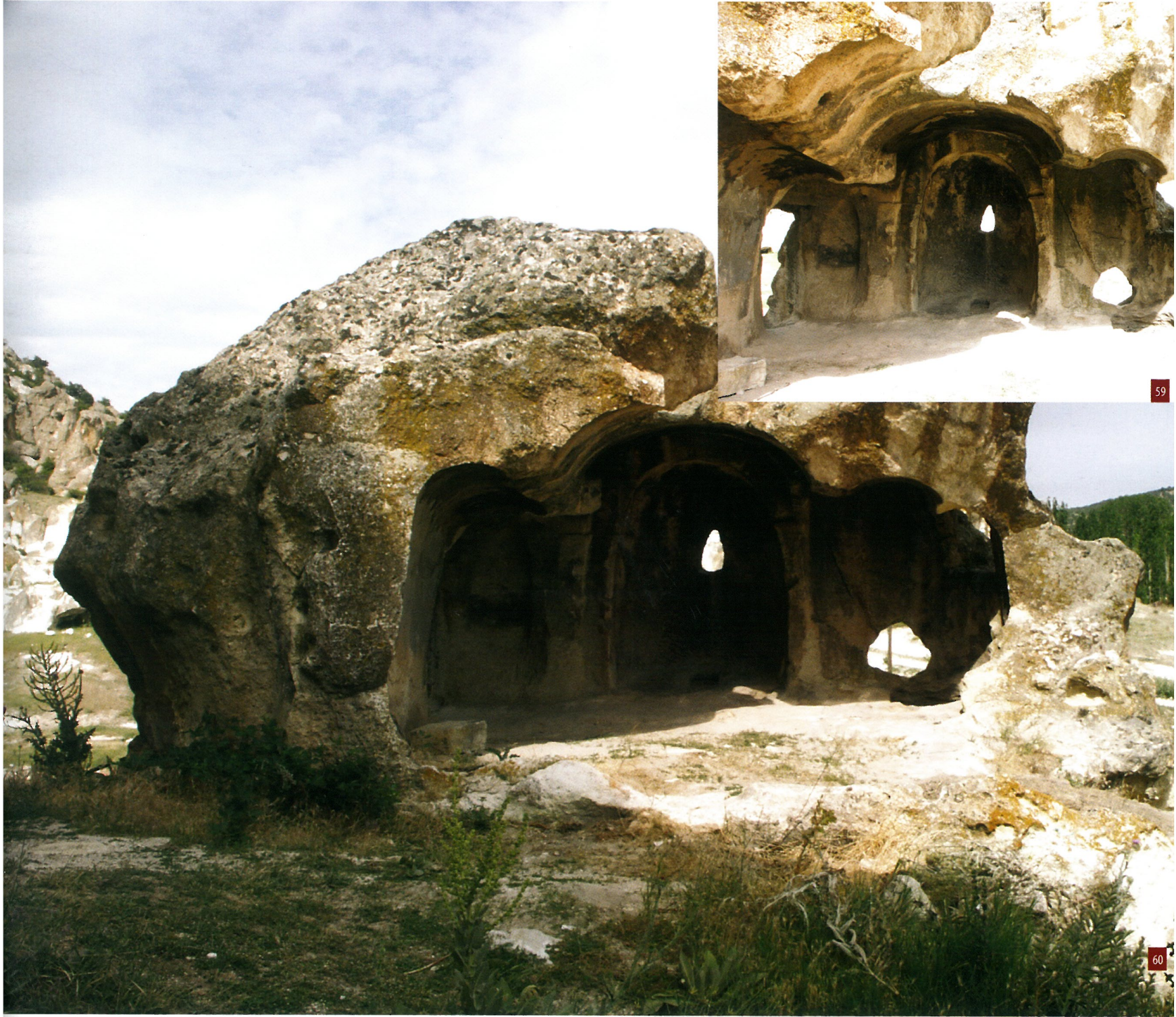
58. Afyonkarahisar/lhsaniye/ Ayazın, Ayazın C Kilisesi apsis batıdan görünüş 59. Afyonkarahisar/lhsaniye/ Ayazın, Ayazın C Kilisesi apsis cephesi batıdan görünüş 60. Afyonkarahisar/lhsaniye/ Ayazın, Ayazın C Kilisesi batıdan görünüş
