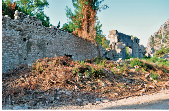
Res. 5 Episkopeion kuzey cephesi
