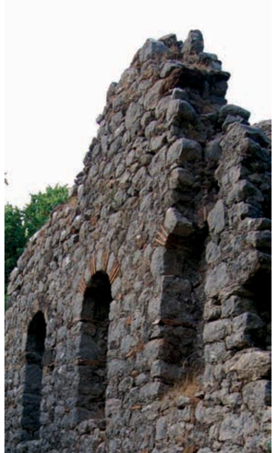
Res. 2 Peristyl doğu duvar üzerindeki nişler
