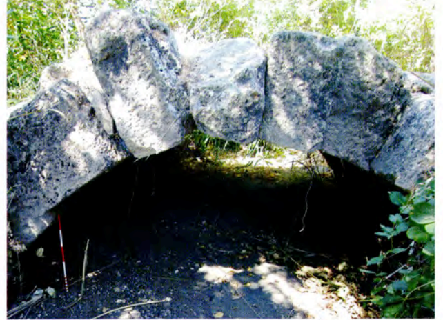
Resim 40: Bedirbey Köyü, Köprü kemeri
