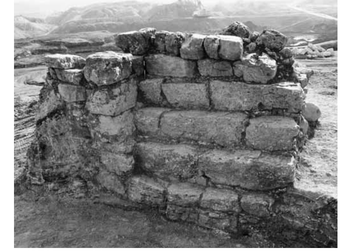
Fig. 3 Batı Yamaçta Bulunan Su Yapısı Kalıntısı
