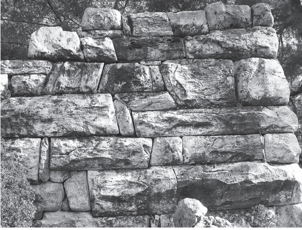
Fig. 2 Kadikulesi Tepesi'ndeki Kapı Kulesi Duvar Detayı
