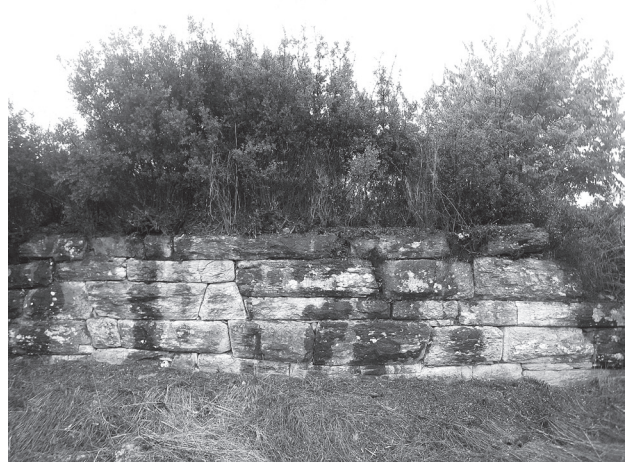
Fig. 3 Aşağı Kent Kuzey Sur Duvarı'ndan Detay
