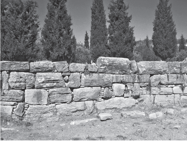
Fig. 4 Aşağı Kent Batı Sur Duvarı'ndan Detay
