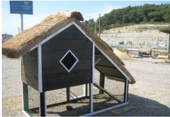
Fotoğraf: 6-7-8:Çatı ve terasta pres kamış kaplama “yedirme kamış”, şemsiye ve çatı uygulaması 1 .
