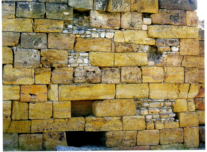
Fig. 11 Hamamda yapılan tadilatlar
