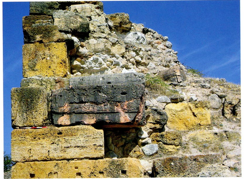
Fig. 12 Hamamda yapılan tadilatlar
