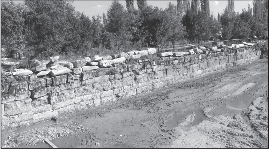
Resim 4: Penkalas Projesi. Taşkın koruma duvarı dolgu toprağı alındıktan sonra.
