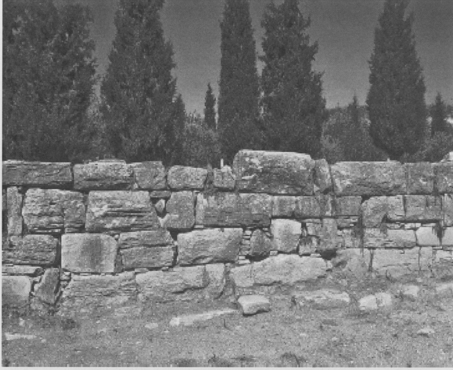
Fig. 4 Aşağı Kent Batı Sur Duvarı'ndan Detay
