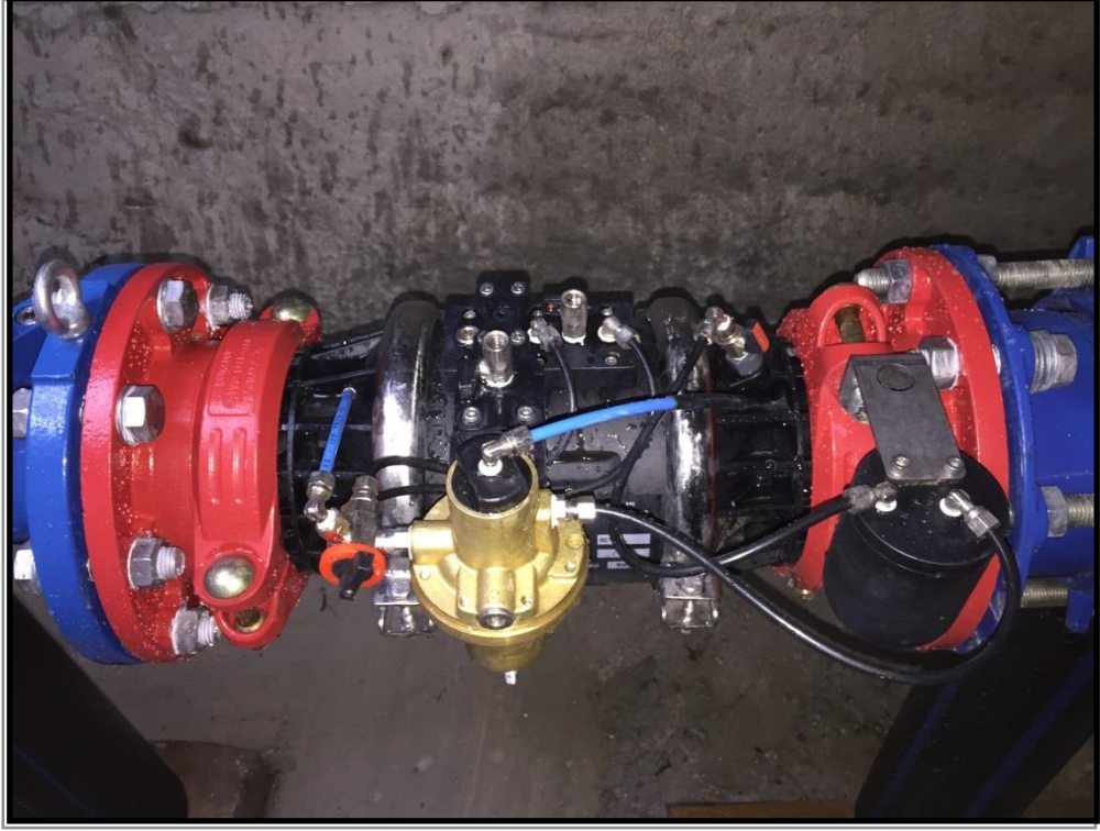
Şekil 4.2: Basınç düzenleyici kontrol vanası
