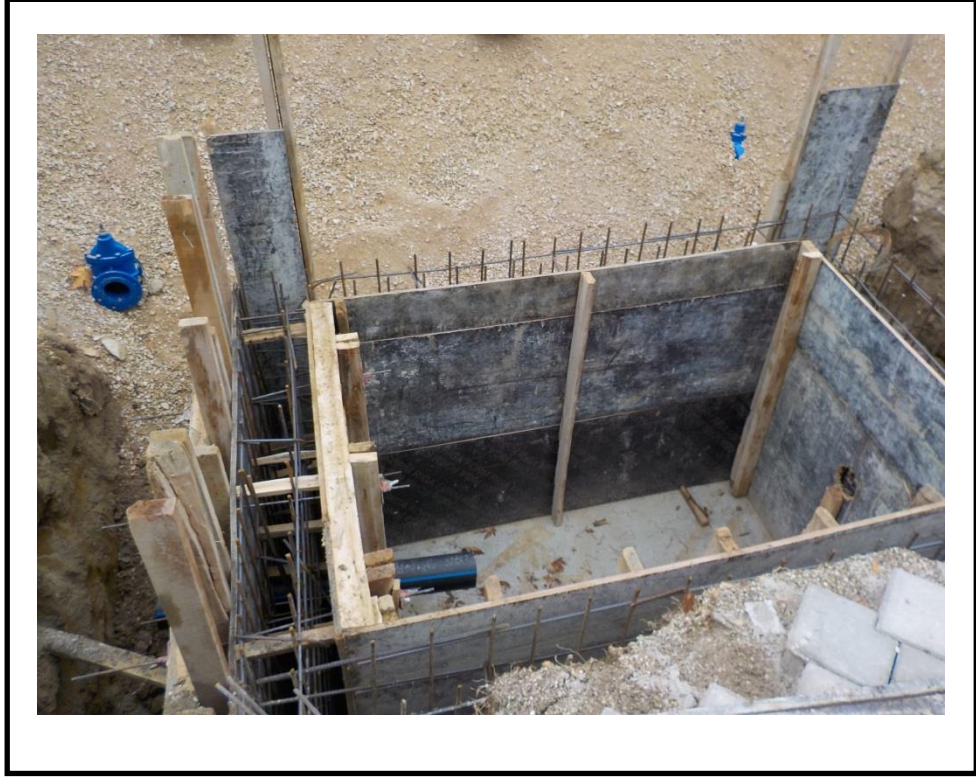
Şekil 4.6: AÖB oda inşaatının temel ve perde duvarları
