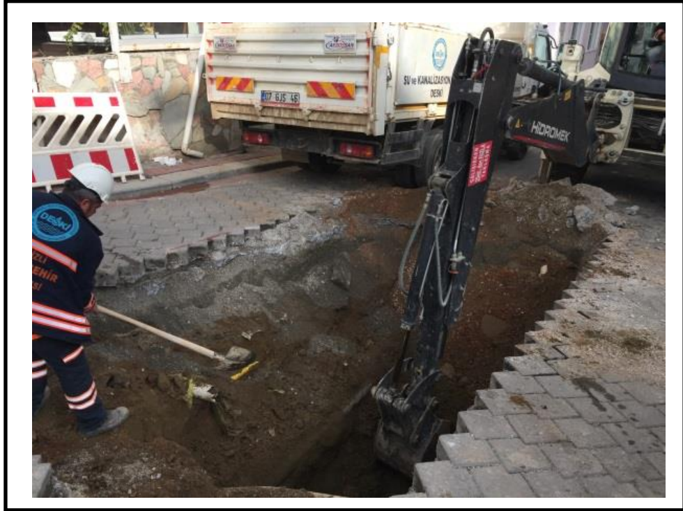
Şekil 4.5: AÖB oda inşaatı için yapılan kazı çalışması
