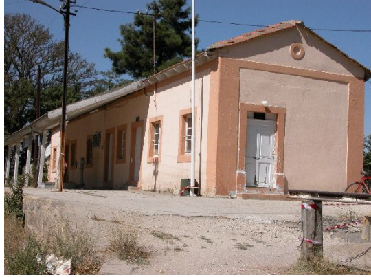
Bozkurt (Hamidiye) Çavuş Lojmanı ve Amele Koğuşu Binası
