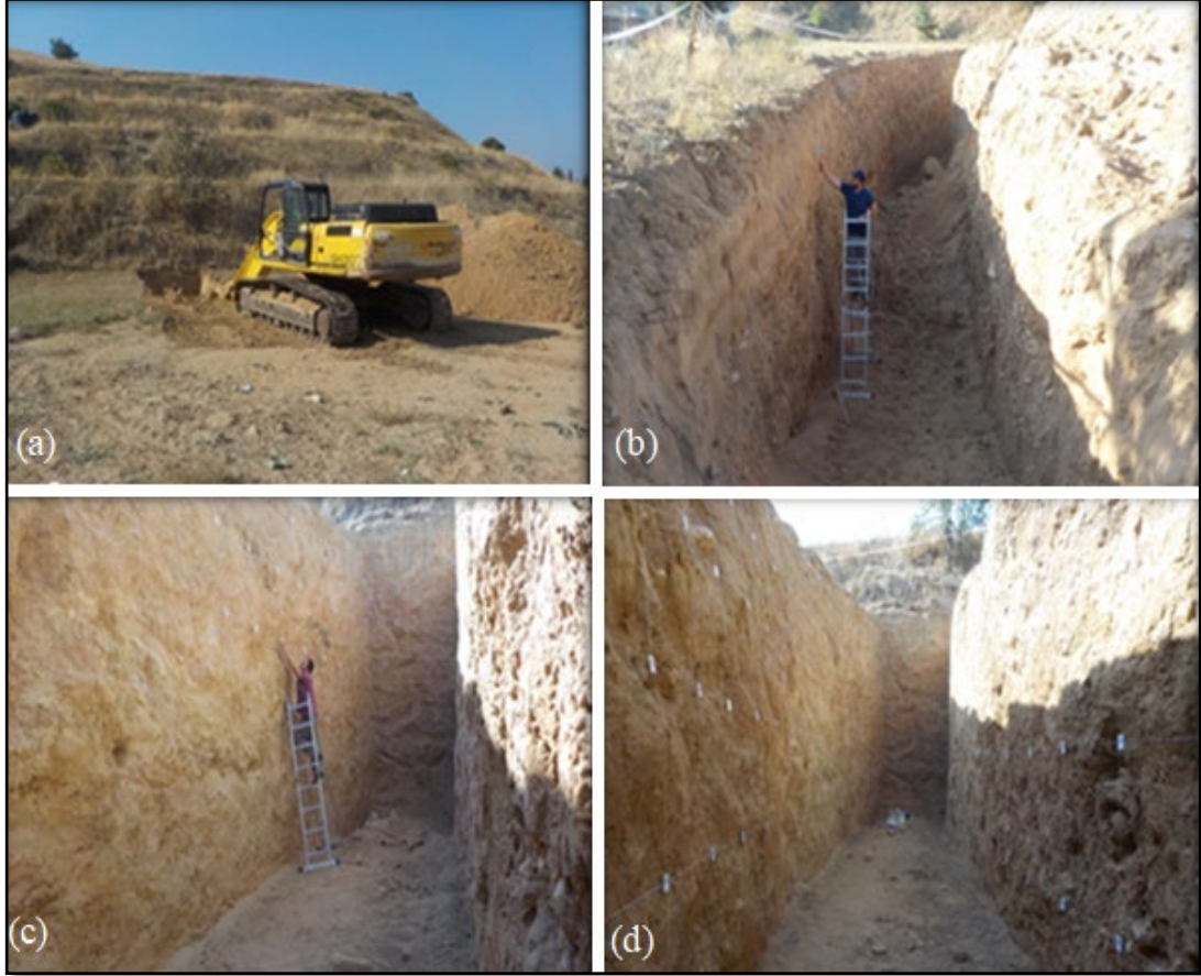
Şekil 1.4: a) Paletli ekskavatör ile hendek açma işlemi, b) Hendek duvarlarının temizlenmesi, c) Hendek duvarların karelajlanması, d) Duvarların karelajlanmış hali.
