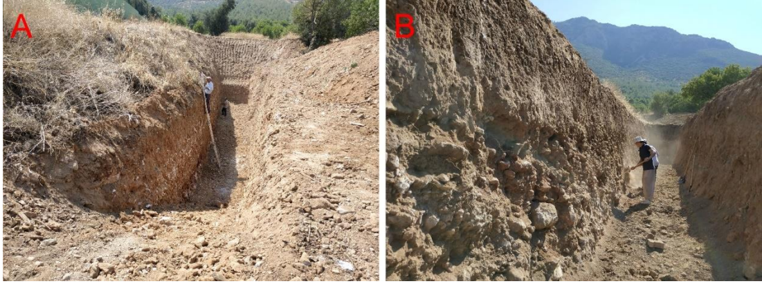
Şekil 5.6: Hendek tesviye çalışmaları A) Kozlupınar Hendeği-1, B) Kozlupınar Hendeği-2.
