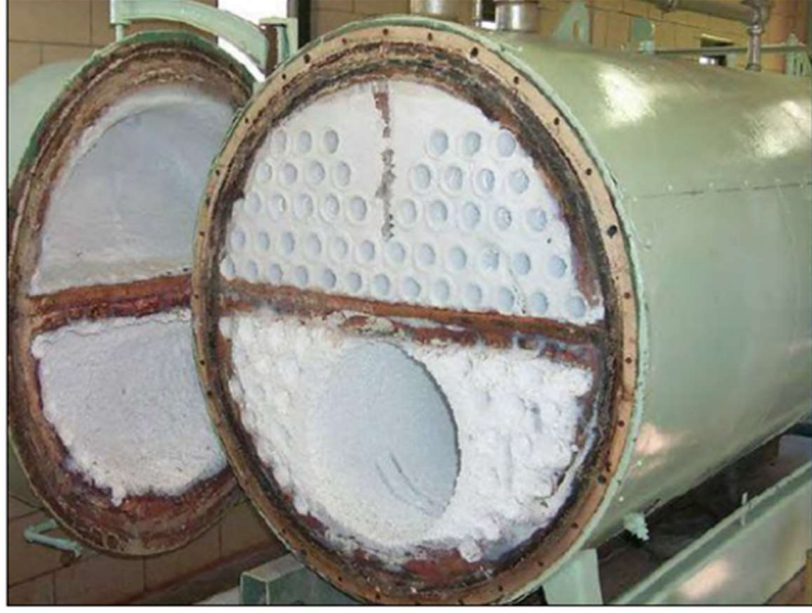
Şekil 1.2: Kazan içerisinde silika depozit birikimi (Dewil ve diğ. 2006)
