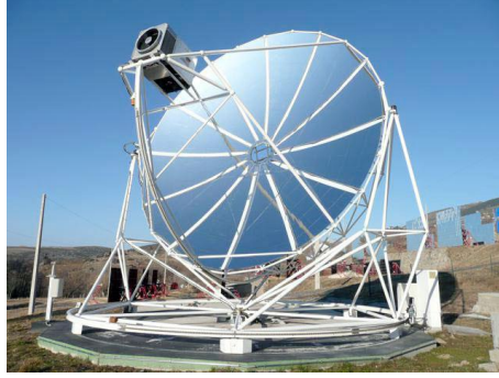
Şekil 4.11: Parabolik çanak yoğunlaştırıcı (Url-11 2019).
