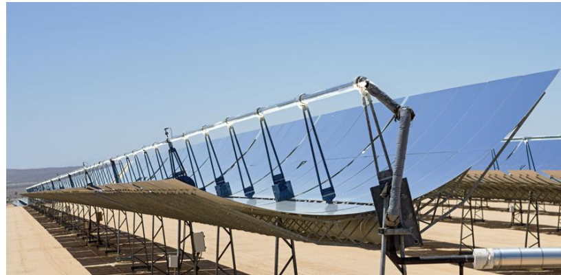
Şekil 4.8: Parabolik oluk tipi güneş kolektörleri (Url-10 2019)
