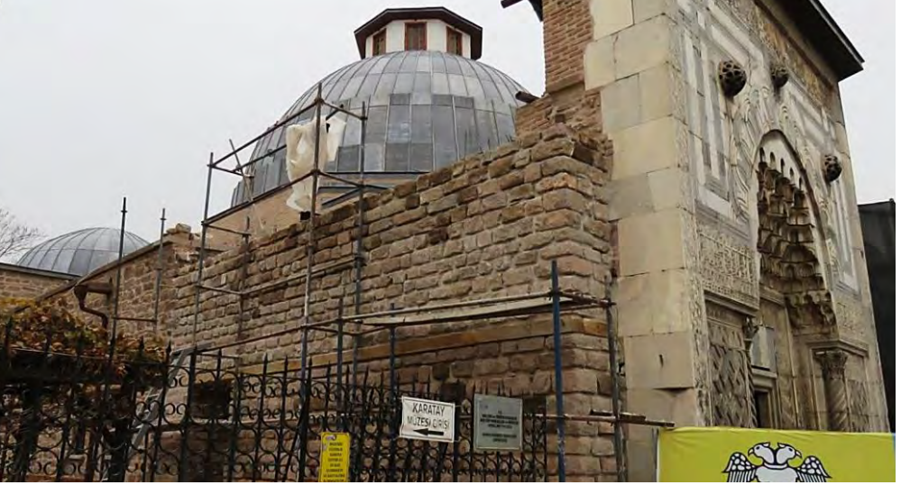
Fotoğraf 7: Taçkapıdan avluya geçişi sağlayan mekânın duvarı (M. Kutlu, Kasım 2018)
