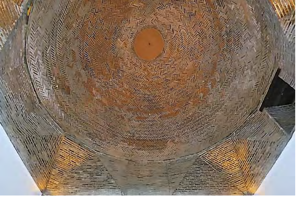
Fotoğraf 12: Eyvanın güneyindeki mekânın (türbe) kubbe örtüsü (M. Kutlu, Kasım 2018)
