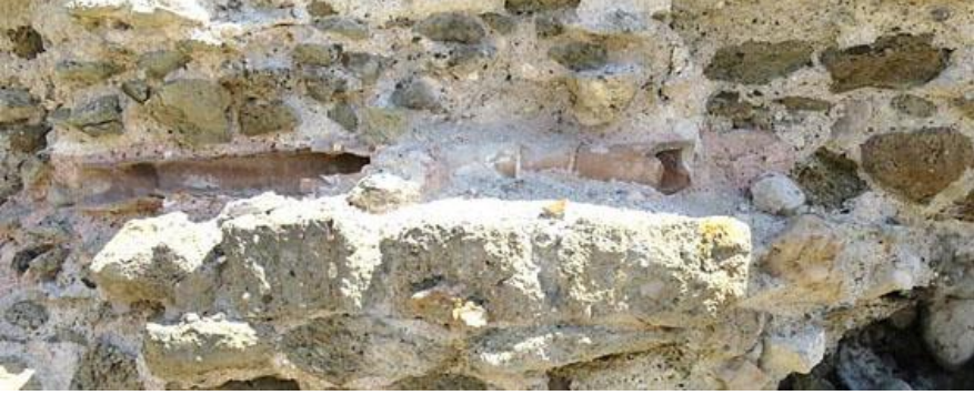
Fotoğraf 4: Kuzey Cephe Duvarı Üzerinde Su Künkleri (M. Kutlu Arşivi, 2018)
