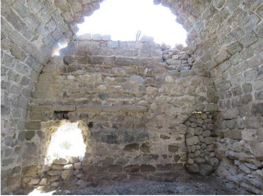
Fotoğraf 30: Mescidin batı duvarı (M. Kutlu Arşivi, 2018)
