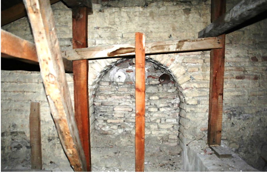
Fotoğraf 12: Özgün tuğla duvar dokusu (Konya Vakıflar B. M. Arşivinden)
