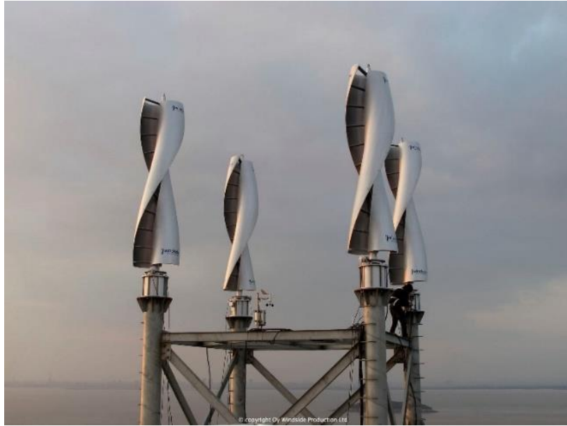
Şekil 3.7. Savonius tipi düşey (dikey) eksenli rüzgar türbinleri (Elibüyük ve Üçgül, 2014)
