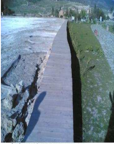
ÜSTÜ TAHTA İLE KAPLI SU KANALLARI
