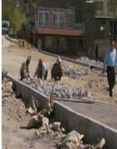
SİT ALANINDA YOL YAPIM ÇALIŞMASI
