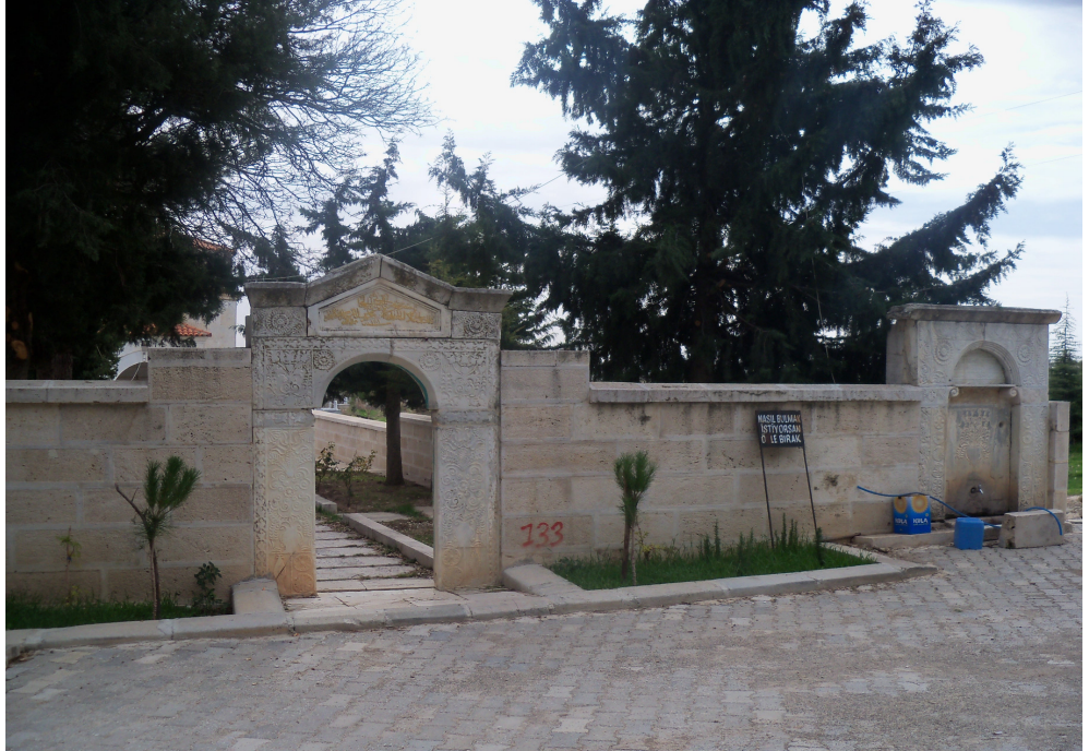
Ek-4 Hacım Sultan Türbesinin giriş kapısı ve çeşme
