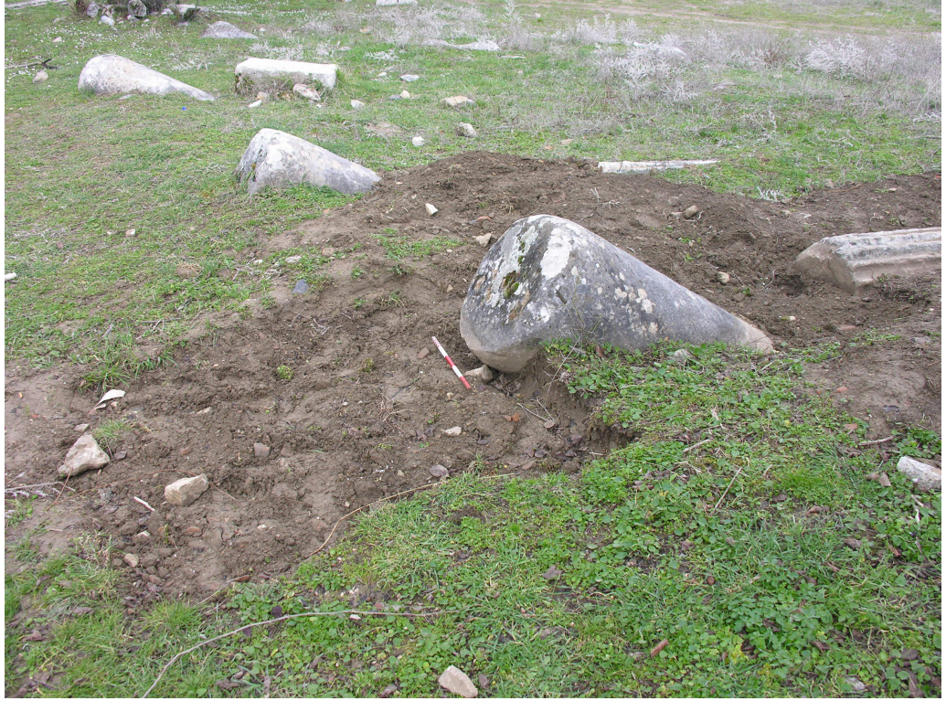
Resim 26: Kuzey Stoa'nın kuzeybatısında depremde düştüğü şekli ile korunan sütun tamburları.
