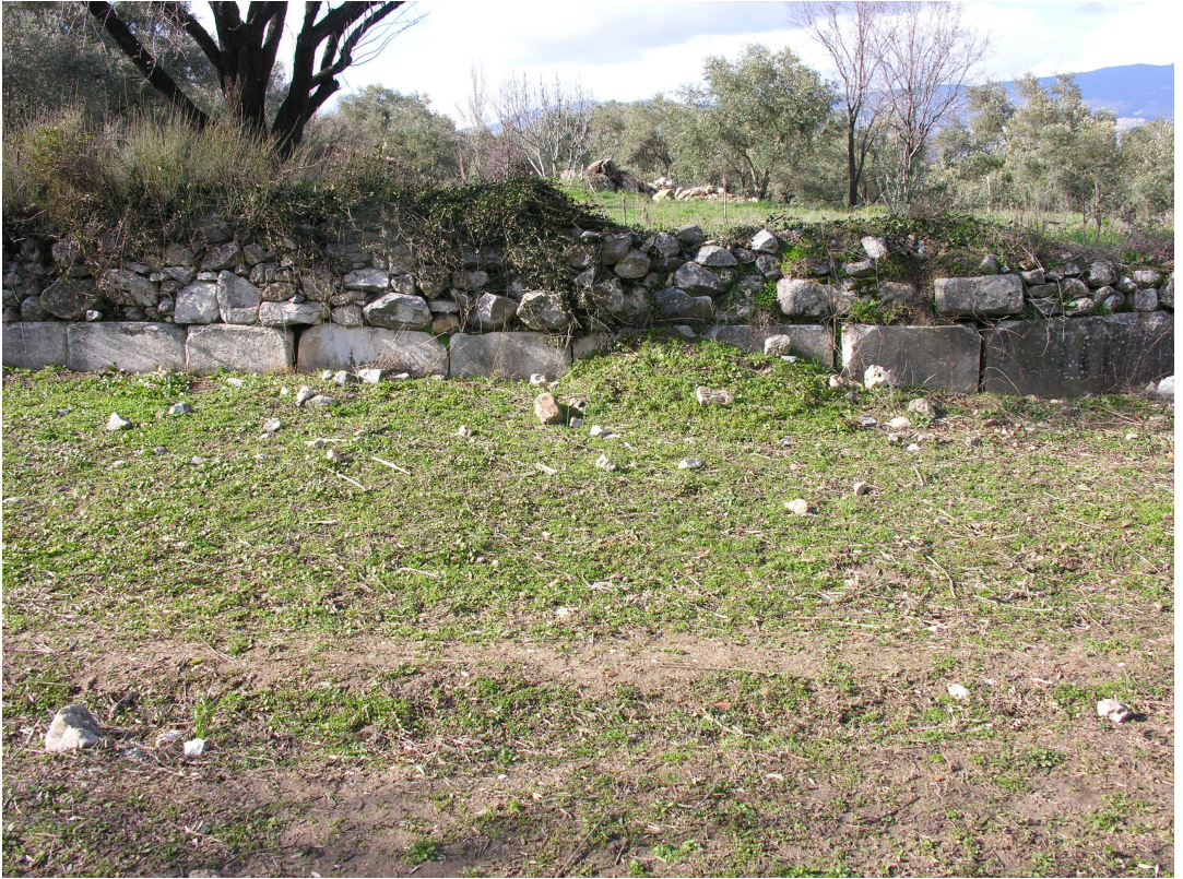
Resim 22: Kuzey Stoa'nın arka duvarının iç cephesi.
