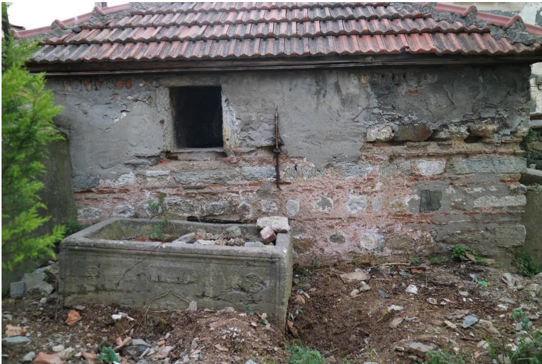
Fotoğraf 19: Salih Ağa Çeşmesi Doğu Cephesi
