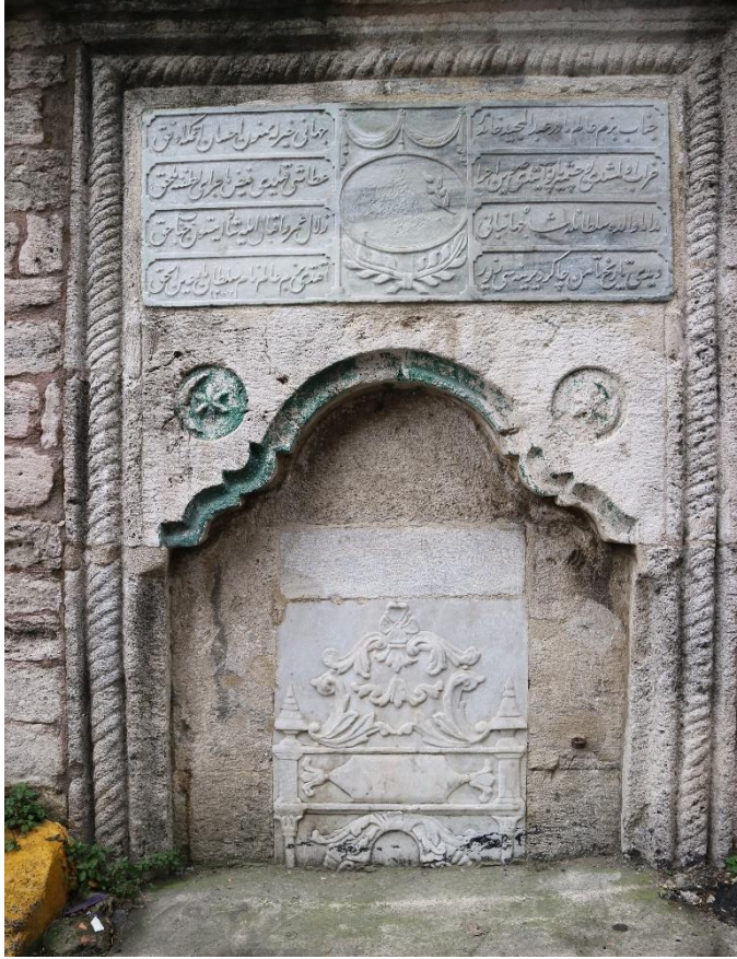
Fotoğraf 53: Bezmialem Valide Sultan Çeşmesi Doğu Cephesinden Ana Kullanım Alanı
