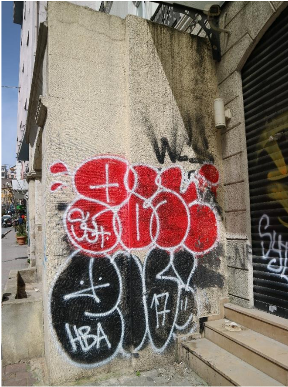
Fotoğraf 92: İbrahim Efendi (Pirinçci) Çeşmesi Güneydoğu Cephesi
