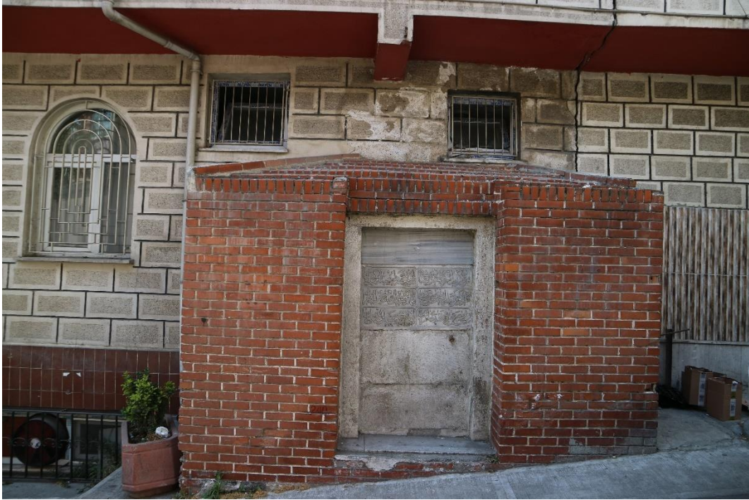
Fotoğraf 70: Ali Rıza Paşa Çeşmesi Genel Görünüşü
