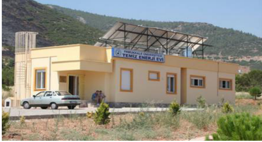
Şekil 6.1: Temiz Enerji Evi
