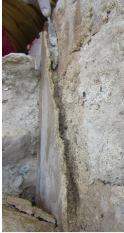
Fig. 88: Sivaların Konservasyonu C
