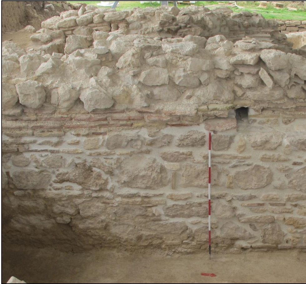
Fig. 135: Calidariumun Doğu Duvarı
