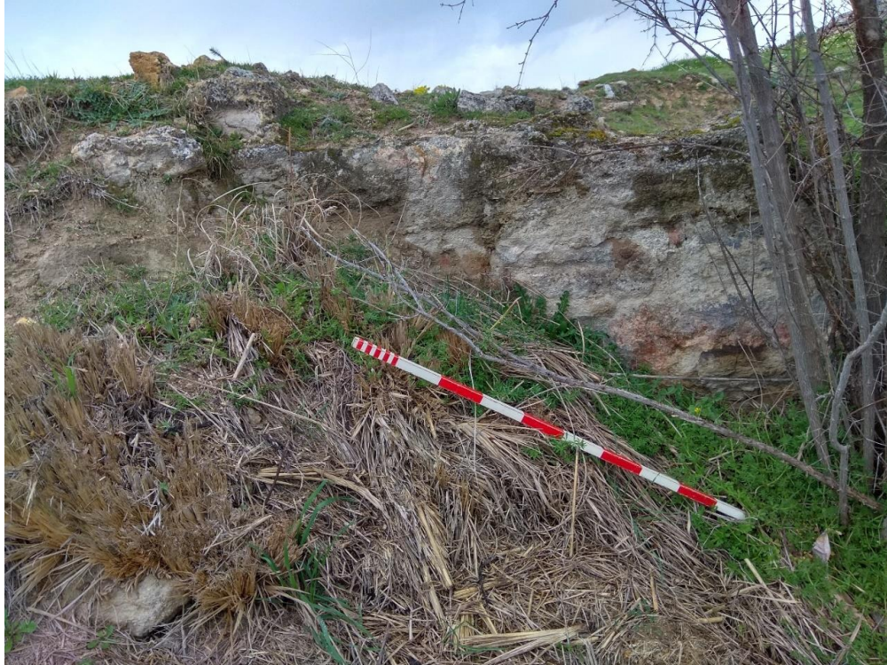
Fig. 100: Hamamın(?) Kuzeyinde Tespit Edilen Duvar
