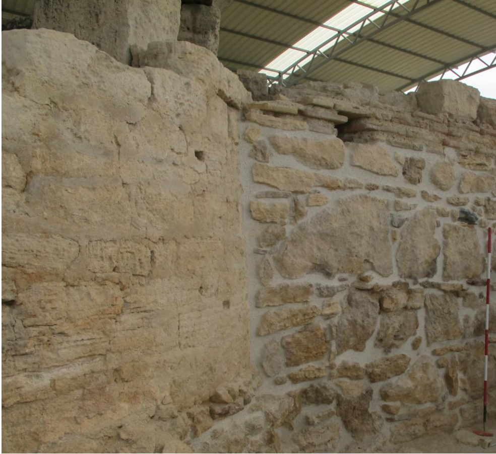
Fig. 131: Yapının Farklı Dönemlerde Restore Edildiğini Gösteren Duvar Detayı
