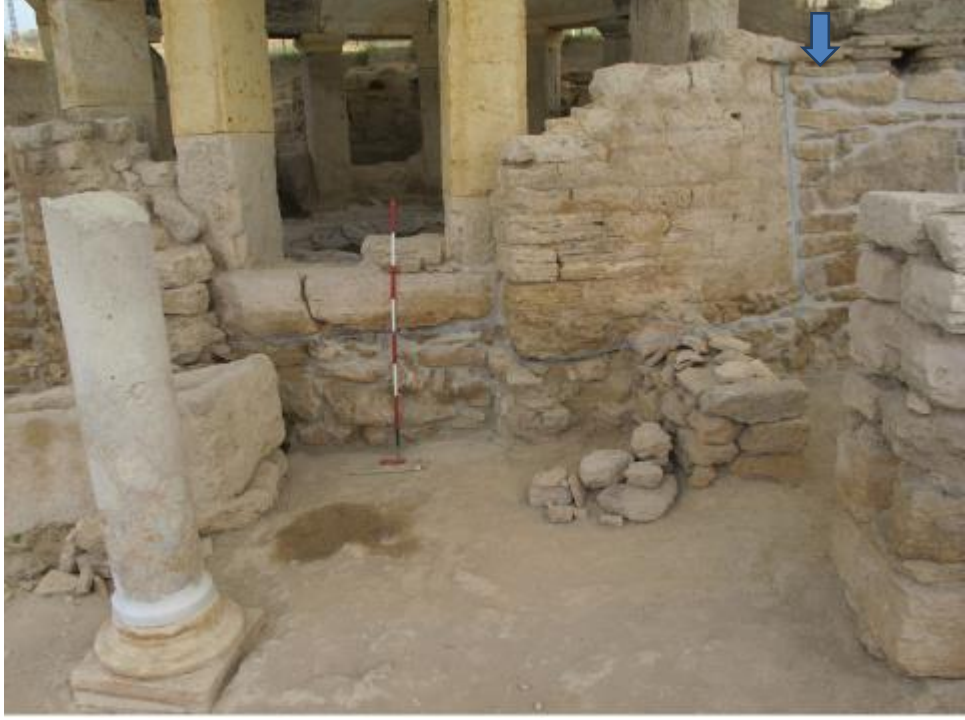
Fig. 130: Yapının Farklı Dönemlerde Restore Edildiğini Gösteren Duvarlar
