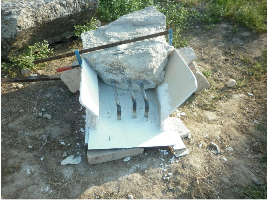
Fig. 65: Restorasyonu Yapılacak Arşitrav
