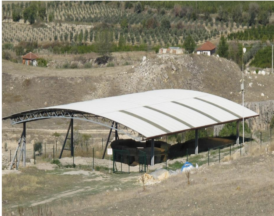
Fig. 94: Yapının Koruma Çatısıyla Üstünün Kapatılmış Hali
