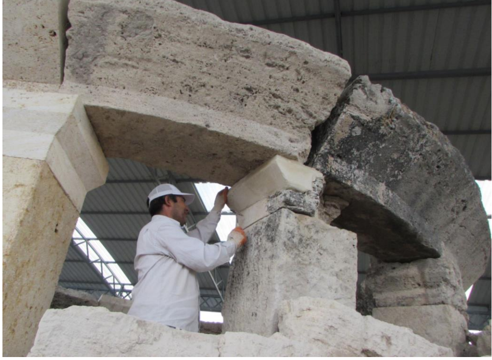
Fig. 69: Paye Başlığının Yerinde Döküm Tekniği İle Restorasyonu ve Eskitme Çalışması
