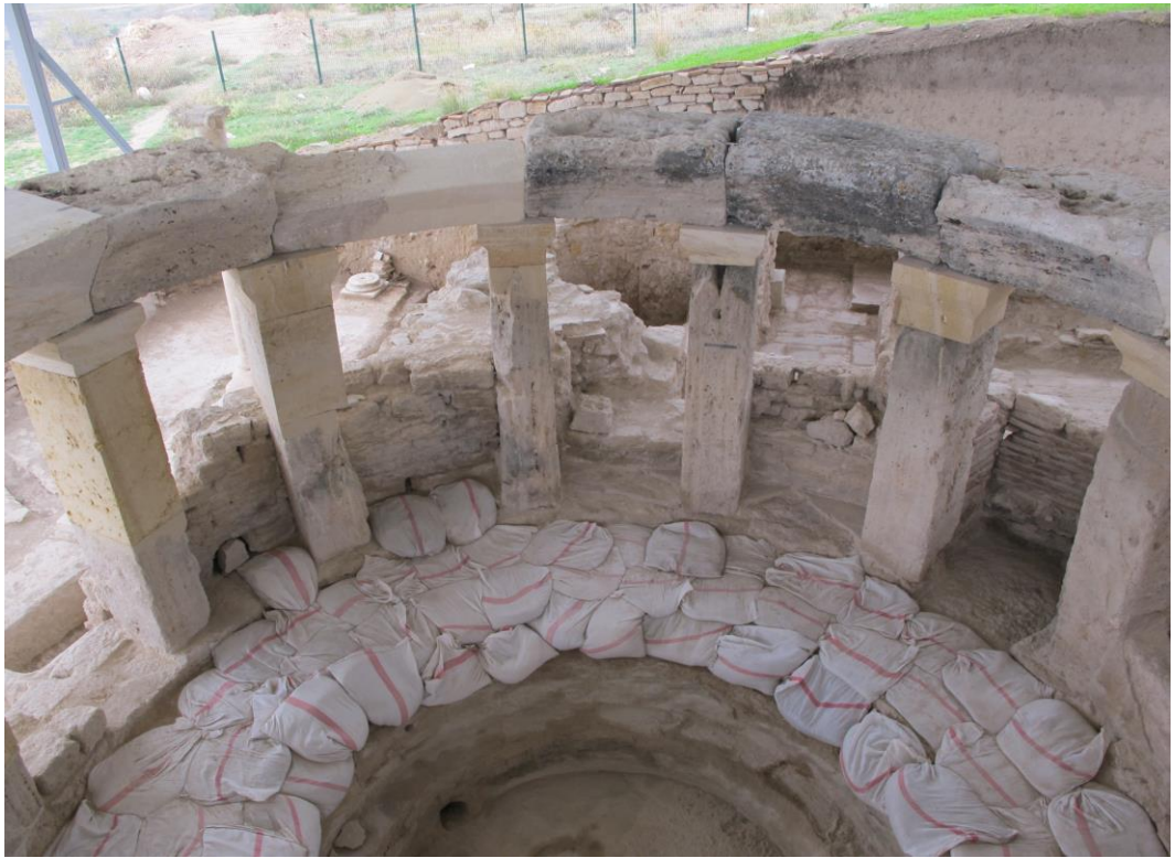
Fig. 64: Yerde Dkm Teknięi İle Tmleme alıřması Yapılan Arřitrov
