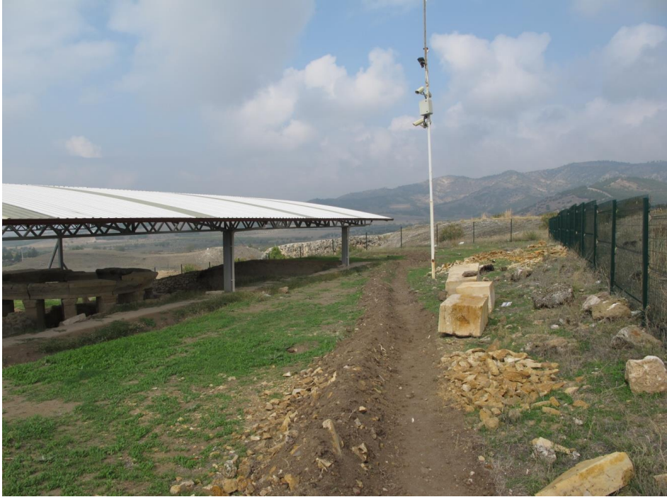
Fig. 92: Yapının Drenaj, Tel Örgü, Güneş Paneli, Kamera ve Işıklanma İşlemlerinin Ardından Durumu
