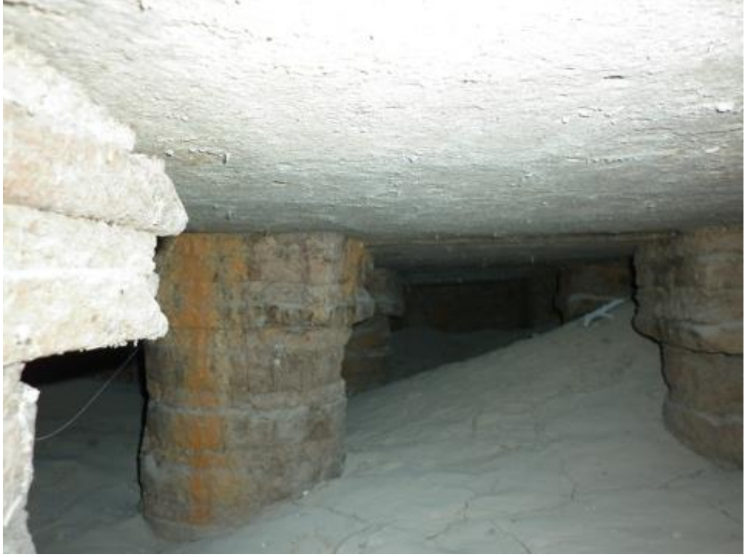
Fig. 13: Hypocaust Sistemi Temizlik Öncesi
