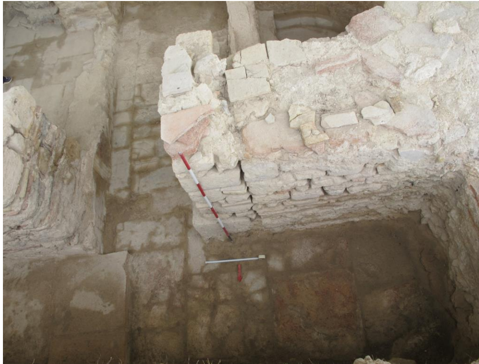
Fig. 129: Yapının Farklı Dönemlerde Restore Edildiğini Gösteren Duvar Cephesindeki İzler
