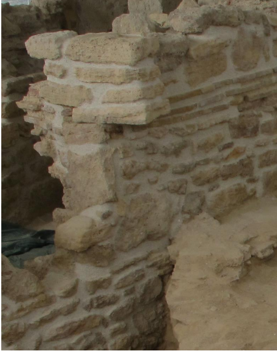
Fig. 138: Dairemsi Alan İle Calidarium Arasındaki Duvarda ıkıntı Yapan Taş Duvar
