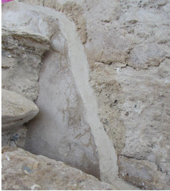
Fig. 89: Sıvaların Konservasyonu Tamamlanmış Hali
