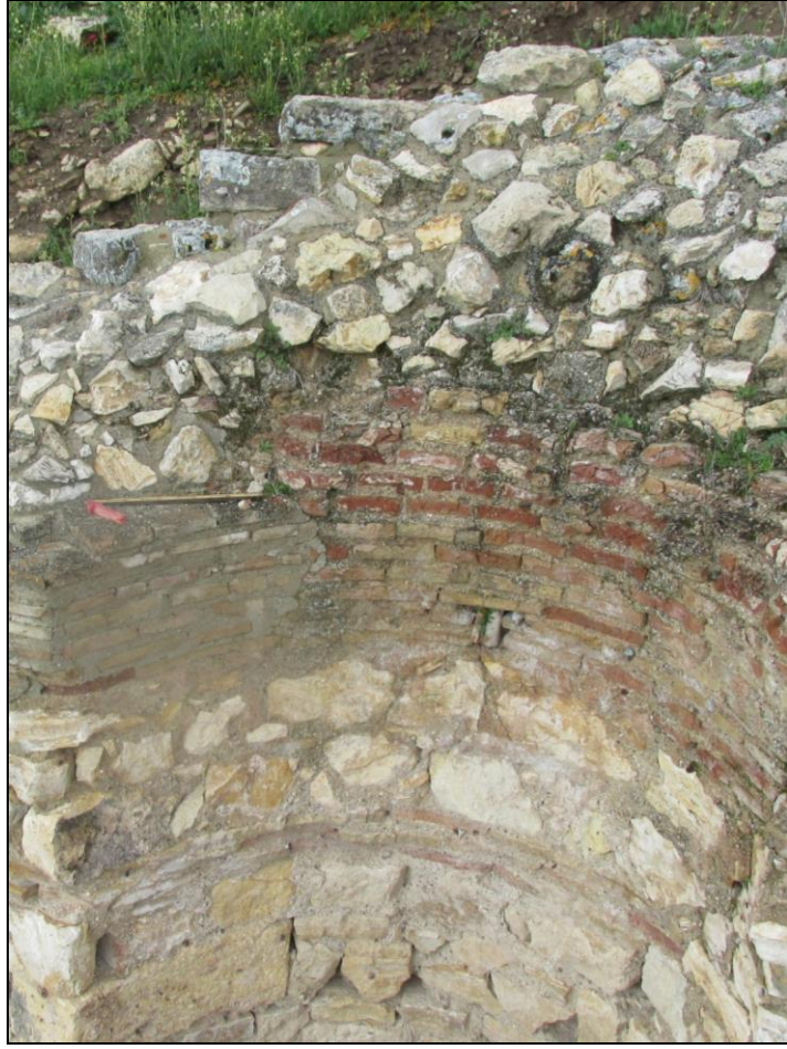
Fig. 136: Hierapolis Segizgen Hamam Nişli Banyo Duvar Detayı
