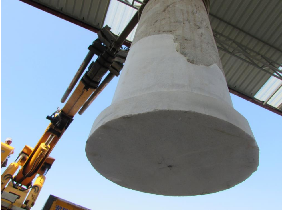
Fig. 72: Pantografi Yapılan Sütunun Vinç Yardımıyla Yerleştirilmesi
