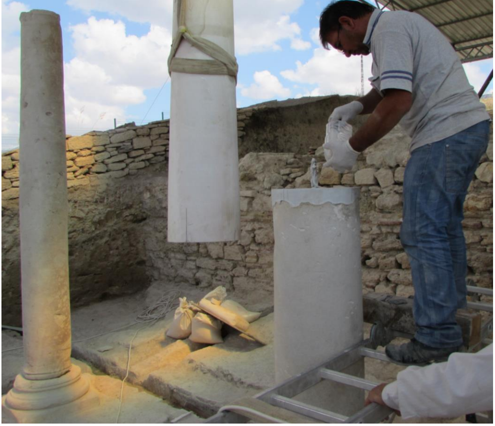
Fig. 73: Pantografi Yapılan Sütunun Yerine Montaj Aşaması
