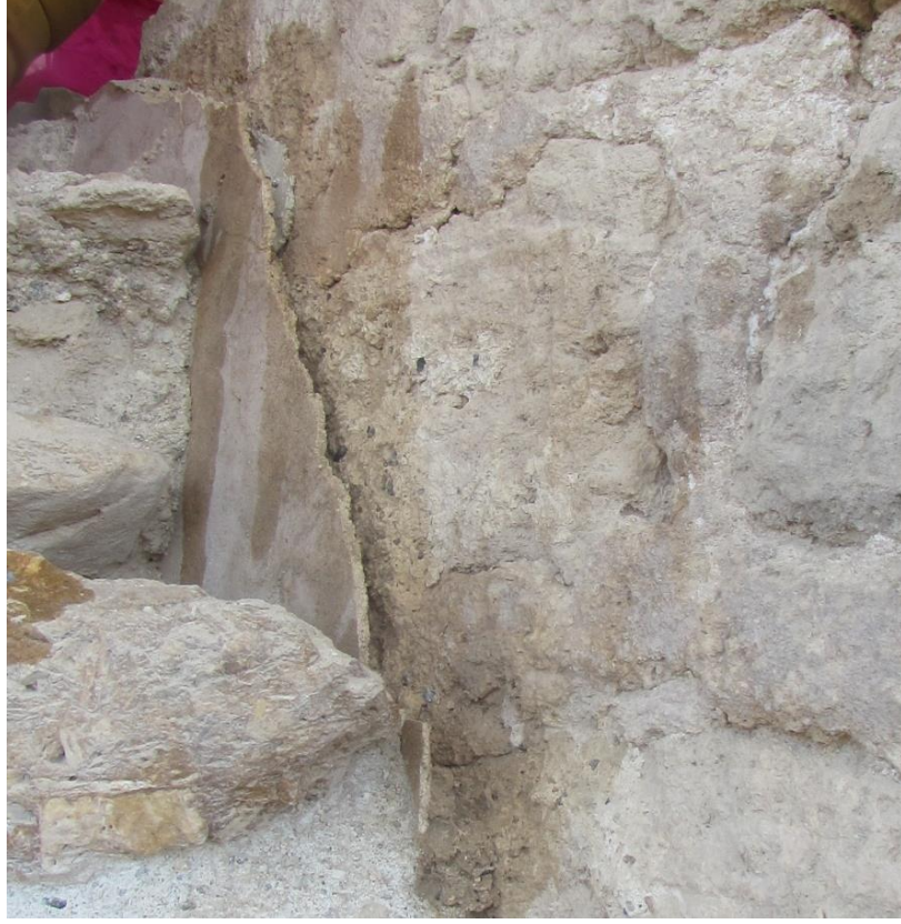
Fig. 87: Sivaların Konservasyonu B
