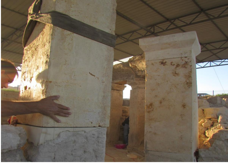
Fig. 61: Yeni Traverten Blokların Yerleştirilmesi
