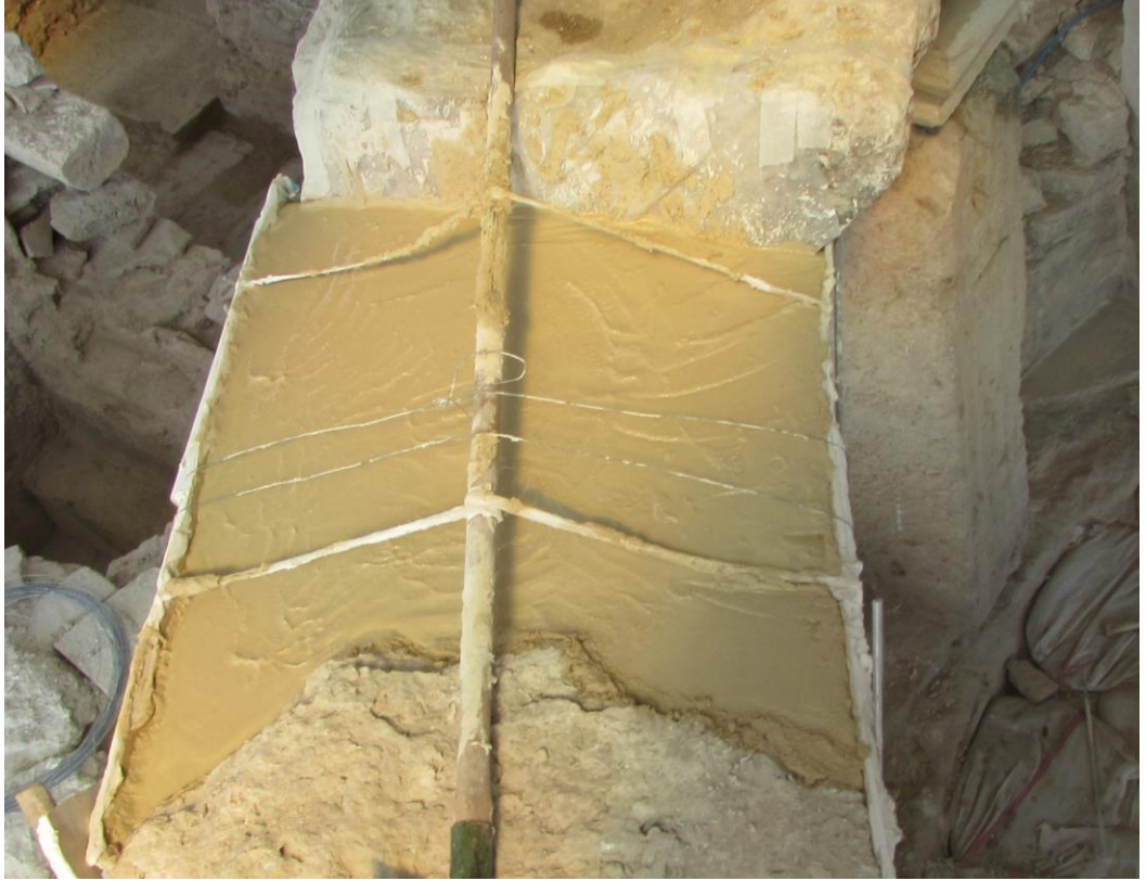
Fig. 66: Yerinde Döküm Tekniği İle Tümleme Çalışmasının Yapılma Aşaması
