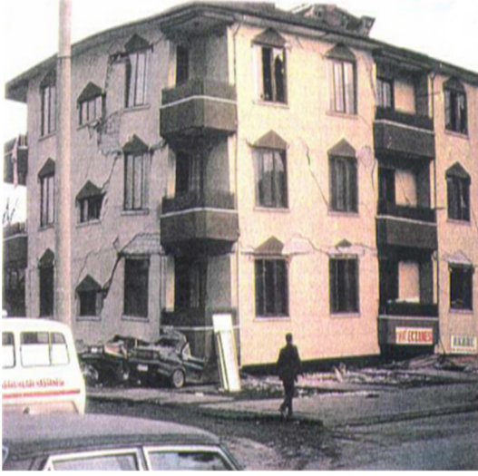
Şekil 2.3: Zemin katın dükkân olarak kullanılması sonucu ve bölme duvarların azlığı nedeniyle yumuşak kat oluşarak zemin katı göçmüş bir bina. a)Binanın depremden sonraki durumu b)binanın depremden önceki durumu. (Erzincan Depremi, 1992)
