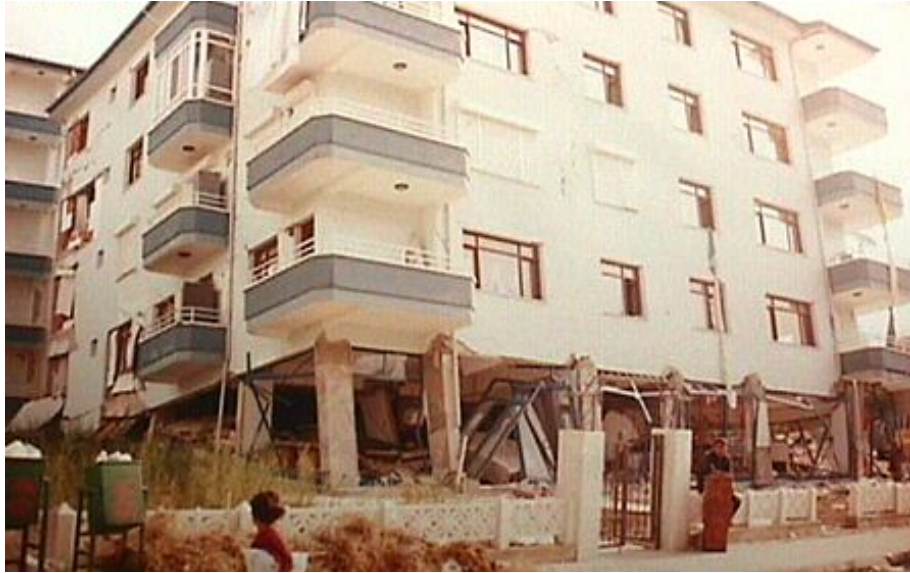
Şekil 2.5: Yumuşak kat sebebiyle giriş katı göçmüş bir bina, Van Depremi, 2011 (İnel vd., 2011)
