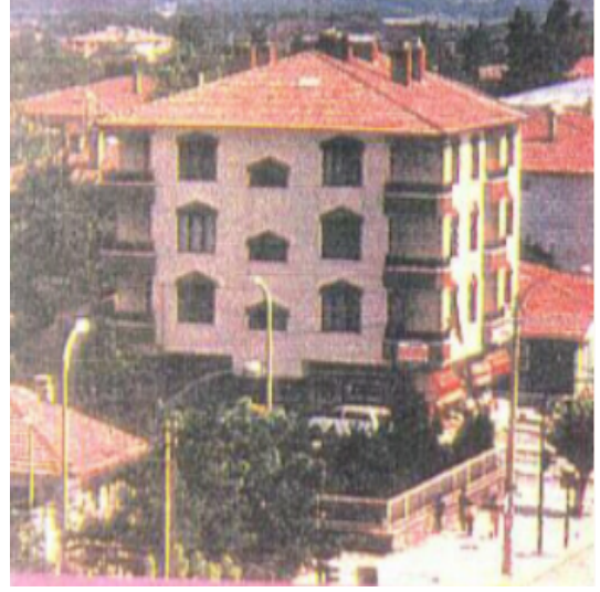
Şekil 2.3: Zemin katın dükkân olarak kullanılması sonucu ve bölme duvarların azlığı nedeniyle yumuşak kat oluşarak zemin katı göçmüş bir bina. a)Binanın depremden sonraki durumu b)binanın depremden önceki durumu. (Erzincan Depremi, 1992)
