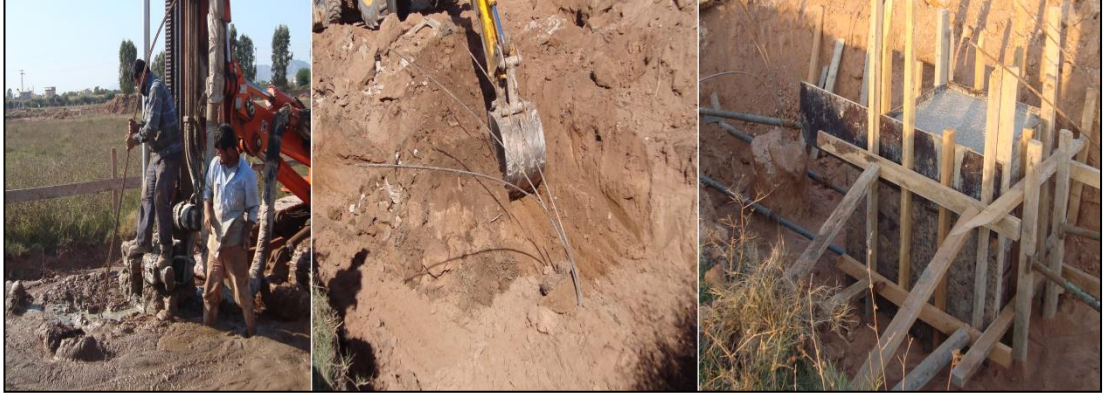
Şekil 4.21: Yükleme testi kolon imalatı (Anonim 2008 b ).
