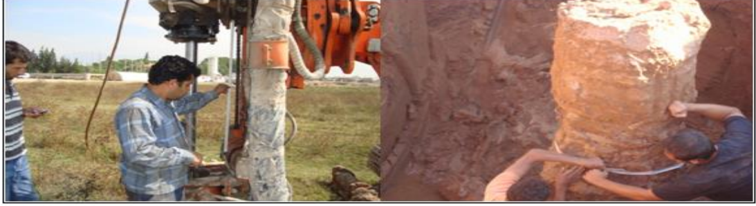
Şekil 4.12: Çekme hızı belirlenmesi ve 1 no’lu kolonda ölçüm (Anonim 2008 a ).
