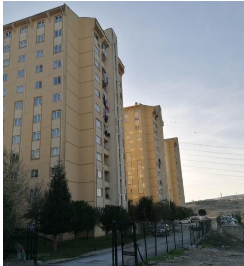
Şekil 4.68: Ayazma 1. Etap konutları.
