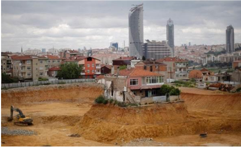
Şekil 2.7: Fikirtepe kentsel dönüşüm alanı inşaat aşaması (Bloomberg 2016).
