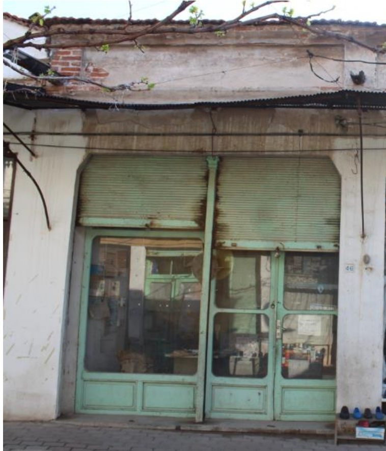
Fotoğraf 50: 8. Dükkan Batı Cephe (2018).
