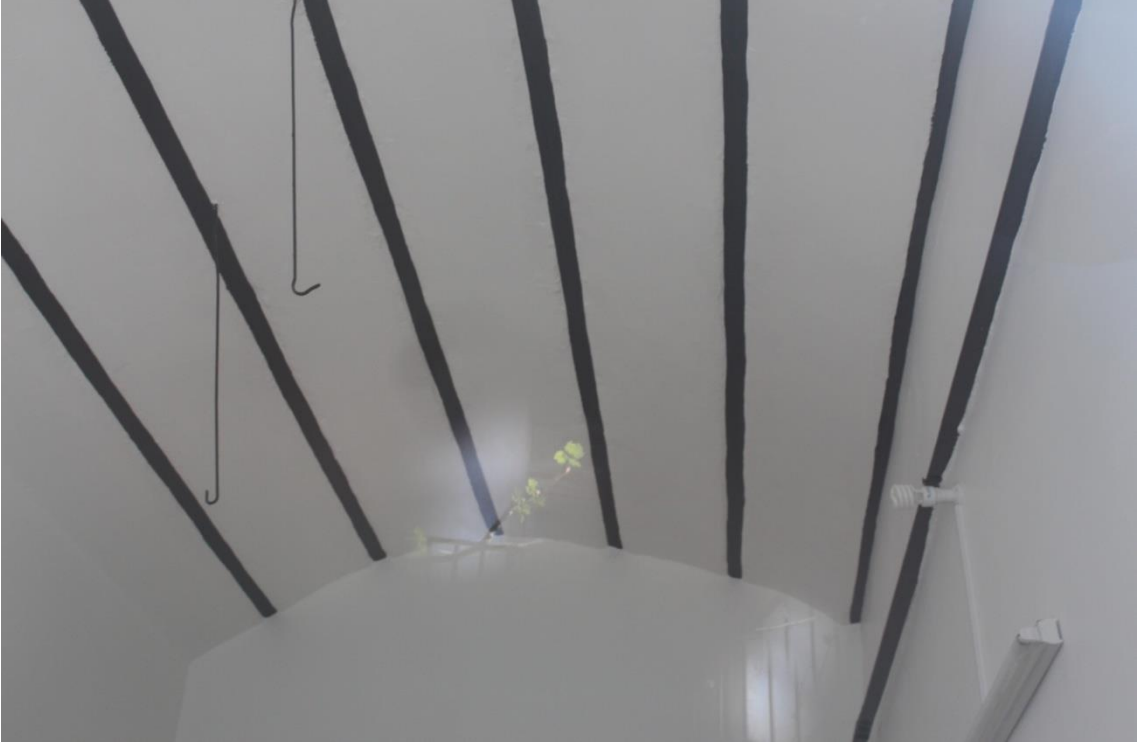
Fotoğraf 57: 9. Dükkan İç Mekan Tavan Örtüsü (2018).
