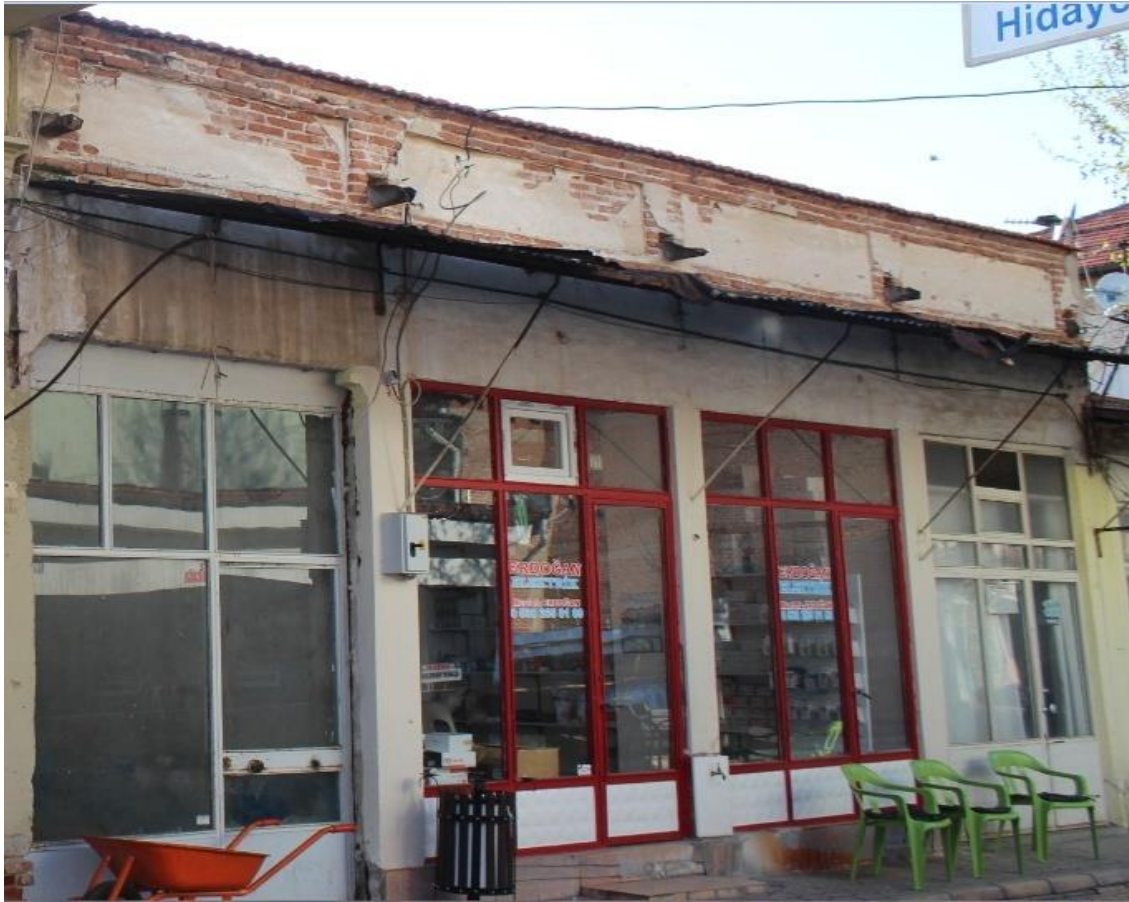
Fotoğraf 10: 1. ve 2. Dükkanların Batı (Arka) Cephesi 14-15-16. Dükkanlar (2018).
