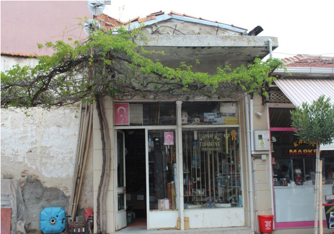
Fotoğraf 76: 12. Dükkan Batı Cephe (2018).
