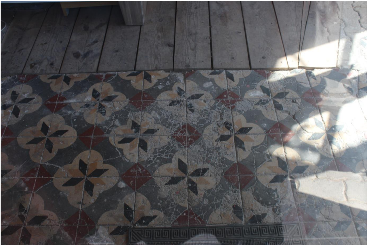
Fotoğraf 36: 5. Dükkan Zemin Kat Yer Döşemesi, Desenli Fayansı (2018).
