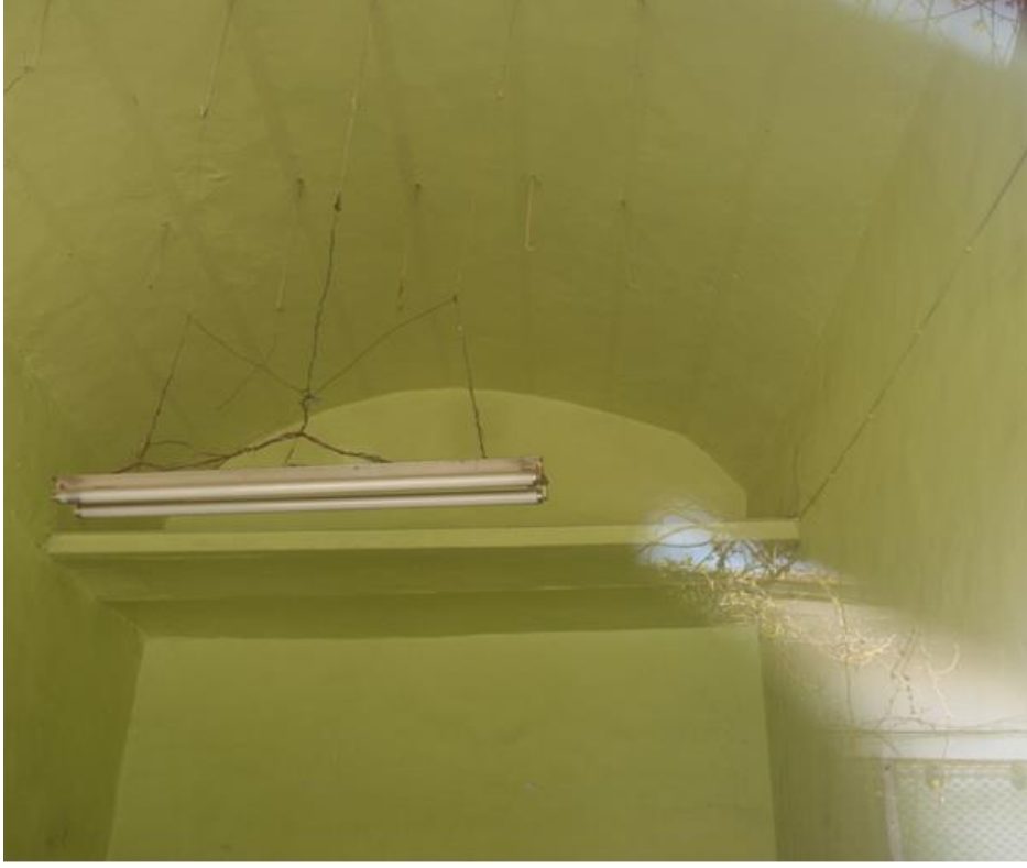
Fotoğraf 41: 6. Dükkan İç Mekan Tavan Örtüsü (2018).
