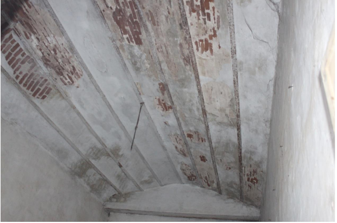
Fotoğraf 25: 4. Dükkan İç Mekan Tavan Örtüsü (2018).
