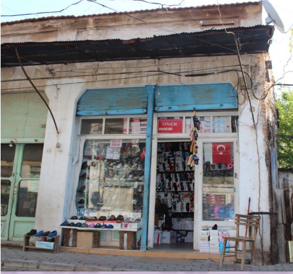
Fotoğraf 44: 7. Dükkan Batı Cephe (2018).
