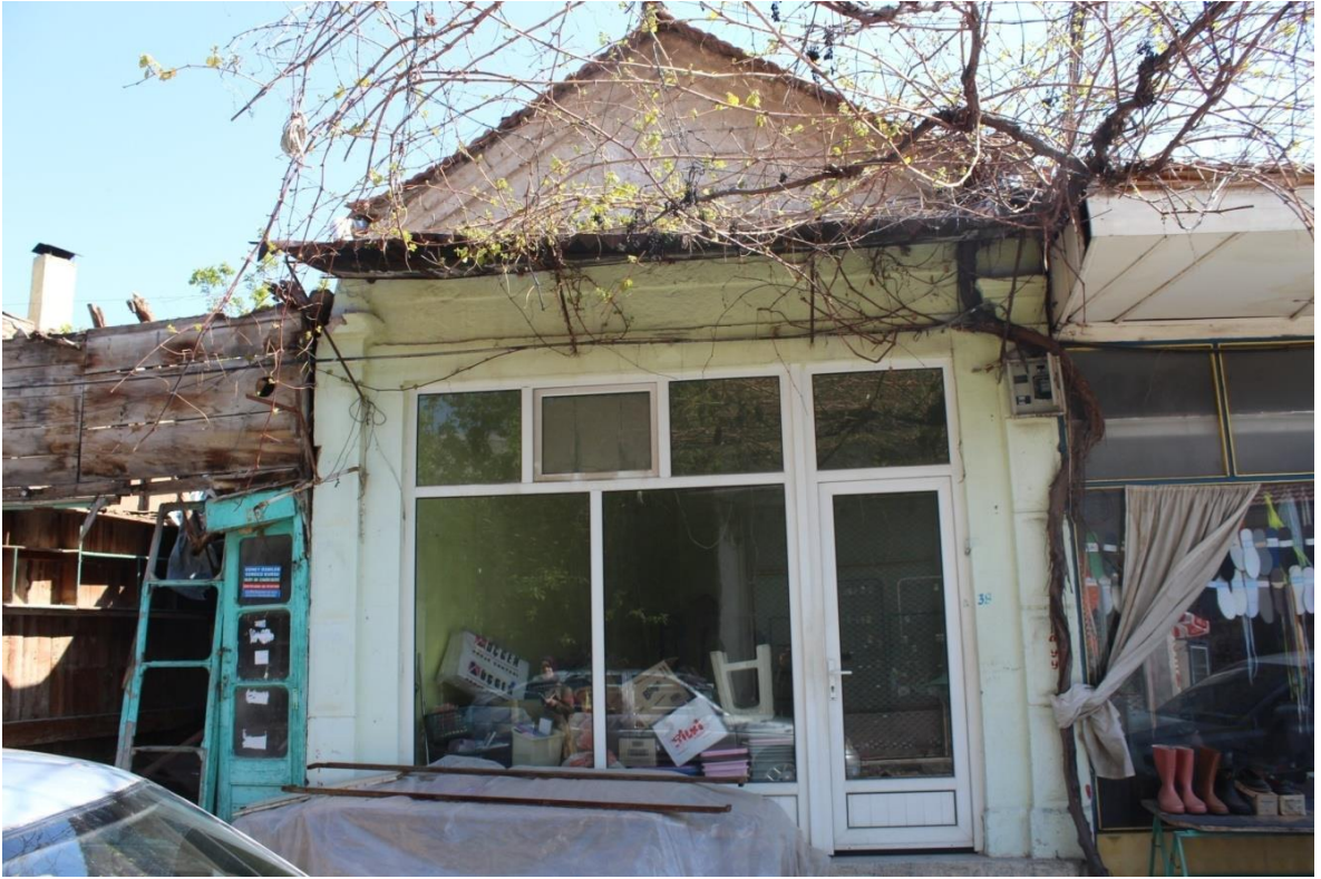
Fotoğraf 38: 6. Dükkan Batı Cephe (2018).
