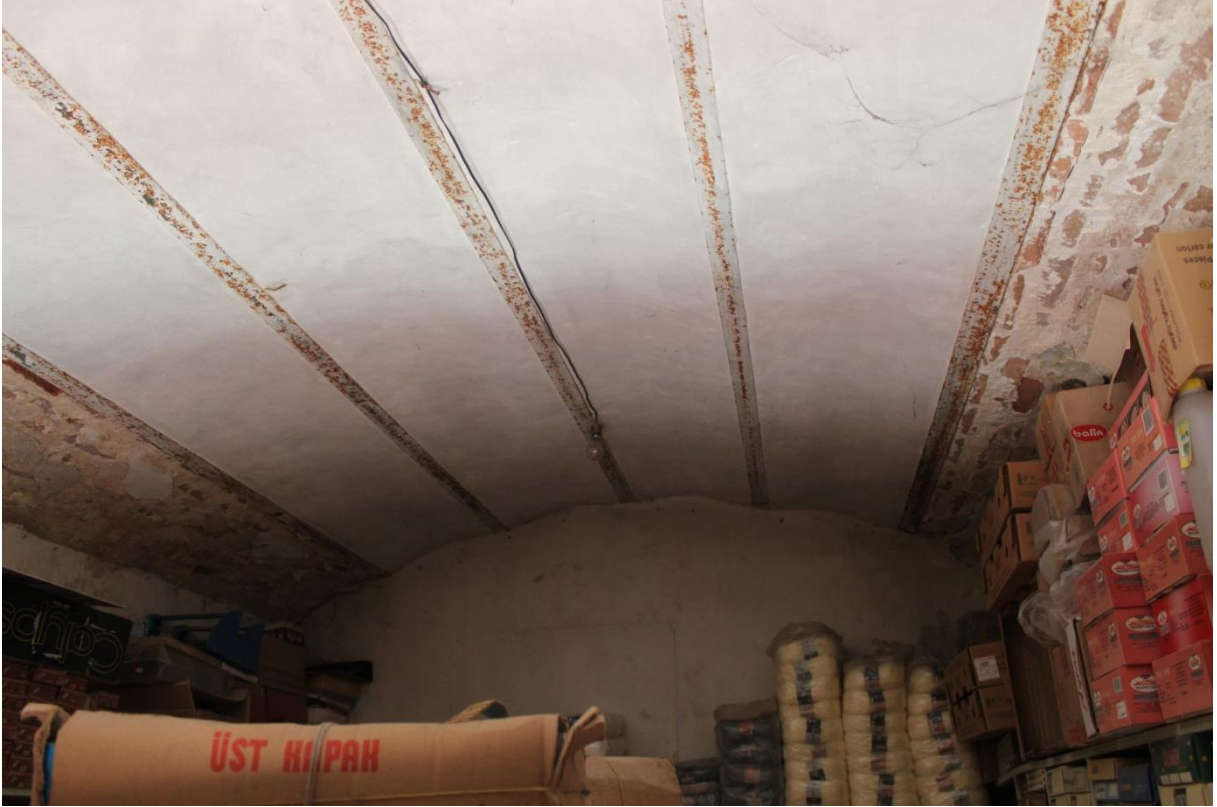
Fotoğraf 79: 12. Dükkanın Volta Tonozlu İç Mekan Tavan Örtüsü ve Asma Katın Görünüşü (2018).
