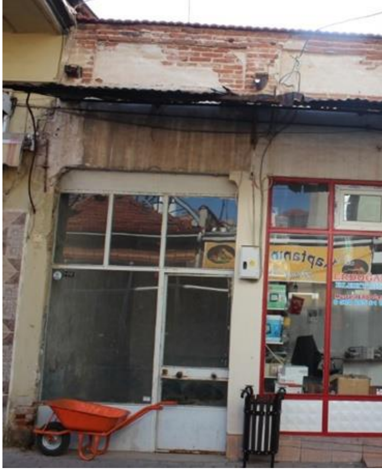
Fotoğraf 97: 16. Dükkan Batı Cephe (2018).
