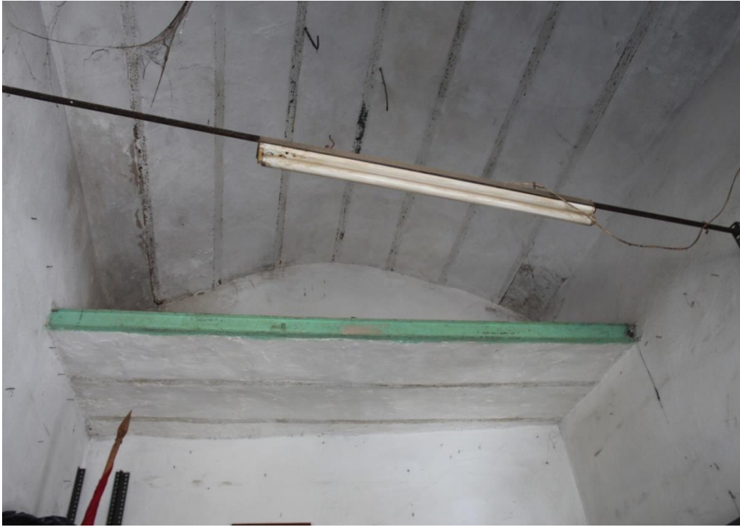
Fotoğraf 52: 8. Dükkan İç Mekan Tavan Örtüsü (2018).
