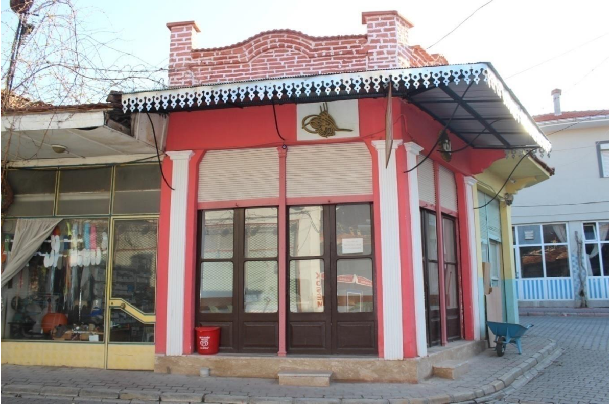
Fotoğraf 31: 5. Dükkan Batı Cephe (2018).
