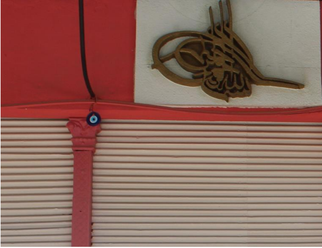
Fotoğraf 33: 5. Dükkan Batı Cephesi Demir Sütun Detayı, Yeni Yapılan Tuğra Bezeme (2018).
