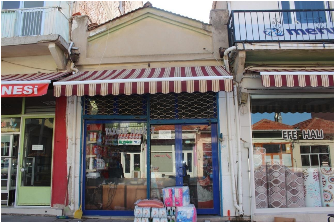
Fotoğraf 112: 19. Dükkan Batı Cephe (2018).
