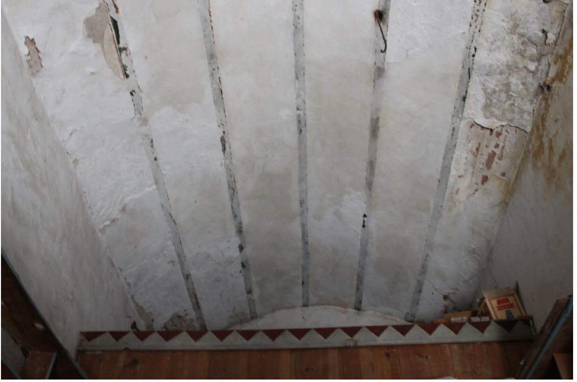
Fotoğraf 61: 10. Dükkan İç Mekan Tavan Örtüsü (2018).
