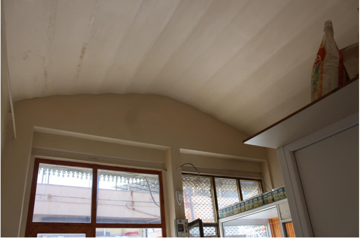
Fotoğraf 5: 1. Dükkan İç Mekan Tavan Örtüsü (2018).
