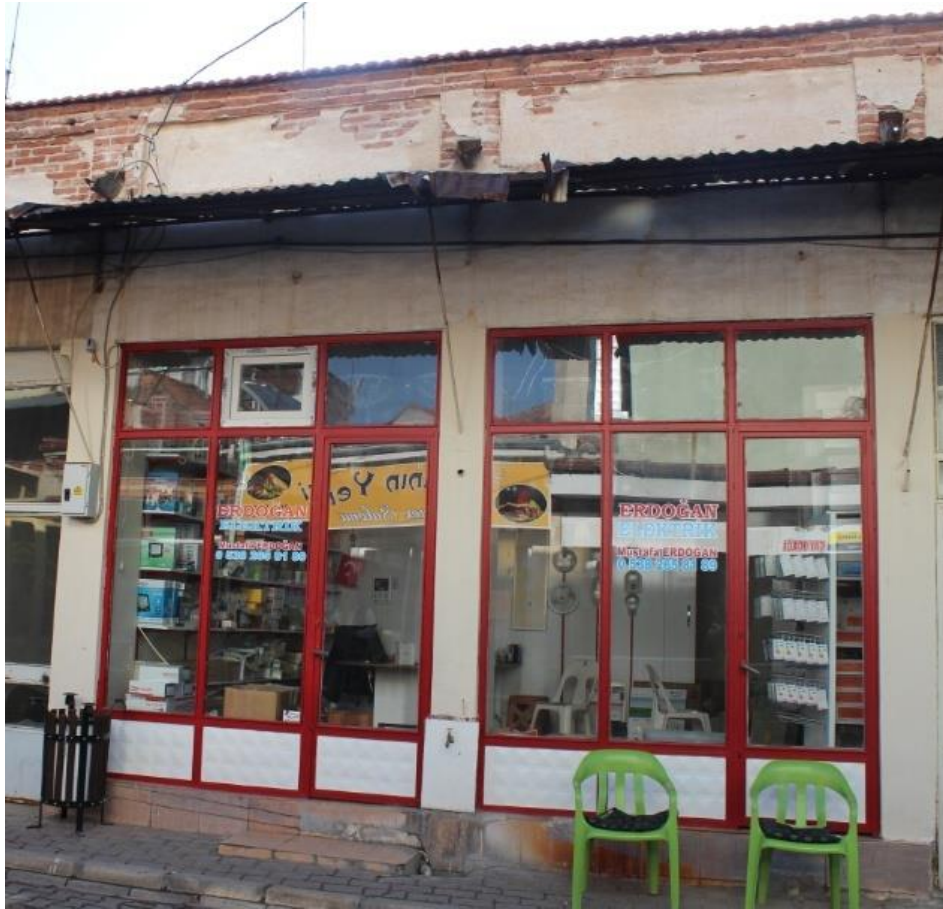
Fotoğraf 92: 15. Dükkan Batı Cephe (2018).
