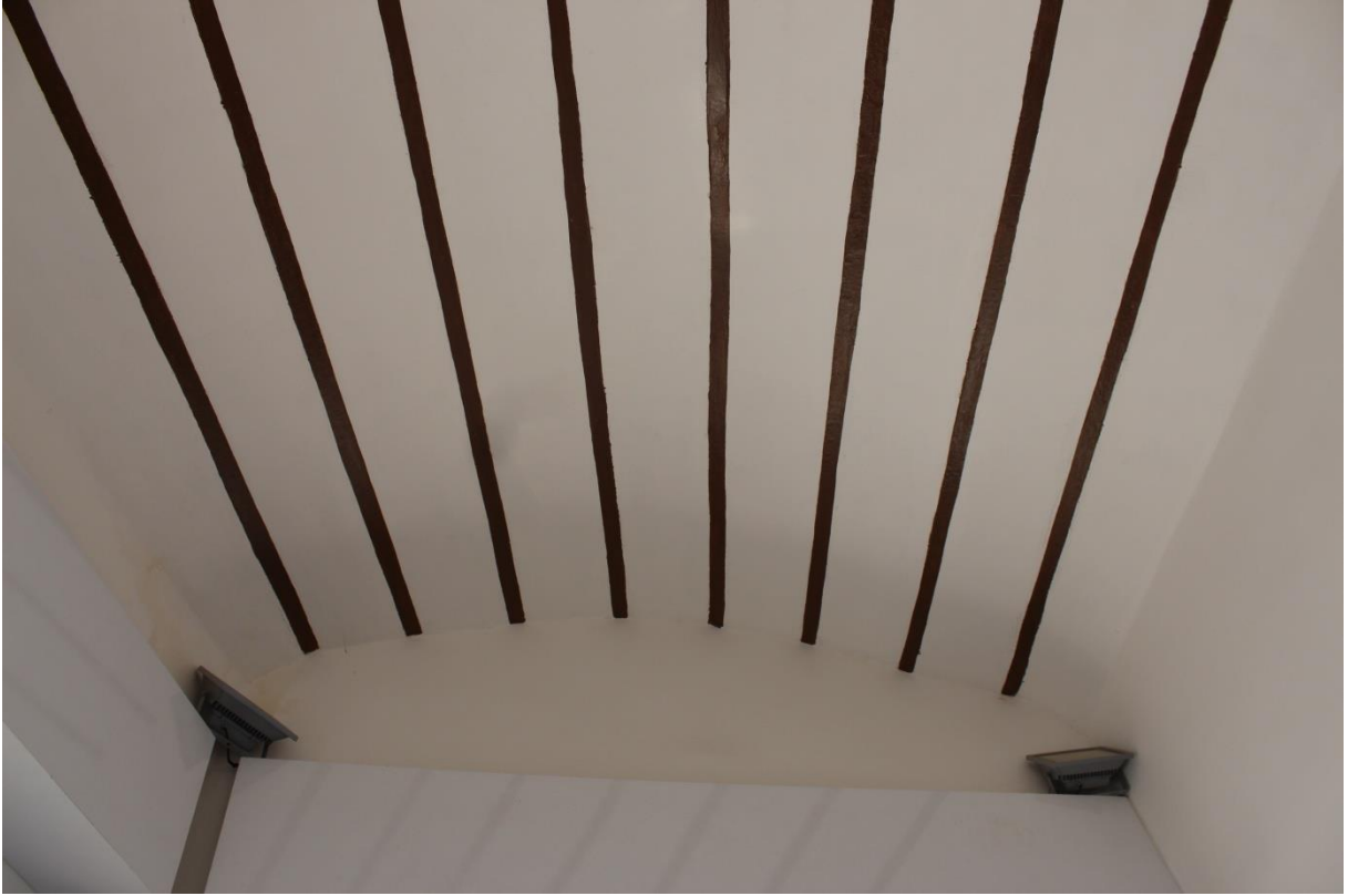
Fotoğraf 35: 5. Dükkan İç Mekan Tavan Örtüsü (2018).
