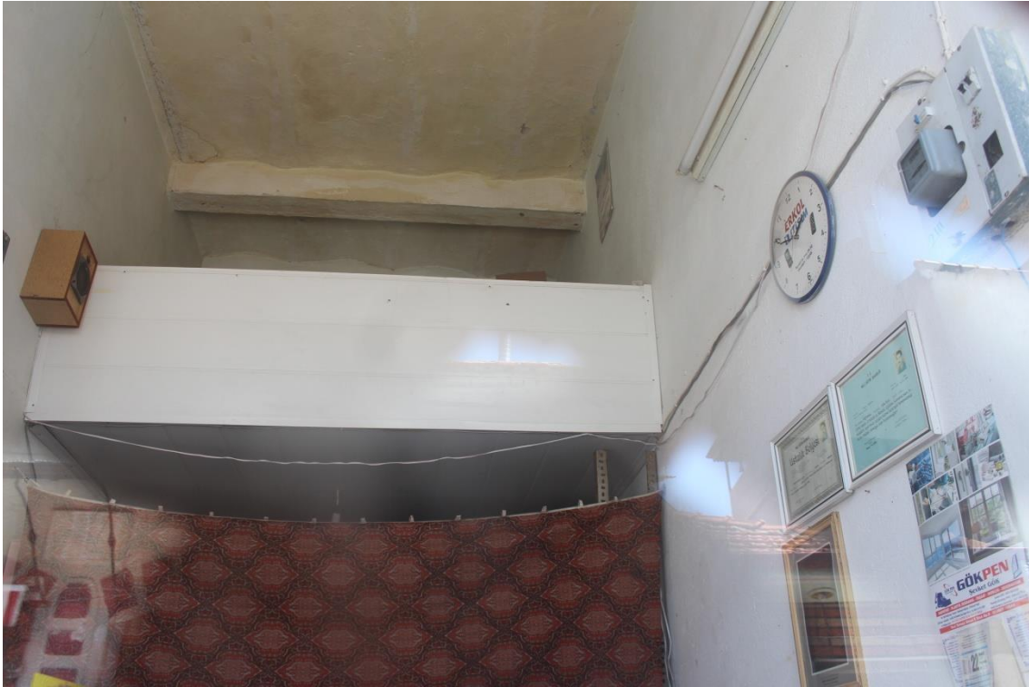
Fotoğraf 102: 17. Dükkan Kuzey Bölümü İçten Görünüşü (2018) 543 .
