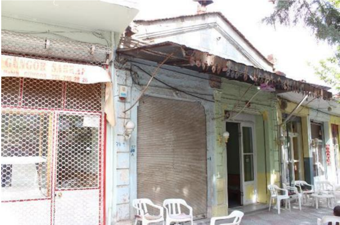
Fotoğraf 66: 11. Dükkan Batı Cephe ( K. İnce'den- 2014).
