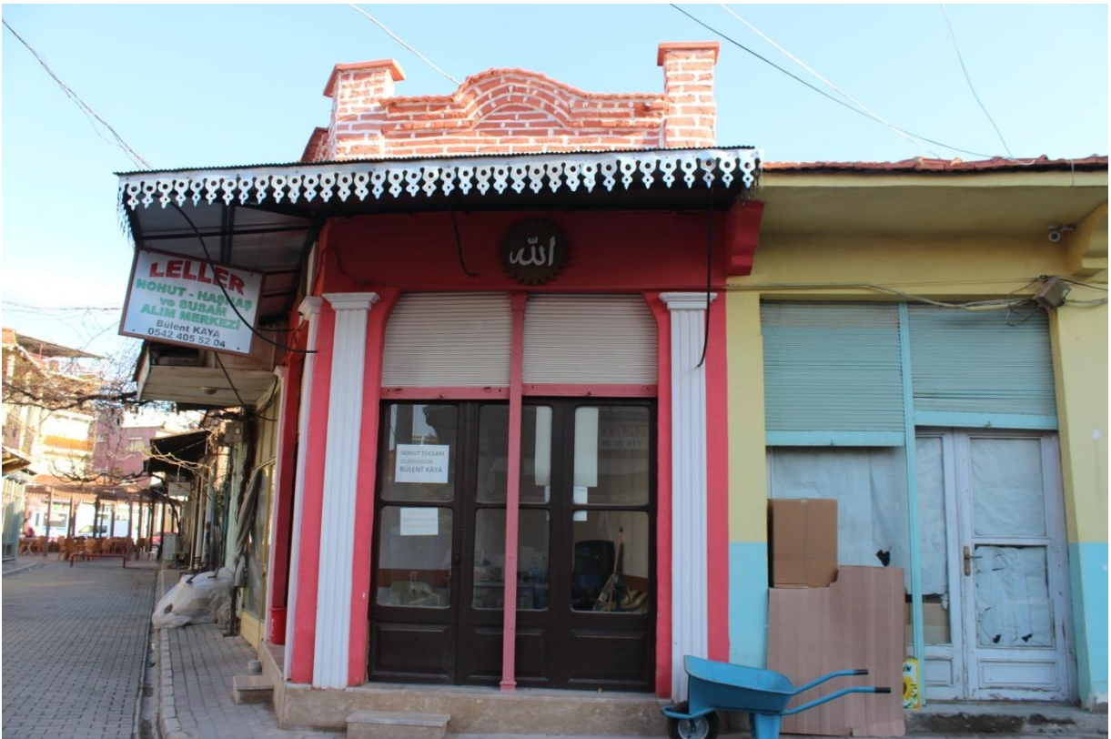
Fotoğraf 32: 5. Dükkan Güney Cephe (2018).
