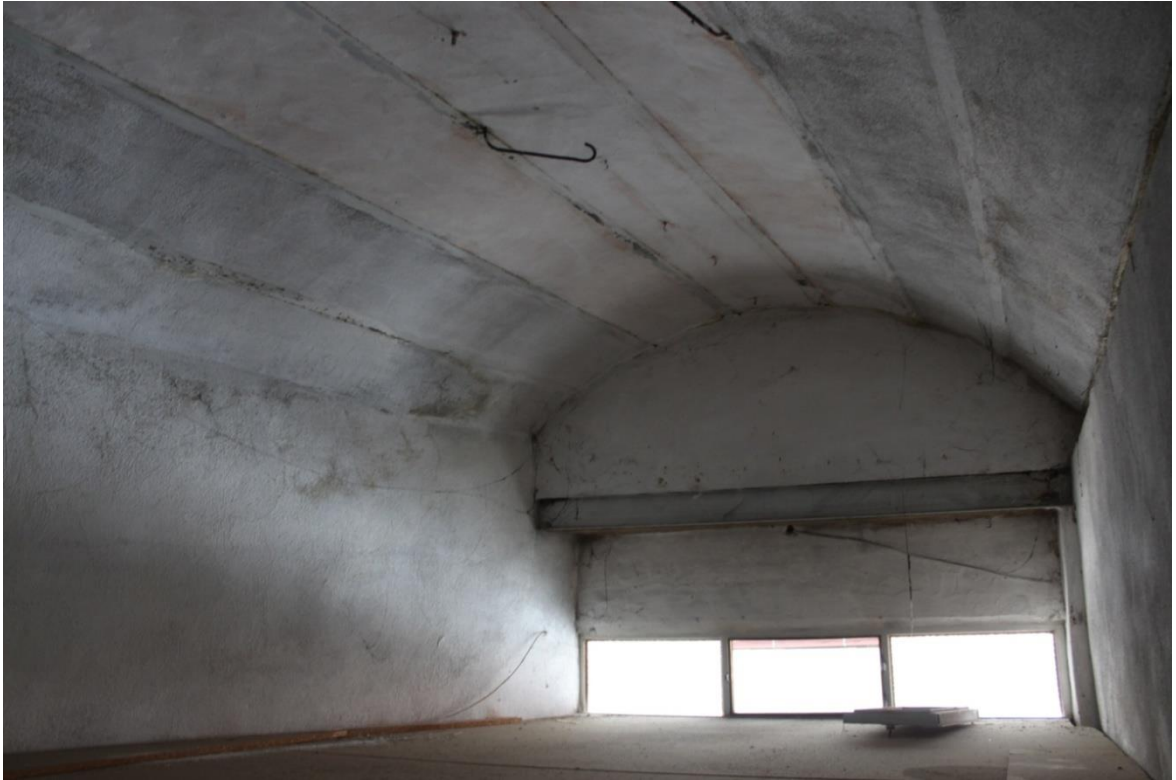
Fotoğraf 90: 14. Dükkan İç Mekan Tavan Örtüsü (2018).
