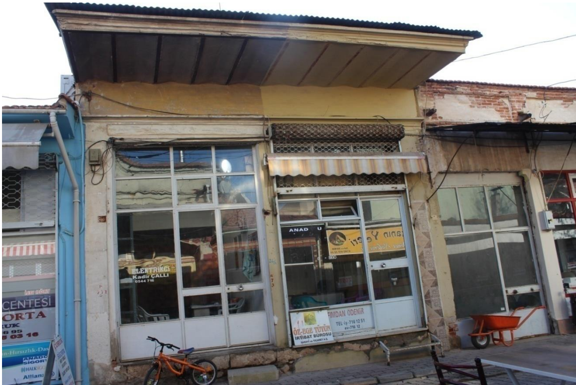
Fotoğraf 100: 17. Dükkan Batı Cephe (2018).
