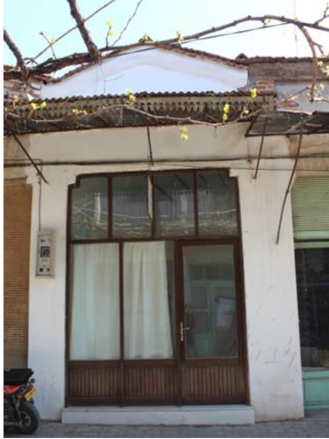
Fotoğraf 55: 9. Dükkan Batı Cephe (2018).
