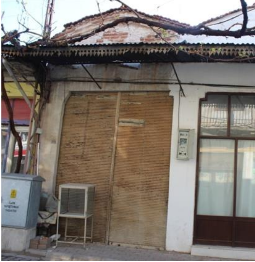
Fotoğraf 59: 10. Dükkan Batı Cephe (2018).
