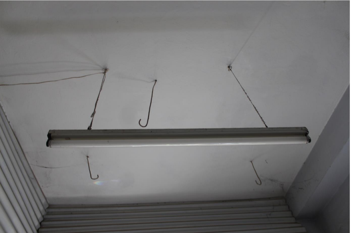
Fotoğraf 20: 3. Dükkan İç Mekan Tavan Örtüsü (2018).
