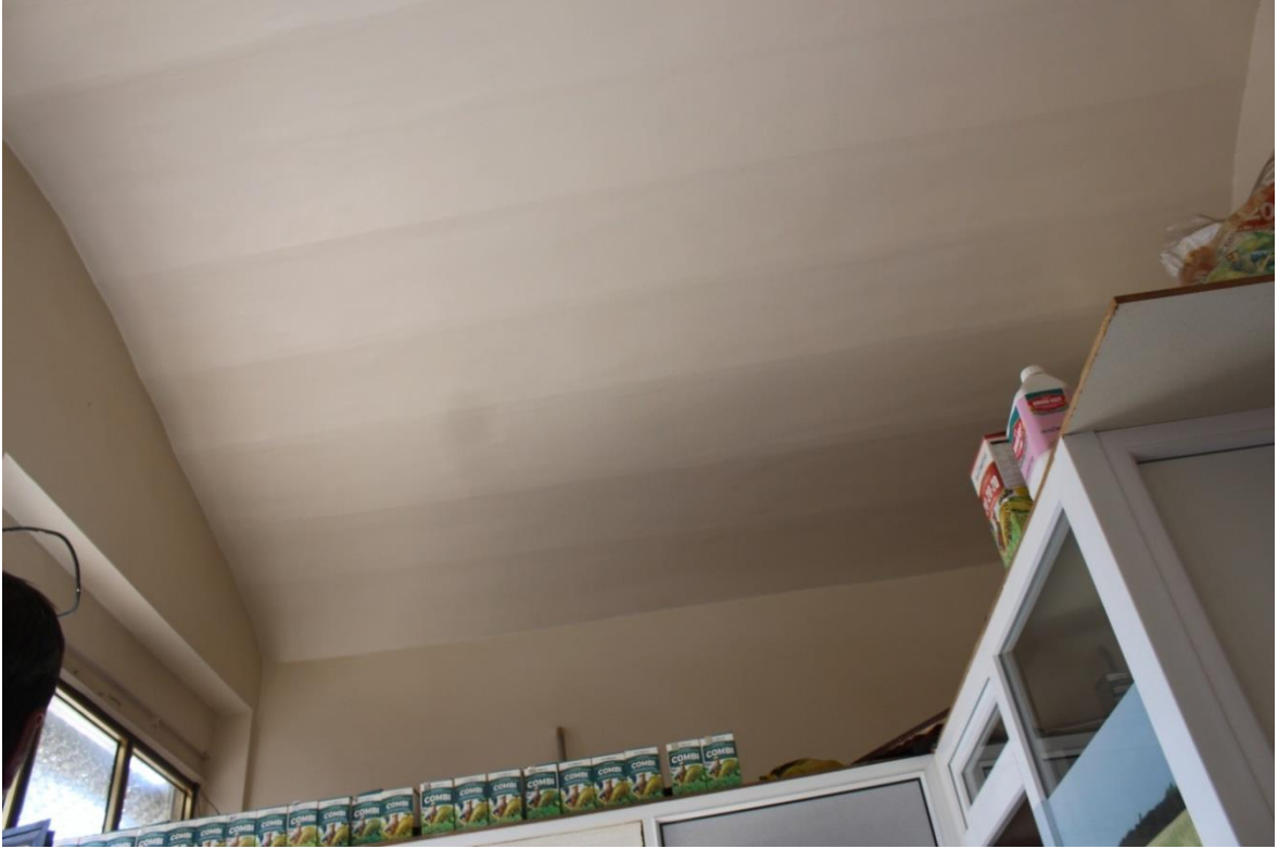
Fotoğraf 6: 1. Dükkan İç Mekan Tavan Örtüsü (2018).
