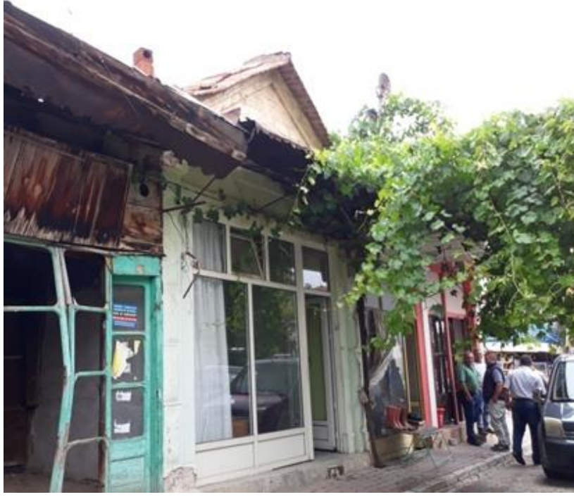
Fotoğraf 39: 6. Dükkan Batı Cephe (2018).
