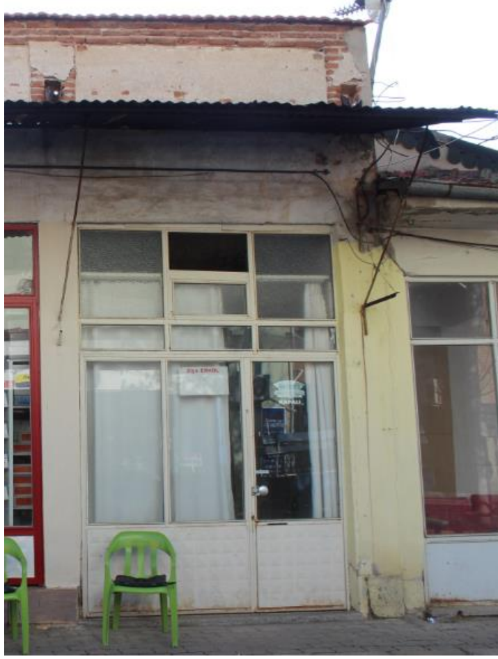
Fotoğraf 87: 14. Dükkan Batı Cephe (2018).
