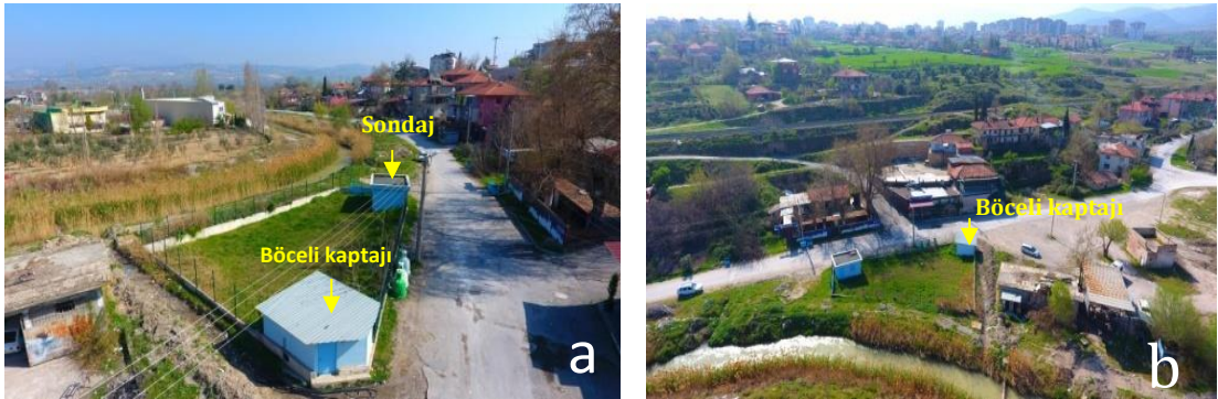
Şekil 3.5: (a) Pınarkent Mahallesi yerleşim alanında bulunan Böceli kaynağı kaptajı ve mülga Köy Hizmetleri Denizli İl Müdürlüğü tarafından açılan sondaj (doğuya bakış), (b) Böceli kaynağı civarının genel görünümü ve içme suyu ihtiyacı fazlası suyunun verildiği çevirme kanalı.
