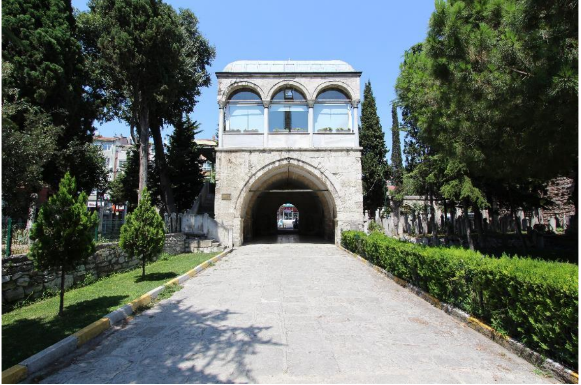
Fotoğraf 87: Hekimoğlu Ali Paşa Külliyesi Avlu Kuzey Taçkapısı Genel Görünüş Arka Yüz (2017)
