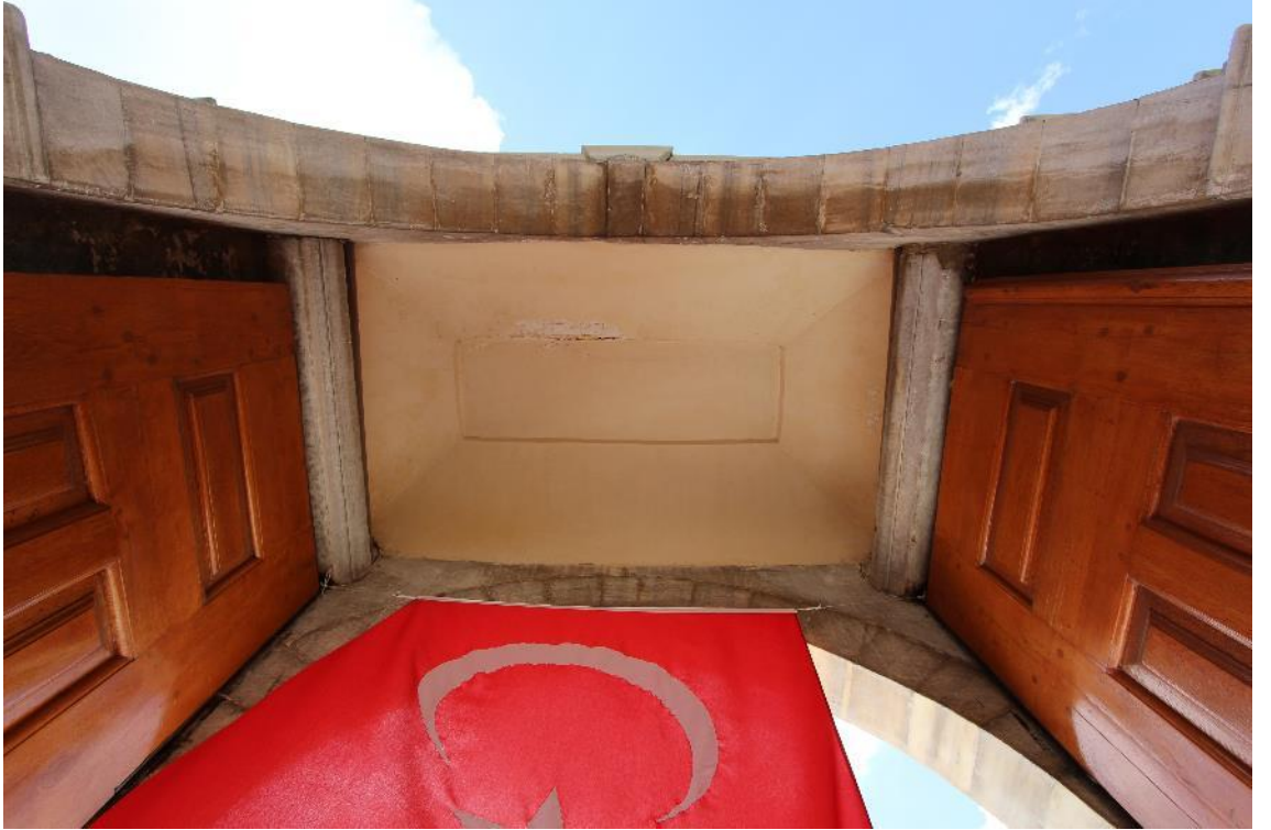
Fotoğraf 312: Eyüp Sultan Camisi Dış Avlu Güneybatı Taçkapısı Örtü Sistemi (2018)
