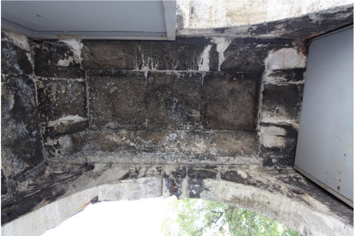
Fotoğraf 196: Ayazma Camisi Avlu Kuzeybatı Taçkapısı Örtü Sistemi (2015)
