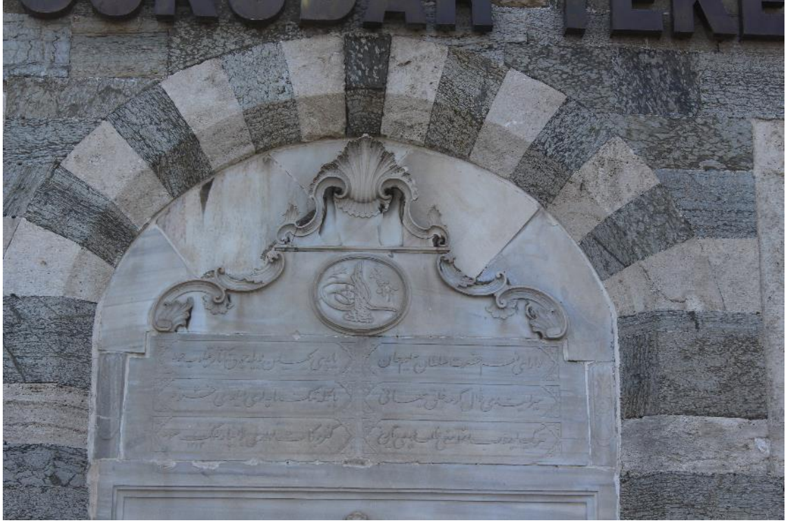
Fotoğraf 309: Tahıl Ambarı Binası Taçkapısı 1 Kitabe ve Tepelik / Taç (2015)
