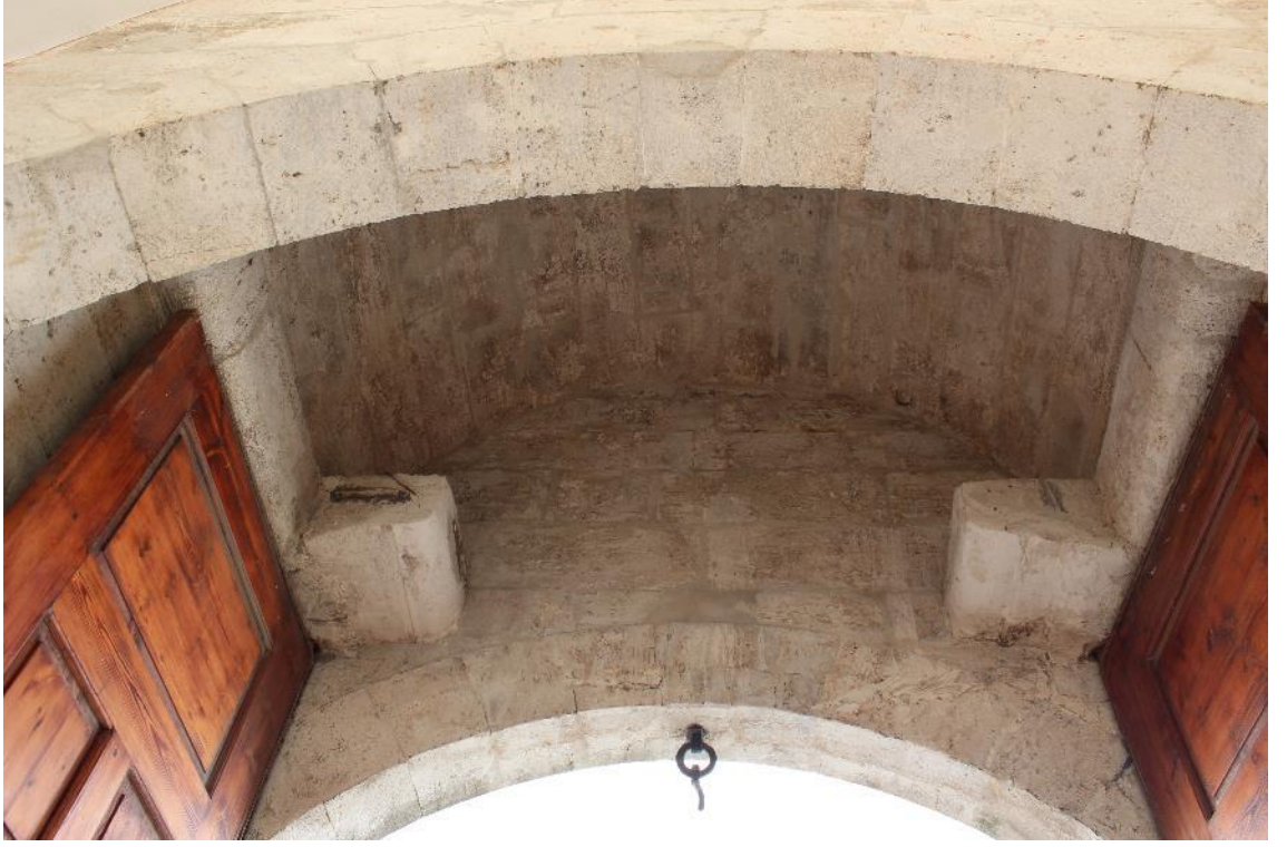
Fotoğraf 31: Yeni Valide Külliyesi Dış Avlu Kuzeybatı Taçkapısı Örtü Sistemi (2017)
