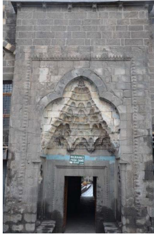
Fotoğraf 394: Diyarbakır Melek Ahmet Paşa Camisi Taçkapısı ( M. Karademir'den)
