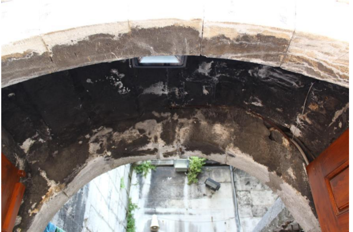
Fotoğraf 22: Çorlulu Ali Paşa Medresesi Avlu Taçkapısı Örtü Sistemi (2018)
