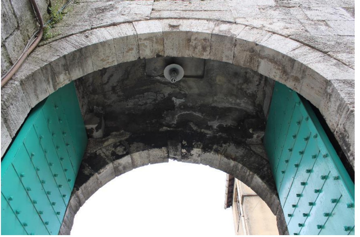
Fotoğraf 101: Hekimoğlu Ali Paşa Külliyesi Avlu Kuzeydoğu Taçkapısı Örtü Sistemi (2017)
