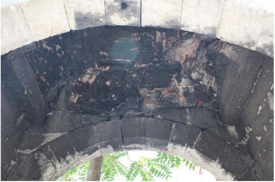
Fotoğraf 95: Hekimoğlu Ali Paşa Külliyesi Avlu Güneybatı Taçkapısı Örtü Sistemi (2018)
