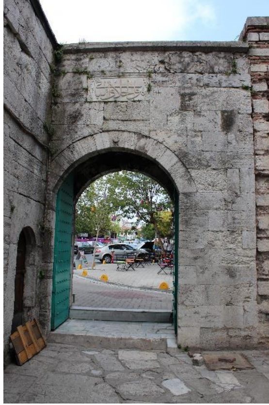
Fotoğraf 97: Hekimoğlu Ali Paşa Külliyesi Avlu Kuzeydoğu Taçkapısı Arka Yüz (2017)
