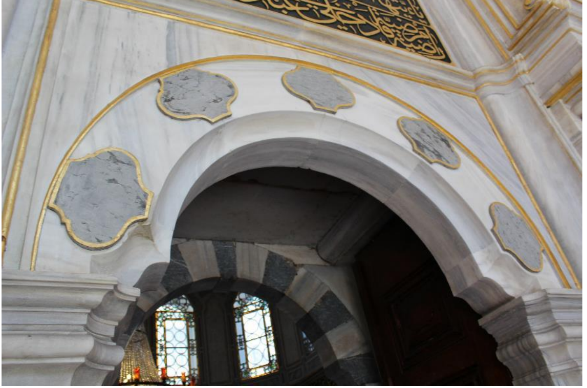
Fotoğraf 291: I. Abdülhamid Külliyesi Türbesi Taçkapısı Kemerü Üzerindeki Kakılmış Mermerler (2016)
