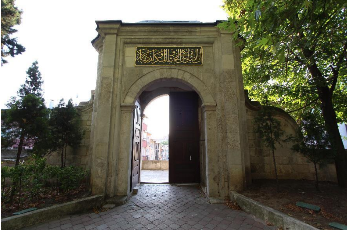
Fotoğraf 343: Üsküdar Selimiye Külliyesi Avlu Kuzeybatı Taçkapısı Arka Yüz (2015)
