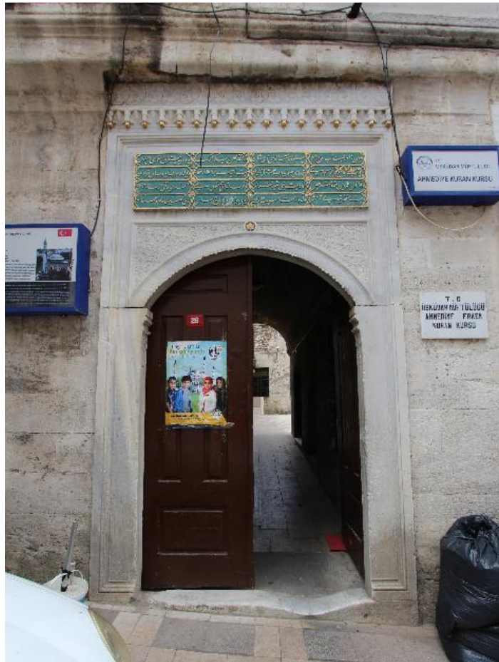
Fotoğraf 82: Ahmediye Külliyesi Avlu Güneydoğu Taçkapısı Ön Yüz (2015)
