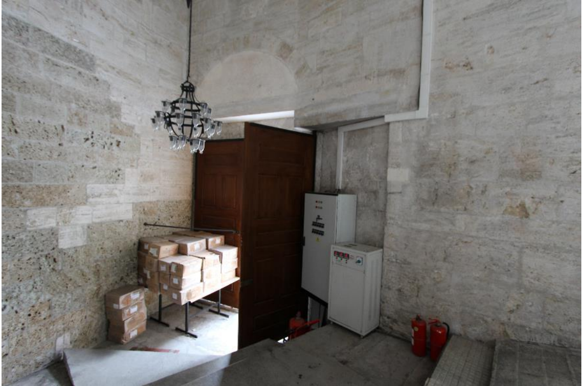
Fotoğraf 178: Nuruosmaniye Camisi Hünkâr Mahfili Rampa Taçkapısı Arka Yüz (2017)
