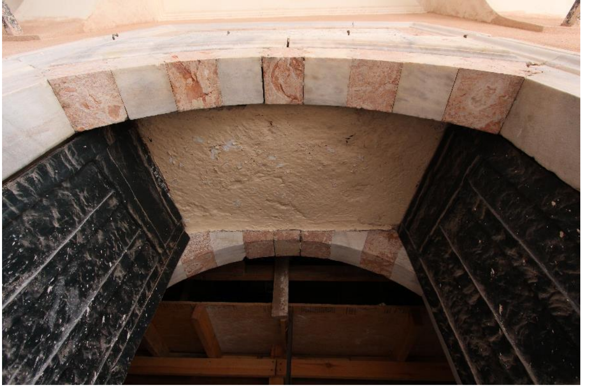
Fotoğraf 70: Damat İbrahim Paşa Külliyesi Kütüphane Taçkapısı Örtü Sistemi (2017)
