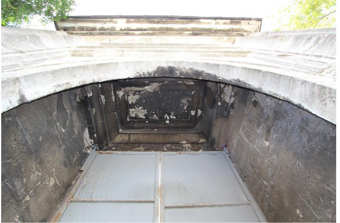
Fotoğraf 202: Ayazma Camisi Avlu Güney Taçkapısı Örtü Sistemi (2017)
