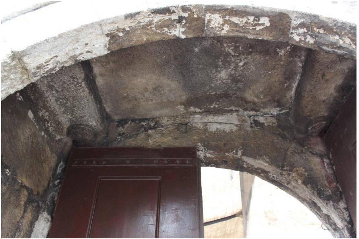
Fotoğraf 81: Ahmediye Külliyesi Avlu Kuzeybatı Taçkapısı Örtü Sistemi (2015)
