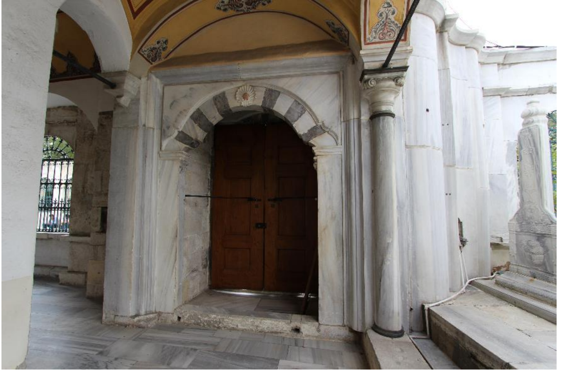
Fotoğraf 302: Mihrişah Valide Sultan Külliyesi Türbe Avlu Taçkapısı Arka Yüz (2016)
