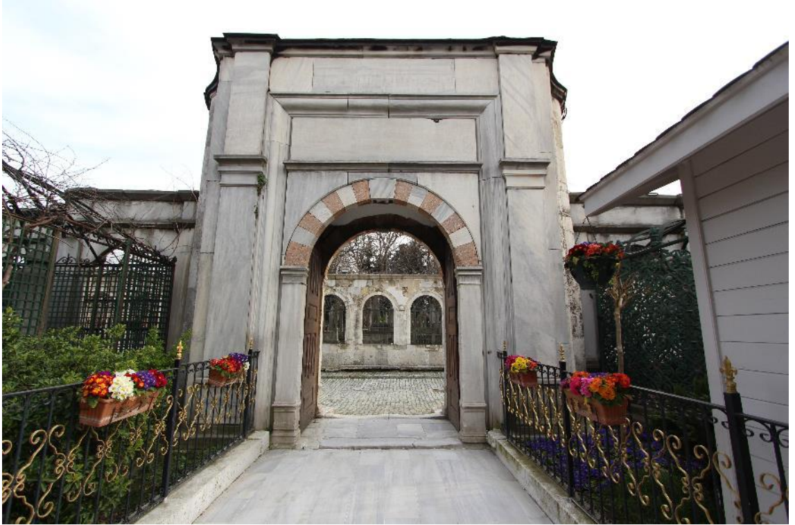
Fotoğraf 300: Mihrişah Valide Sultan Külliyesi İmaret Avlu Taçkapısı Arka Yüz (2017)
