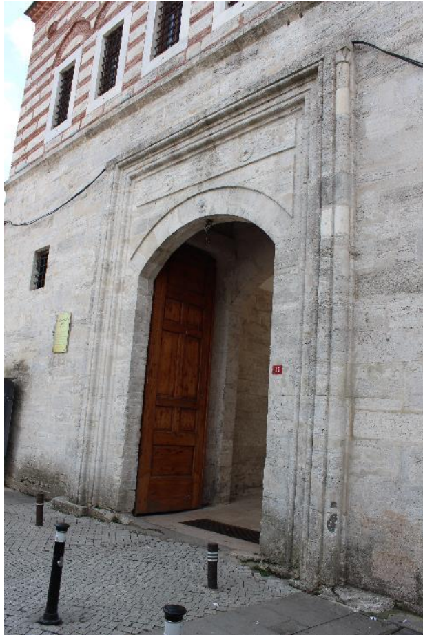
Fotoğraf 28: Yeni Valide Külliyesi Dış Avlu Kuzeybatı Taçkapısı Ön Yüz Silme Takımları (2017)
