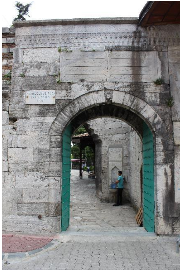
Fotoğraf 96: Hekimoğlu Ali Paşa Külliyesi Avlu Kuzeydoğu Taçkapısı Ön Yüz (2017)
