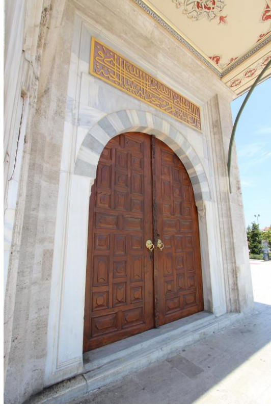
Fotoğraf 257: Fatih Camisi Hünkâr Mahfili Rampa Taçkapısı Silme Takımları (2018)
