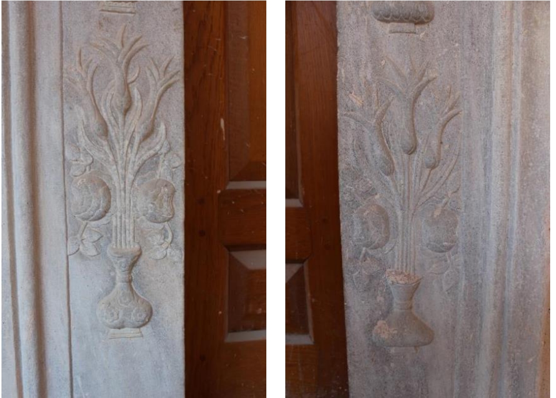
Fotoğraf 74: Damat İbrahim Paşa Külliyesi Darülhadis Mescit Taçkapısı Söve Yüzeyindeki Bezeme Detayı (2017)
