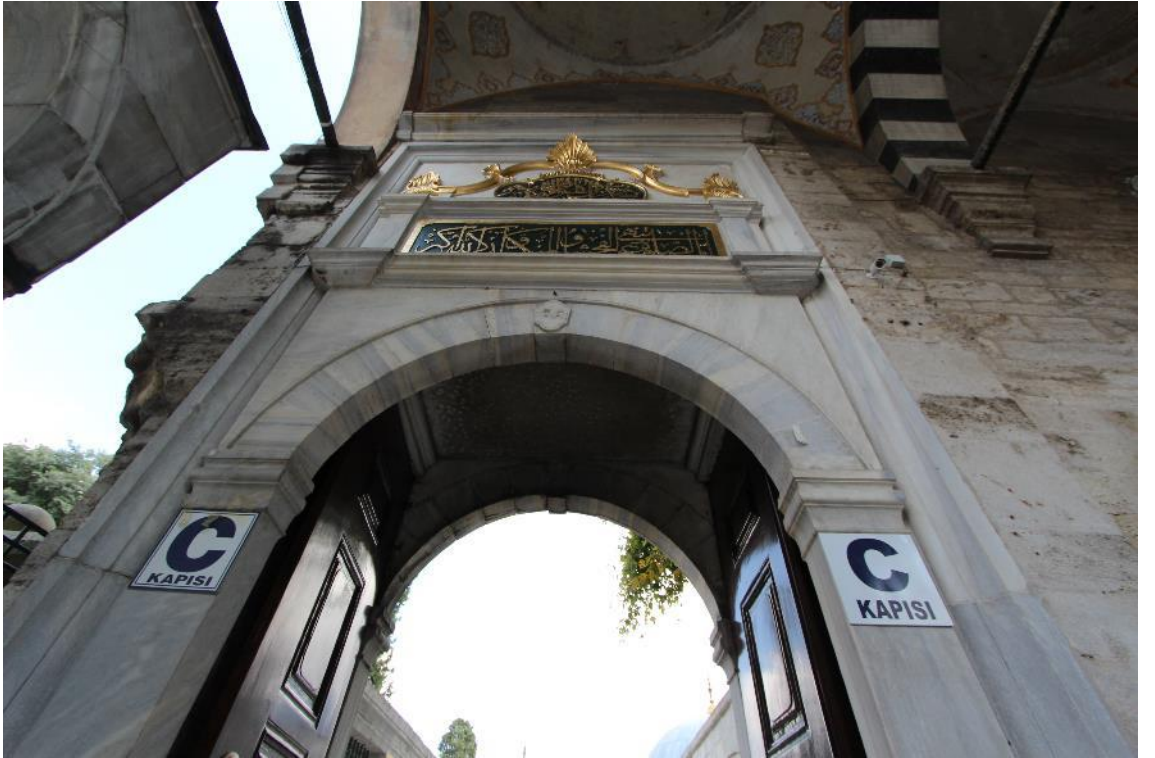
Fotoğraf 318: Eyüp Sultan Camisi İç Avlu Kuzeydoğu Taçkapısı Örtü Sistemi (2018)
