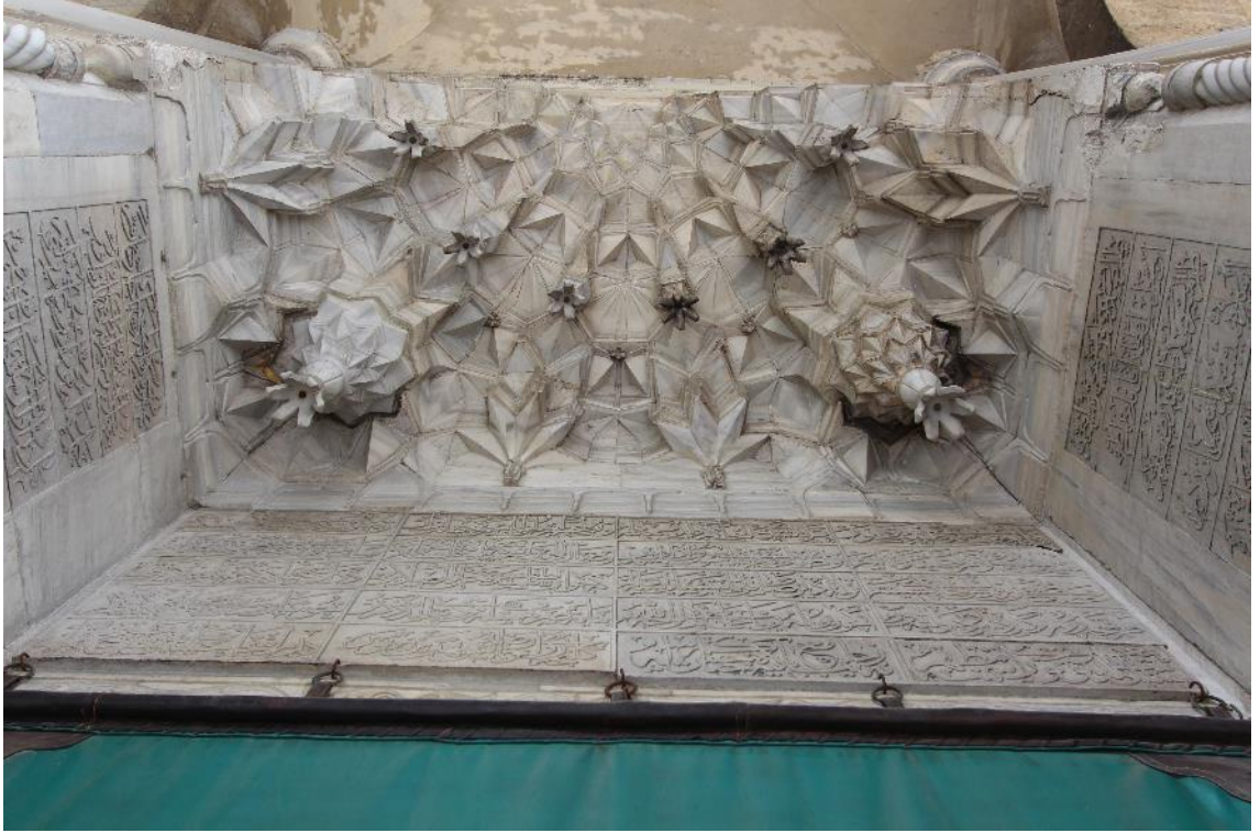
Fotoğraf 107: Hekimoğlu Ali Paşa Camisi Harim Kuzey Taçkapısı Kavsara Alttan Görünüş (2017)
