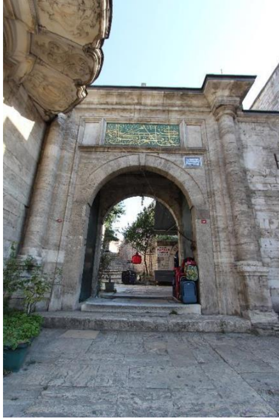
Fotoğraf 215: Laleli Külliyesi Dış Avlu Güneybatı Taçkapısı Ön Yüz (2018)
