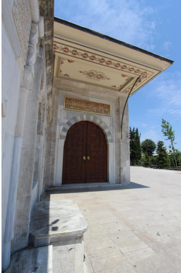
Fotoğraf 256: Fatih Camisi Hünkâr Mahfili Rampa Taçkapısı Saçak (2018)
