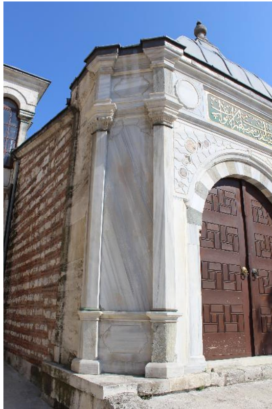
Fotoğraf 246: Laleli Camisi Hünkâr Mahfili Rampa Taçkapı Kenarındaki Pahlı Kısım (2018)
