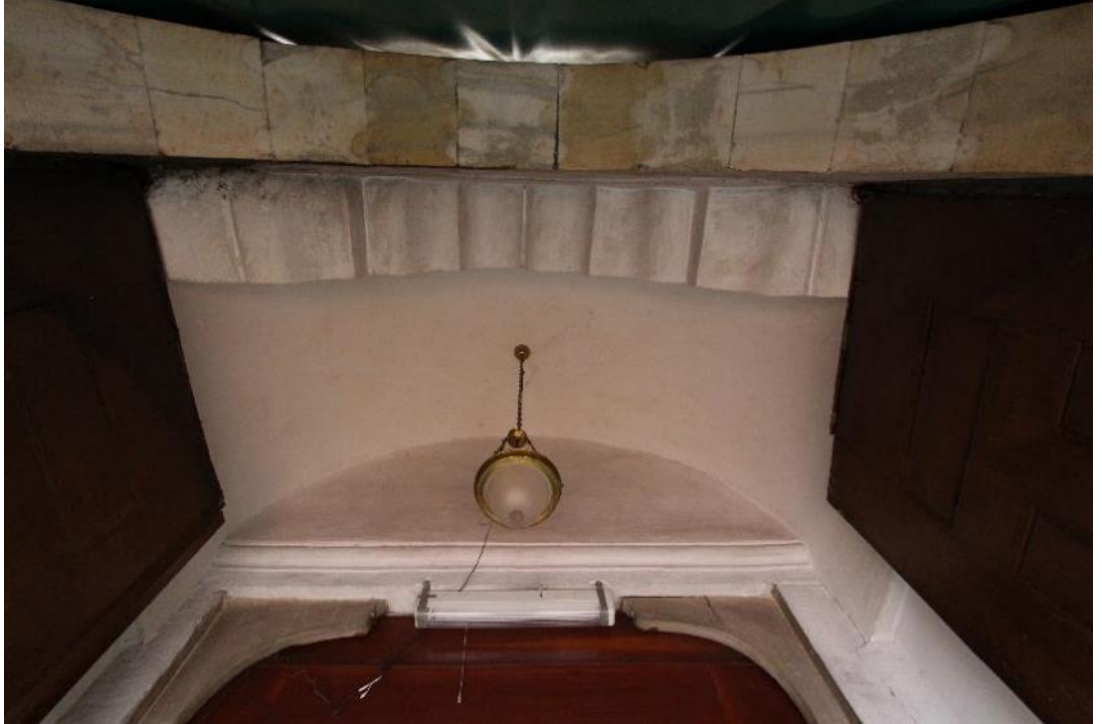
Fotoğraf 110: Hekimoğlu Ali Paşa Camisi Harim Kuzey Taçkapısı Örtü Sistemi (2017)
