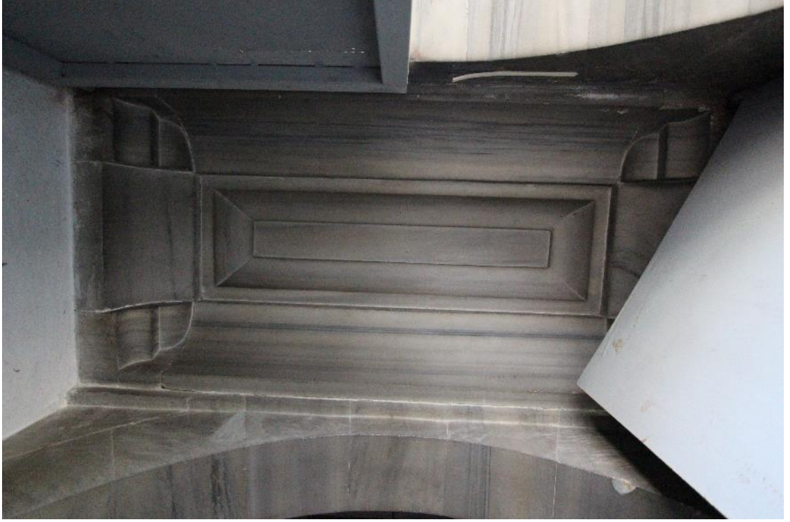
Fotoğraf 209: Ayazma Camisi Harim Kuzey Taçkapı Örtü Sistemi (2017)
