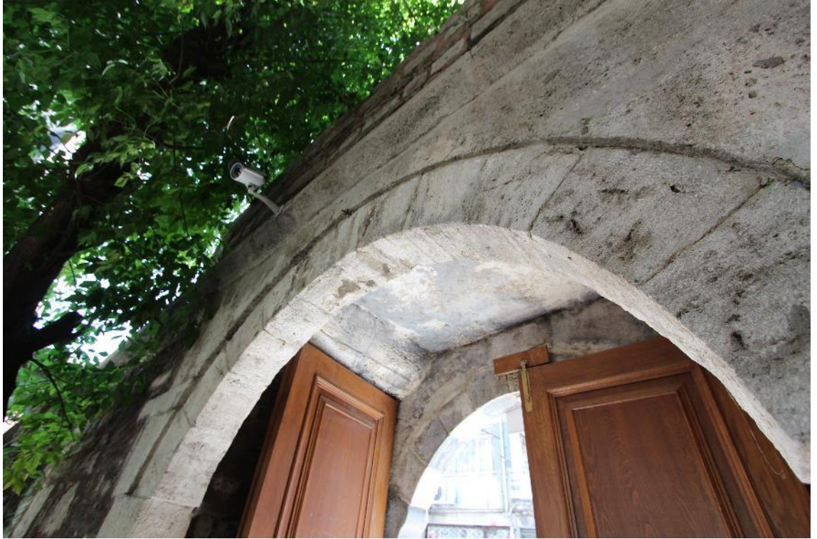
Fotoğraf 296: Nazperver Kalfa Sıbyan Mektebi Avlu Taçkapısı Örtü Sistemi (2016)
