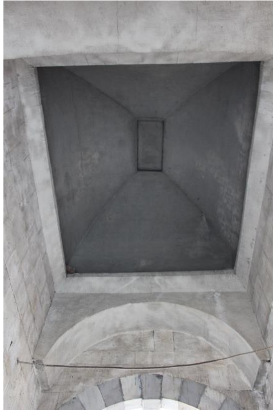
Fotoğraf 214: Laleli Külliyesi Dış Avlu Güneydoğu Taçkapısı Örtü Sistemi (2018)
