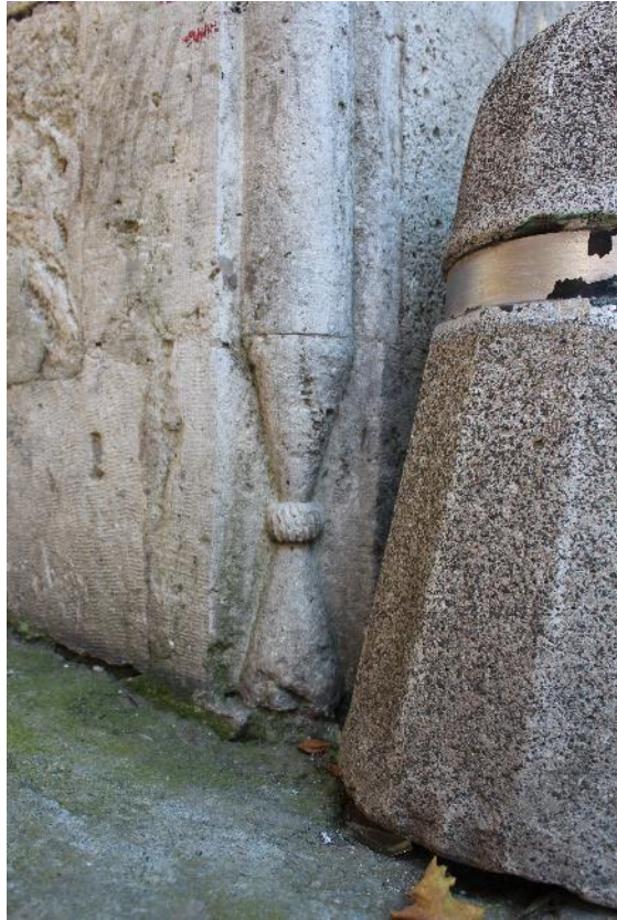
Fotoğraf 18: Bereketzâde Medresesi Avlu Taçkapısı Köşe Sütuncesi (2016)
