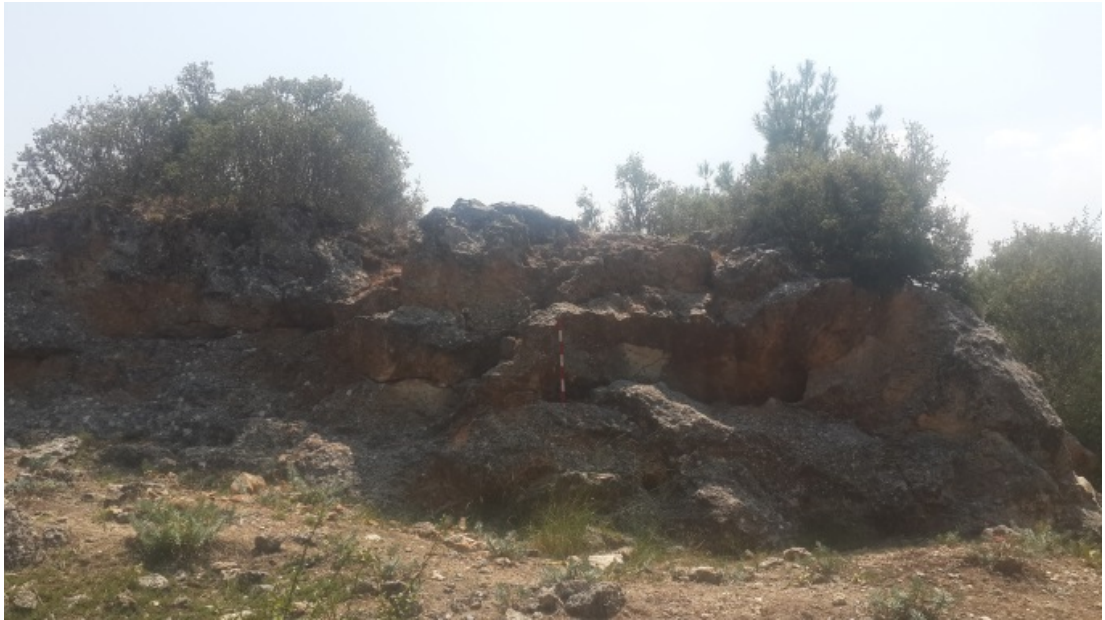
Şekil 7.10: Çatlak doğrultusuna paralel açılmış ocak aynası (ölçek çubuğu üzerindeki beyaz ve kırmızı bölümler 10 cm'dir).
