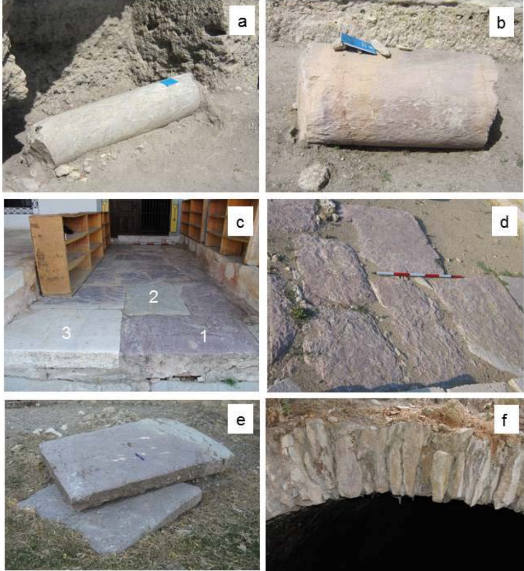
Şekil 9.2: Tabae antik kentinde plaketli kireçtaşı grubunun kullanım alanlarına örnekler. a) Gri renkli plaketli kireçtaşından yapılmış bir sütun parçası, b) Bordo renkli plaketli kireçtaşından yapılmış bir sütun, c) Cevher Paşa Camisi girişinde kullanılmış bordo (1) ve gri (2) renkli plaketli kireçtaşları, (3) Mermer. d) yola döşenmiş bordo renkli, boyutlandırılmış plaketli kireçtaşları, e) Boyutlandırılmış bordo renkli plaketli kireçtaşı parçaları, f) Kemerli sarnıç girişinin üst kısmında kullanılmış plaketli kireçtaşları
