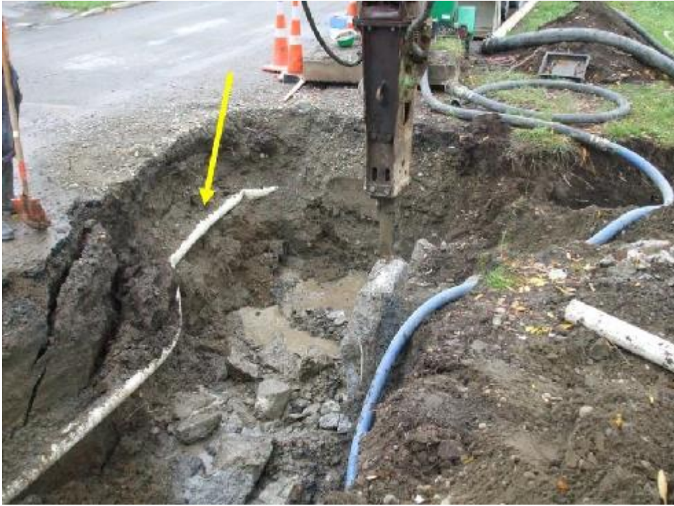
Şekil 3.3: Eksenel olarak bozulmuş ancak çalışır durumdaki PVC tipi boru (O'Callaghan 2014)
