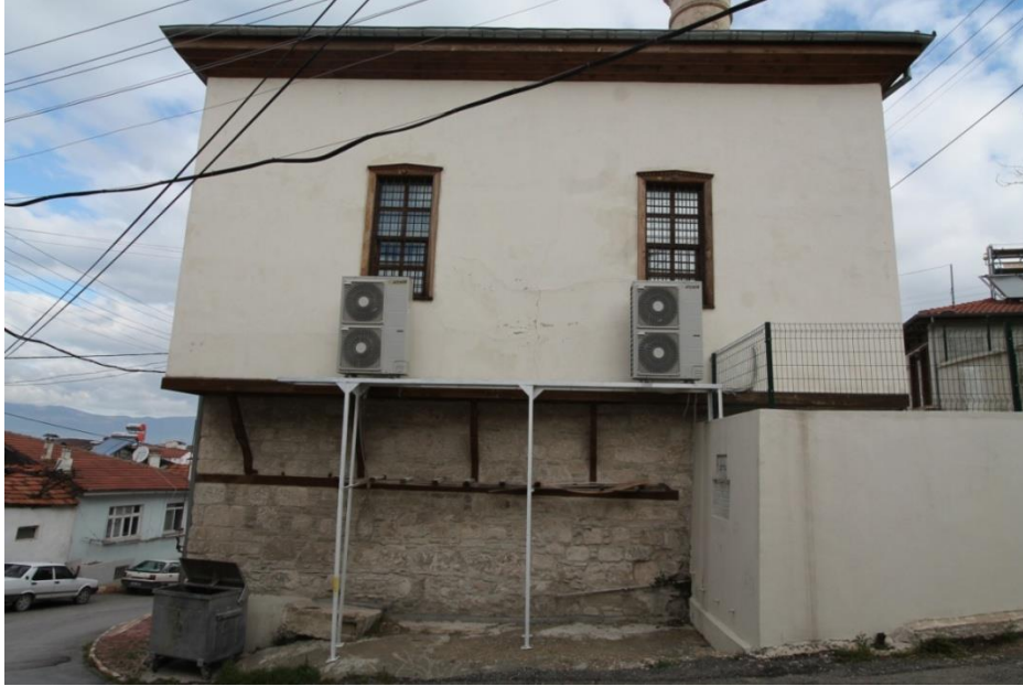
Fot. 169: Güney Cepheden Görünüm
