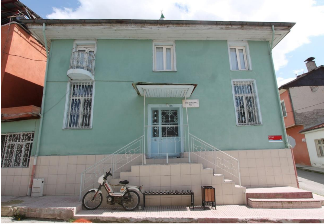
Fot. 317: Kuzey Cepheden Görünüm
