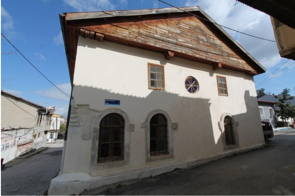
Fot. 5: Güney Cepheden Görünüm
