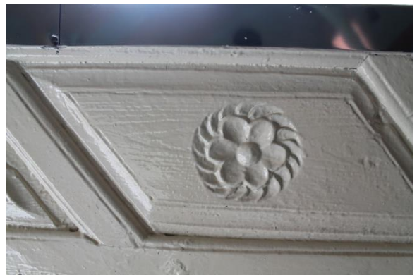
Fot. 66: Korkuluk Panolarından Birinden Görünüm
