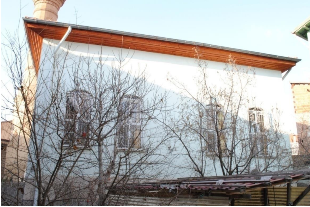
Fot. 245: Güney (Kible) Cephesinden Görünüm (M. Ekmekci/2011)
