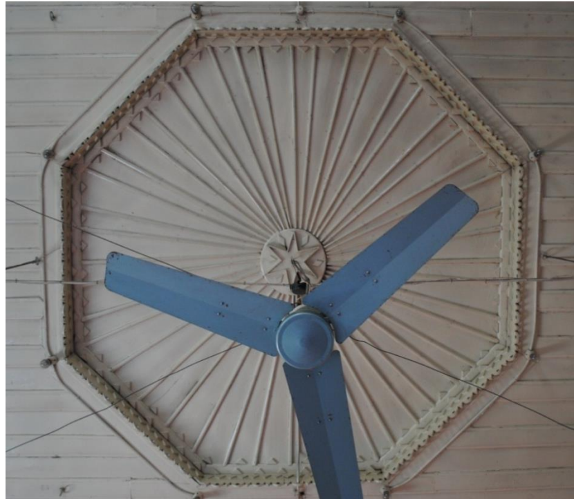
Fot. 193: Onarım Öncesi Tavan Göbeğinden Görünüm (M. Ekmekci/2011)
