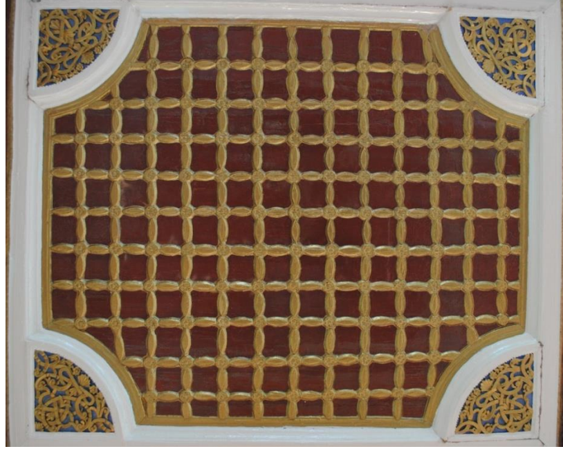
Fot. 138: Müezzin Mahfilinin Tavanından Görünüm
