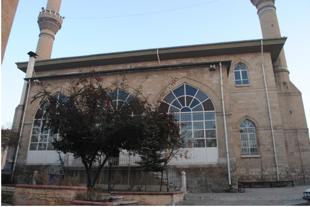
Fot. 125: Kuzey Cepheden Görünüm
