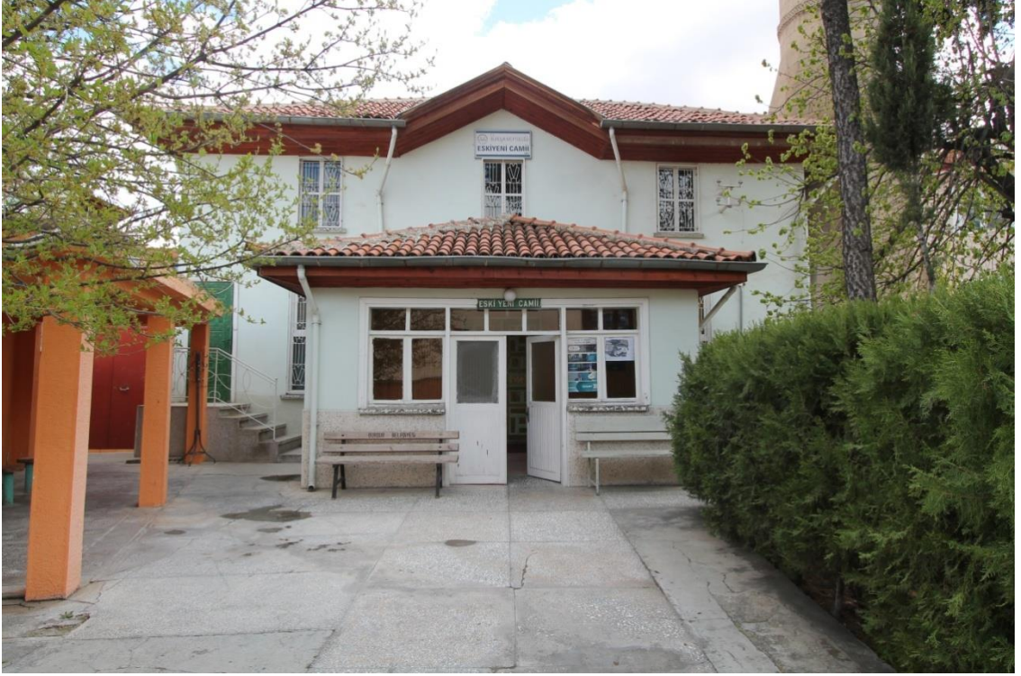
Fot. 247: Kuzey Cepheden Görünüm
