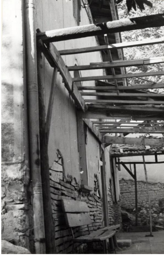
Fot. 313: Kuzey Cephe Duvar Örgü Tekniğinden Görünüm (VGM.'den)
