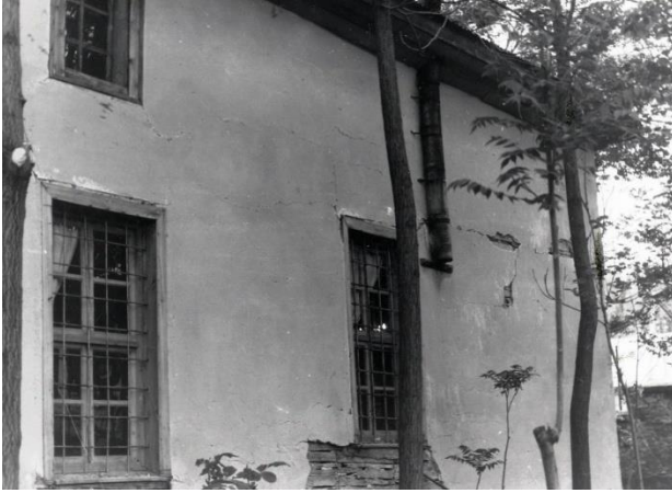
Fot. 93: Caminin Batı Cephesinden Yapının İnşa Tekniğini Gösteren Görünüm (VGM.'den)
