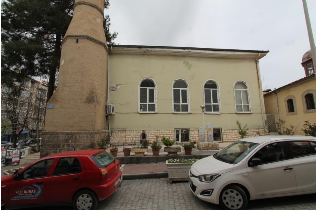
Fot. 97: Batı Cepheden Görünüm
