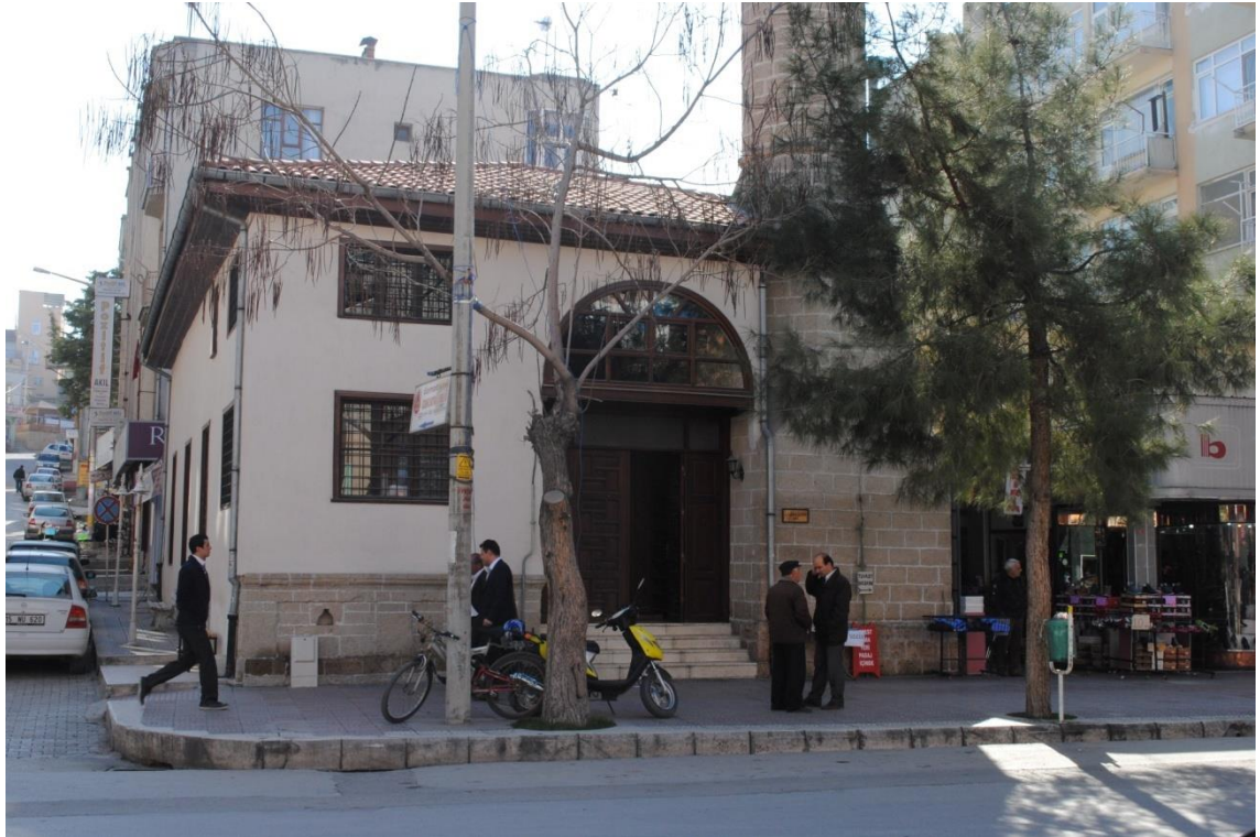
Fot. 31: Kuzey Cepheden Görünüm
