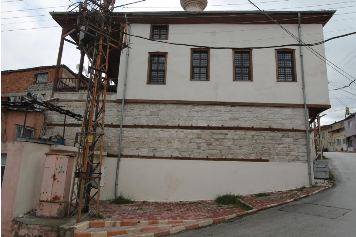
Fot. 172: Batı Cepheden Görünüm
