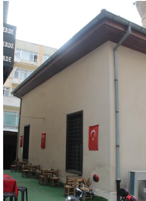
Fot. 29: Güney (Kible) Cephesinden Görünüm
