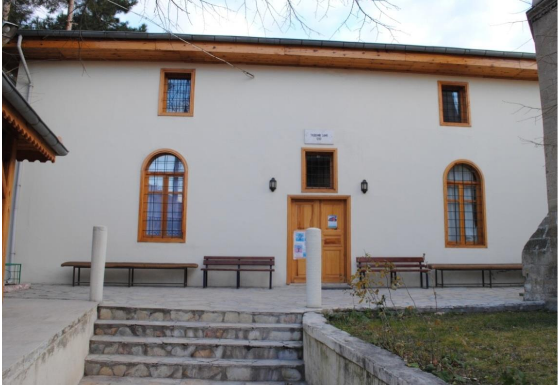
Fot. 297: Kuzey Cepheden Görünüm
