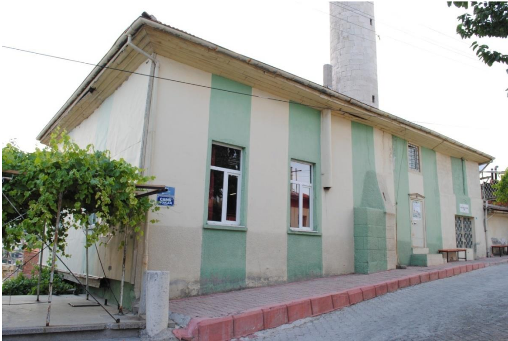
Fot. 168: Onarımlar Öncesi Doğu Cepheden Görünüm (M.Ekmekci/2011)
