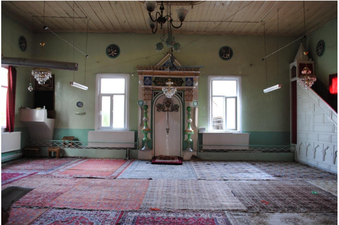
Fot. 180: Onarım Öncesi Güney Duvarından Görünüm (M. Ekmekci/2011)
