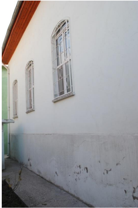
Fot. 244: Caminin Doğu Cephesinden Görünüm
