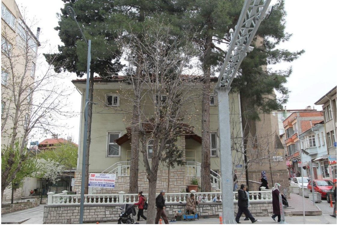
Fot. 99: Kuzey Cepheden Görünüm
