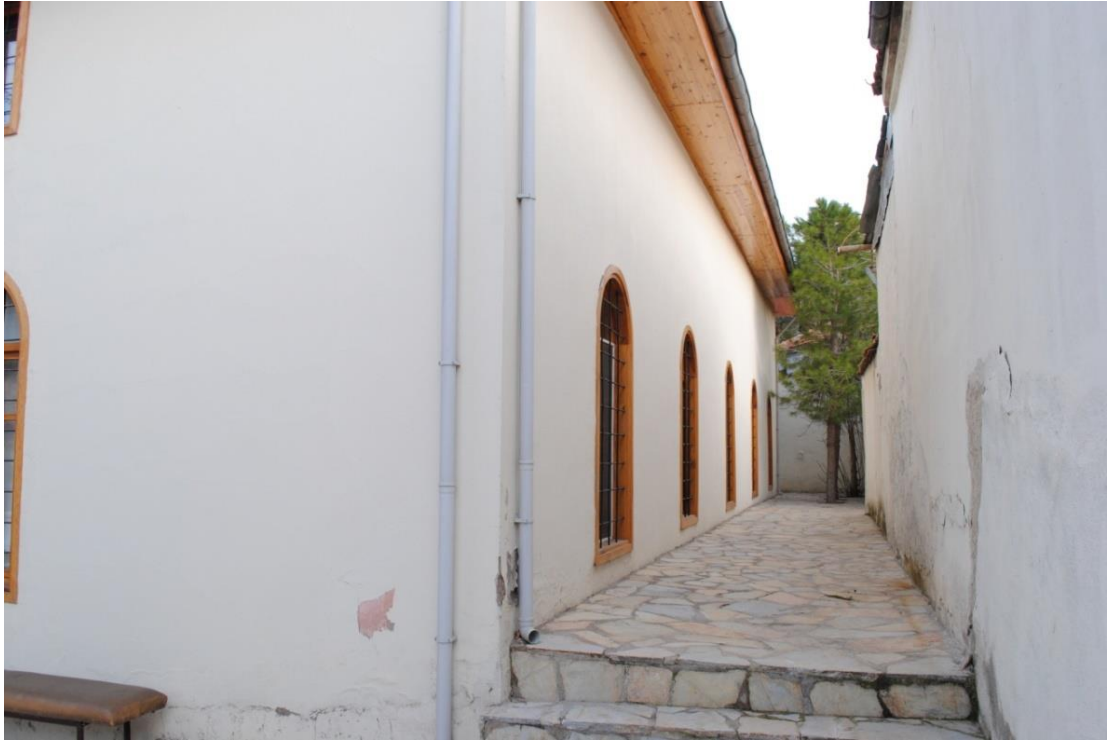
Fot. 296: Batı Cepheden Görünüm
