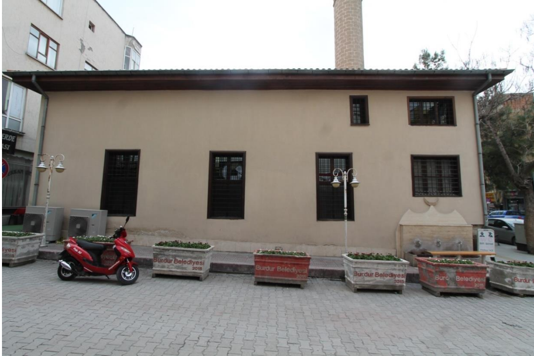
Fot. 28: Doğu Cepheden Görünüm
