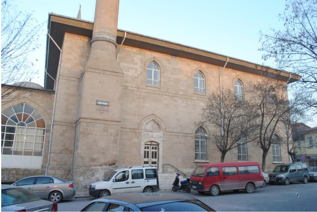
Fot. 124: Batı Cepheden Görünüm
