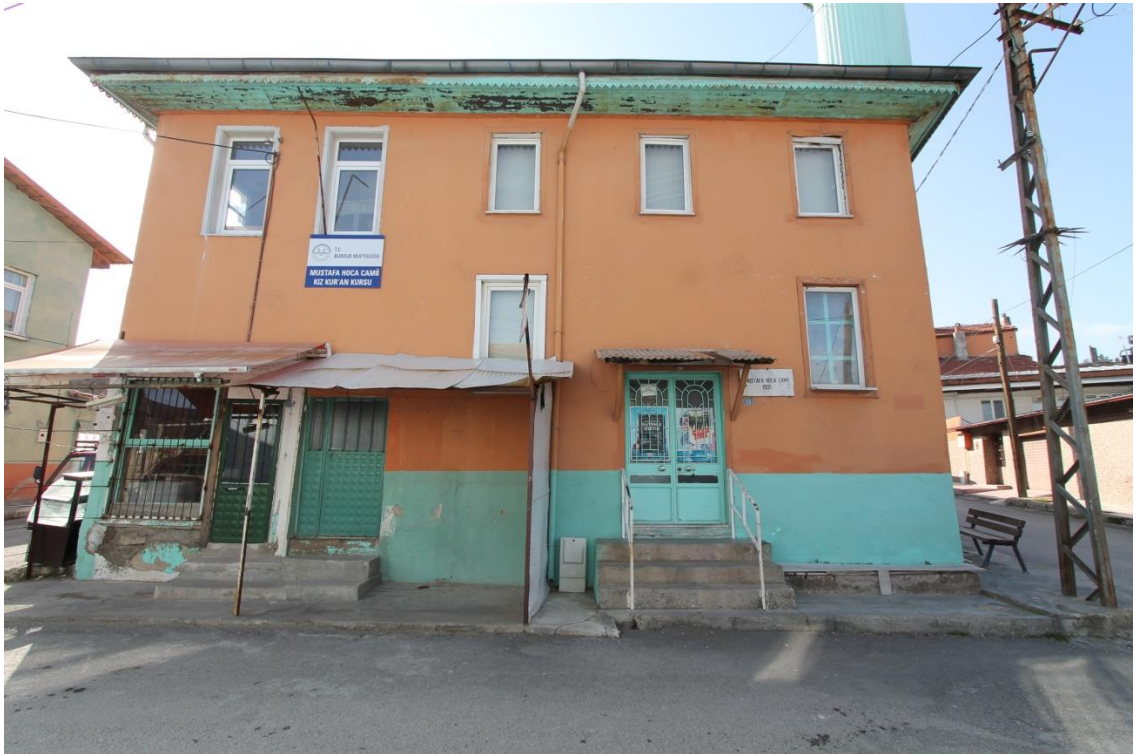
Fot. 279: Kuzey Cepheden Görünüm
