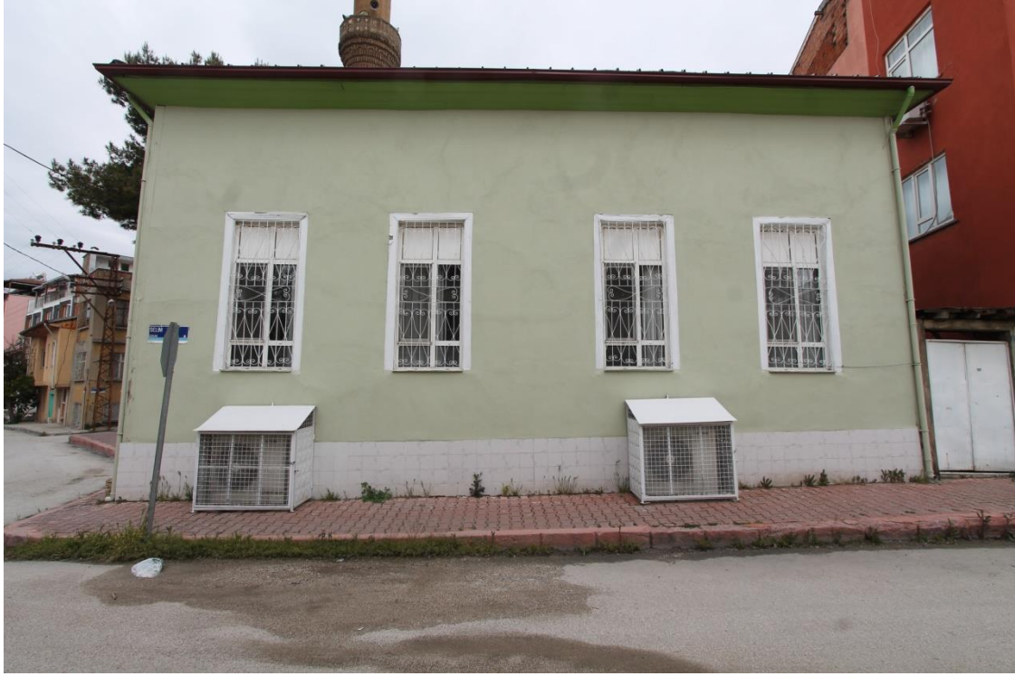
Fot. 51: Cami Güney Cepheden Görünüm
