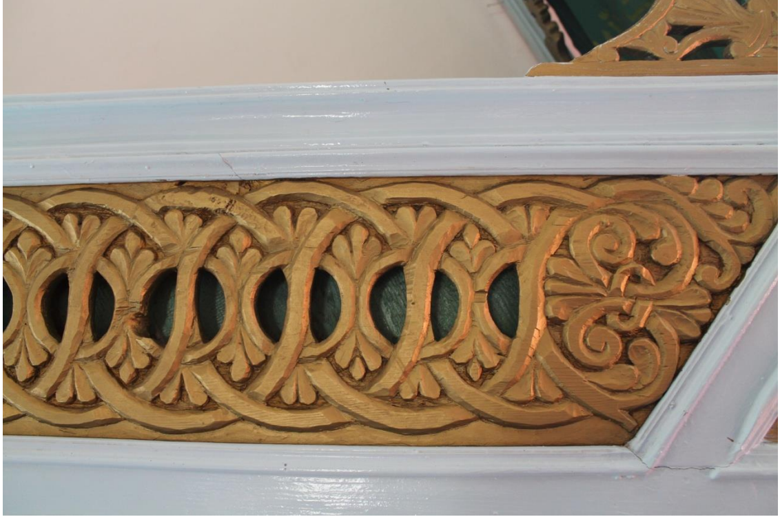
Fot. 328: Korkuluktan Detay Görünüm
