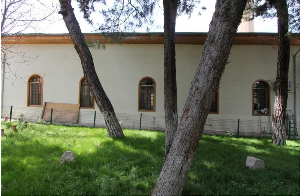
Fot. 294:Doğu Cepheden Görünüm
