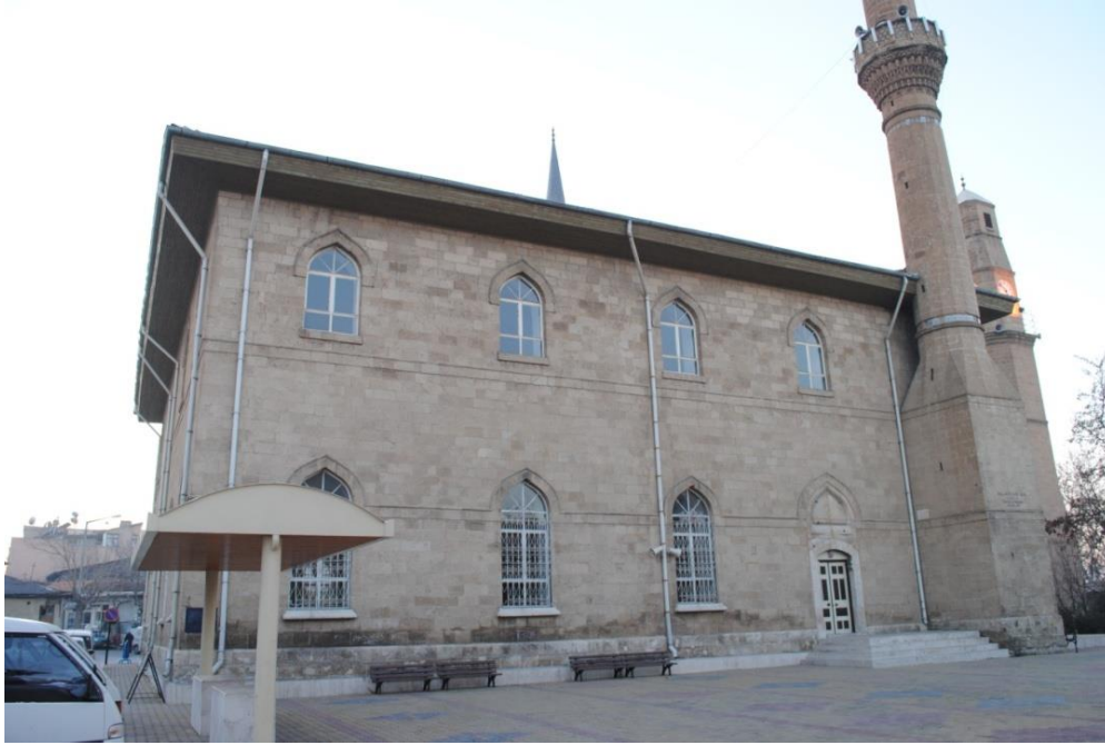
Fot. 122: Doğu Cepheden Görünüm (M. Ekmekci/2011)
