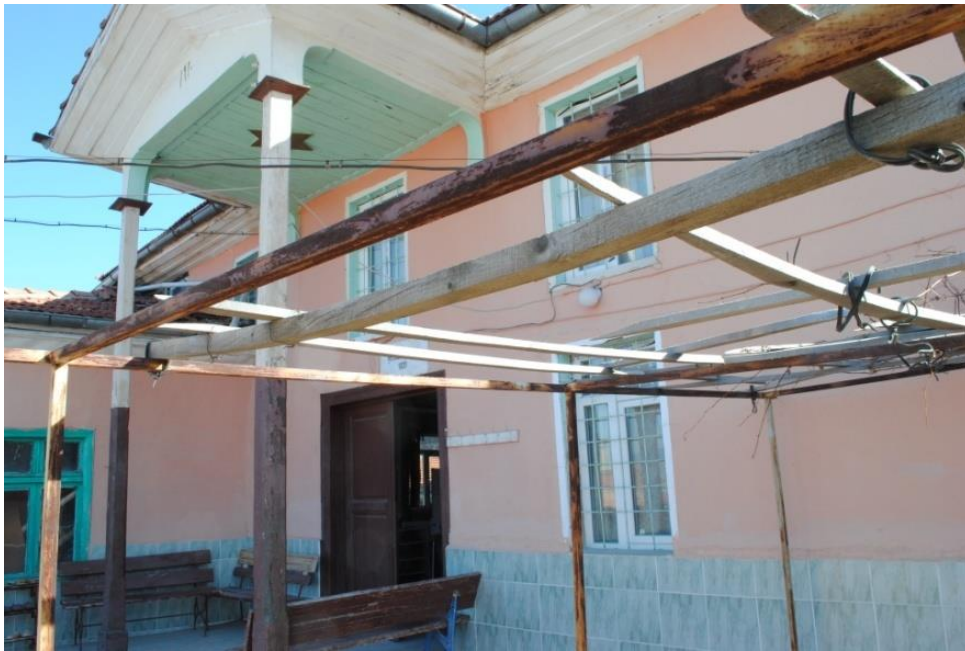
Fot. 207: Kuzey Cepheden Görünüm
