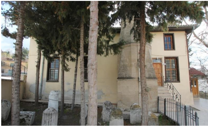
Fot. 72: Caminin Doğu Cephesinden Görünüm
