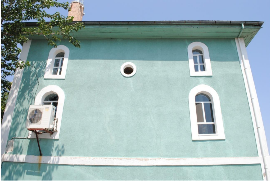
Fot. 225: Güney Cepheden Görünüm
