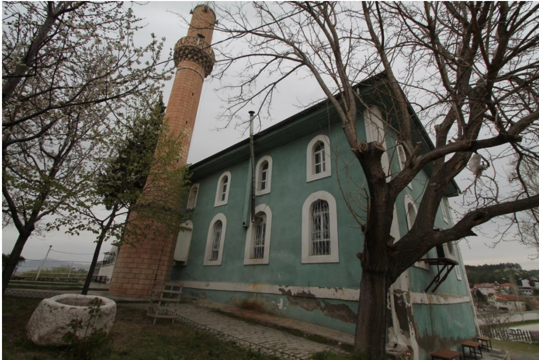
Fot. 226: Batı Cepheden Görünüm
