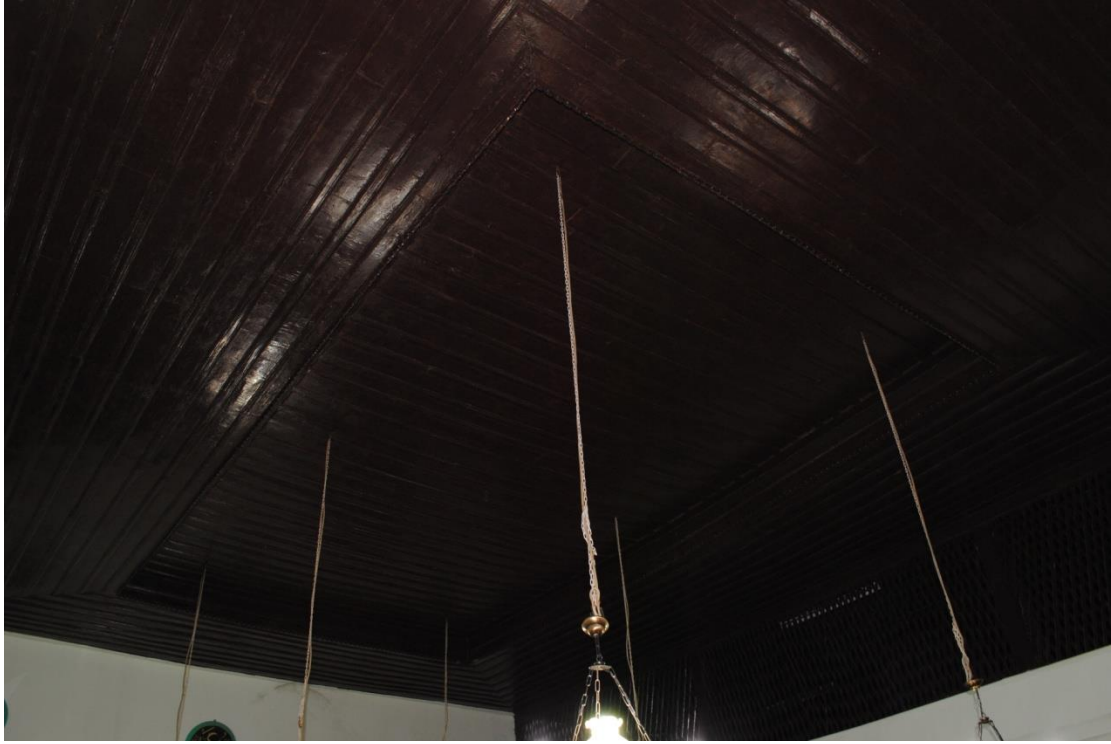
Fot. 81: Harim Çökertme Tavandan Görünüm
