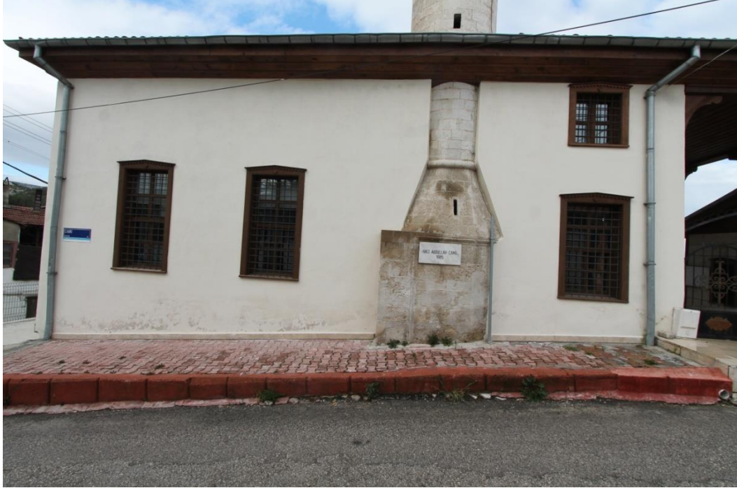
Fot. 167: Doğu Cepheden Görünüm
