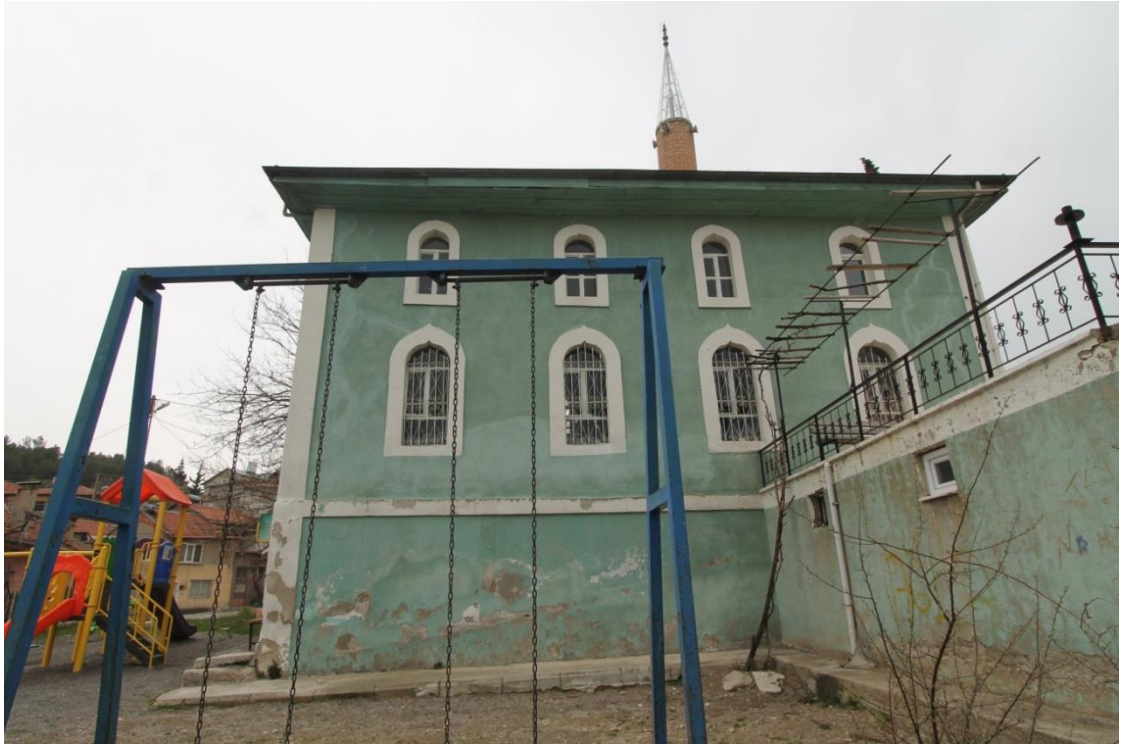
Fot. 224: Doğu Cepheden Görünüm
