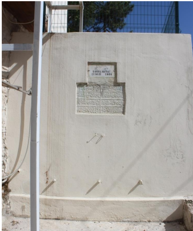
Fot. 170: Güneydoğu Köşedeki Depolu Çeşme
