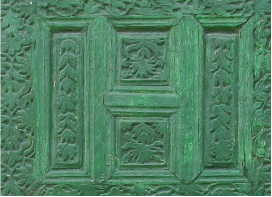
Fot. 266: Kare ve Dikey Dikdörtgen Formlu Panolardan Görünüm
