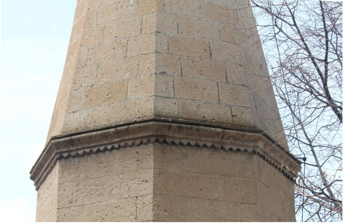
Fot. 310: Minare Kaidesinden Detay Görünüm
