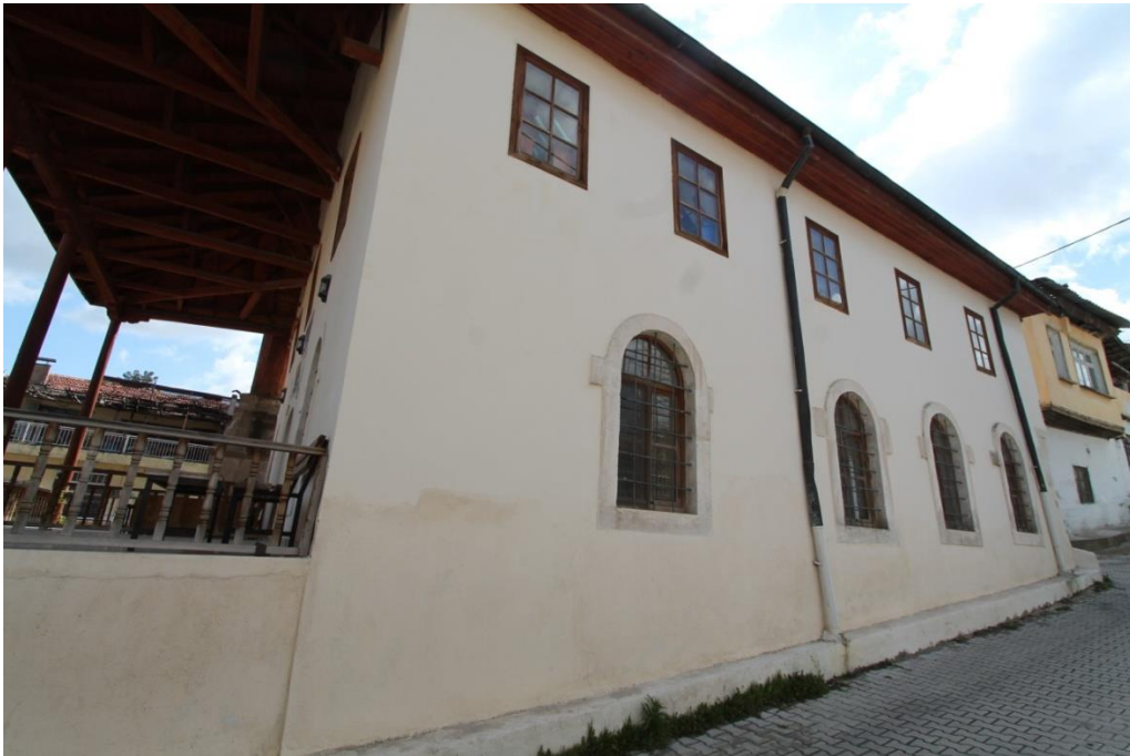
Fot. 6: Batı Cepheden Görünüm
