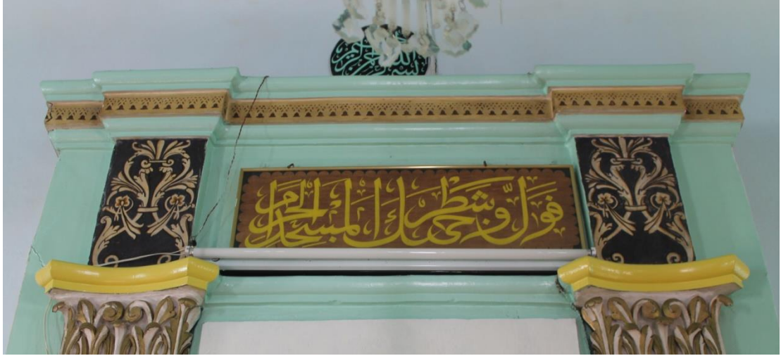
Fot. 216: Mihrap Taç Kısımından Görünüm
