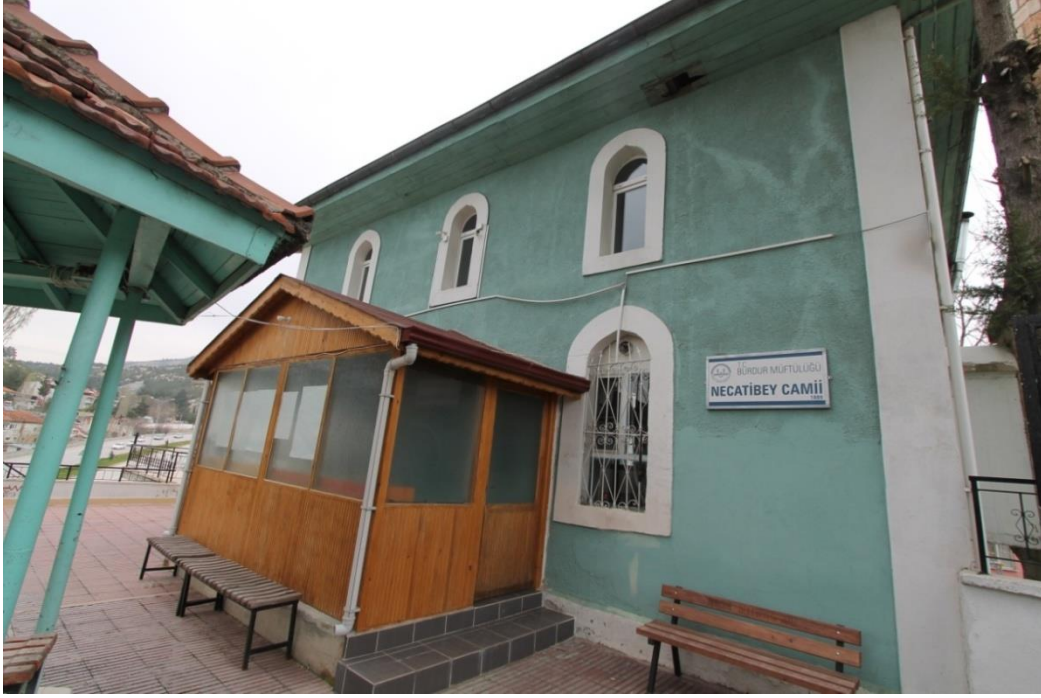
Fot. 227: Kuzey Cepheden Görünüm
