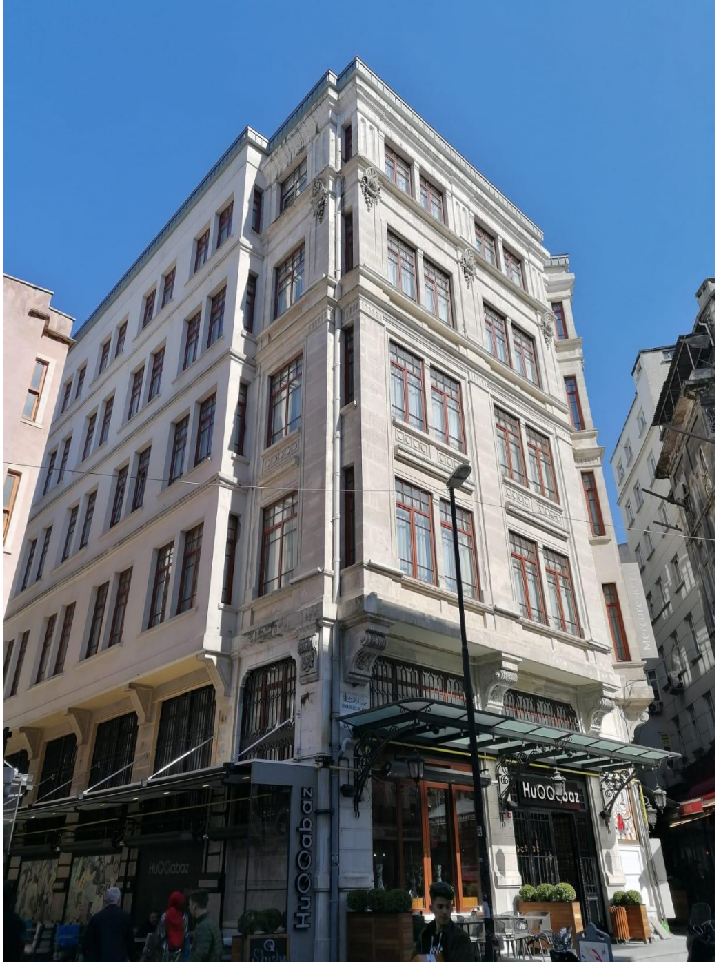
Ek 17: The National Bank of Turkey'nin İstanbul Sirkeci'deki Merkez İdare Binası Kınacıyan'ın günümüzdeki hali (Bu fotoğraf 11 Mart 2020'de çekilmiştir).
