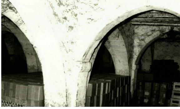
Foto. 969. Mersin Amerikan İnas İdâdisi A-Blok Bodrum Kat Sivri Kemerli Ayaklardan Bir Görünüm (Adana KTVKK.)
