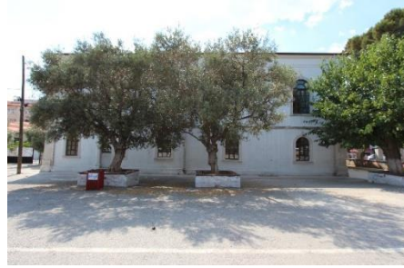
Foto. 625. Muğla İdâdisi Doğu Cephe
