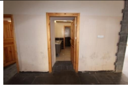
Foto. 125. Diyarbakır İdâdîsi Zemin Kat wc.
