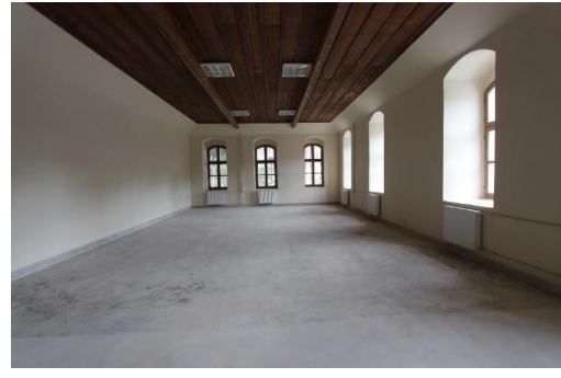
Foto. 48. Bursa İdâdîsi Zemin Kat ZK-02 Nolu Mekân
