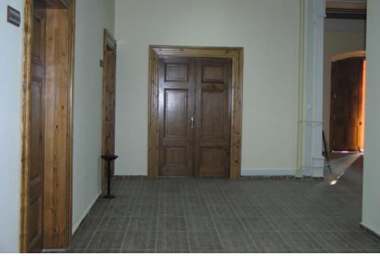
Foto. 493. Bilecik İdâdîsi 2005 Restorasyonu Sonrası Kapı Doğramalarında Meydana Gelen Değişim
