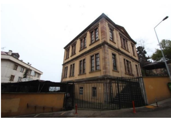
Foto. 1021. Trabzon Rum İdâdîsi Güneybatı Cephe
