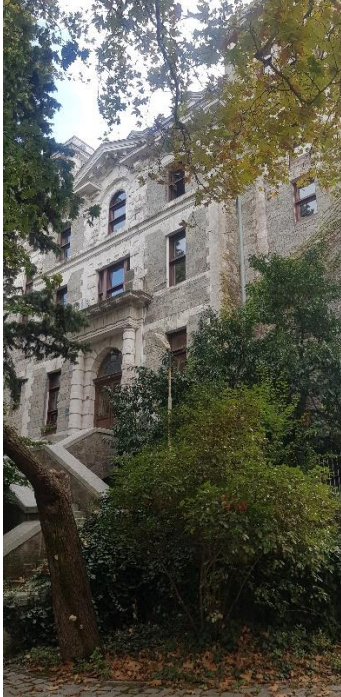
Foto. 1086. Robert Amerikan Koleji Washburn Hall Binası Doğu Cephe
