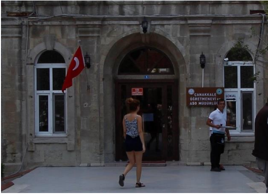
Foto. 186. Çanakkale İdâdîsi Güney Giriş Kapısı
