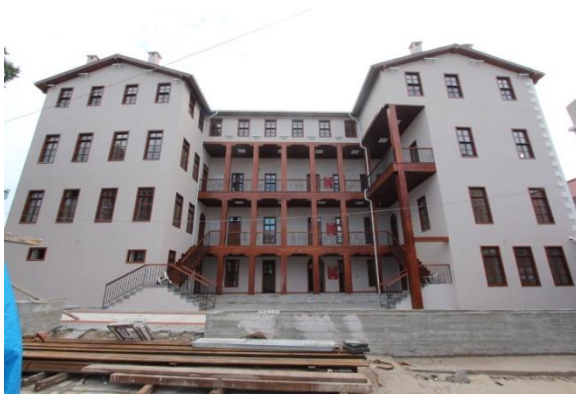
Foto. 816. Adana Amerikan İnas İdadisi Batı Cephe Koridorları
