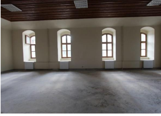
Foto. 51. Bursa İdâdîsi Zemin Kat ZK-05 Nolu Mekân
