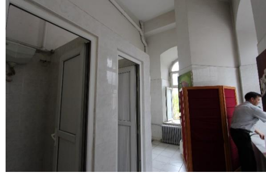
Foto. 393. Balıkesir İdâdîsi Zemin Kat Tuvaletleri (2)
