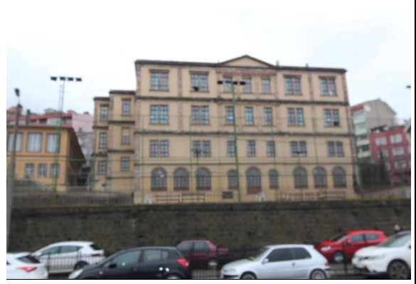
Foto. 1022. Trabzon Rum İdâdîsi Kuzey Cephe (1)
