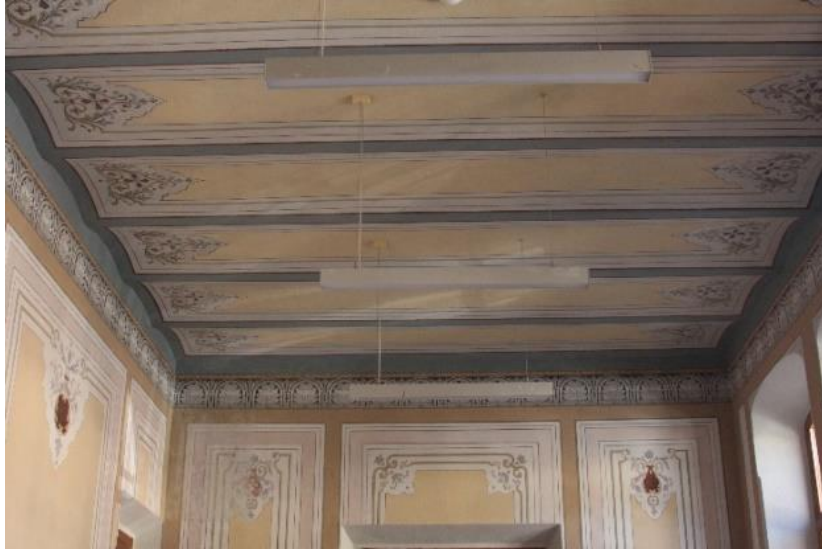
Foto. 1041. Üsküdar Saint İmmaculle Conception (St. Marie) Fransız İdâdisi Z-03 Nolu Mekânın Tavan Kalem İşi Bezeme Kompozisyonu
