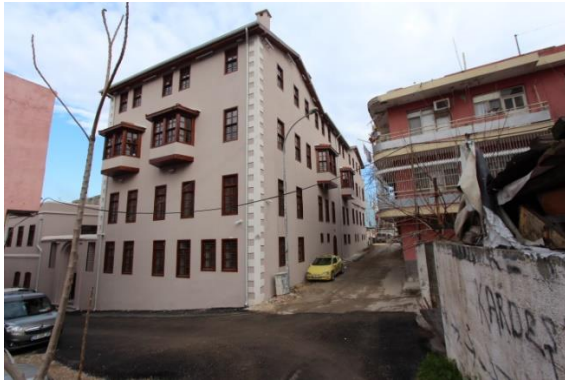
Foto. 846. Adana Amerikan İnas İdâdîsi Doğu Cephe
