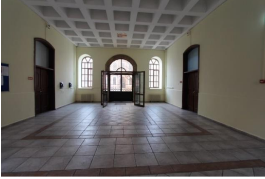
Foto. 158. Bursa Askeri İdâdîsi Zemin Kat Kuzey Giriş Holü
