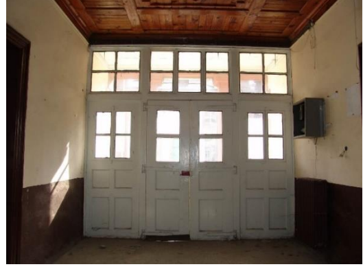
Foto. 466. Söğüt İdâdisi Güney Giriş Kapı Doğraması
