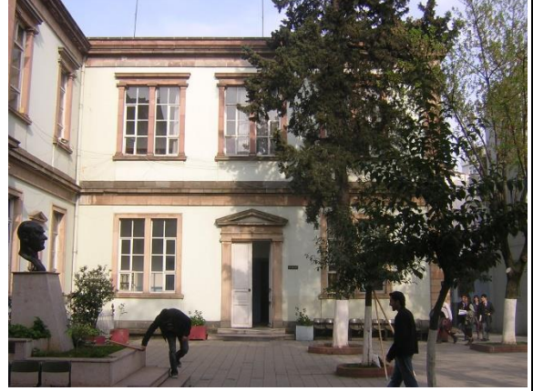
Foto. 1016. Trabzon Rum İdâdisi Doğu Kanat Batı Cephe
