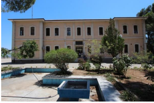
Foto. 365. Aydın İdâdîsi Güney Cephe
