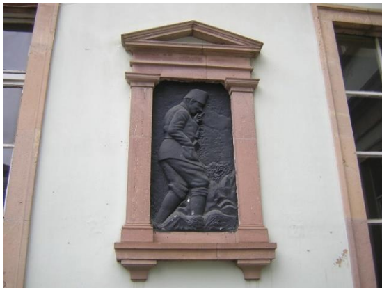
Foto. 1019. Trabzon Rum İdâdisi Güney Cephe Zemin Kat Dekoratif Kartuş (1)
