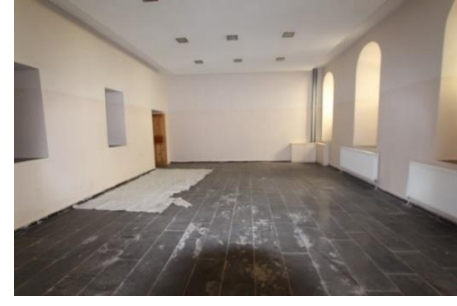
Foto. 124. Diyarbakır İdâdîsi ZK-05 Nolu Mekân
