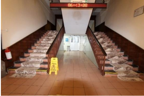
Foto. 450. Sinop İdâdîsi Merdivenleri
