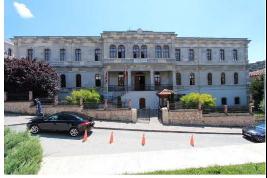
Foto. 26. Kastamonu İdâdîsi Kuzey Cephe
