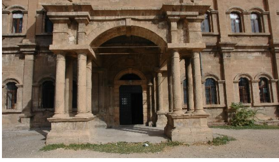
Foto. 788. Mardin İdâdîsi Giriş Cephesi Zemin Kattan Bir Görünüş
