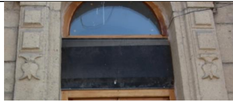
Foto. 114. Kütahya İdadisi Güney Cephe Pencere Bezeme Detayı
