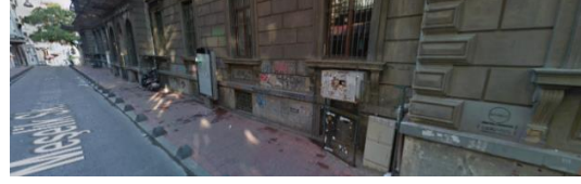
Foto. 863. Zapyon Rum İnas İdâdisi Güney Cephe Zemin Kat
