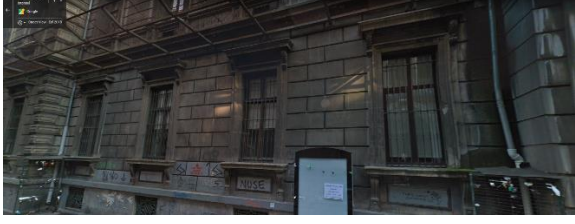
Foto. 862. Zapyon Rum İnas İdâdisi Güney Cephe Zemin Kat Pencereleeri
