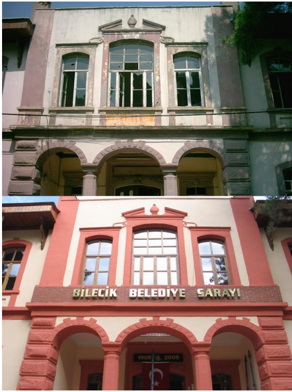
Foto. 491. Bilecik İdâdîsi 2005 Restorasyonu Sonrası Güney Cephe
