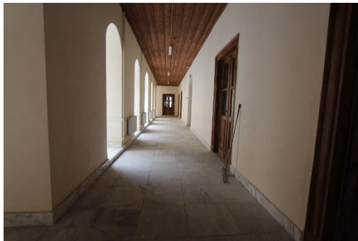
Foto. 43. Bursa İdadisi Zemin Kat Dolanma Koridoru
