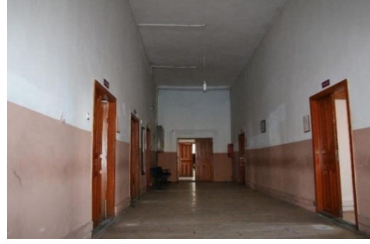
Foto. 423. Bitlis İdâdîsi Zemin Kat Koridoru
