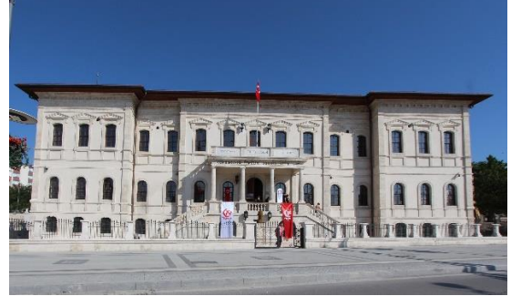
Foto. 280. Sivas İdâdîsi Doğu Cephe
