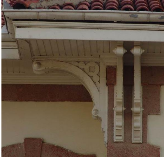
Foto. 487. Söğüt İdâdisi Çatı Konsolları
