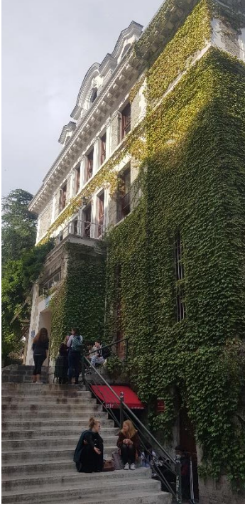
Foto. 1087. Robert Amerikan Koleji Washburn Hall Binası Batı Cephe
