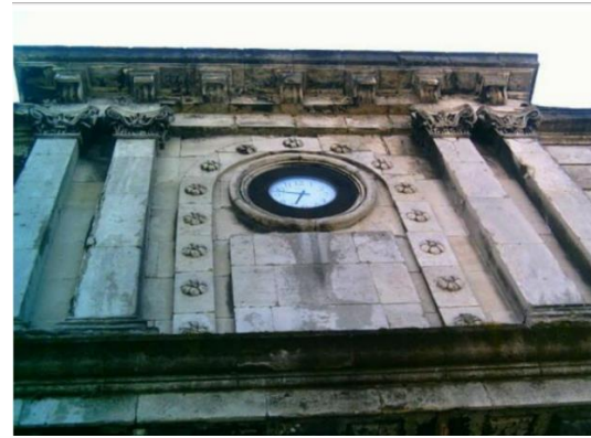
Foto. 867. Zapyon Rum İnas İdâdisi Kuzey Cephe Saat Uygulaması (Zapyon Lisesi Arşivi)
