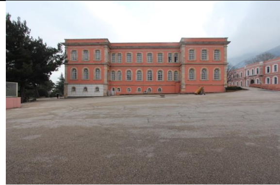
Foto. 182. Bursa Askeri İdâdîsi Doğu Cephe
