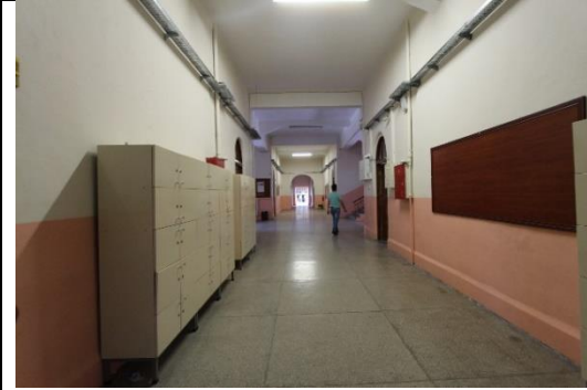
Foto. 87. Kütahya İdâdîsi Zemin Kat Koridoru
