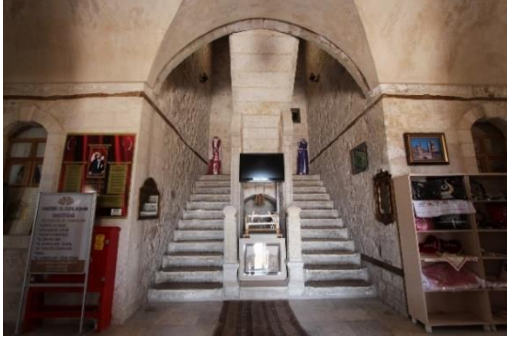
Foto. 768. Mardin İdâdîsi Merdiven Sahanlığı
