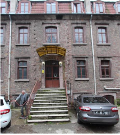
Foto. 955. İzmit St. Barbe Fransız İdâdisi Kuzey Giriş Kapısı
