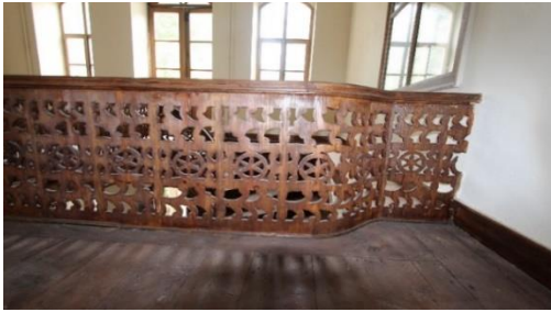
Foto. 79. Bursa İdâdîsi Merdivenleri (2)
