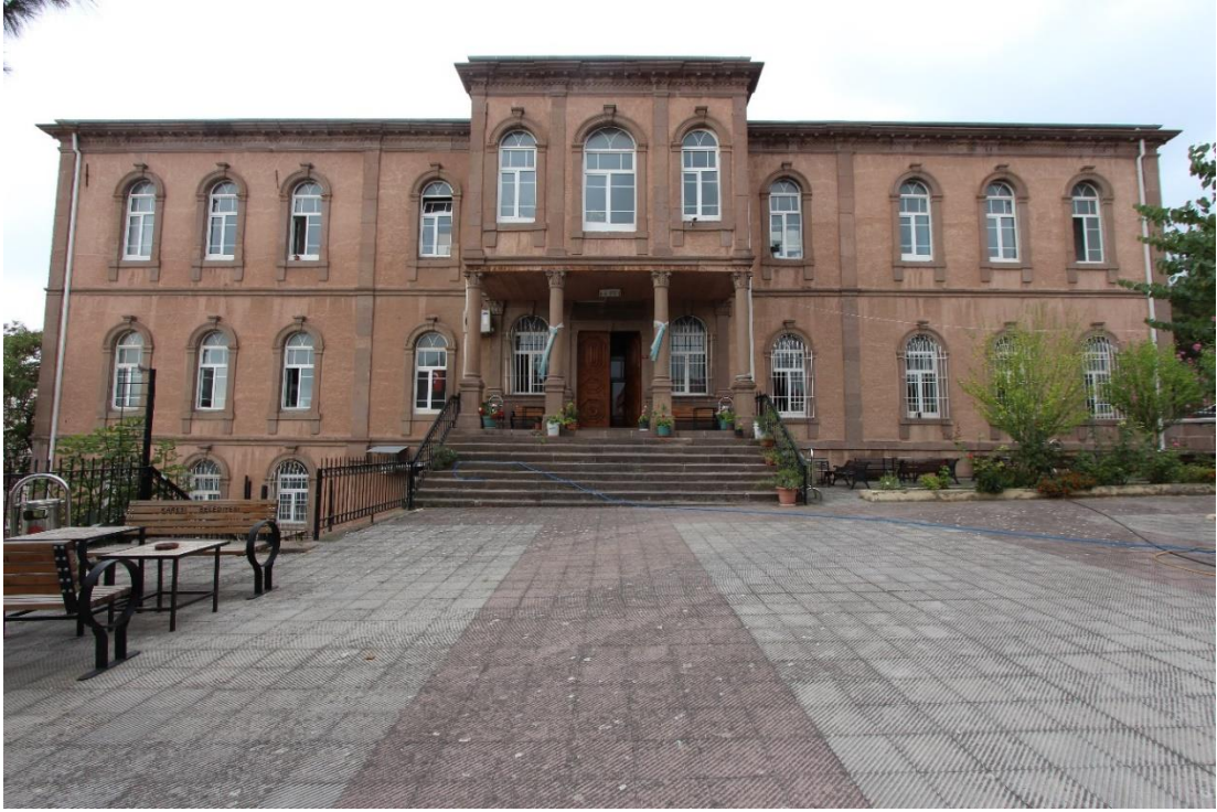
Foto. 412. Balıkesir İdâdîsi Güney Cephe
