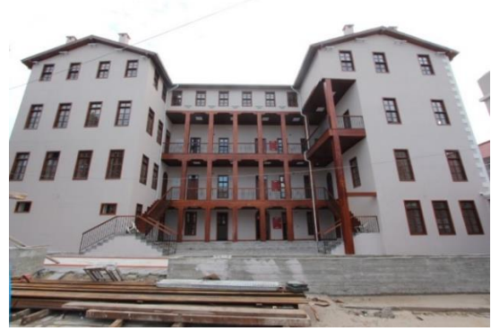
Foto. 845. Adana Amerikan İnas İdâdîsi Batı Cephe
