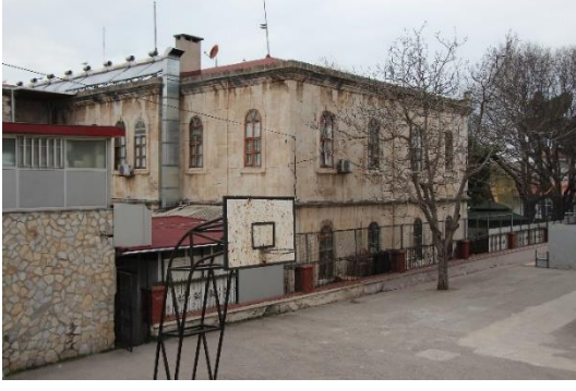
Foto. 454. Sinop İdâdisi Doğu Cephesi
