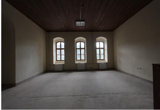
Foto. 49. Bursa İdâdîsi Zemin Kat ZK-03 Nolu Mekân
