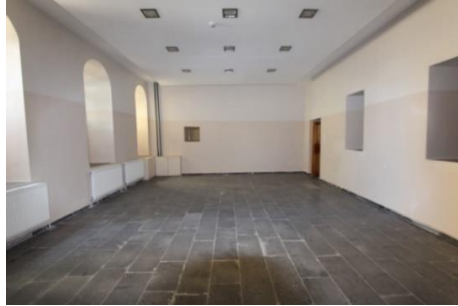
Foto. 123. Diyarbakır İdâdîsi ZK-04 Nolu Mekân
