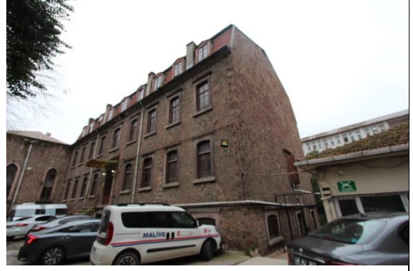
Foto. 956. İzmit St. Barbe Fransız İdâdisi Batı Cephe
