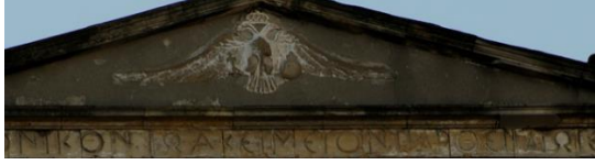
Foto. 812. Fener İoakimion Rum İnas İdâdisi Kuzeydoğu Cephe
