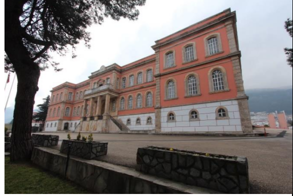
Foto. 179. Bursa Askeri İdâdîsi Güney Cephe
