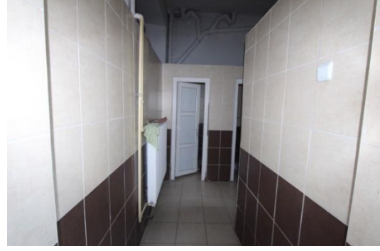
Foto. 215. Erzurum İdâdîsi Zemin Kat WC. (1)
