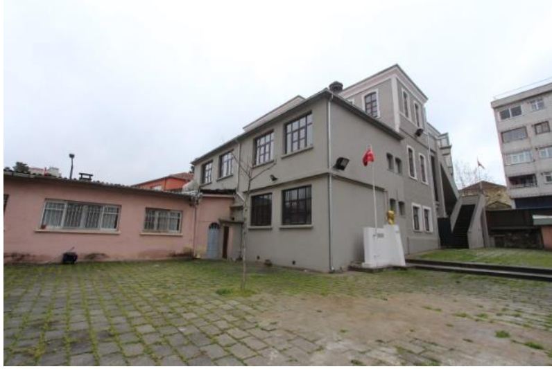
Foto. 891. Kurtuluş (Tatavla) Rum Zükur İdâdîsi Kuzey Cephe
