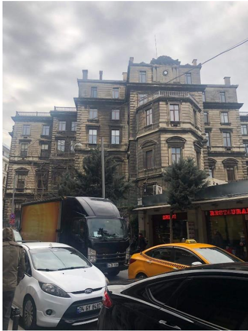
Foto. 866. Zapyon Rum İnas İdâdisi Kuzey Cephe
