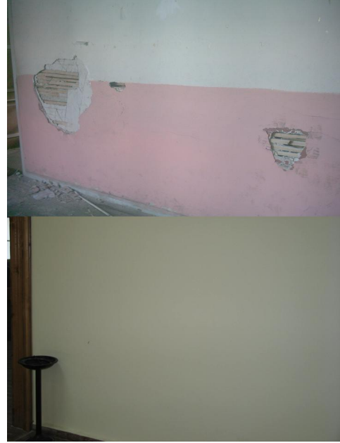
Foto. 536. Bilecik İdâdisi Bağdadi Tekniğinde Yapılan İç Duvar Uygulaması
