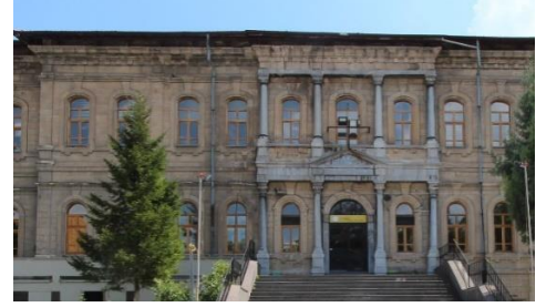
Foto. 110. Kütahya İdadisi Güney Cephe Giriş Aksı
