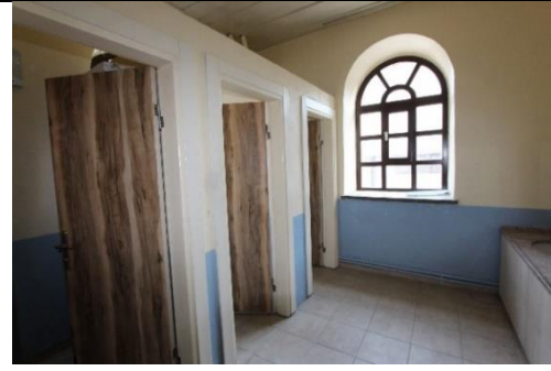
Foto. 601. Muğla İdâdîsi ZK-04 Nolu Tuvaletler (1)
