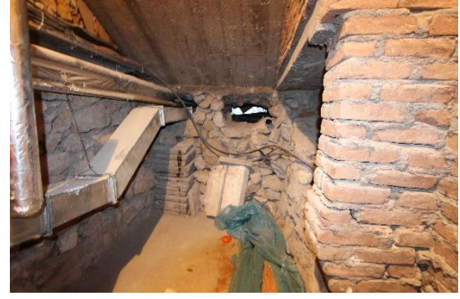
Foto. 312. Sivas İdâdîsi Temel Seviyesinden Bir Görüntü
