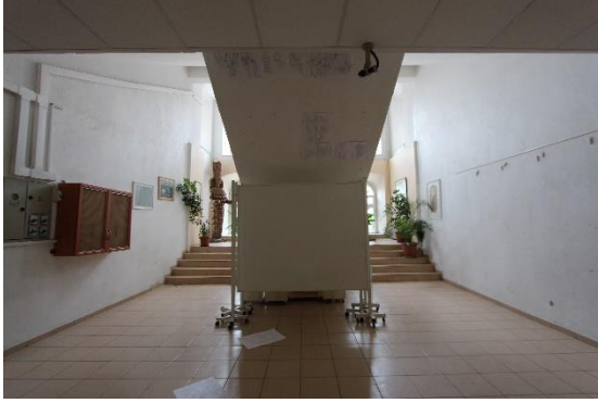
Foto. 374. Balıkesir İdâdîsi Bodrum Kat Giriş ve Merdiven Sahanlığı
