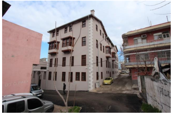
Foto. 848. Adana Amerikan İnas İdâdîsi Güney Cephe
