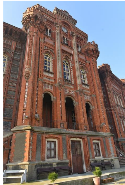
Foto. 855. Fener Rum Zükur İdâdisi Güneybatı Cephe Giriş Aksı
