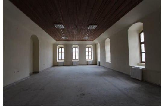
Foto. 50. Bursa İdâdîsi Zemin Kat ZK-04 Nolu Mekân
