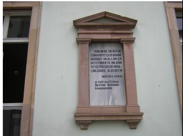
Foto. 1020. Trabzon Rum İdâdisi Güney Cephe Zemin Kat Dekoratif Kartuş (2)
