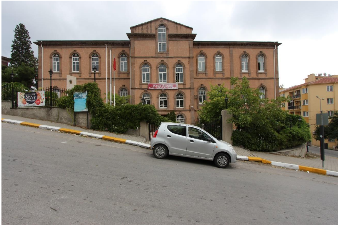
Foto. 414. Balıkesir İdadisi Kuzey Cephe
