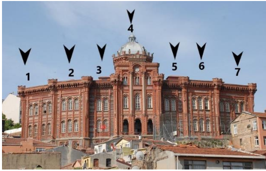
Foto. 854. Fener Rum Zükur İdâdisi Doğu Cephe
