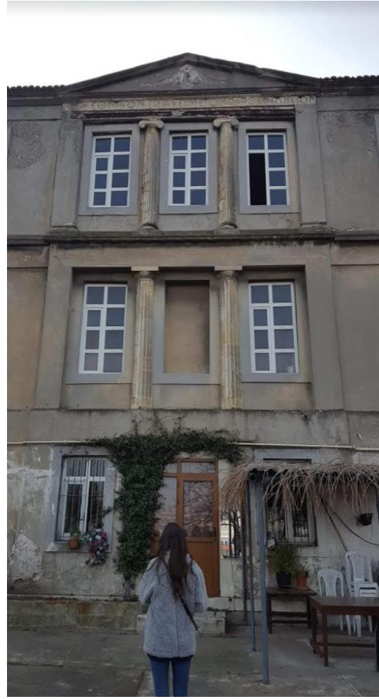
Foto. 813. Fener İoakimion Rum İnas İdâdisi Kuzeydoğu Cephe Orta Aks
