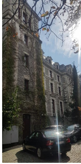
Foto. 1088. Robert Amerikan Koleji Washburn Hall Binası Kuzey Cephe
