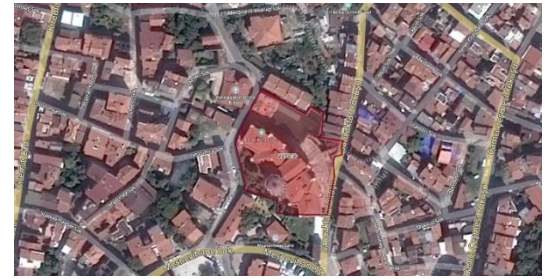
Foto. 853. Fener Rum Zükur İdâdisi Kuşbakışı Görünümü
