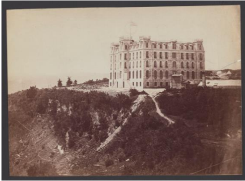
Foto. 1073. Robert Amerikan Koleji Hamlin Hall Binası (Boğaziçi Üniversitesi Arşivi)
