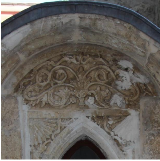
Foto. 311. Sivas İdâdîsi Bahçe Giriş Kapısı Kulüblerinde Bulunan Alımlık Bezemesi
