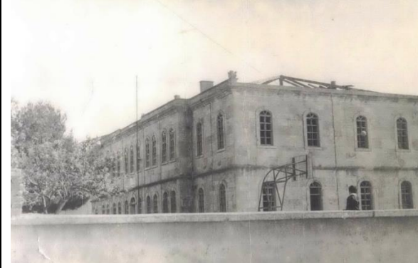
Foto. 440. Sinop İdâdîsi 1976 Yılında Çatı Yenilemesi (Sinop KTVKKM.)
