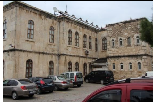
Foto. 453. Sinop İdâdîsi Kuzey Cephe
