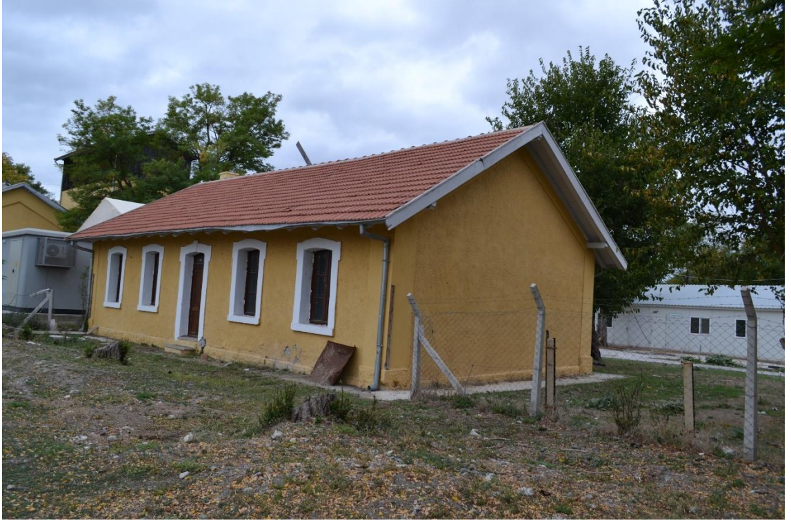
Fotoğraf 17: Alayunt İstasyonu Lojman Binası Doğu Cephesi Görünüşü.
