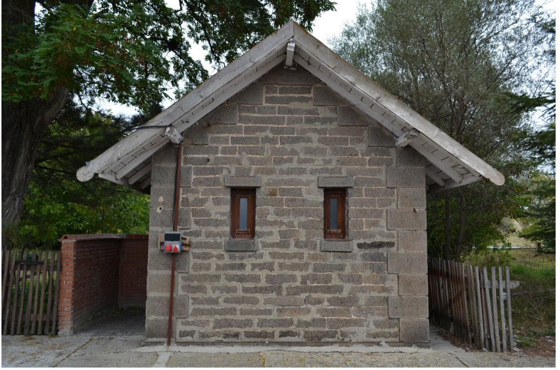
Fotoğraf 59: Dumlupınar İstasyonu Tuvalet Binası Güney Cephesi Görünüşü.
