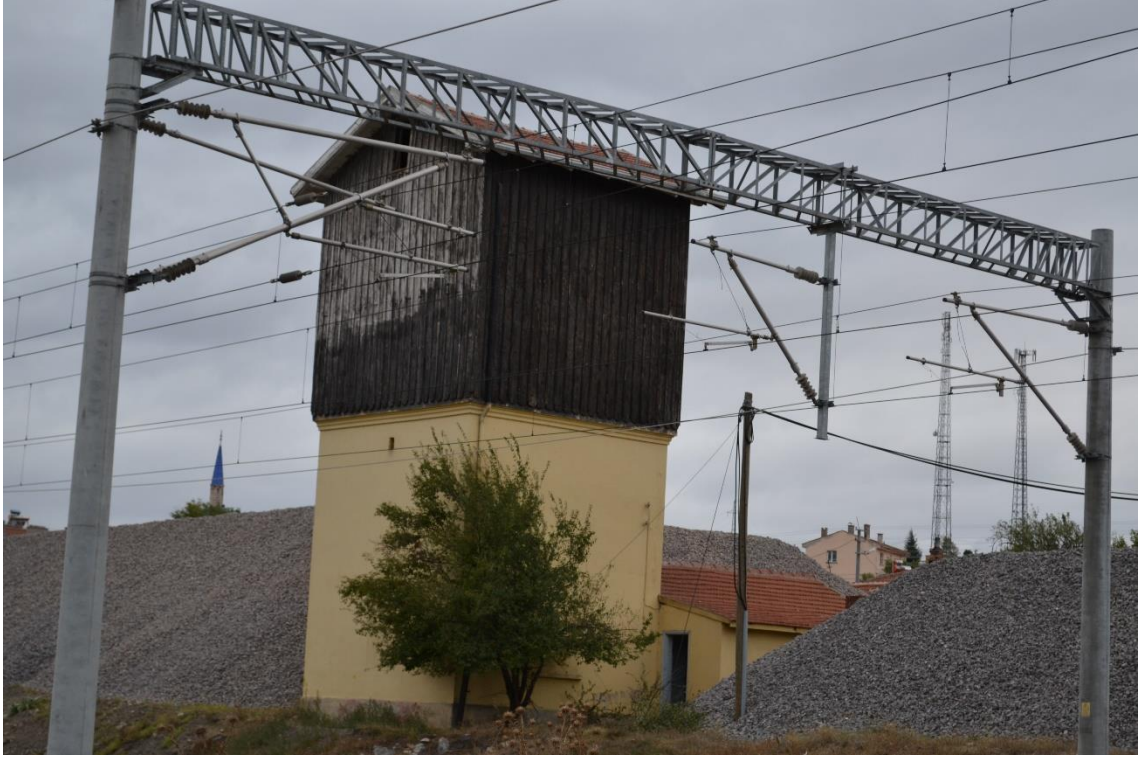
Fotoğraf 39: Sabuncupınar İstasyonu Pompa Binası ve Lojmanı Güneydoğu Yönünden Görünüş.
