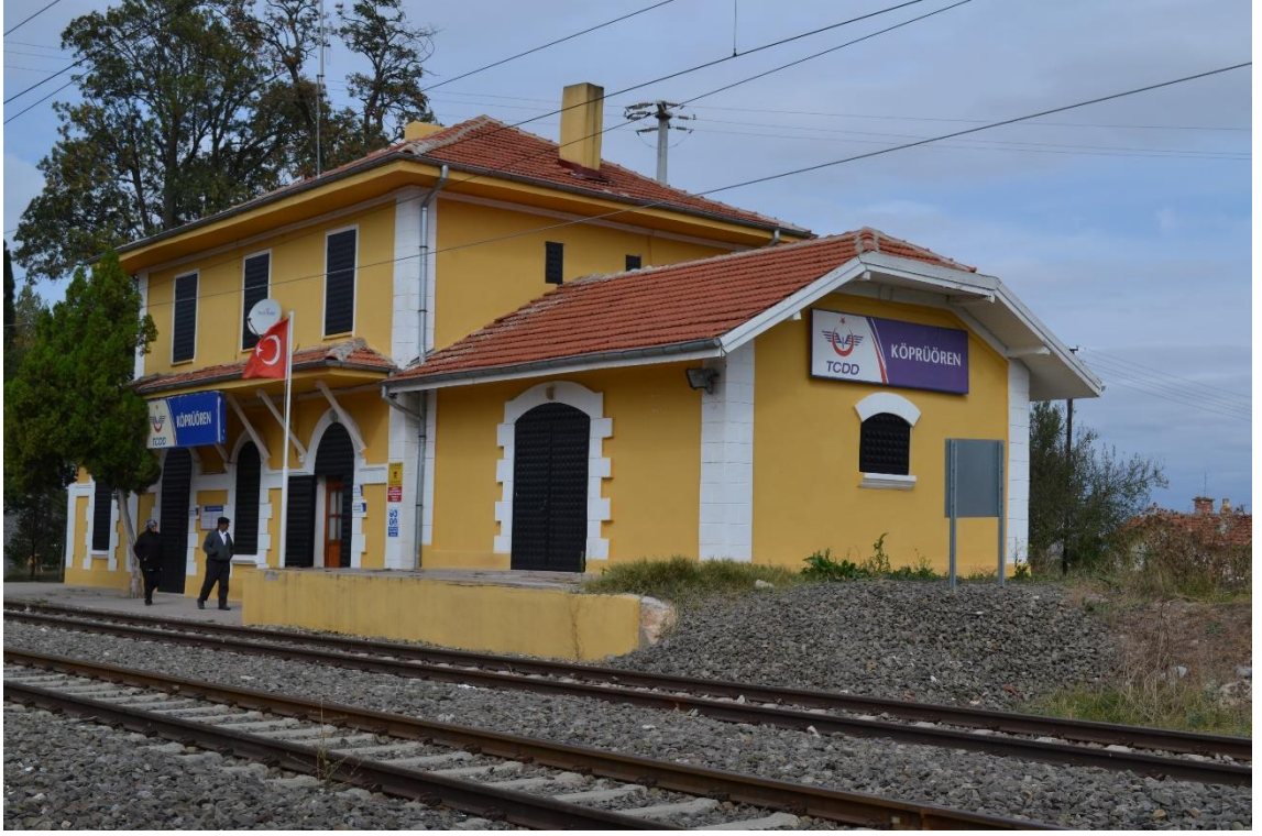
Fotoğraf 87: Köprüören İstasyonu Yolcu Binası Doğu Cephe Görünüşü.
