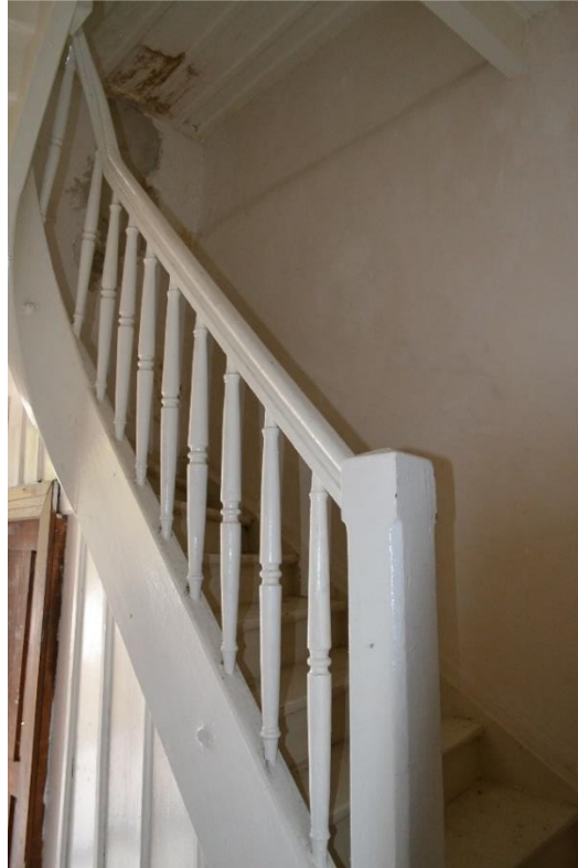
Fotoğraf 4: Alayunt İstasyonu Yolcu Binası Üst Kata Çıkışı Sağlayan Merdivenin Görünüşü.
