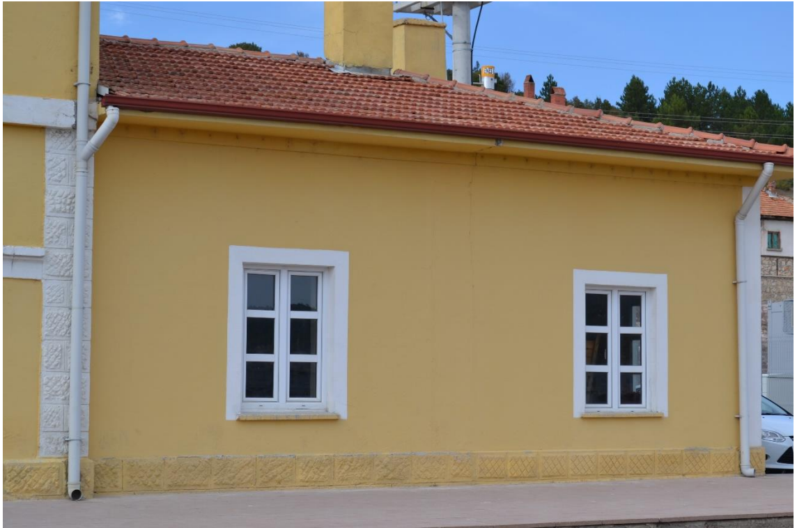
Fotoğraf 74: Emirler İstasyonu Yolcu Binası Güney Cephe Görünüşü (Detay).
