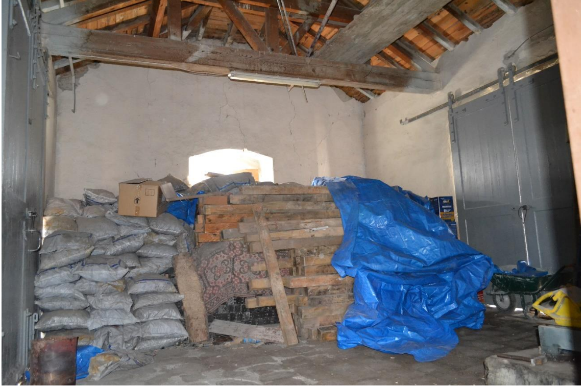
Fotoğraf 61: Emirler İstasyonu Ambar Binası İç Mekan Görünüşü.
