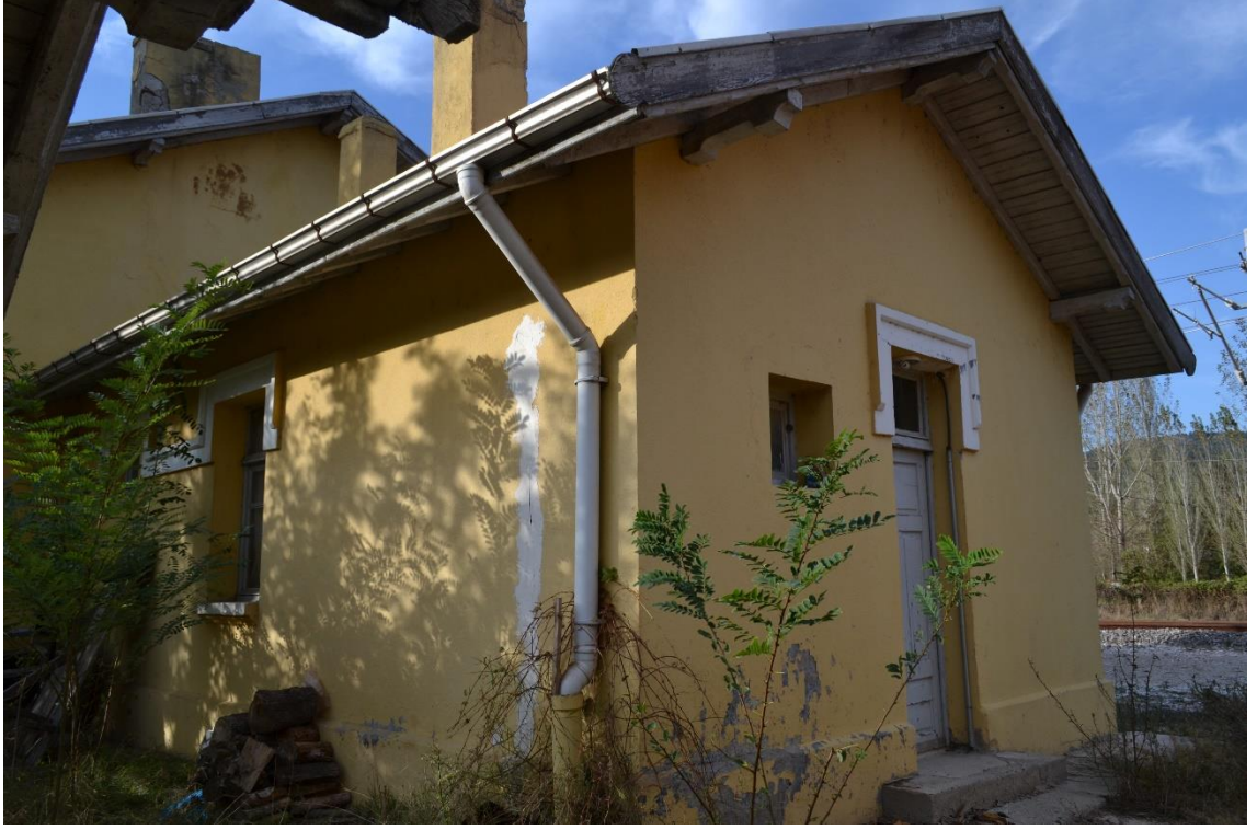
Fotoğraf 143: Balıköy İstasyonu Amele Barakası ve Çavuş Lojmanı Batı Cephesi Görünüşü.
