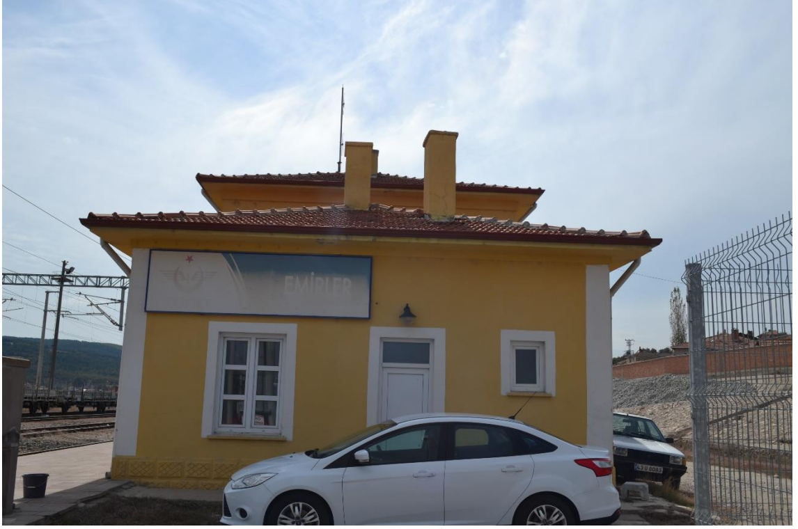
Fotoğraf 77: Emirler İstasyonu Yolcu Binası Doğu Cephe Görünüşü.
