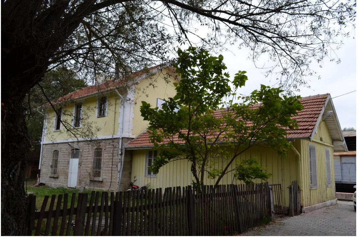
Fotoğraf 55: Dumlupınar İstasyonu Yolcu Binası Kuzey Cephesi Görünüşü.
