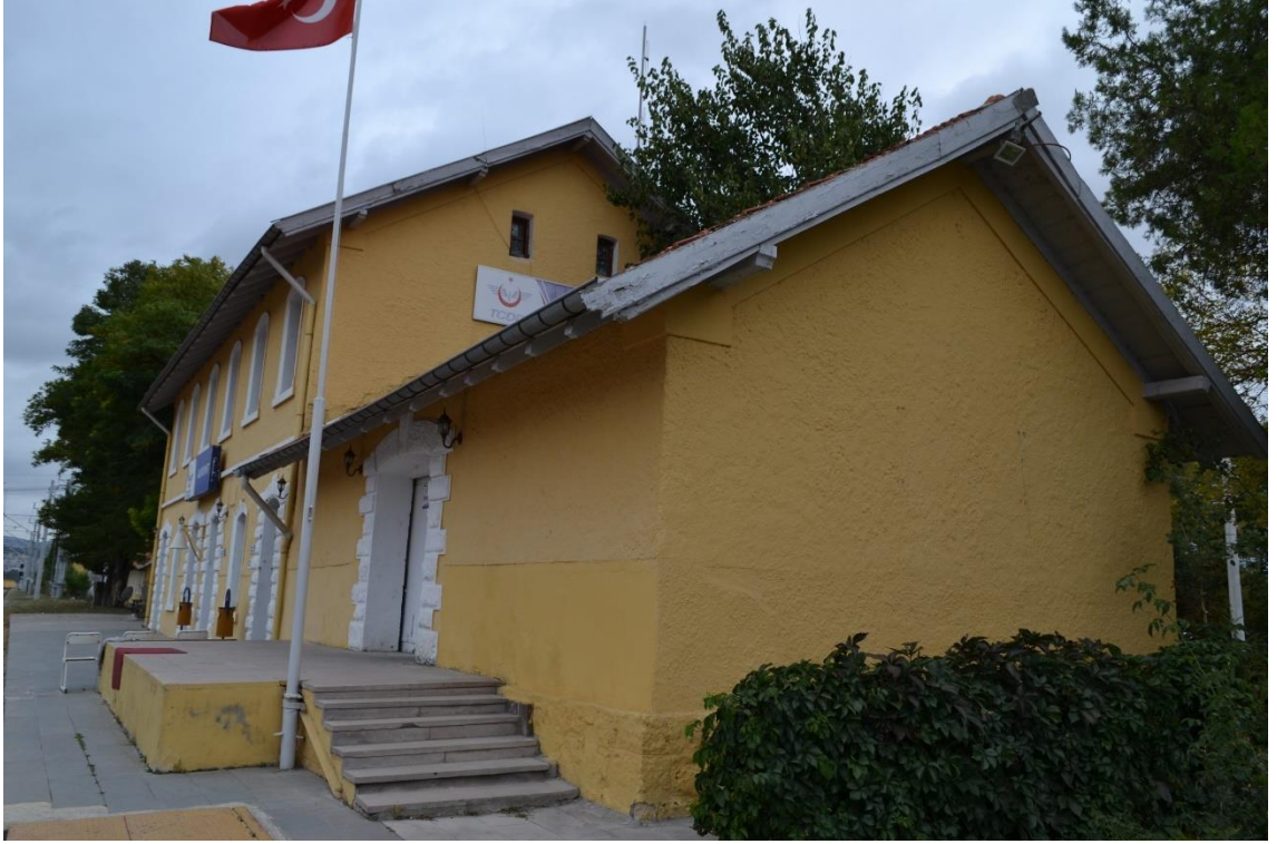
Fotoğraf 13: Alayunt İstasyonu Yolcu Binası Doğu Cephesi Görünüşü.
