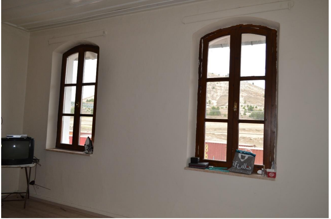
Fotoğraf 7: Alayunt İstasyonu Yolcu Binası Birinci Kat Lojman Odası Pencereleeri.
