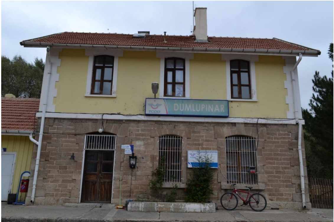
Fotoğraf 52: Dumlupınar İstasyonu Yolcu Binası Güney Cephesi Görünüşü.
