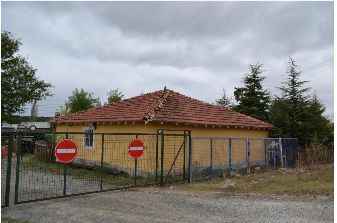
Fotoğraf 40: Sabuncupınar İstasyonu Amele Barakası Kuzeybatı Yönünden Görünüş.
