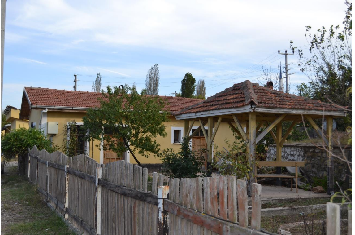
Fotoęraf 138: Balık y İstasyonu Kısım Őeflięi Binası Doęu Cephesi G r n Ő .
