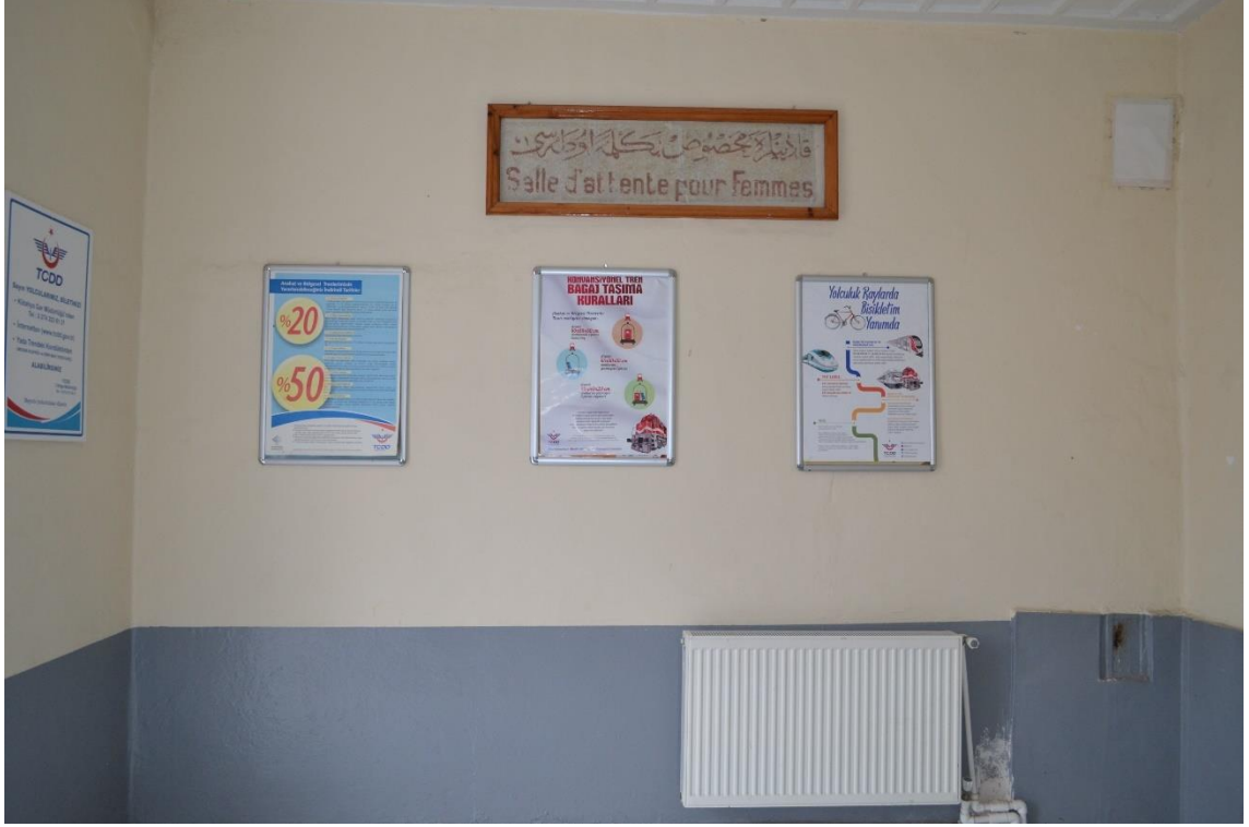
Fotoğraf 29: Sabuncupınar İstasyonu Yolcu Bekleme Salonu Batı Duvarı.
