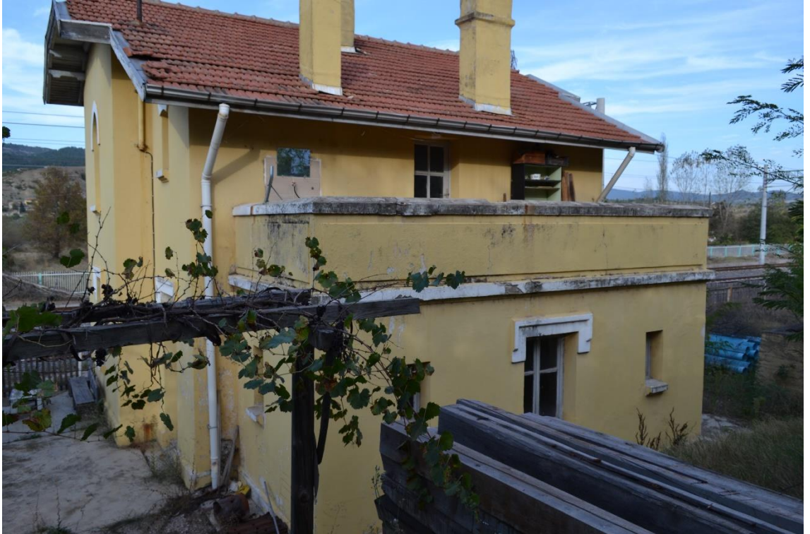
Fotoğraf 134: Balıköy İstasyonu Lojman Binası Kuzey Cephe Görünüşü.
