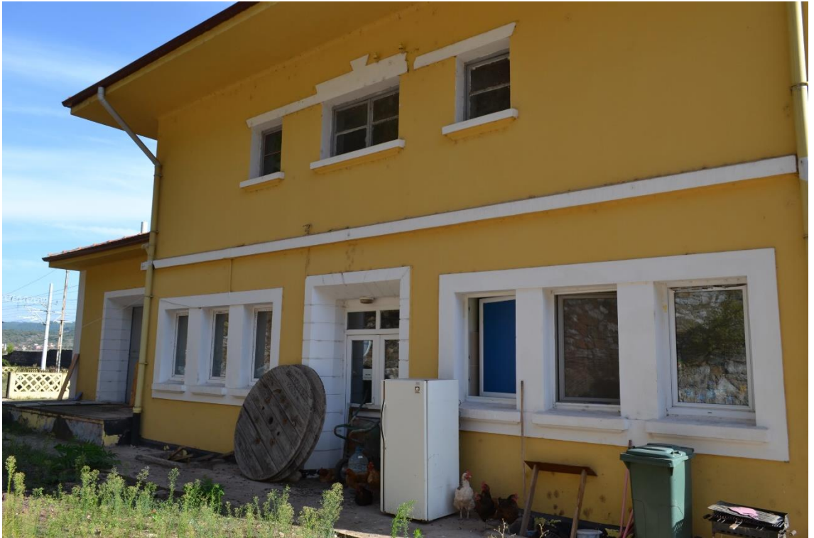
Fotoğraf 122: Değirmisaz İstasyonu Yolcu Binası Kuzey Cephe Görünüşü.
