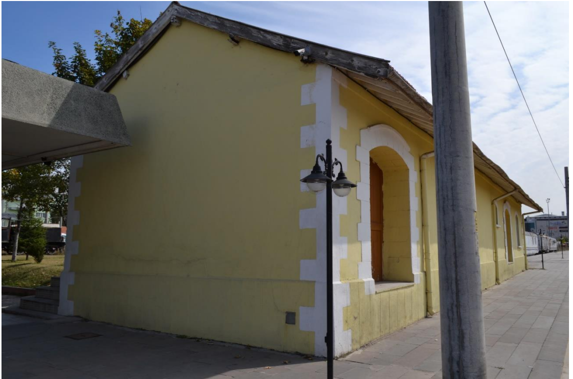
Fotoğraf 102: Tavşanlı İstasyonu Yolcu Binası Batı Cephe Görünüşü.
