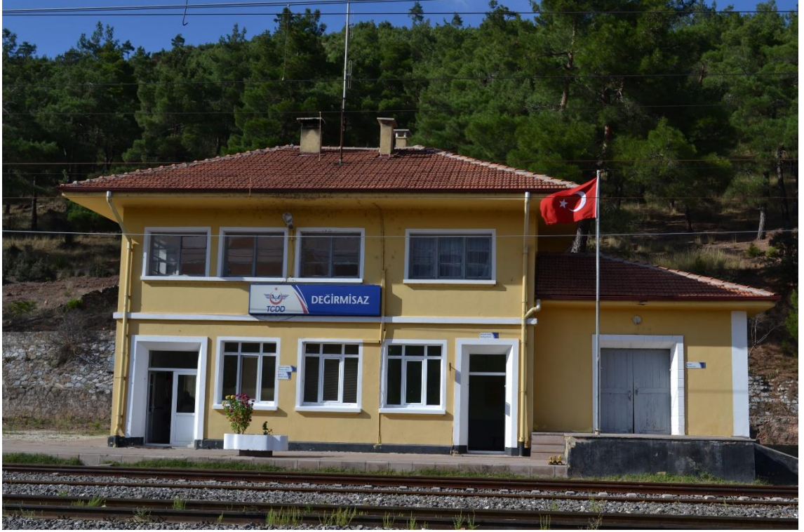
Fotoğraf 121: Değirmisaz İstasyonu Yolcu Binası Güney Cephe Görünüşü.
