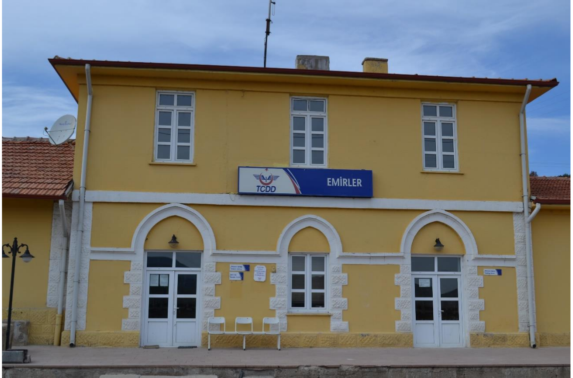
Fotoğraf 72: Emirler İstasyonu Yolcu Binası Güney Cephe Görünüşü (Detay).
