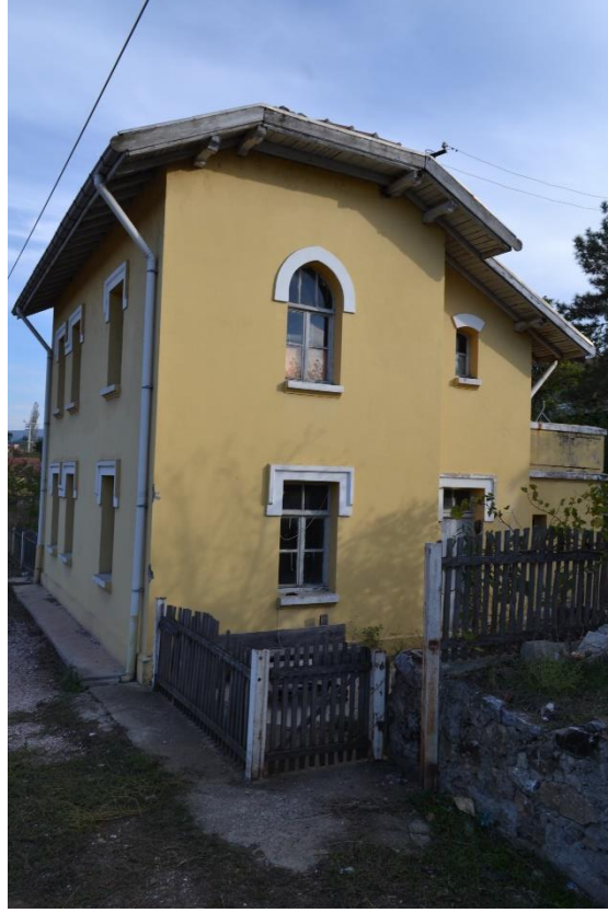
Fotoğraf 135: Balıköy İstasyonu Lojman Binası Doğu Cephesi Görünüşü.
