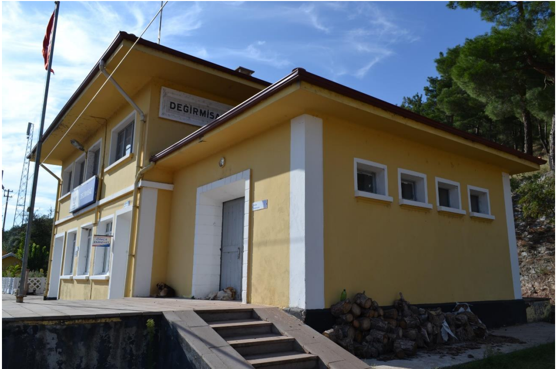
Fotoğraf 124: Değirmisaz İstasyonu Yolcu Binası Doğu Cephesi Görünüşü.
