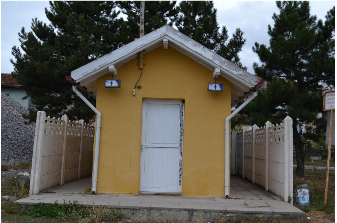
Fotoğraf 42: Sabuncupınar İstasyonu Tuvalet Binası Güney (Peron) Cephesi Görünüşü.
