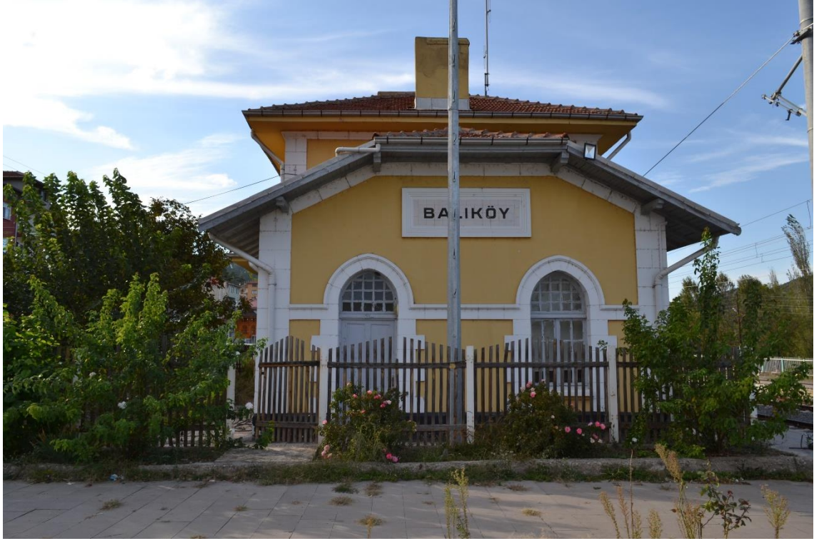
Fotoğraf 131: Balıköy İstasyonu Yolcu Binası Batı Cephesi Görünüşü.
