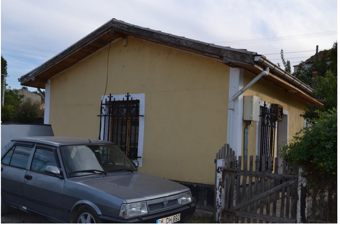
Fotoęraf 137: Balık y İstasyonu Kısım Őeflięi Binası G ney Cephesi G r n Ő .
