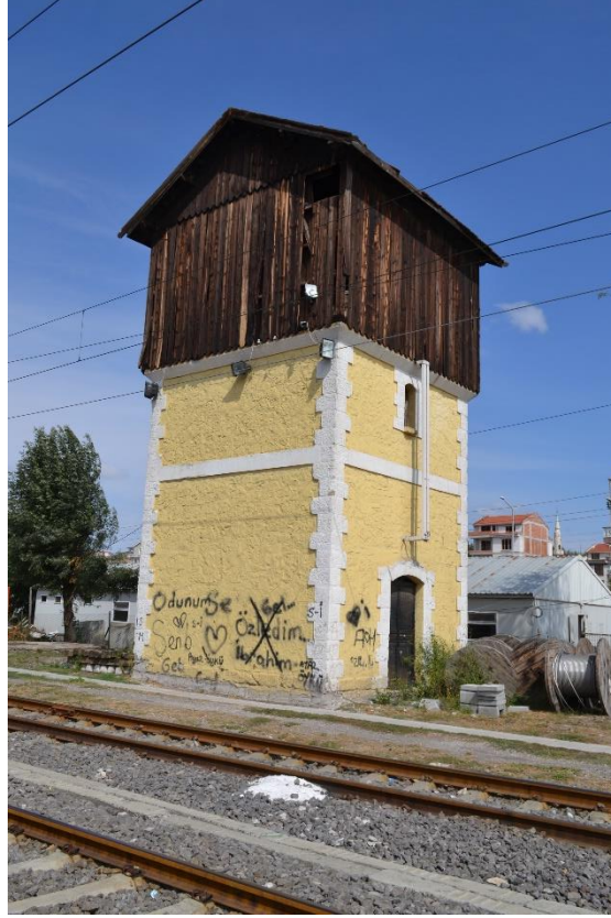
Fotoğraf 103: Tavşanlı İstasyonu Su Deposu Güneydoğu Yönü Görünüşü.
