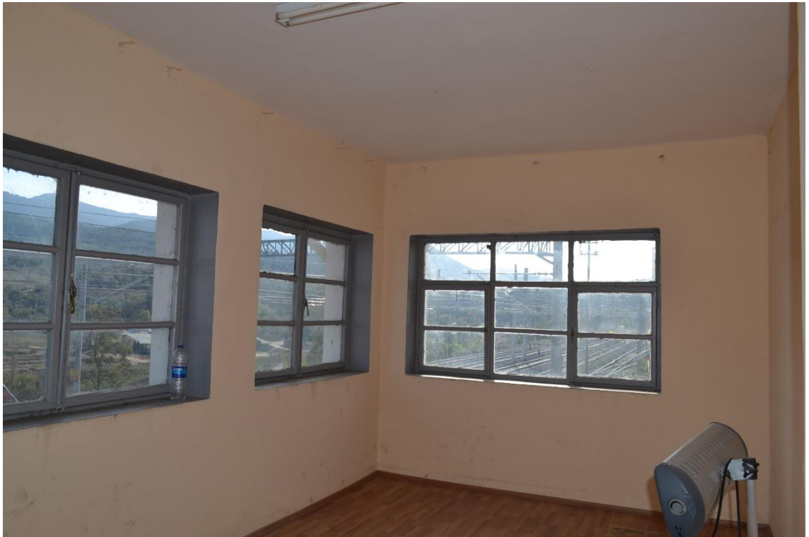
Fotoğraf 120: Değirmisaz İstasyonu Yolcu Binası Birinci Kat Lojman Odası Görünüşü.
