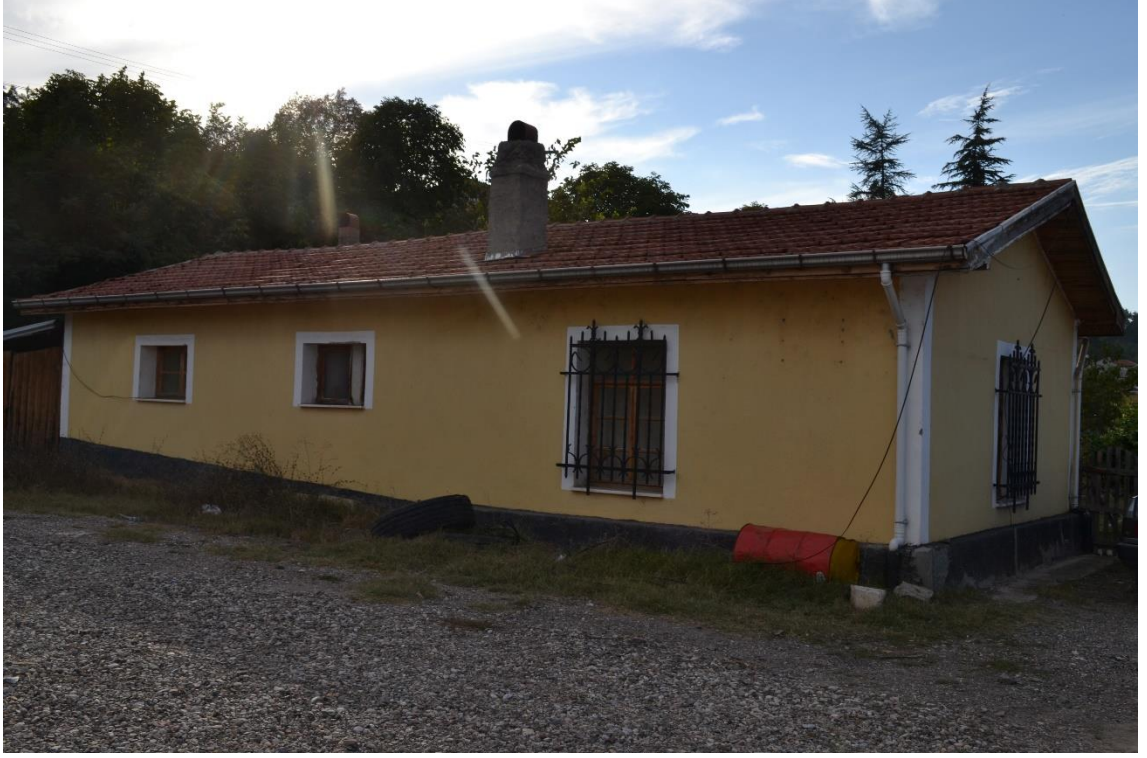
Fotoğraf 139: Balıköy İstasyonu Kısım Şefliği Binası Batı Cephesi Görünüşü.
