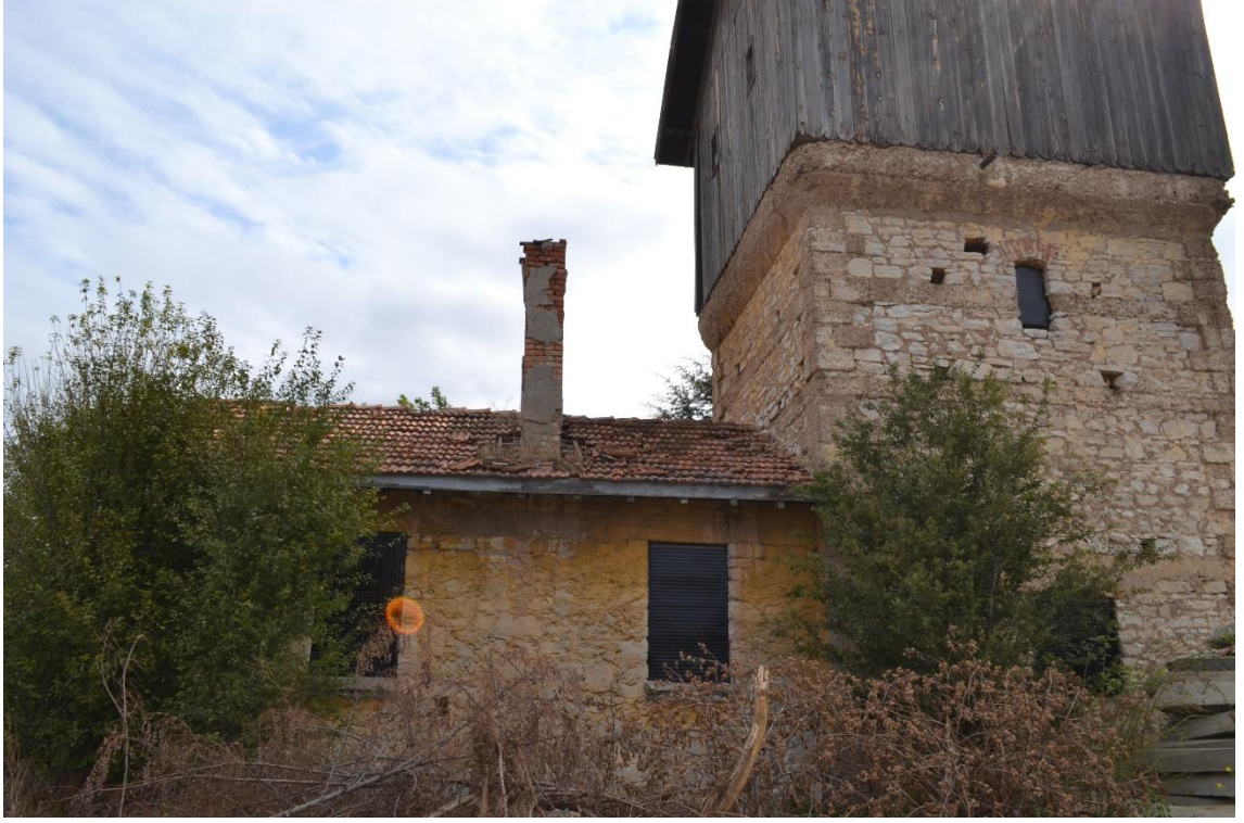
Fotoğraf 89: Köprüören İstasyonu Pompa Binası ve Lojmanı Güney Cephesi Görünüşü.
