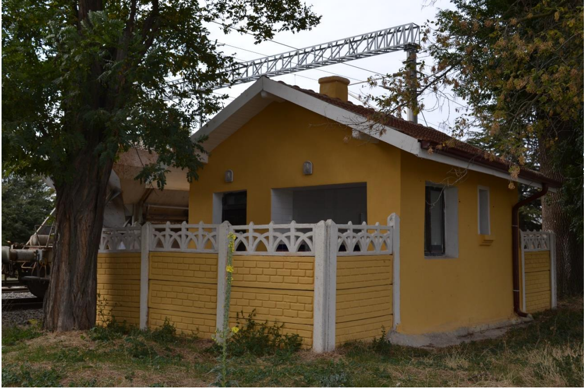
Fotoğraf 93: Köprüören İstasyonu Tuvalet Binası Kuzeydoğu Yönünden Görünüşü.
