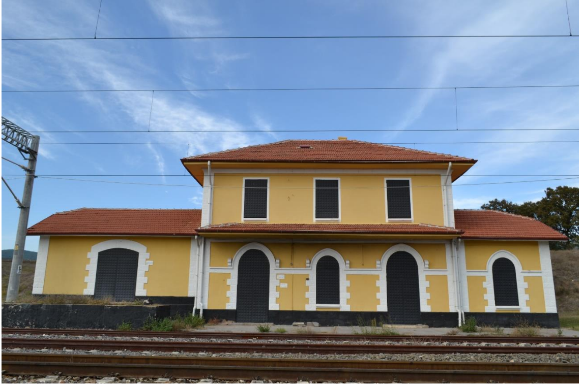
Fotoğraf 105: Demirli İstasyonu Yolcu Binası Güney Cephe Görünüşü.
