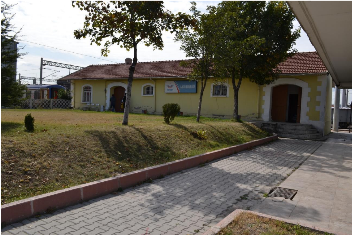
Fotoğraf 100: Tavşanlı İstasyonu Yolcu Binası Kuzey Cephe Görünüşü.
