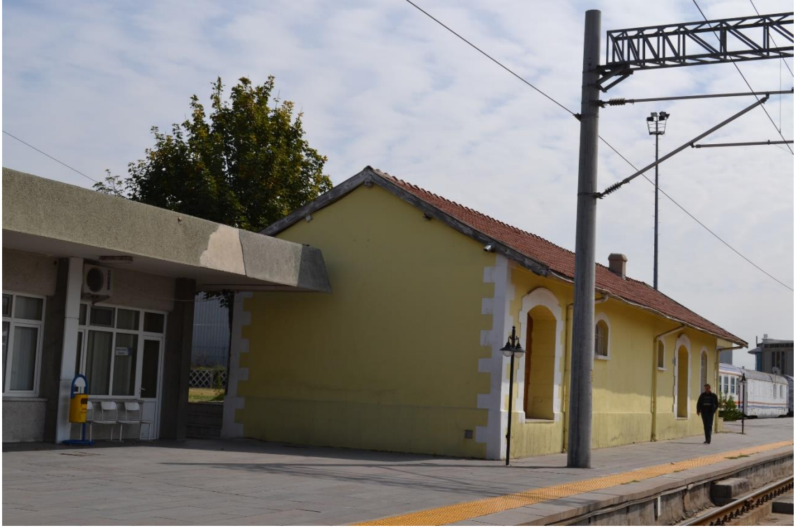
Fotoğraf 99: Tavşanlı İstasyonu Yolcu Binası Güney Cephe Görünüşü.
