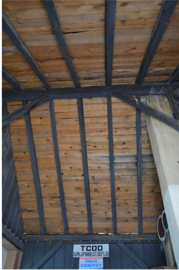
FotoĐraf 50: Dumluþınar İstasyonu Ambar Binası atı Kiriþleri.
