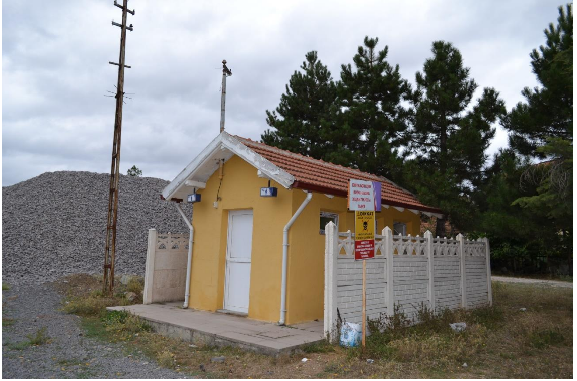
Fotoğraf 43: Sabuncupınar İstasyonu Tuvalet Binası Güneydoğu Cephesinden Görünüşü.
