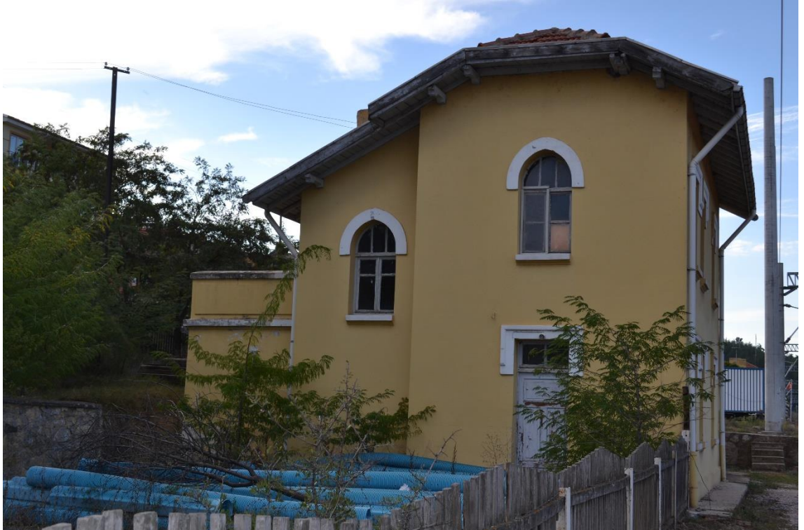
Fotoğraf 136: Balıköy İstasyonu Lojman Binası Batı Cephesi Görünüşü.
