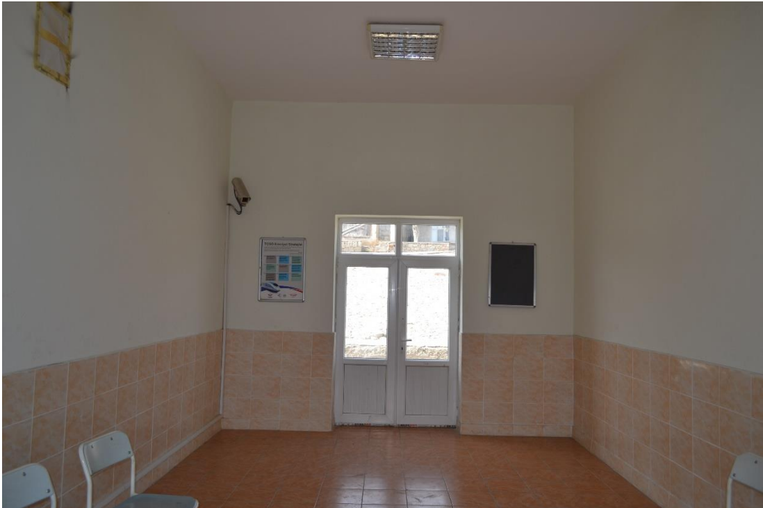
Fotoğraf 66: Emirler İstasyonu Yolcu Bekleme Salonu Kuzey Duvarı Görünüşü.
