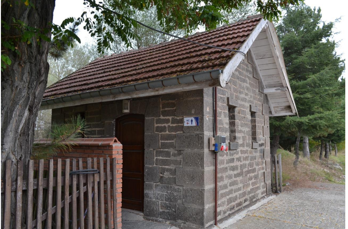
Fotoğraf 60: Dumlupınar İstasyonu Tuvalet Binası Güneybatı Yöntünden Görünüşü.
