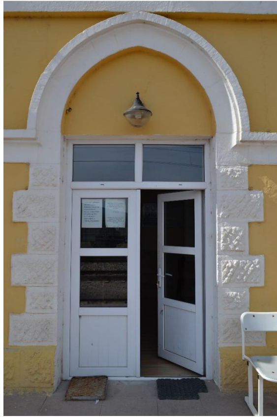
Fotoğraf 76: Emirler İstasyonu Yolcu Binası Kapı Örneği.
