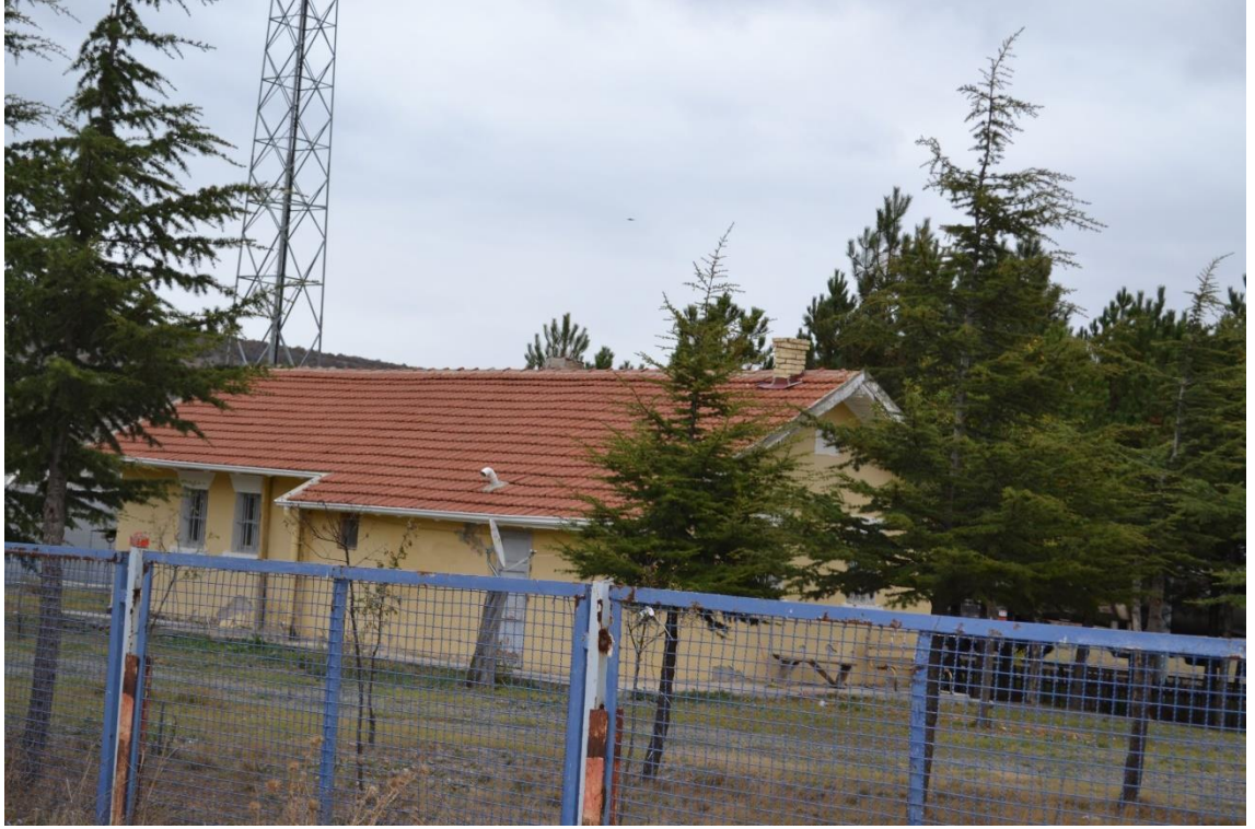
Fotoğraf 41: Sabuncupınar İstasyonu Amele Barakası Güneydoğu Yönünden Görünüşü.
