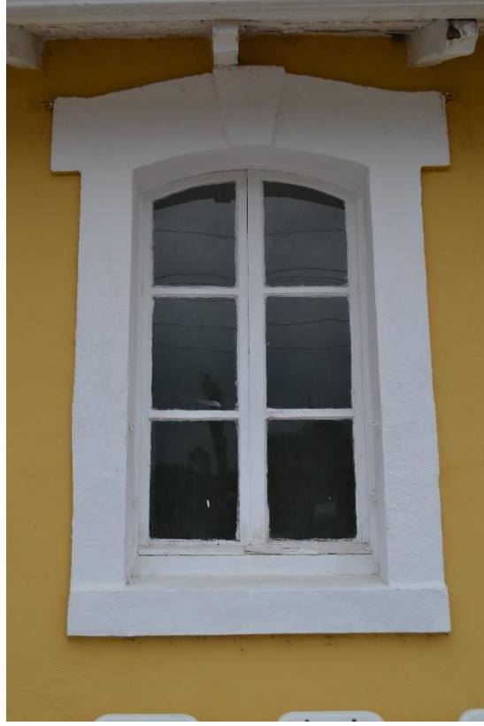
Fotoğraf 31: Sabuncupınar İstasyonu Yolcu Binası Pencere Örneği.
