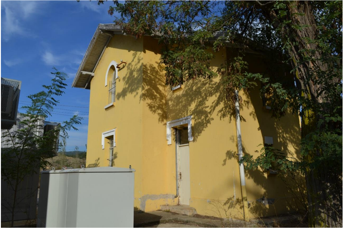
Fotoğraf 142: Balıkköy İstasyonu Amele Barakası ve Çavuş Lojmanı Doğu Cephesi Görünüşü.
