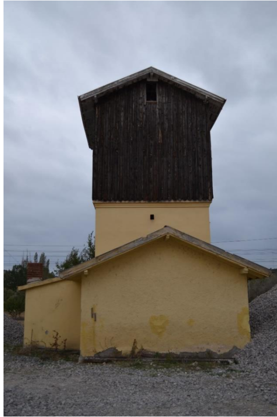
Fotoğraf 38: Sabuncupınar İstasyonu Pompa Binası ve Lojmanı Kuzey Cephe Görünüşü.
