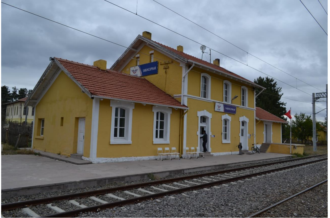
Fotoğraf 32: Sabuncupınar İstasyonu Yolcu Binası Güney Cephesi Görünüşü.
