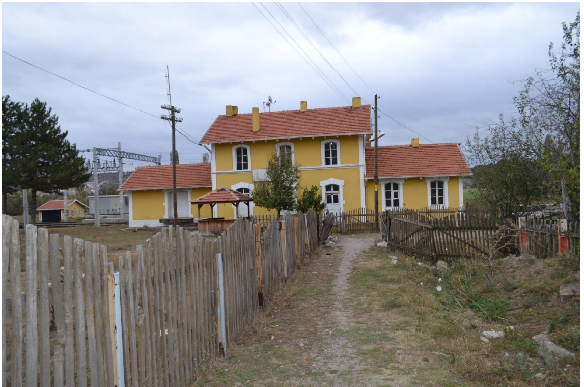
Fotoğraf 34: Sabuncupınar İstasyonu Yolcu Binası Kuzey Cephesi Görünüşü.
