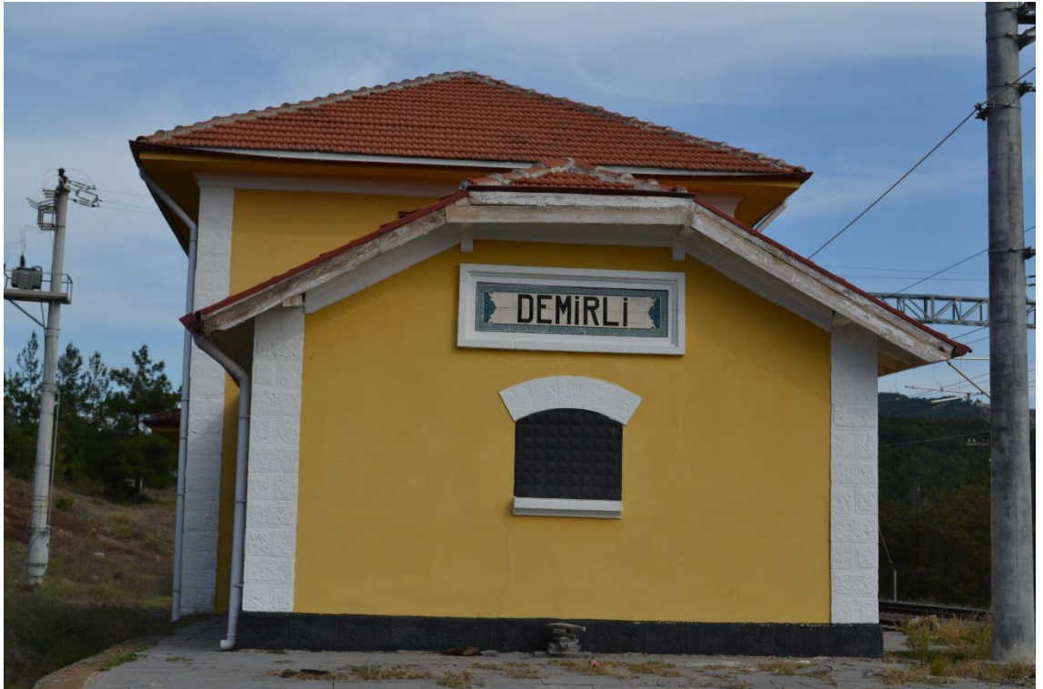
Fotoğraf 110: Demirli İstasyonu Yolcu Binası Batı Cephesi Görünüşü.
