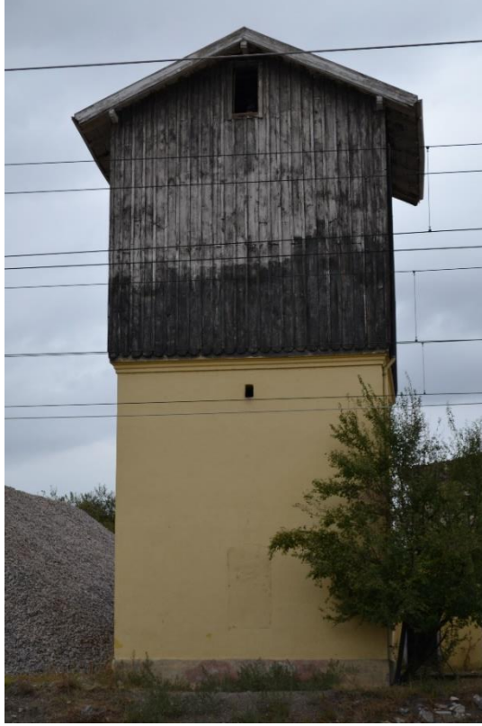
Fotoğraf 37: Sabuncupınar İstasyonu Pompa Binası ve Lojmanı Güney Cephesi.
