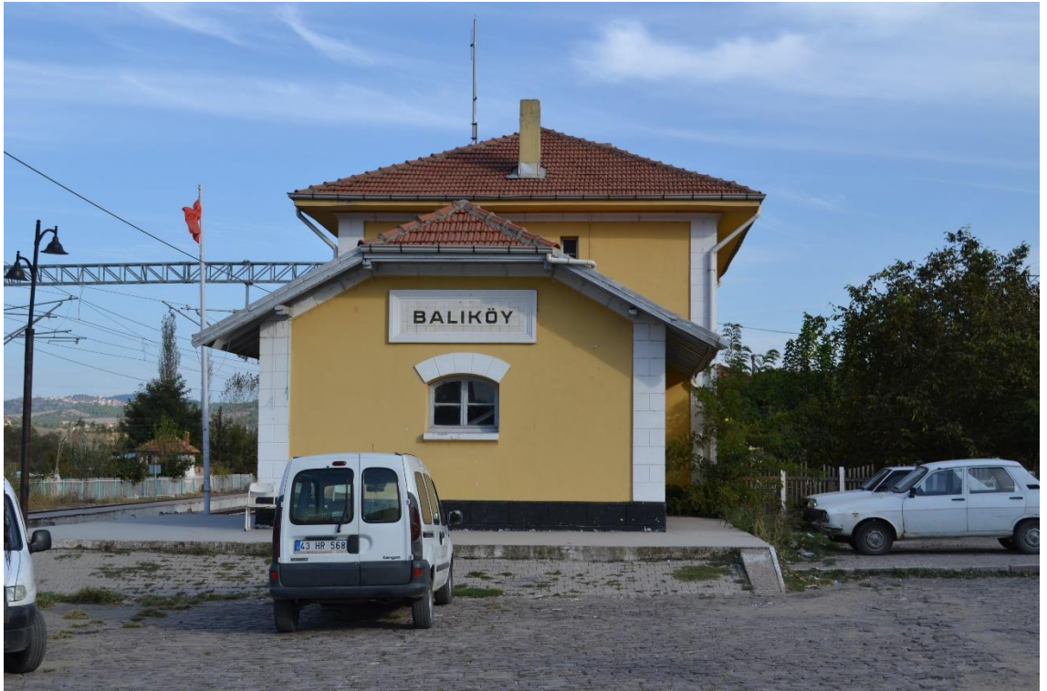
Fotoğraf 132: Balıköy İstasyonu Yolcu Binası Doğu Cephesi Görünüşü.
