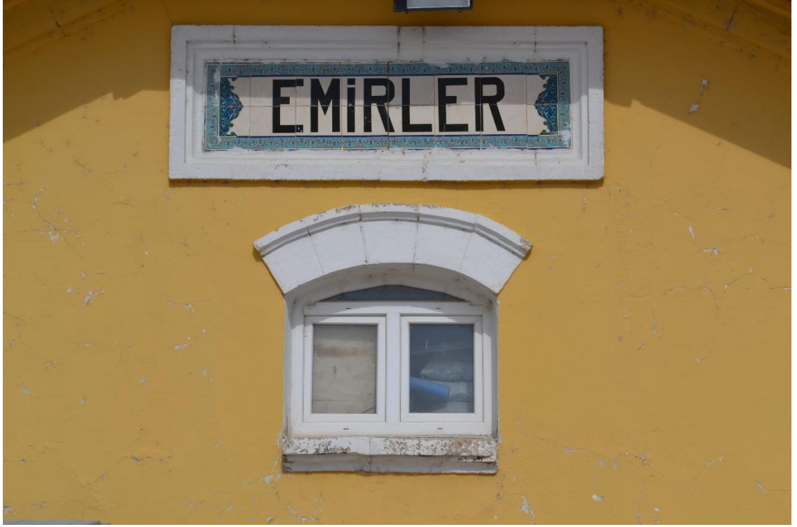
Fotoğraf 79: Emirler İstasyonu Yolcu Binası Batı Cephesindeki Pencere ve Pano.
