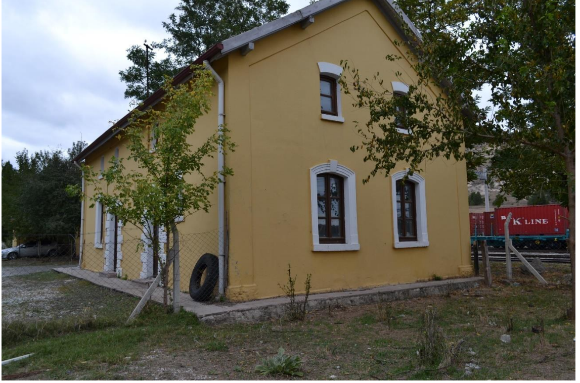
Fotoğraf 21: Alayunt İstasyonu Üçlü Lojman Binası Batı Cephesi Görünüşü.
