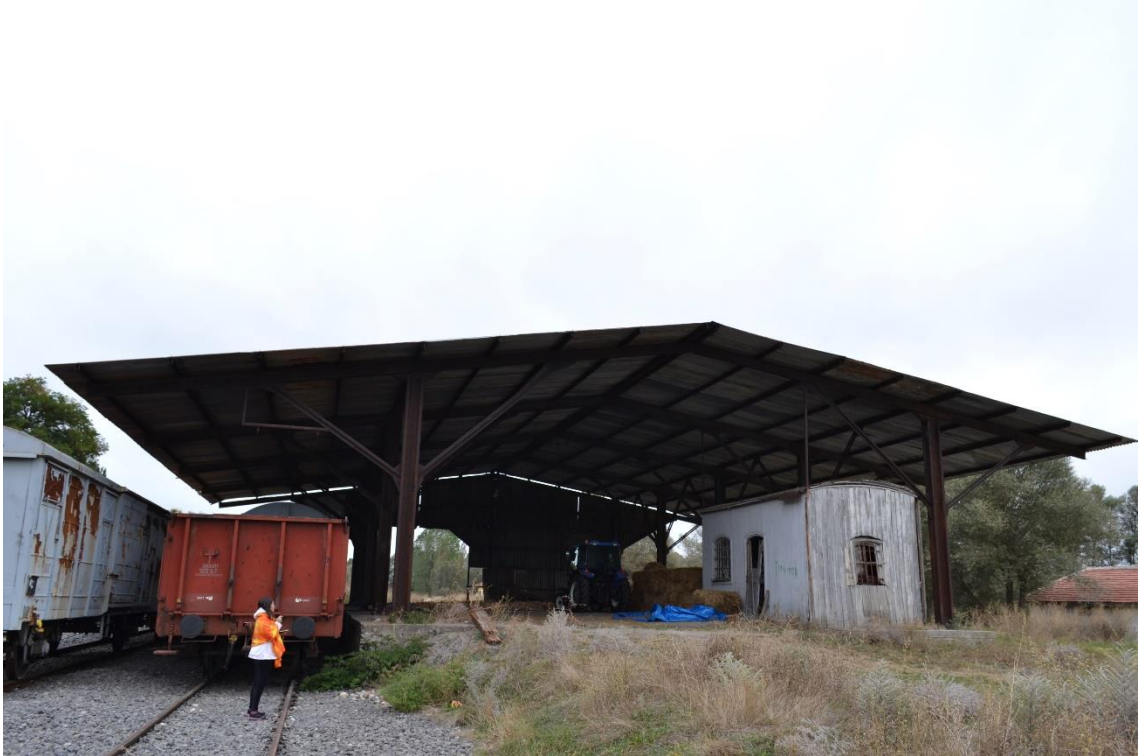
Fotoğraf 58: Dumluþınar İstasyonu Açık Hangar Binası Görünüþü.
