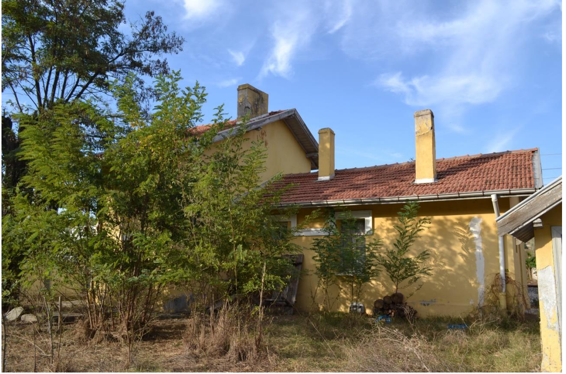
Fotoğraf 141: Balıkköy İstasyonu Amele Barakası ve Çavuş Lojmanı Kuzey Cephe Görünüşü.
