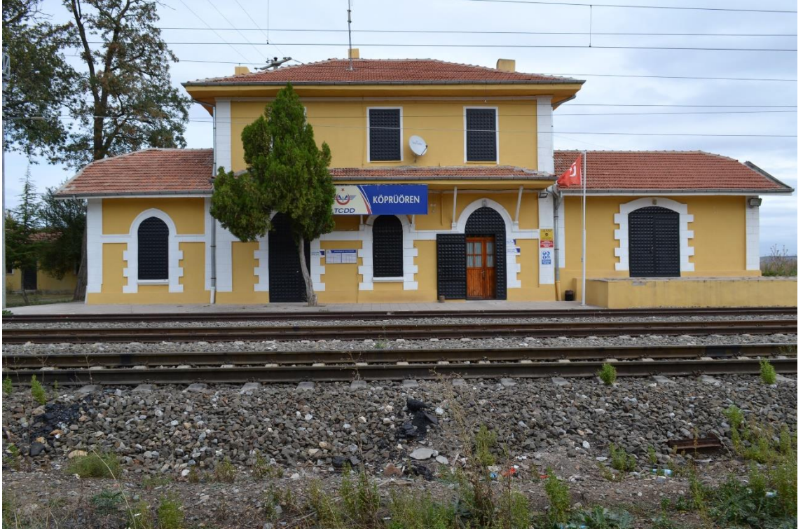
Fotoğraf 83: Köprüören İstasyonu Yolcu Binası Güney Cephe Görünüşü.
