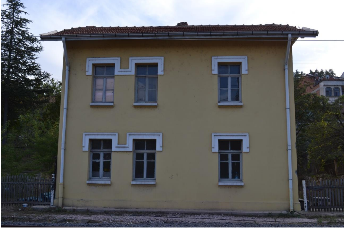
Fotoğraf 133: Balıköy İstasyonu Lojman Binası Güney Cephe Görünüşü.
