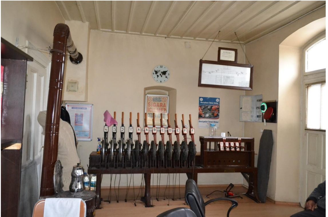
Fotoğraf 26: Sabuncupınar İstasyonu Yolcu Binası Zemin Kat Ofis İçi Görünüş.
