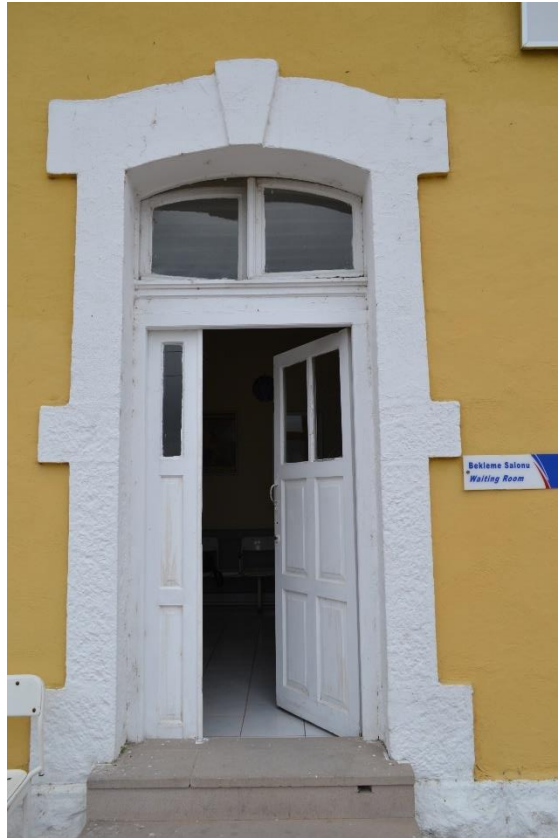
Fotoğraf 30: Sabuncupınar İstasyonu Yolcu Binası Kapı Örneği.
