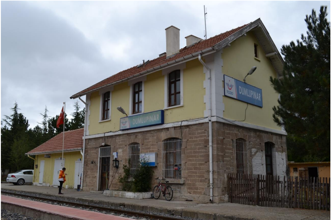
Fotoğraf 56: Dumlupınar İstasyonu Yolcu Binası Güneydoğu Cephesi Görünüşü.
