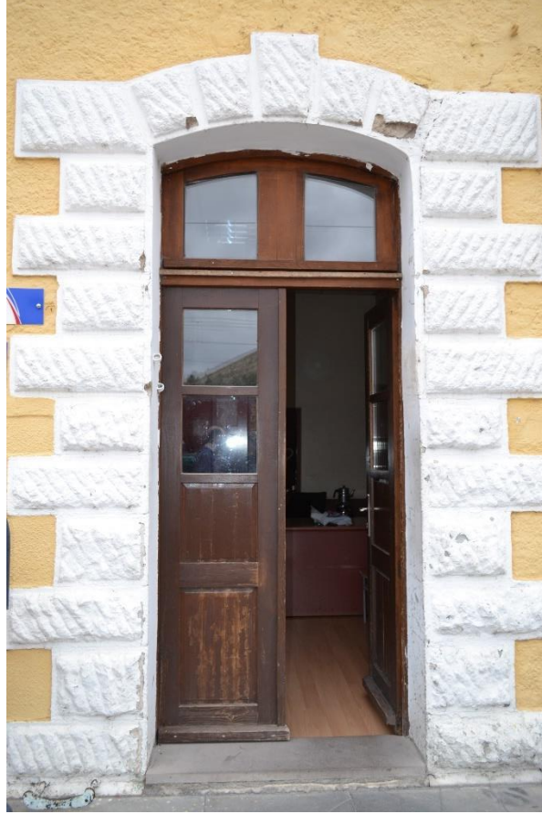
Fotoğraf 11: Alayunt İstasyonu Yolcu Binası Güney Cephesi Kapısının Görünüşü.
