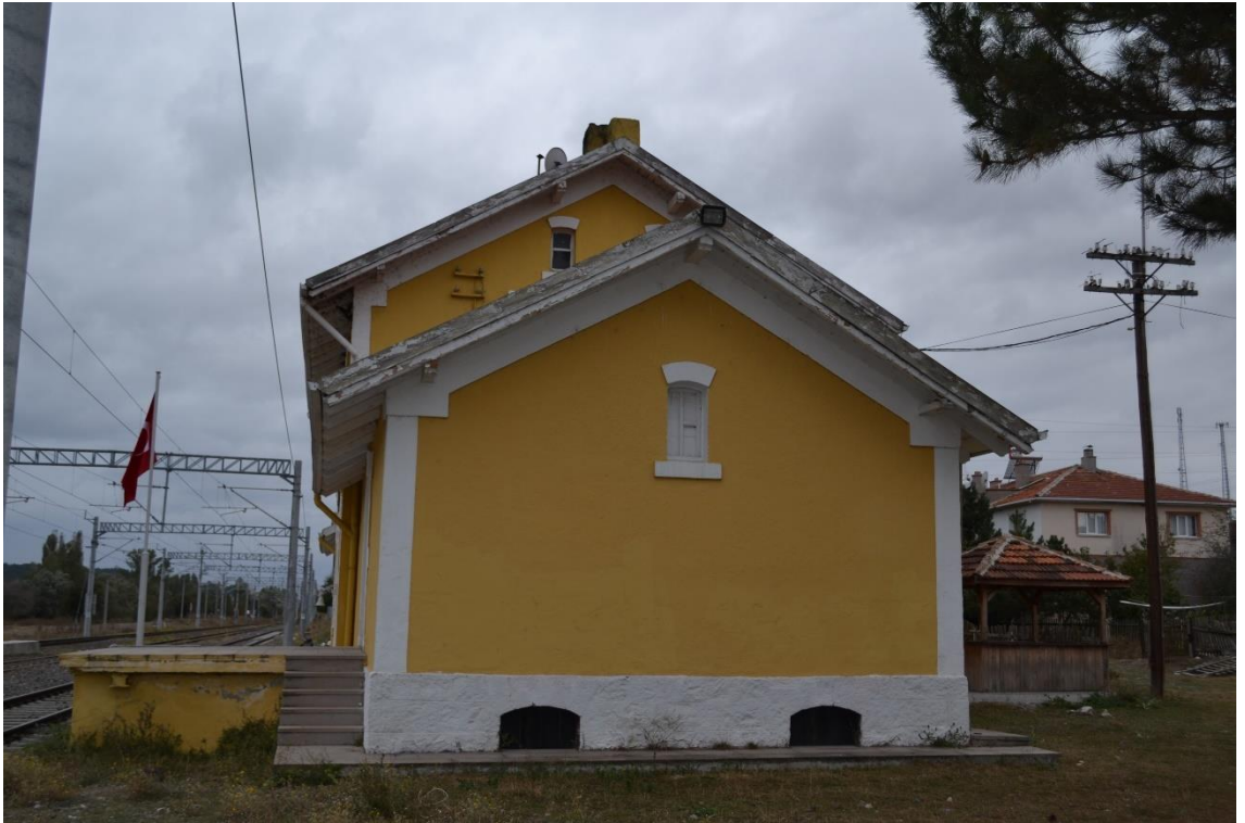
Fotoğraf 36: Sabuncupınar İstasyonu Yolcu Binası Doğu Cephesi Görünüşü.
