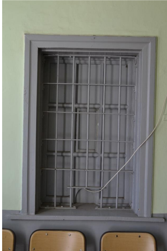
Fotoğraf 118: Değirmisaz İstasyonu Yolcu Binası Gişe Penceresi.
