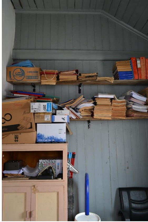
Fotoğraf 51: Dumlupınar İstasyonu Depo Bölümü İç Mekan Görünüşü.
