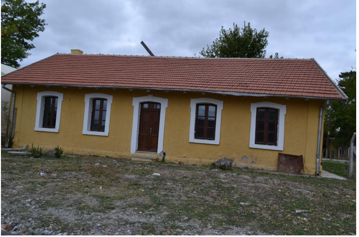
Fotoğraf 15: Alayunt İstasyonu Lojman Binası Güney Cephesi Görünüşü.
