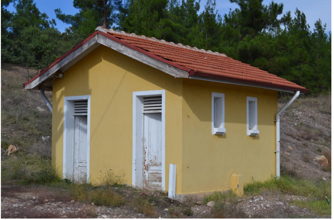
Fotoğraf 111: Demirli İstasyonu Tuvalet Binası Güneybatı Yönünden Görünüşü.
