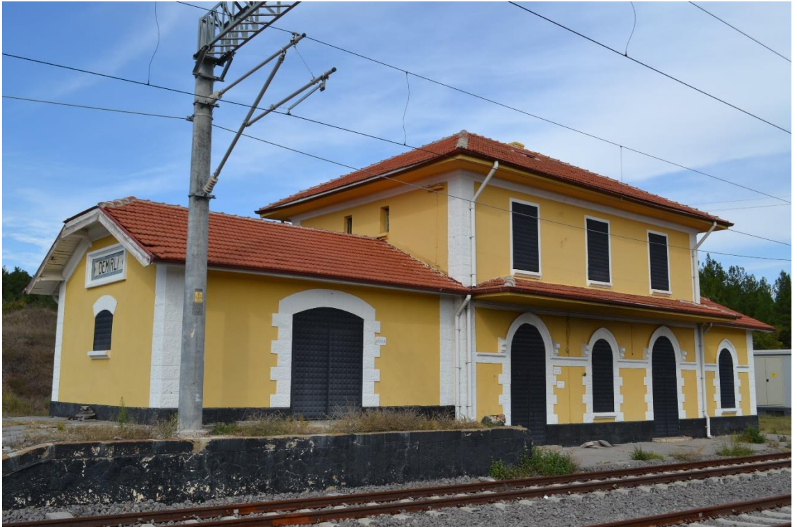
Fotoğraf 106: Demirli İstasyonu Yolcu Binası Güneybatı Yönünden Görünüşü.
