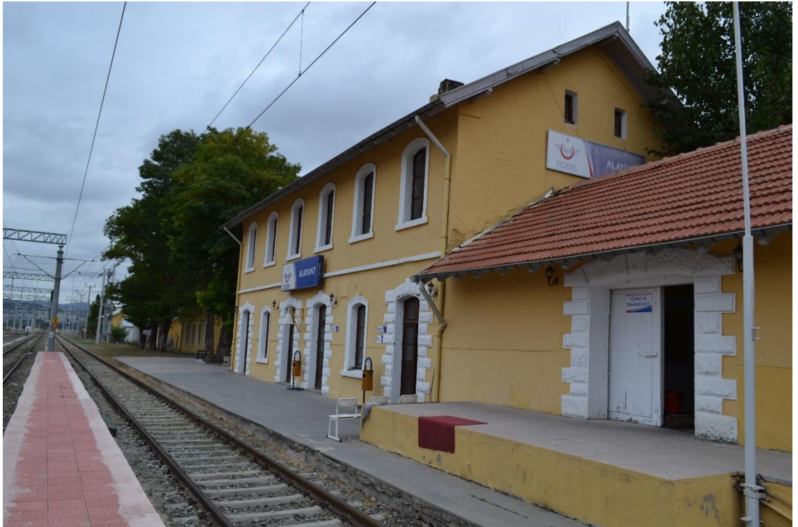
Fotoğraf 10: Alayunt İstasyonu Yolcu Binası Güney Cephesi Görünüşü.
