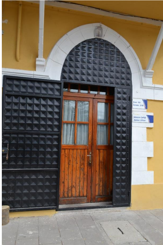
Fotoğraf 84: Köprüören İstasyonu Yolcu Binası Saçak Altı Destekleri ve Silme Kuşağının Birleştiği Yerler (Kapı Örneği).
