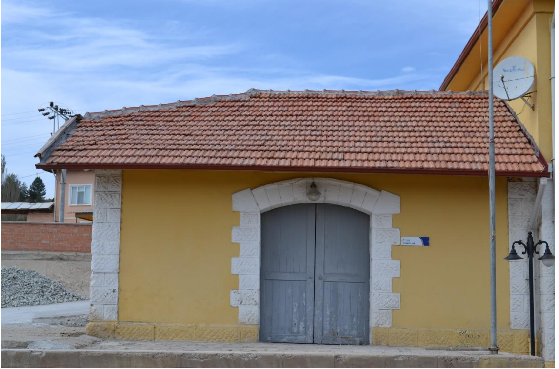
Fotoğraf 63: Emirlers İstasyonu Ambar Binası Güney Cephe Görünüşü.
