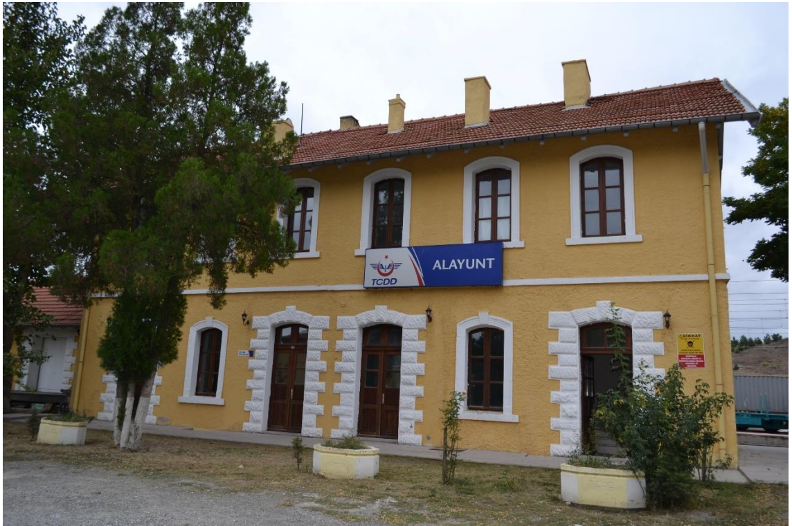
Fotoğraf 12: Alayunt İstasyonu Yolcu Binası Kuzey Cephesi Görünüşü.
