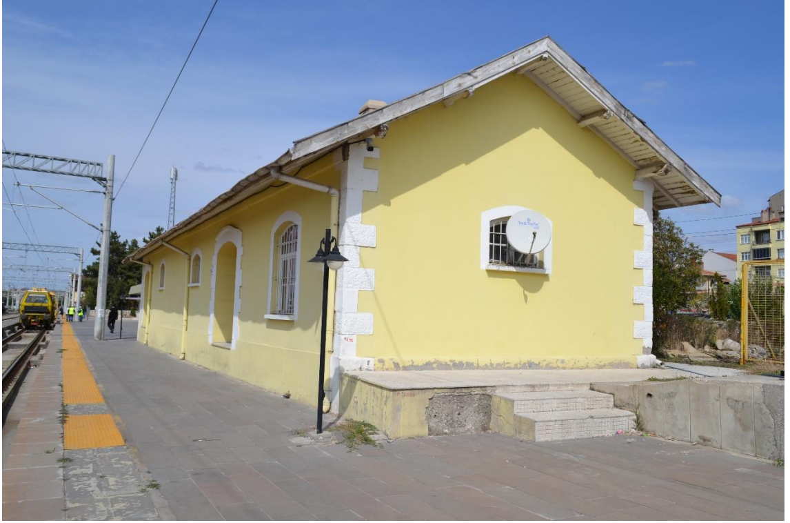
Fotoğraf 101: Tavşanlı İstasyonu Yolcu Binası Doğu Cephe Görünüşü.
