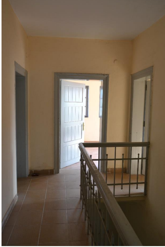
Fotoğraf 119: Değirmisaz İstasyonu Yolcu Binası Birinci Kat Koridor Görünüşü.
