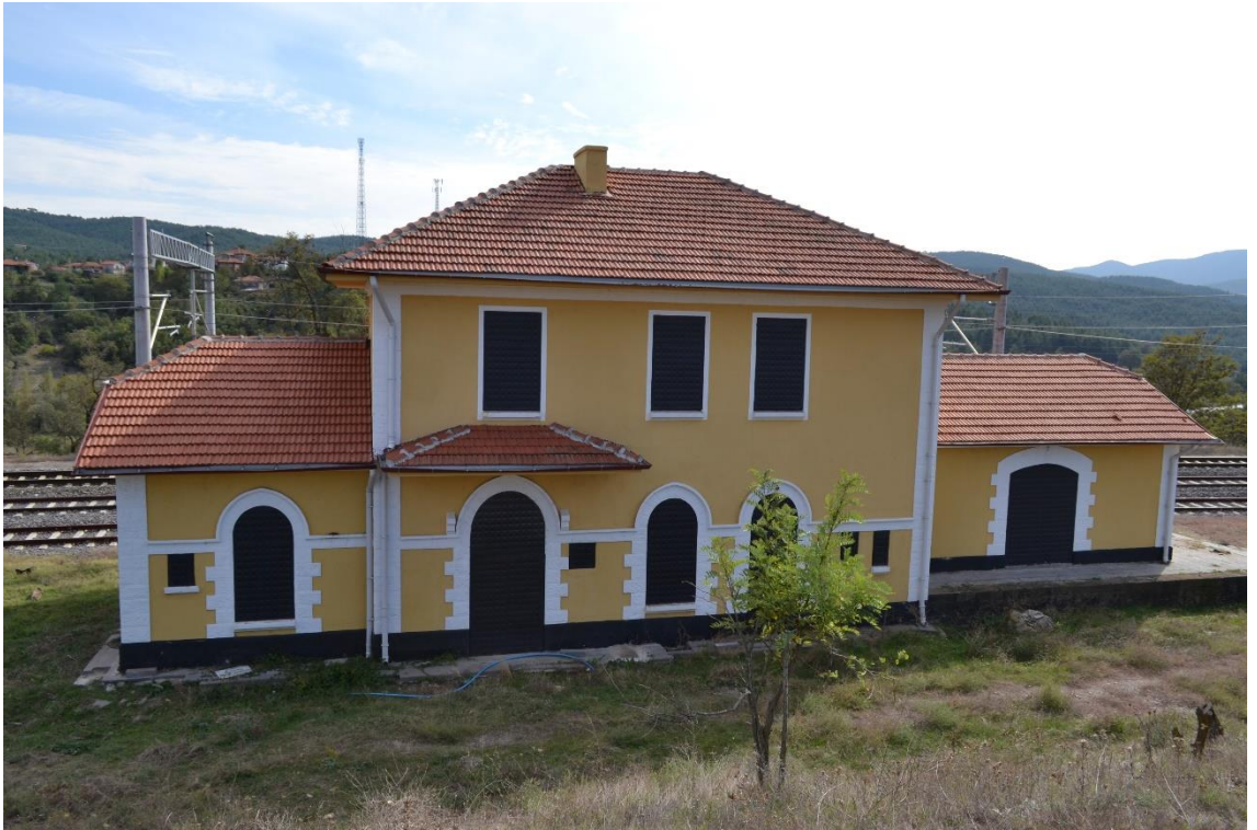
Fotoğraf 108: Demirli İstasyonu Yolcu Binası Kuzey Cephe Görünüşü.
