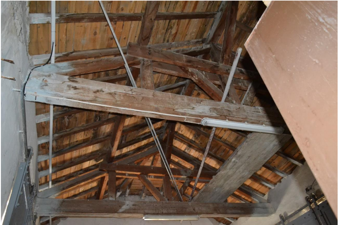
Fotoğraf 62: Emirler İstasyonu Ambar Binası Çatı Kirişleri.
