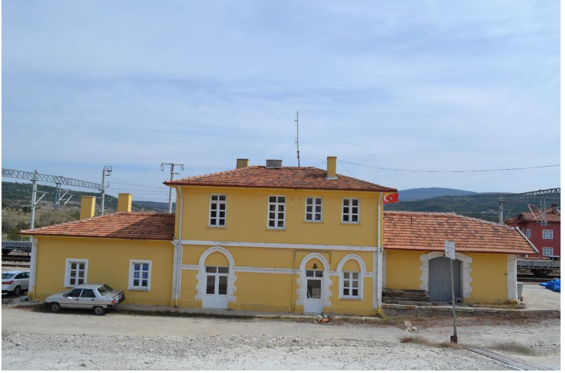
Fotoğraf 75: Emirler İstasyonu Yolcu Binası Kuzey Cephe Görünüşü.
