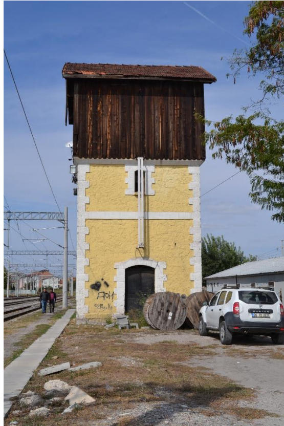
Fotoğraf 104: Tavşanlı İstasyonu Su Deposu Doğu Yönü Görünüşü.
