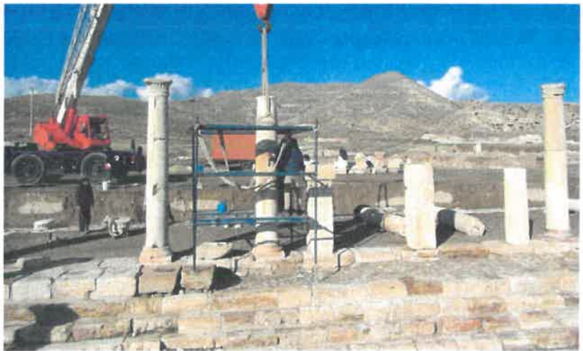
Resim 16 Sütun tamburlarının orijinal yerlerine yerleştirilmesi
