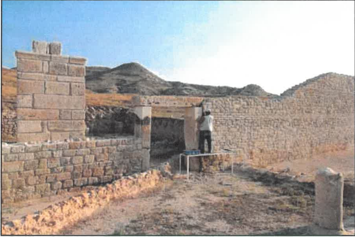
Resim 12: Kutsal Alan temenos duvarı restorasyon çalışması.
