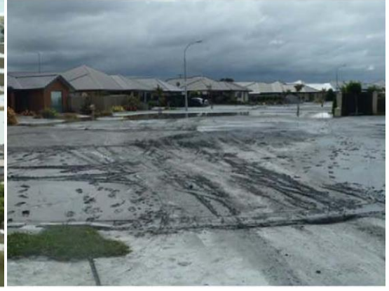
b) Zemin sıvılaşması
