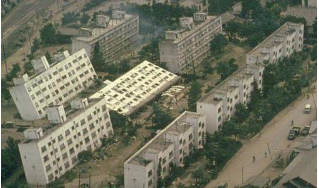
Şekil 2.1: 1964 Niigata depremi sonrası sivilaşma etkisiyle zarar gören yapılar (Japan National Committee on Earthquake Engineering 1965).
