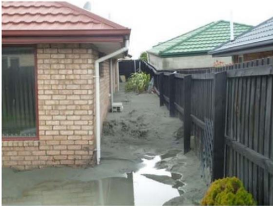
e) Yerleşim yerinde zemin sıvılaşması
