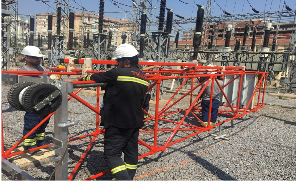
Şekil 3.13: İzole iskelenin kurularak canlı bakım çalışması için hazırlanması
