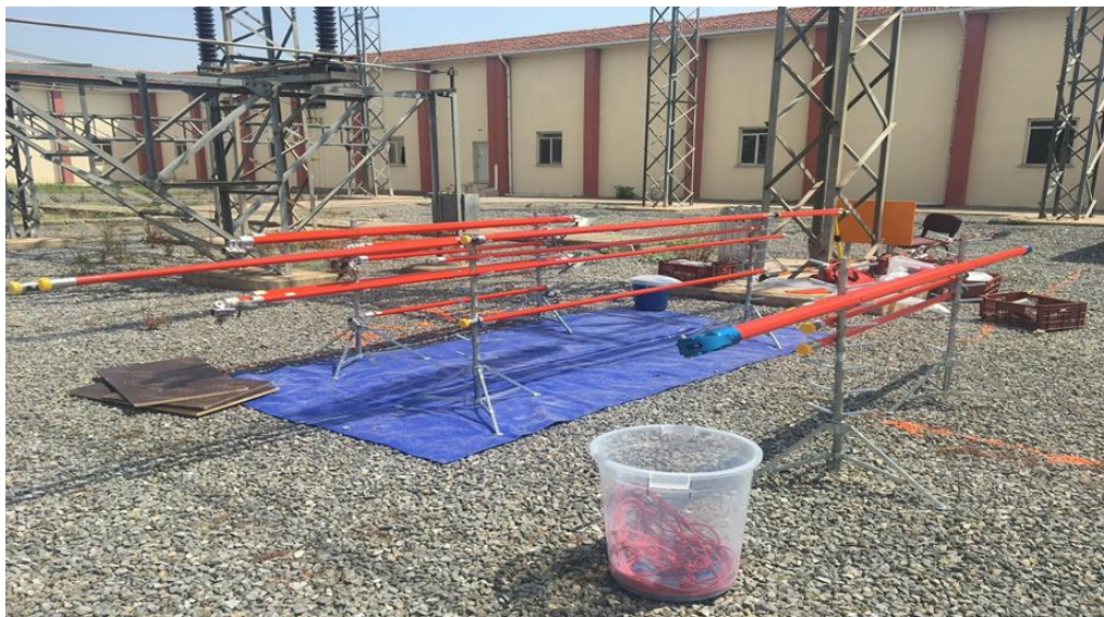
Şekil 3.11: Canlı bakımda çalışılacak malzemelerin düzenlenmesi
