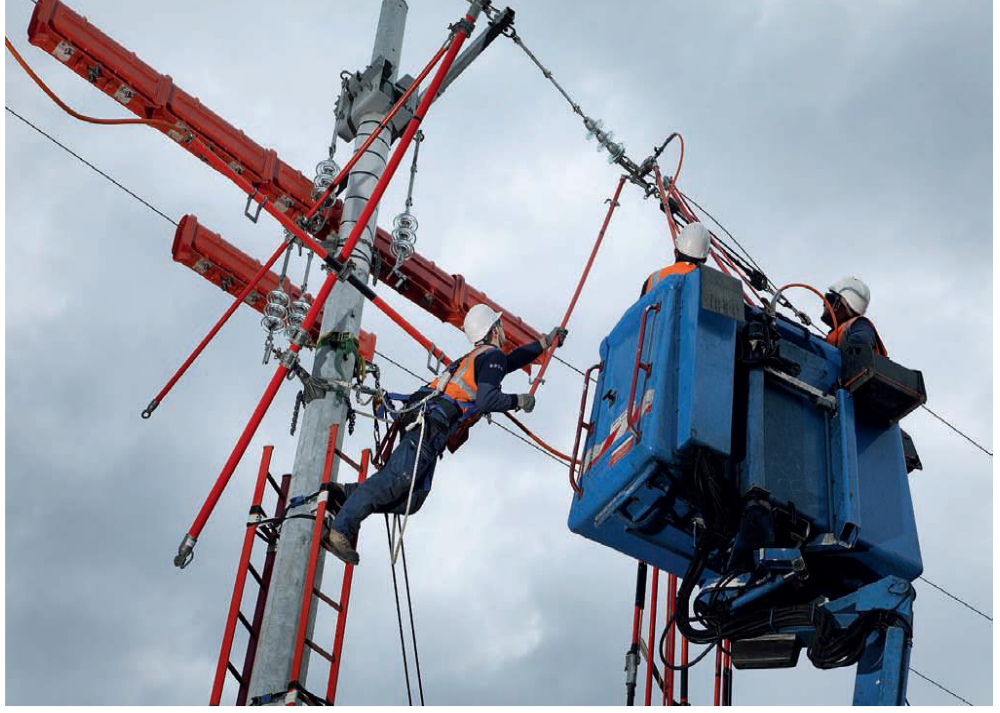
Şekil 3.1: Canlı bakımda sıcak sopa yöntemiyle teçhizat değişimi(RTE,2013)
