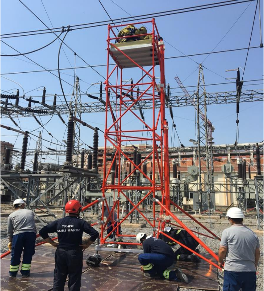
Şekil 3.22: Canlı bakım çalışması çalışma sorumlusu koordinasyonu
