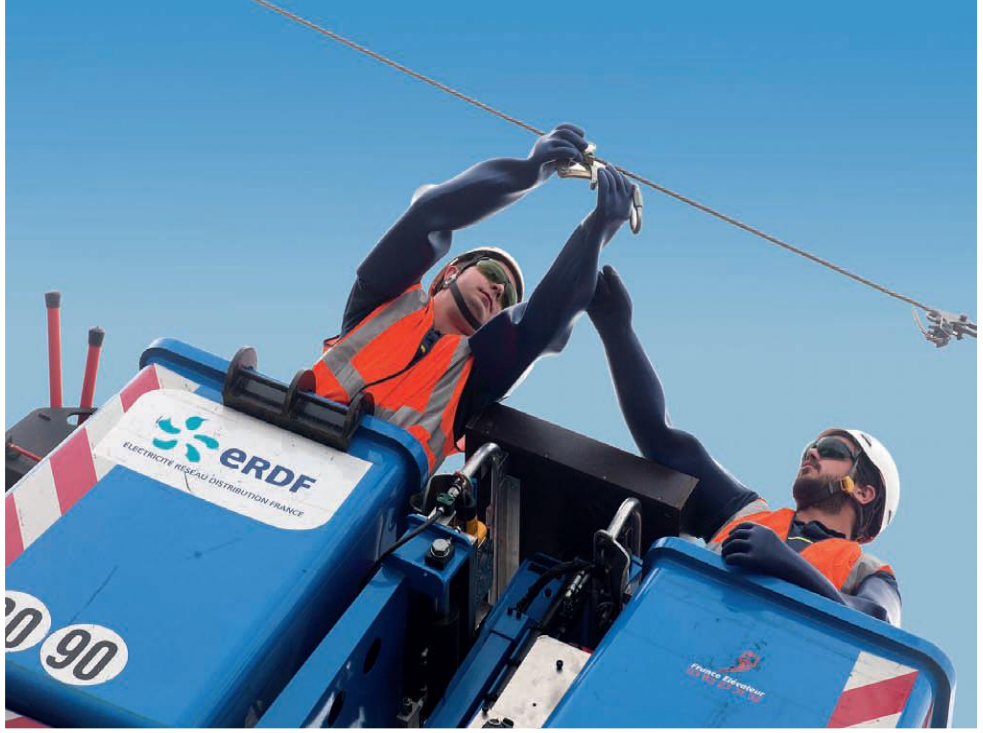
Şekil 3.2: Canlı bakım çalışmasında sıcak eldiven yöntemiyle bakım yapılması (RTE,2013).
