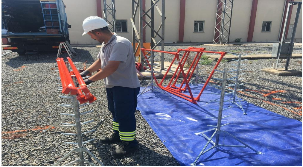
Şekil 3.10: Canlı bakımda çalışılacak malzemelerin düzenlenmesi
