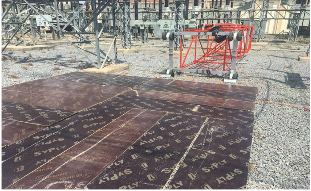
Şekil 3.12: Çalışma bölgesinde izole iskelenin hareketi için zeminin hazırlanması
