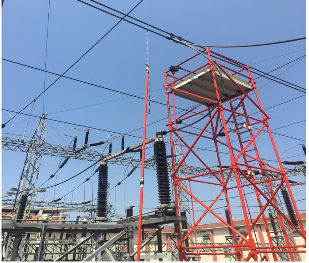
Şekil 3.15: CB çalışmasından önce atlama mesafesi ölçümlerinin yapılması
