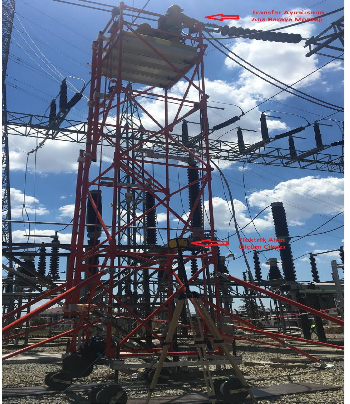
Şekil 4.12: Canlı bakım sırasında elektrik alan ölçümü
