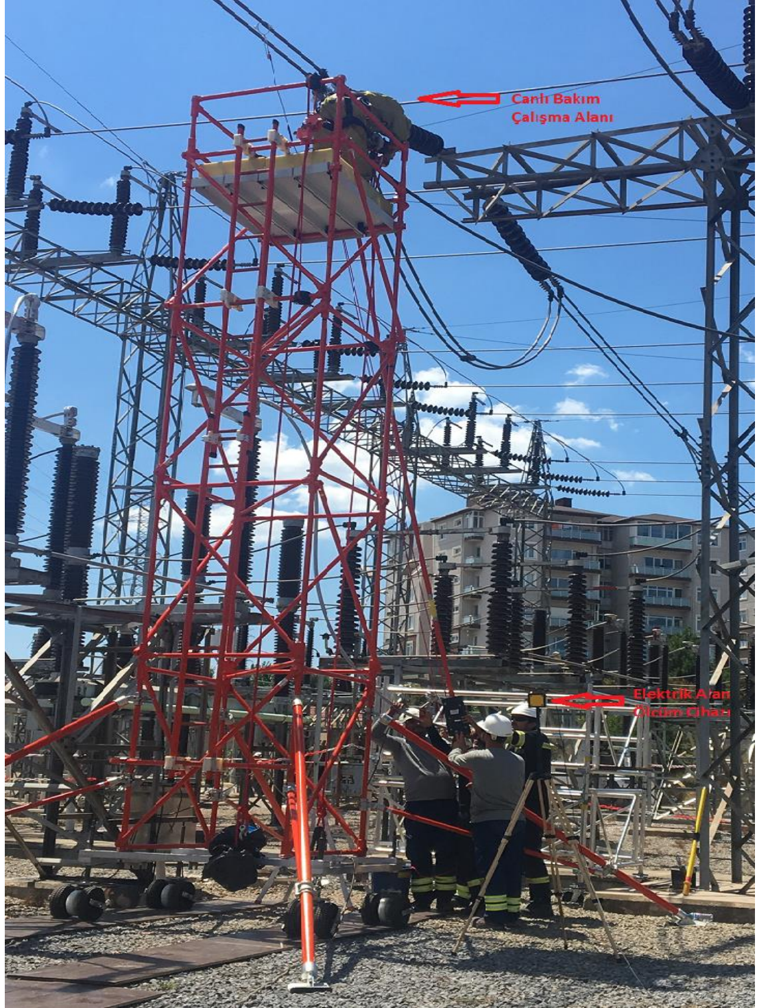
Şekil 4.11: Canlı bakım sırasında elektrik alan ölçümü
