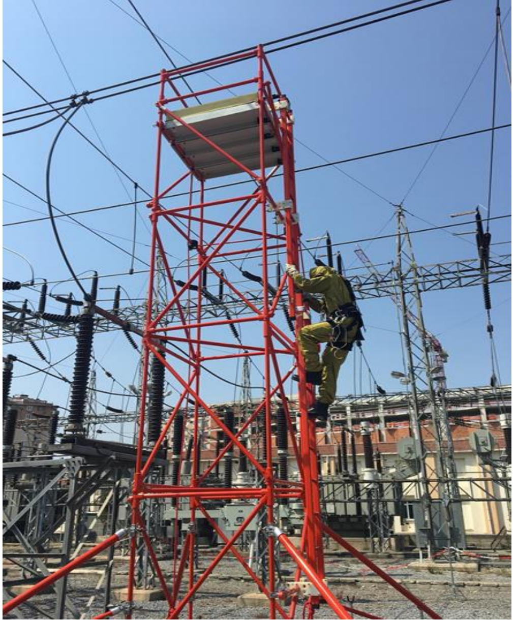
Şekil 3.20: Canlı bakım çalışmasında enerjili baraya çıkılması
