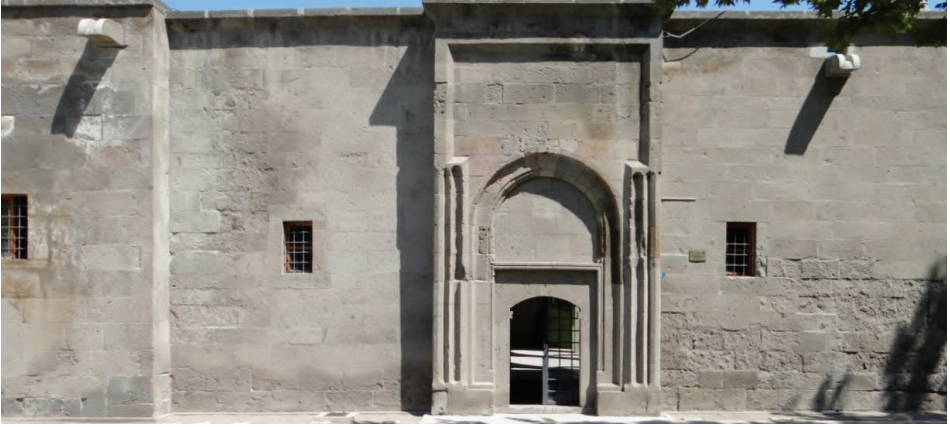
Fotoğraf 6: Çifte Medrese'nin doğu kanadında ön cephenin 0.65 m gerideki konumu. (M. Kutlu)
