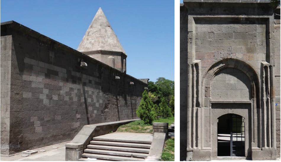
Fotoğraf 7 ve 8: Çifte Medrese'nin doğu kanadındaki türbe ve özgün olmayan taçkapı. (M. Kutlu)
