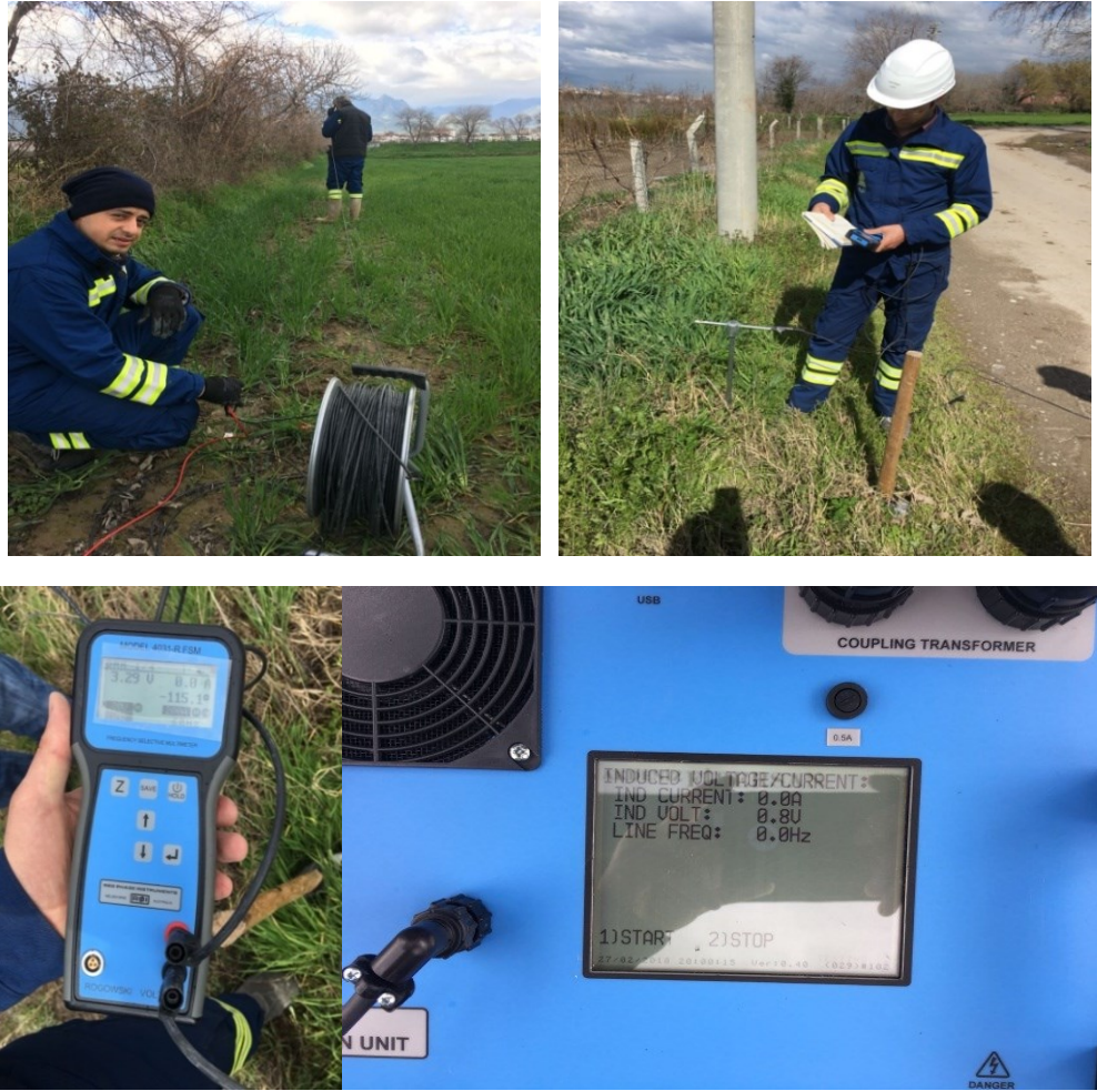
Şekil 7.5: Gerilim profili ölçümü saha çalışmaları
