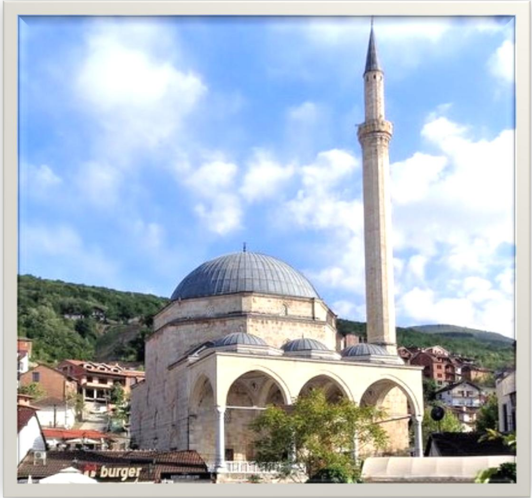
Fot. 84: Sinan Paşa Camisi dış görünüş
