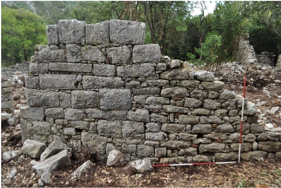
Şekil 119. Güney cephe duvarının dıştan görünüşü
