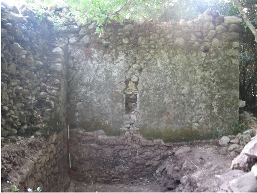
Şekil 26. Güneyde yer alan mekân, doğu cephesi (Öztaşkın, 2013: Şekil 54)
