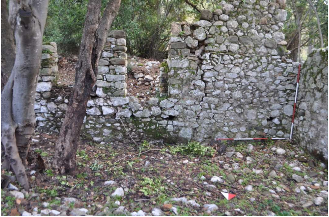
Şekil 24. Güney mekânın güney cephe duvarı
