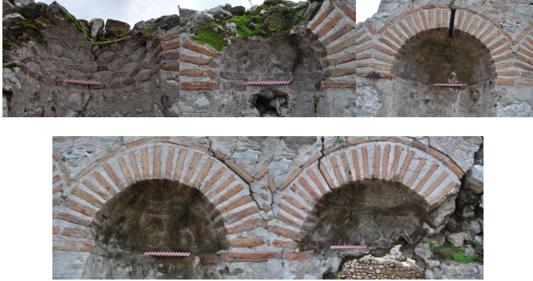
Şekil 50. Vaftizhane çeşmesi nişlerin tuğla süslemeleri
