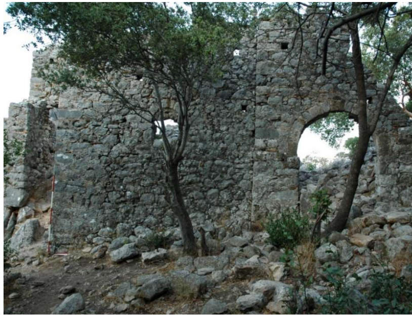
Şekil 75. Kompleksin batı giriş kapısı
