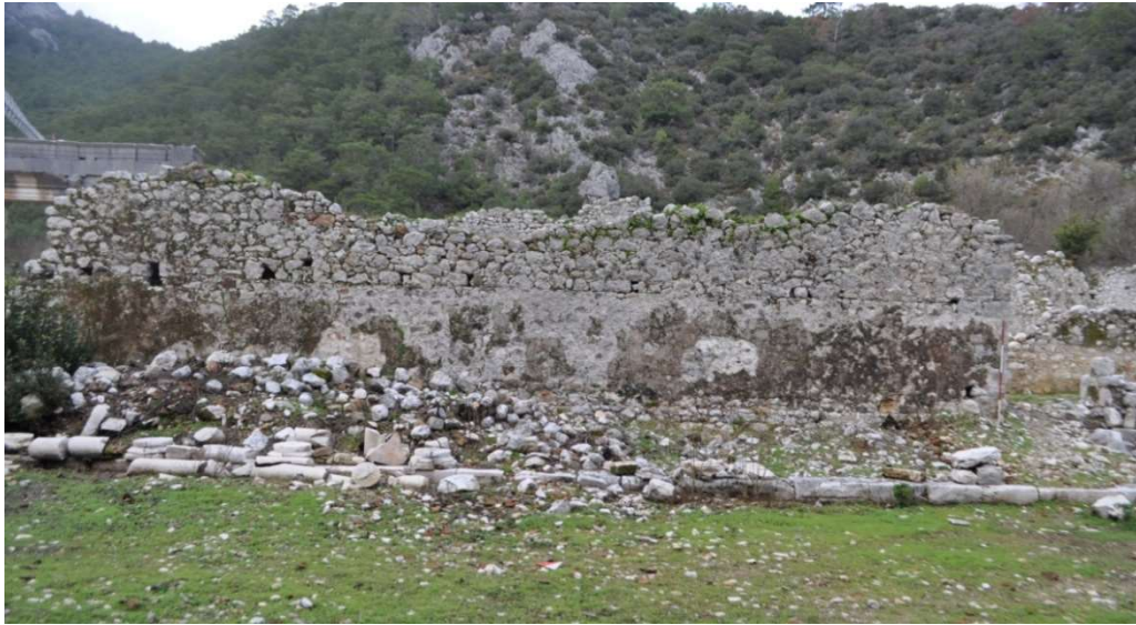
Şekil 48. Kilisenin kuzey cephe duvarı
