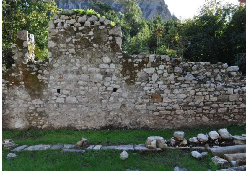
Şekil 68. Kilisenin güney cephe duvarı
