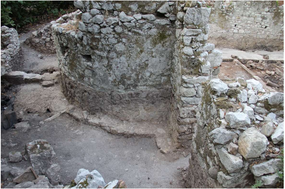
Şekil 65. Apsisin kuzeyindeki mekânın kuzeyden görünüşü
