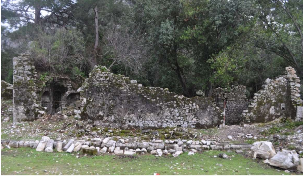
Şekil 47. Kilisenin güney cephe duvarı
