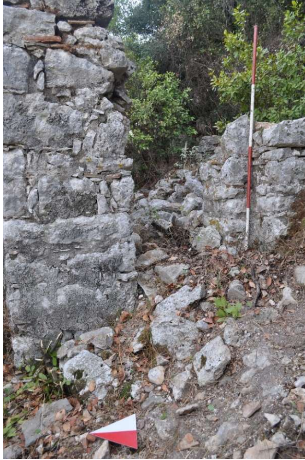
Şekil 79. Güney nef doğu ucundaki kapı açıklığı
