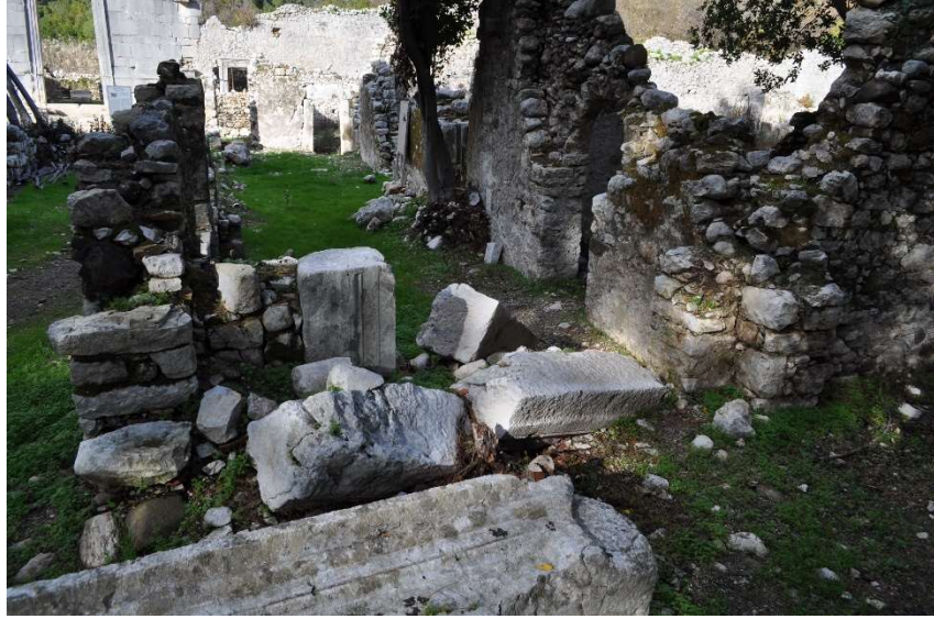
Şekil 16. Nartheks giriş kapısı
