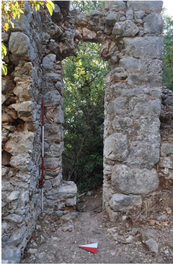
Şekil 78. Kuzey nef doğu ucundaki kapı açıklığı
