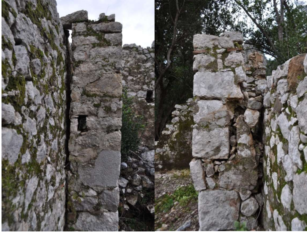
Şekil 51. Naos stylobat başlangıçlarındaki payandalarda görülen dilatasyon
