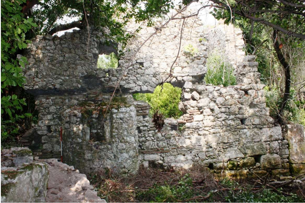
Şekil 104. Doğu çevre duvarının kuzey bölümü arka cephesi (kazı arşivi)
