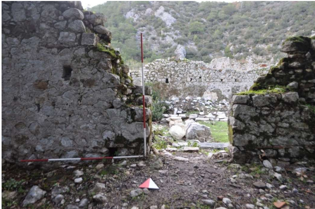
Şekil 27. Güney mekânın kuzey duvarındaki naosa açılan pencere
