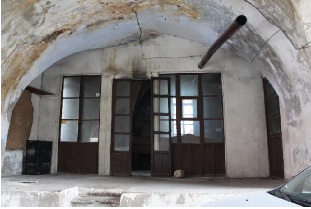
Fotoğraf 438: Antakya Kuseyri Sabunhanesi İdari Odanın Batı Cephesi (M. Çiftyürek)
