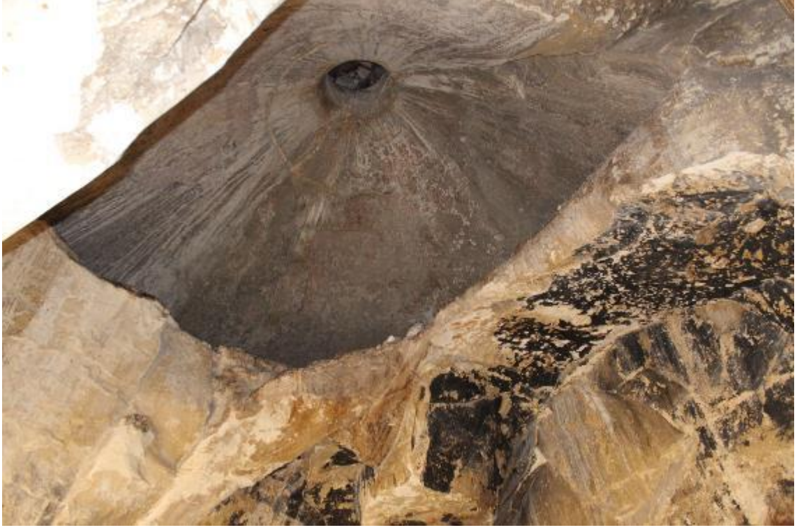
Fotoğraf 560: Birecik Mıstıkođlu Sabunhanesi Mađarannın Tavanındaki Kubbemsi Boşluk (M. Çiftyürek)
