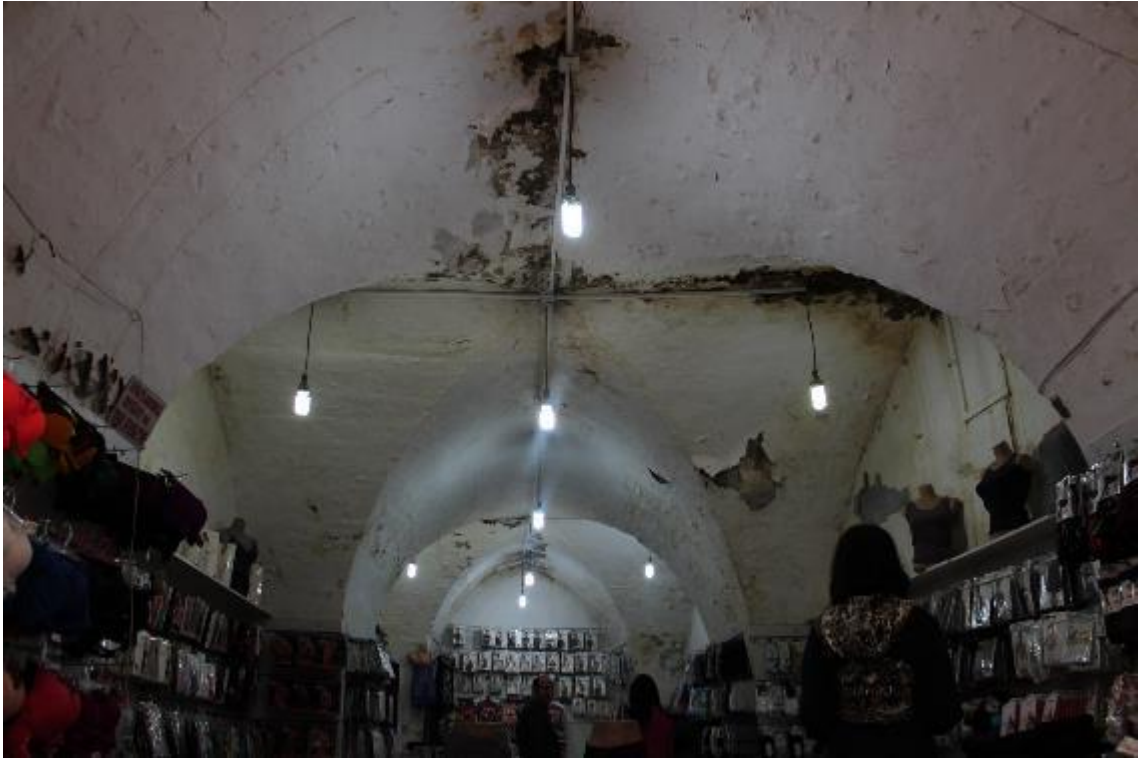
Fotoğraf 437: Antakya Kuseyri Sabunhanesi Güneydoğu Köşedeki Çapraz Tonozlu Bölüm (M. Çiftyürek)
