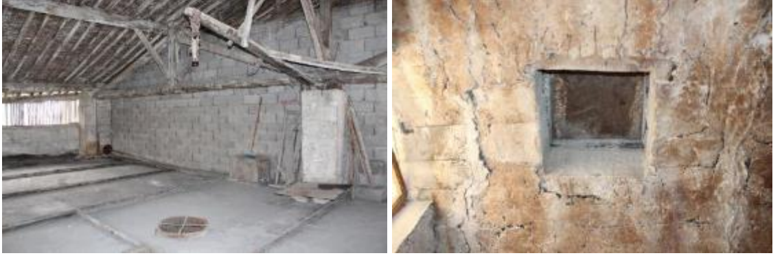
Fotoğraf 29: Carızkal ve Tonoz Yüzeyindeki Kare Boşluk (Antakya Kuseyri ve Selahattin Ökten Sabunhanesi)
