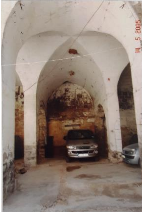
Fotoğraf 489: Gaziantep Kürkçü Sabunhanesi Doğudaki Tonozlu Bölüm, 2005 (Gaziantep KVKBKM Arşivi)
