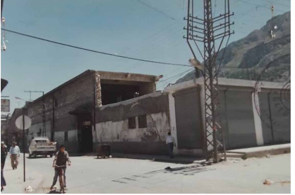
Fotoğraf 401: Antakya Şehoğlu Sabunhanesi Batı ve Güney Cephe, 1996 (Hatay KVKBKM Arşivi)
