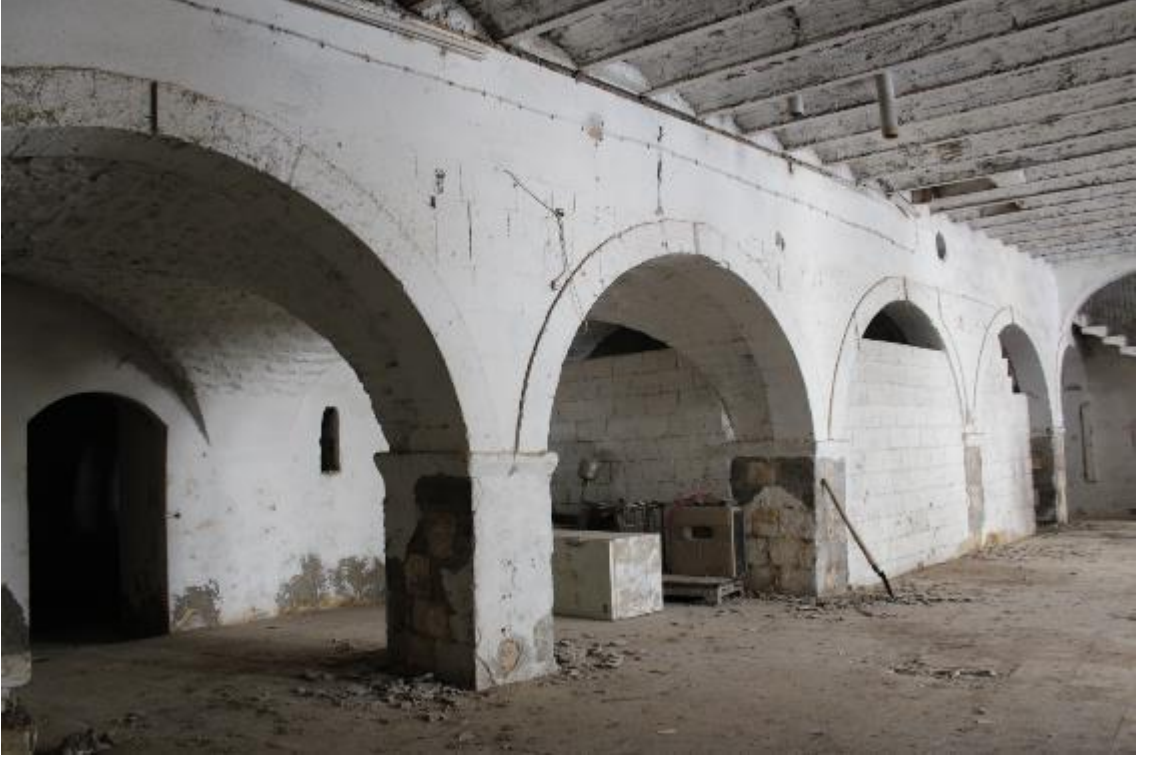
Fotoğraf 641: Kilis Muharrem Bey Sabunhanesi Yuvarlak Kemerleri (M. Çiftyürek)
