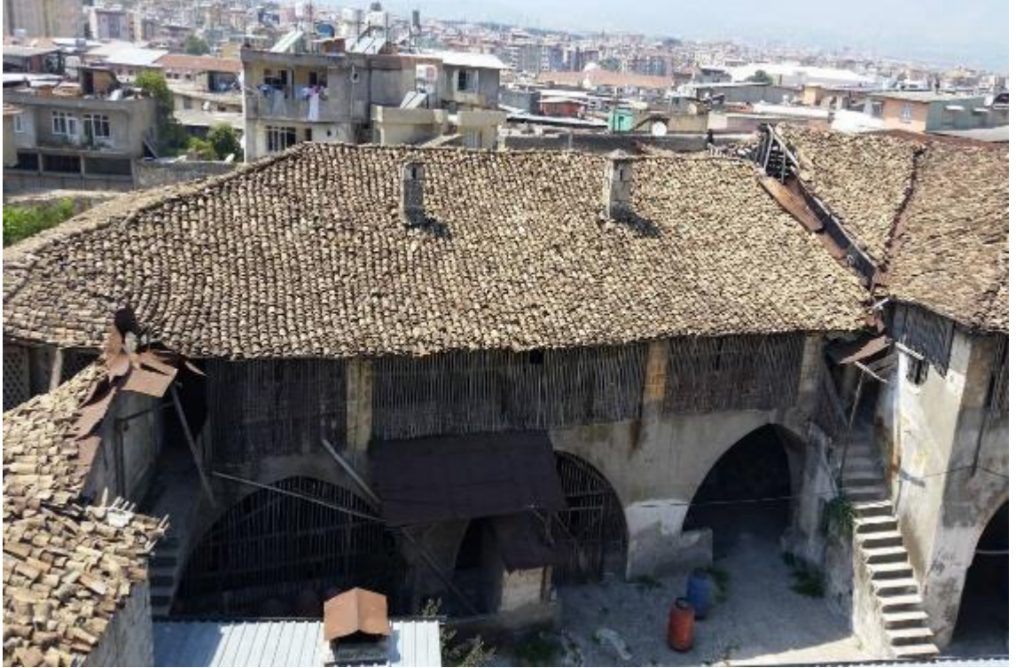
Fotoğraf 456: Antakya Kuseyri Sabunhanesi Çatısı (M. Çiftyürek)
