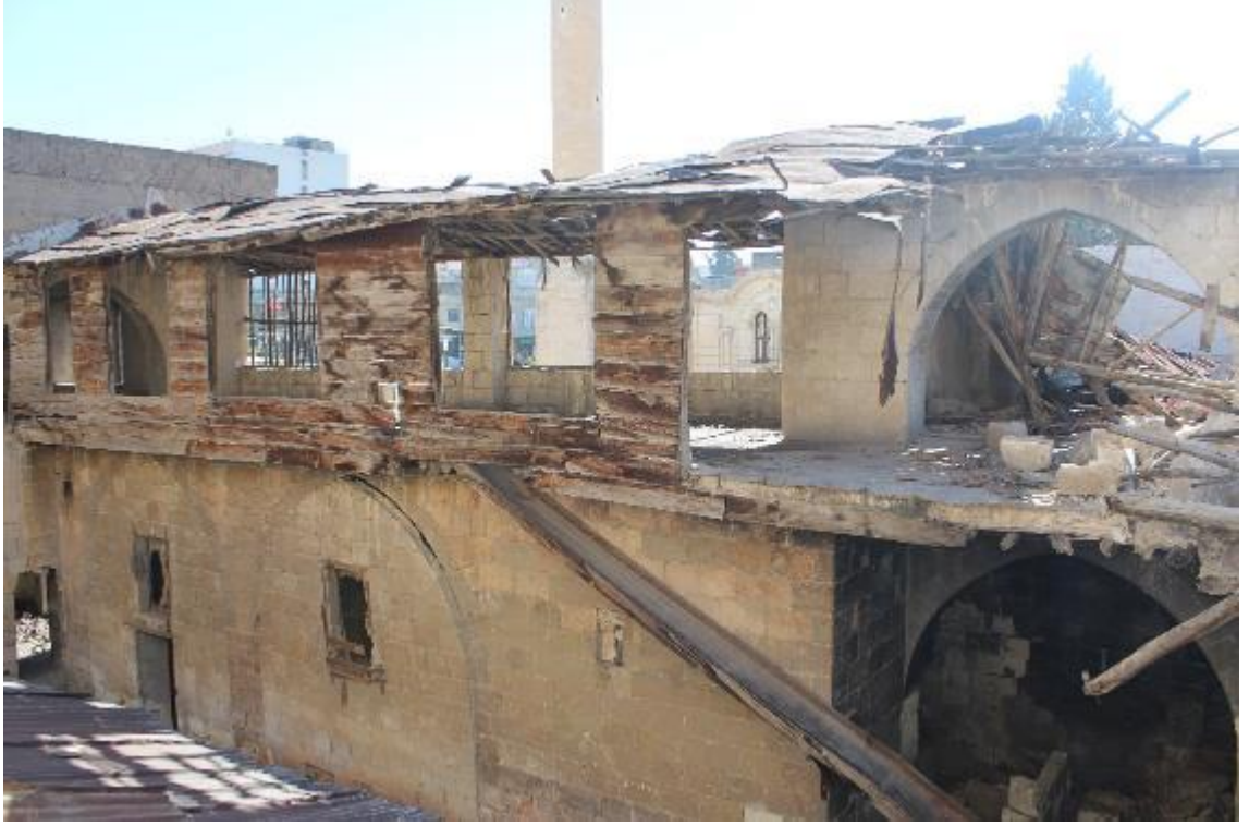
Fotoğraf 606: Nizip Sayınlar Sabunhanesi Avluya Bakan Güney Cephe (M. Çiftiyürek)
