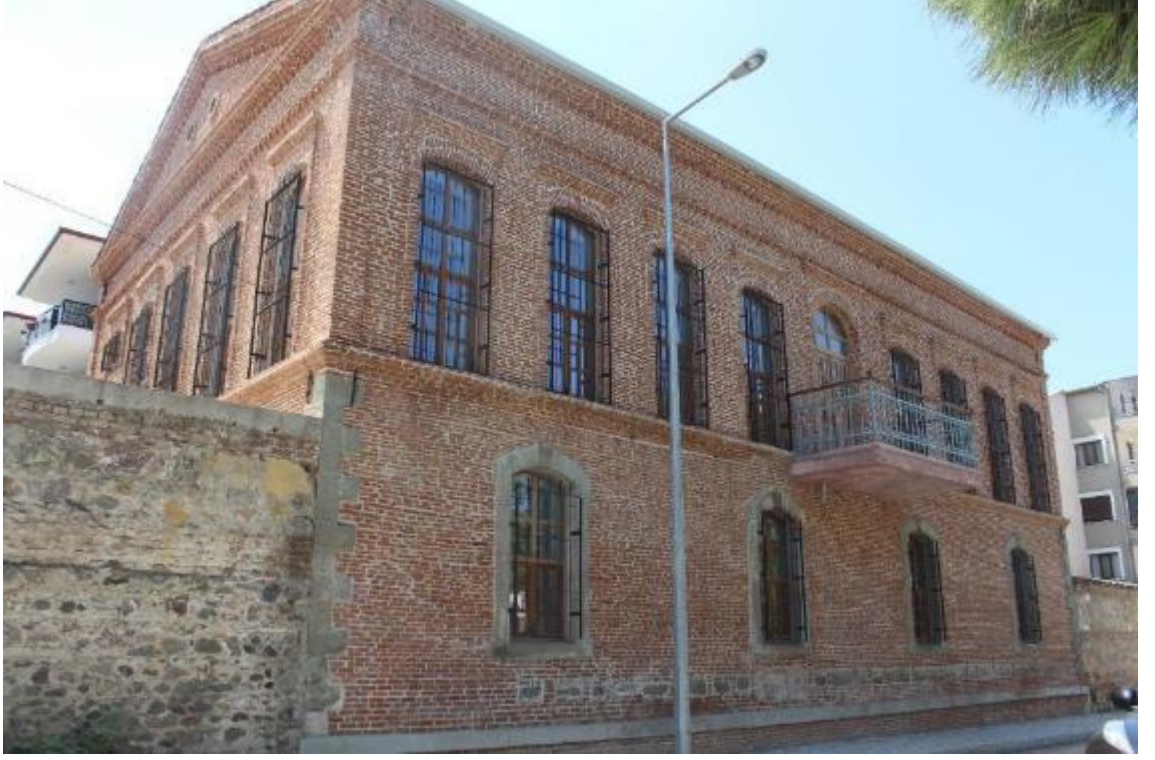
Fotoğraf 195: Burhaniye Hüsnü Tolun Sabunhanesi Kuzey Cephe (M. Çiftyürek)
