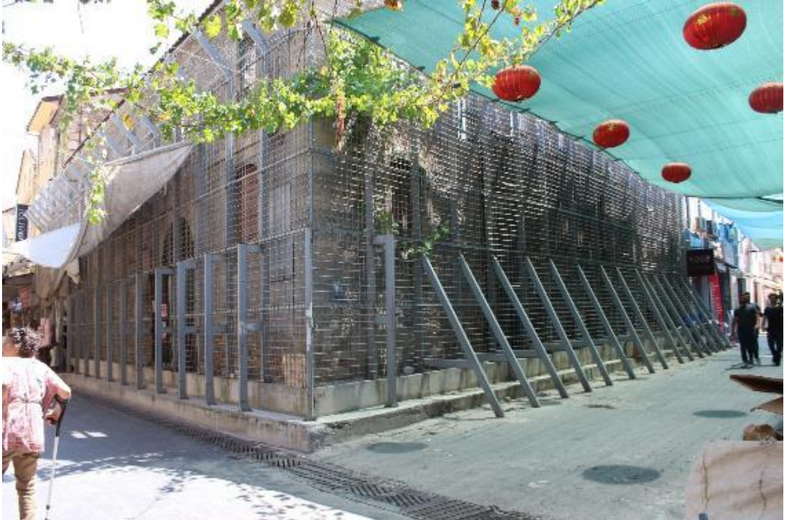
Fotoğraf 276: Konak Hamdi Dalan Sabunhanesi Kuzey ve Batı Cephe (M. Çiftyürek)
