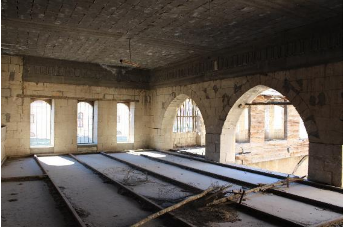
Fotoğraf 614: Nizip Sayınlar Sabunhanesi Doğu Bölümün Birinci Katı (M. Çiftyürek)
