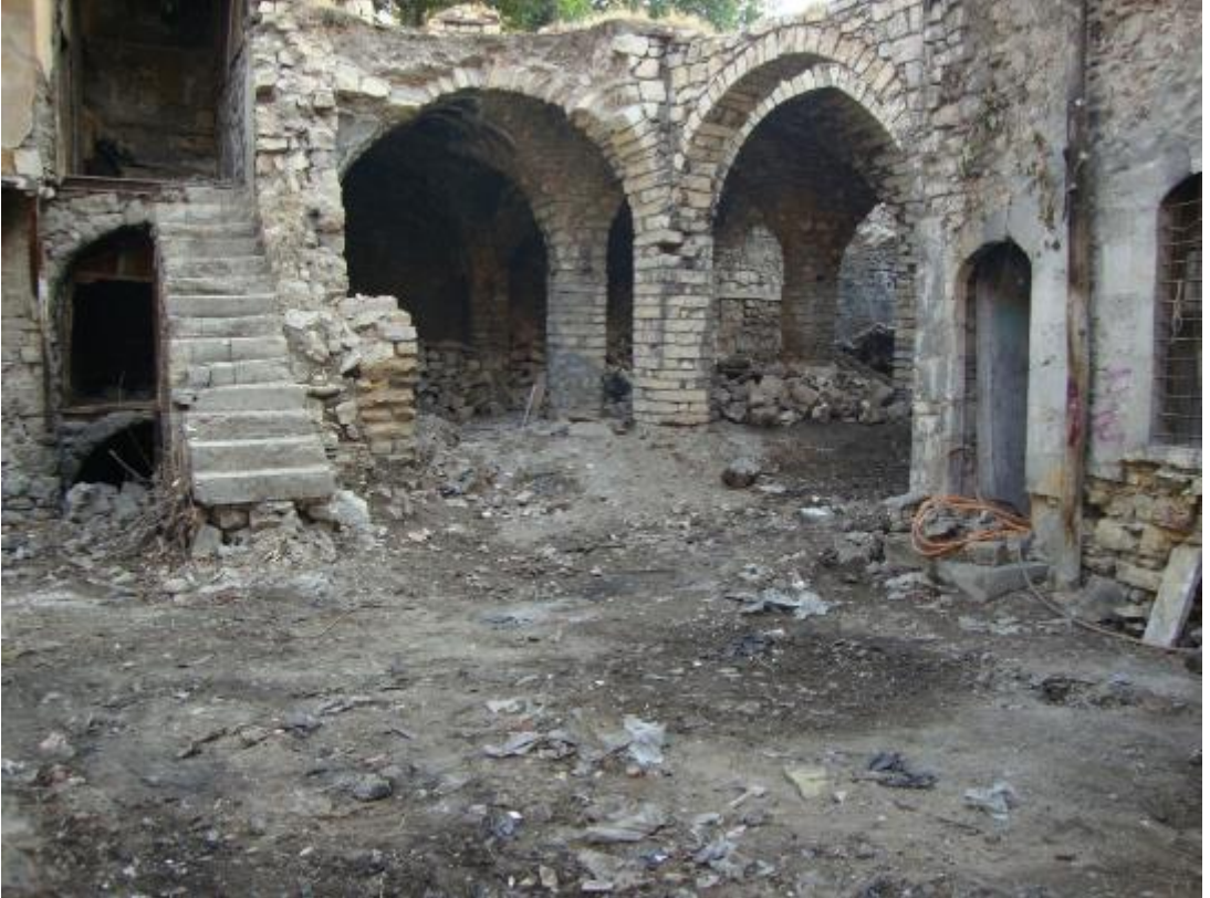
Fotoğraf 787: Kahramanmaraş Cumhuriyet Hanı Sabunhanesi Doğu Kütlenin Güney Cephesi, 2010 (Kahramanmaraş Belediyesi Arşivi)
