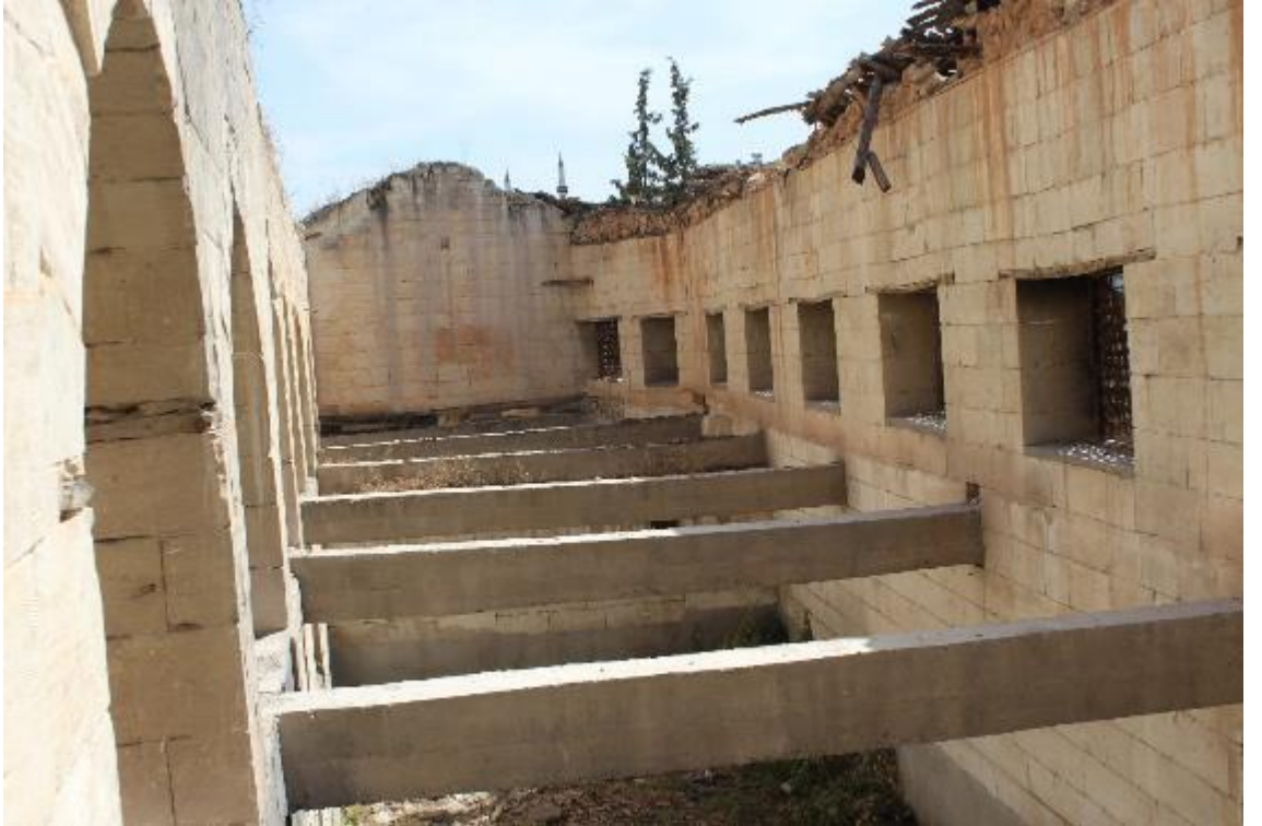
Fotoğraf 573: Birecik Mıstıkoğlu Sabunhanesi Batı Bölüm Birinci Kattaki Sabun Kurutma Alanı (M. Çiftyürek)
