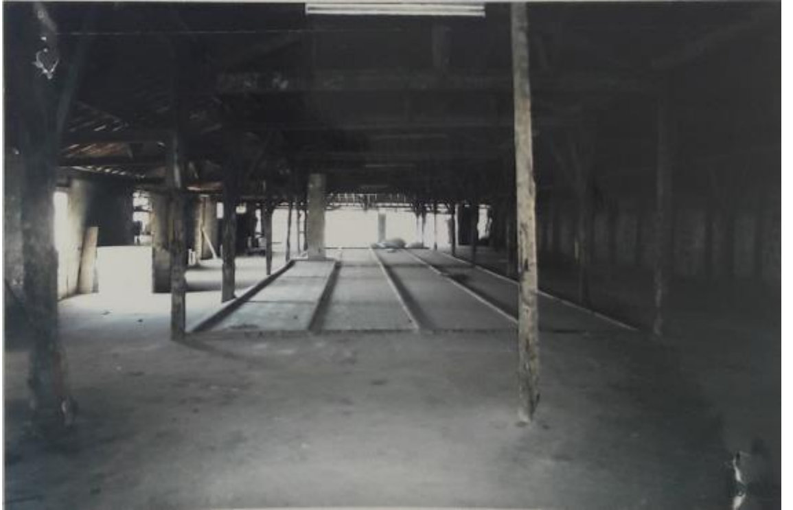
Fotoğraf 429: Antakya Selahattin Ökten Sabunhanesi Birinci Kattaki Sabun Kalıpları (Hatay KVKBKM Arşivi)
