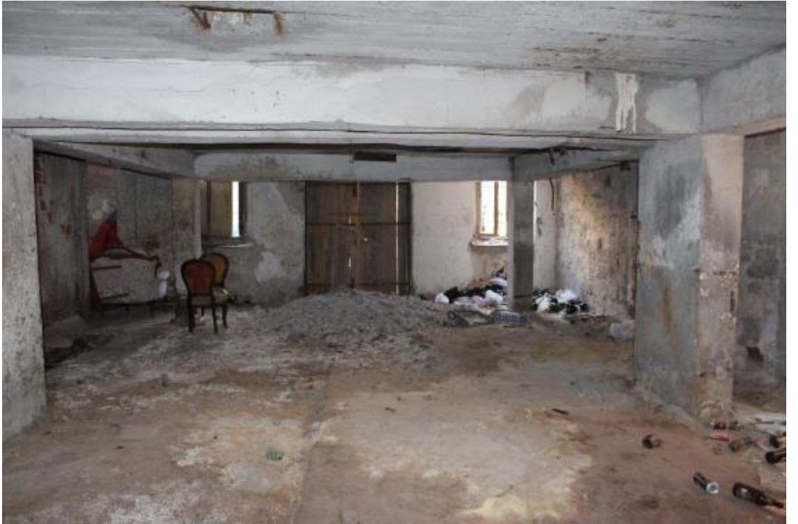
Fotoğraf 144: Ayvalık Cömertler Sabunhanesi Birinci Kütlenin Zemin Katı (M. Çiftyürek)
