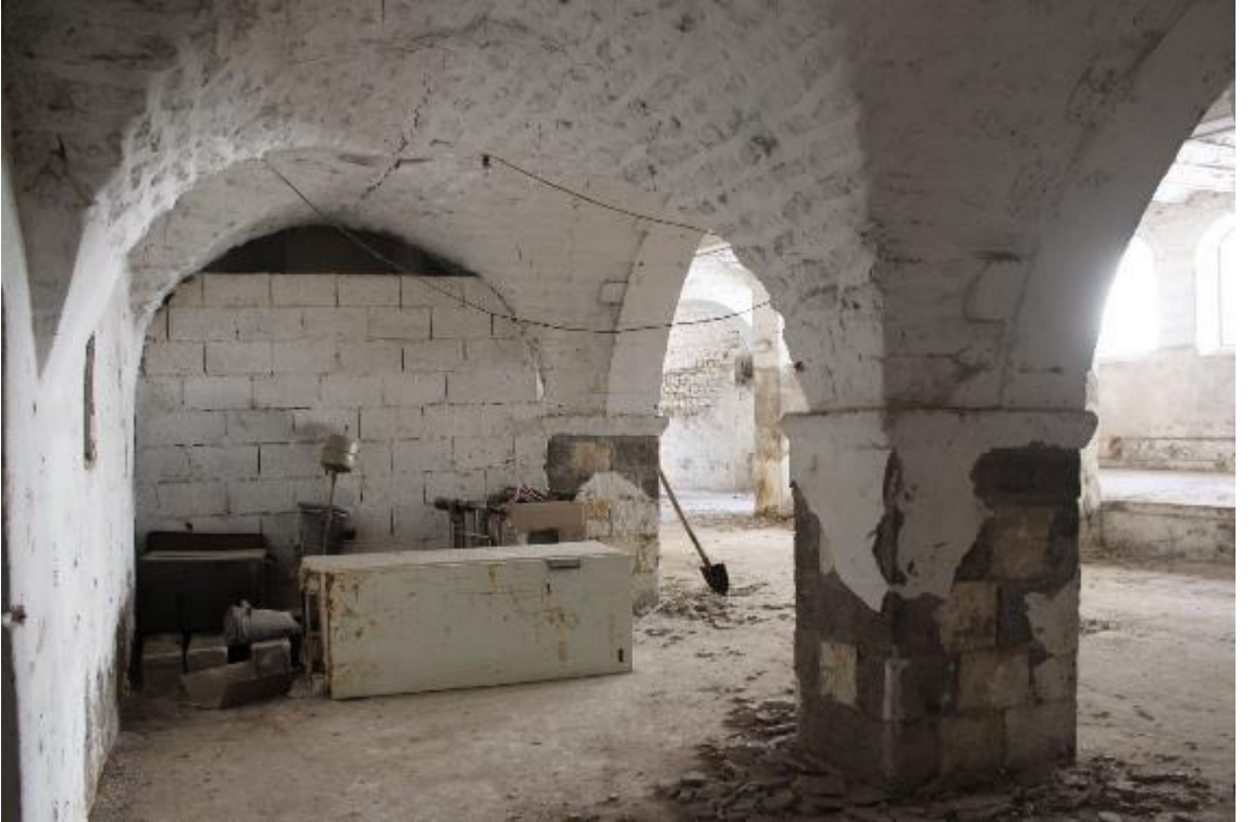
Fotoğraf 647: Kilis Muharrem Bey Sabunhanesi Kuzeydoğu Köşedeki Deponun Önündeki Yarı Açık Mekân (M. Çiftyürek)
