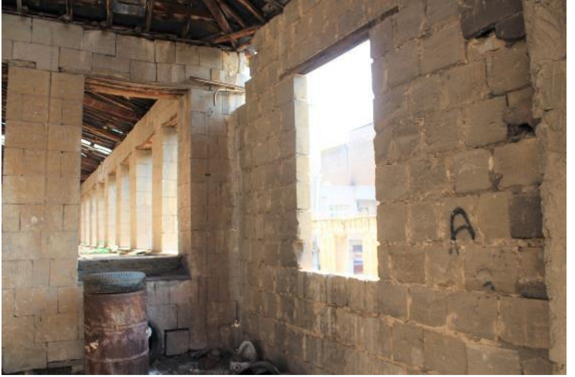
Fotoğraf 722: Nizip Okanlar Sabunhanesi Batı Bölüm Birinci Katın Güney Duvarı (M.Çiftyürek)
