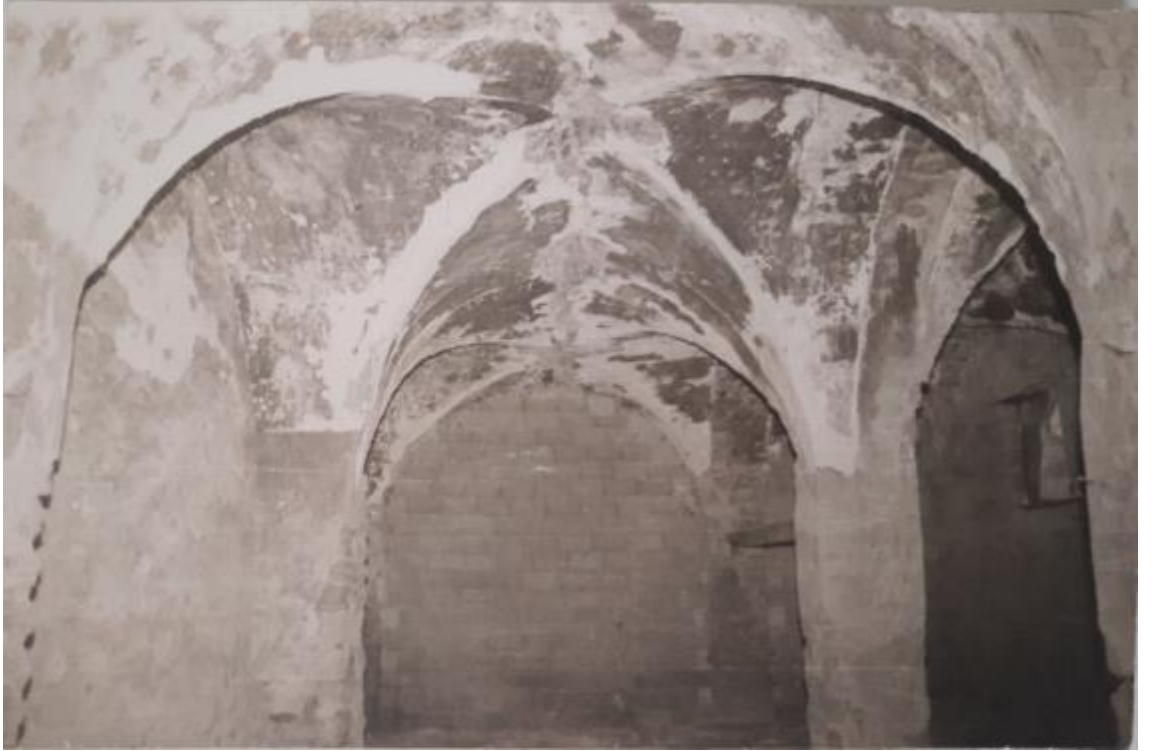
Fotoğraf 789: Kahramanmaraş Cumhuriyet Hanı Sabunhanesi Doğu Kütlenin Çapraz Tonozu, 1986 (Gaziantep KVKBKM Arşivi)
