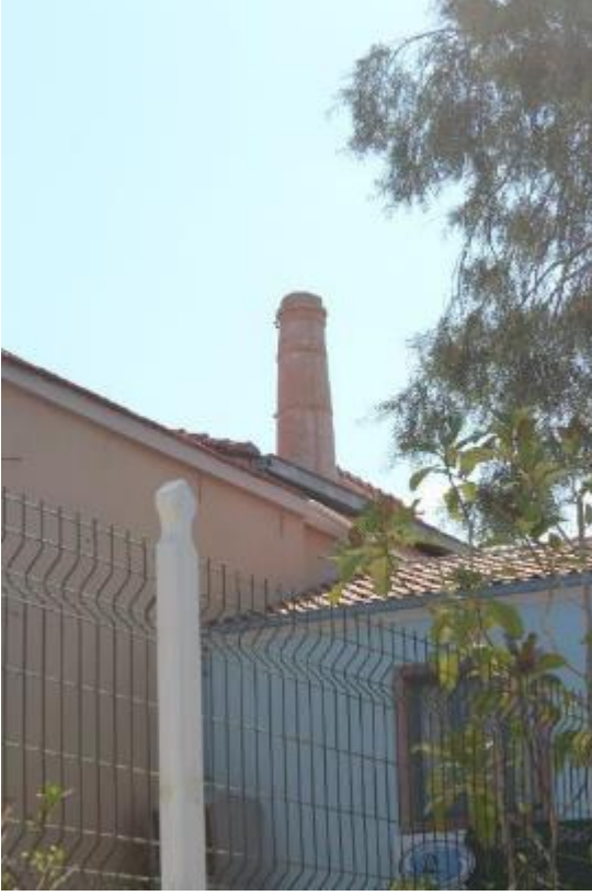
Fotoğraf 99: Ayvalık Erman Sabunhanesi Tuğla Bacası (M.Çiftyürek)
