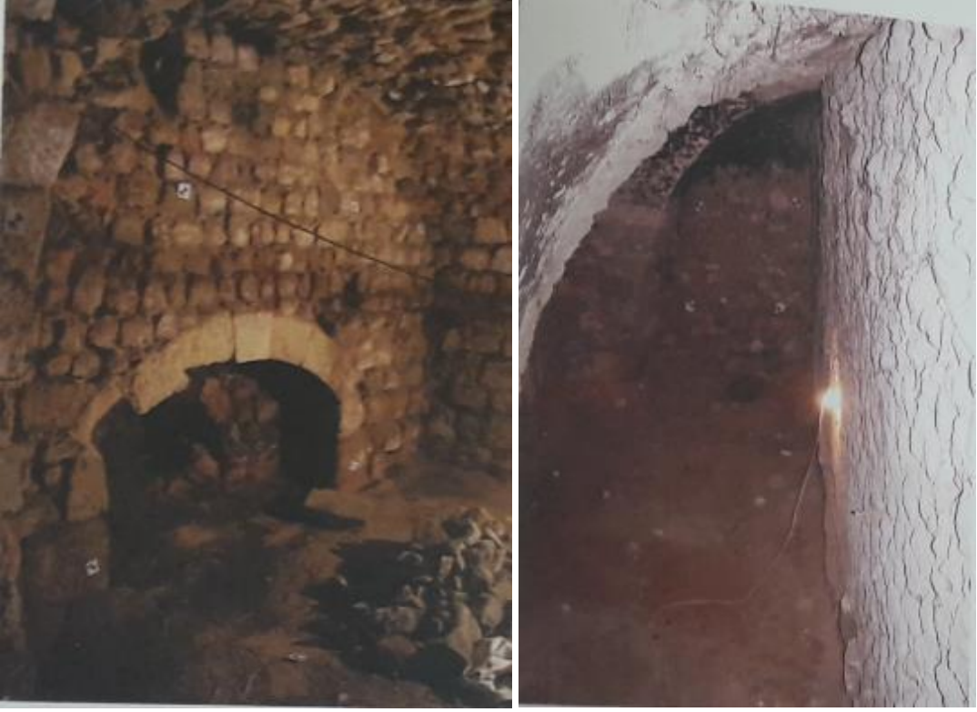
Fotoğraf 385: Antakya Hasan Ökten Sabunhanesi Ocaklıkları (Hatay KVKBKM Arşivi)
