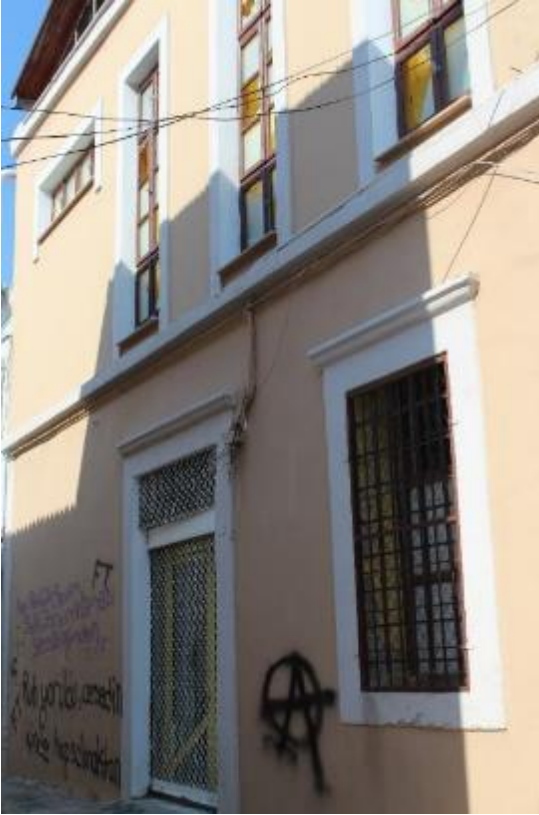
Fotoğraf 100: Ayvalık Erman Sabunhanesi Doğu Cephe (M.Çiftyürek)
