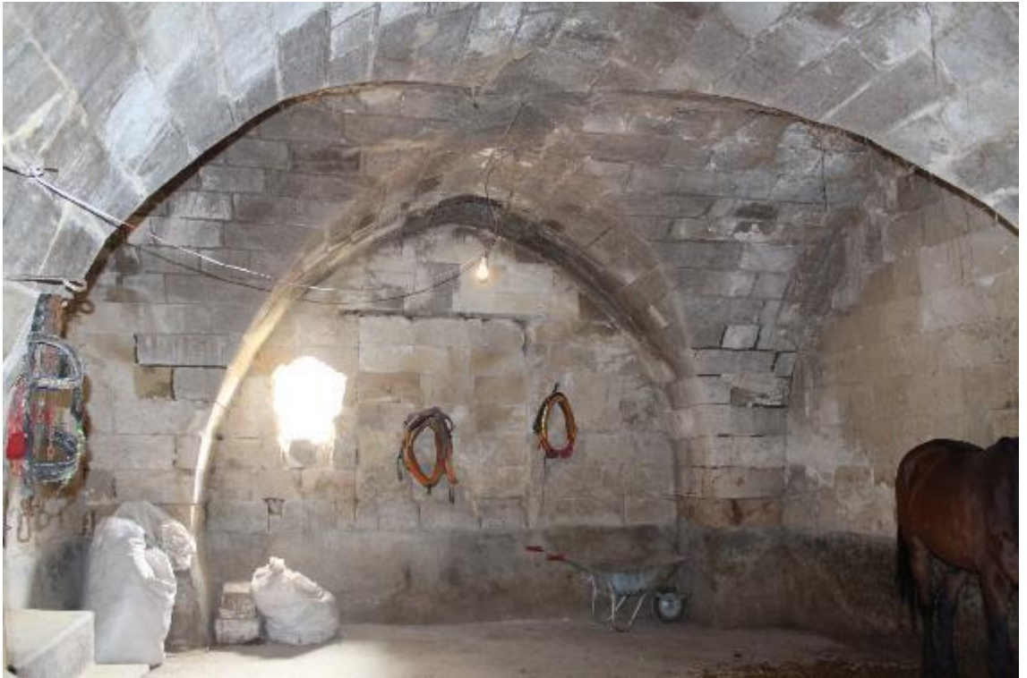
Fotoğraf 543: Birecik Mıstıkođlu Sabunhanesi Avlu Geçidinin Batısındaki Mekân (M. Çiftyürek)
