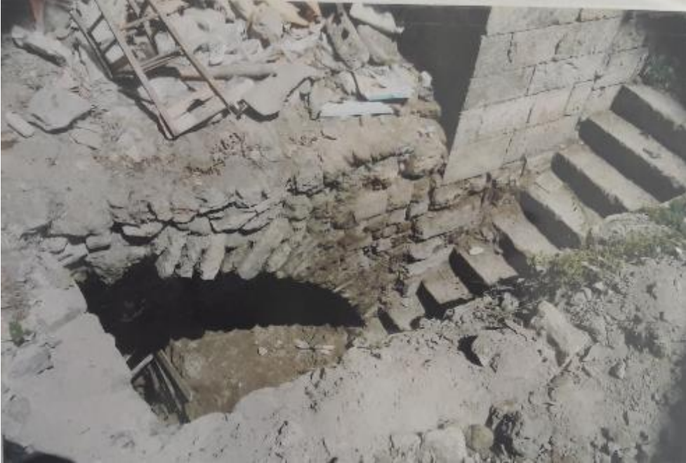
Fotoğraf 326: Antakya Haytoğlu Sabunhanesi Ocaklık Merdiveni, 2003 (Hatay KVKBKM Arşivi)
