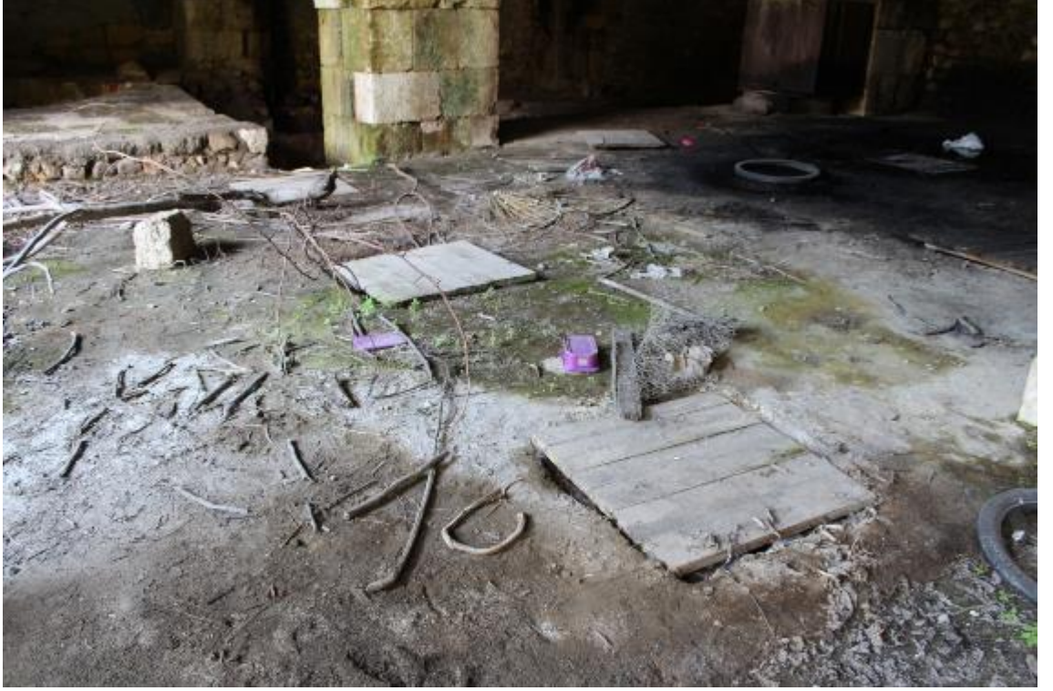
Fotoğraf 347: Antakya Aselcioğlu Sabunhanesi Zeytinyağı Kuyuları (M. Çiftyürek)
