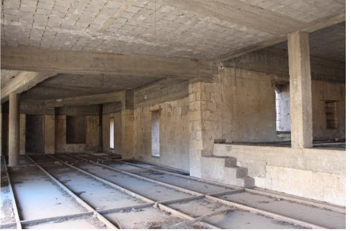
Fotoğraf 616: Nizip Sayınlar Sabunhanesi Doğu Bölümün Birinci Katı (M. Çiftyürek)
