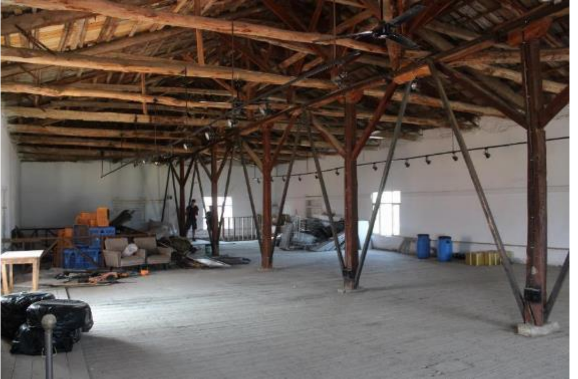
Fotoğraf 110: Burhaniye Yağcı Sabunhanesi Birinci Katın Güney ve Batı Duvarı (M.Çiftyürek)
