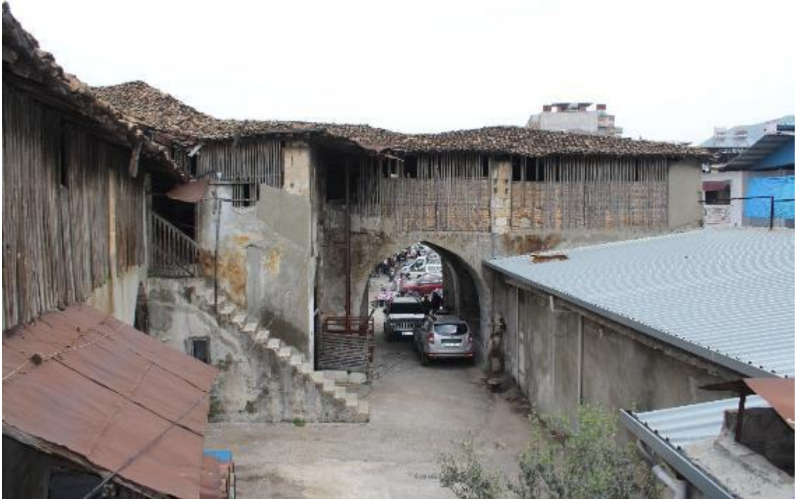
Fotoğraf 435: Antakya Kuseyri Sabunhanesi Avluya Bakan Kuzey, Doğu ve Batı Cephe (M. Çiftyürek)
