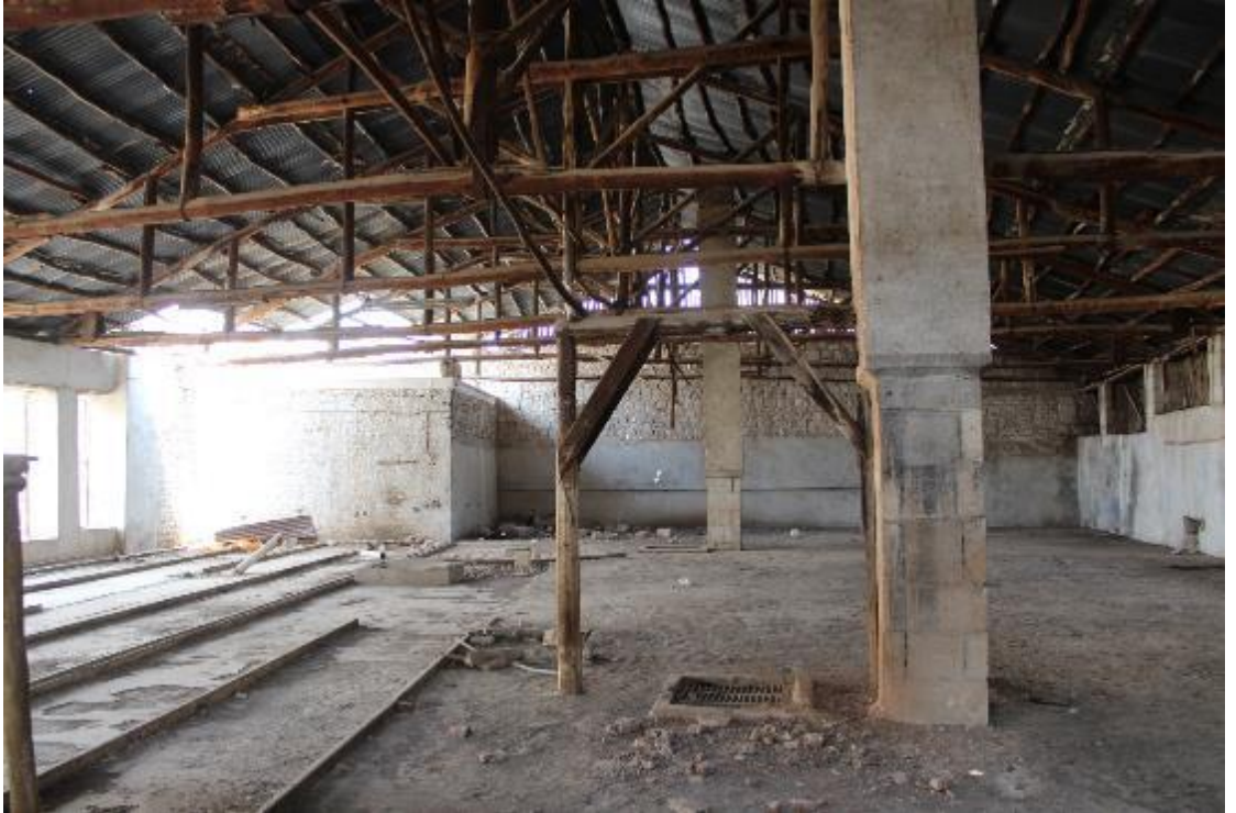
Fotoğraf 655: Kilis Muharrem Bey Sabunhanesi Birinci Katı (M. Çiftyürek)
