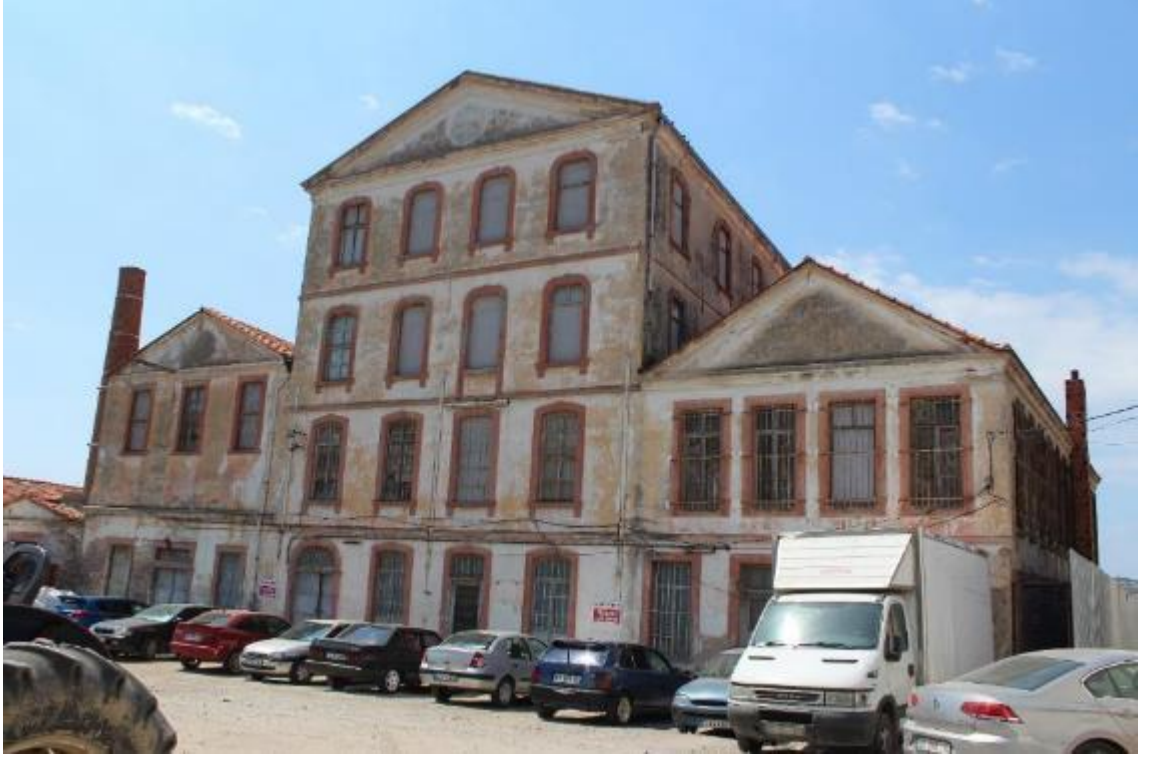
Fotoğraf 820: Ayvalık Sezai Ömer Madra Sabunhanesi Güney Cephe (M. Çiftyürek)
