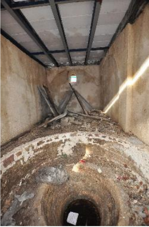
Fotoğraf 797: Kahramanmaraş Cumhuriyet Hanı Sabunhanesi Batı Kütledeki Sabun Kazanı, 2013 (Kahramanmaraş Belediyesi Arşivi)
