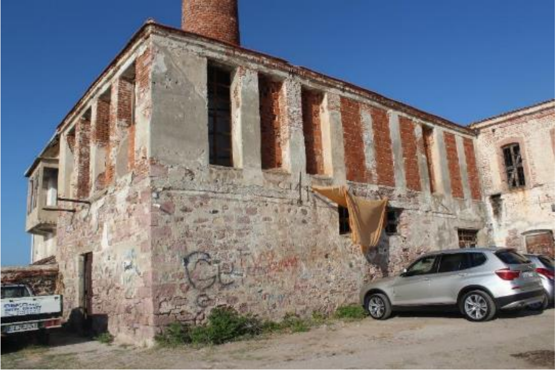
Fotoğraf 164: Ayvalık Ertemler Sabunhanesi Güneybatı Cephe (M.Çiftyürek)
