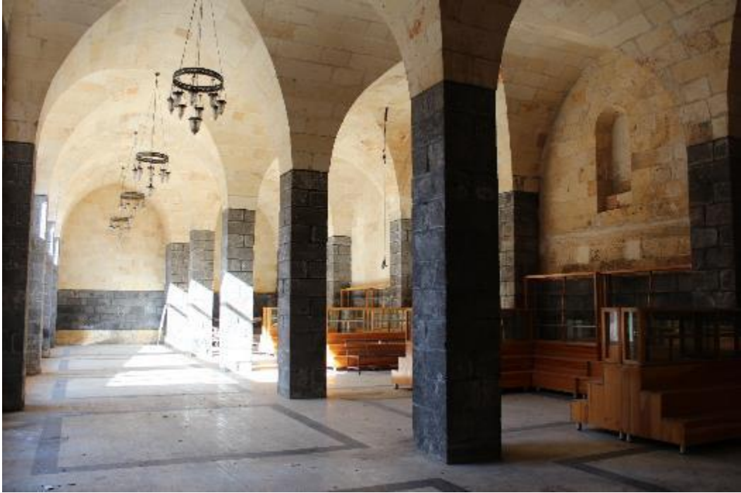
Fotoğraf 495: Gaziantep Kürkçü Sabunhanesi Kuzeydeki Tonozlu Bölüm (M. Çiftyürek)
