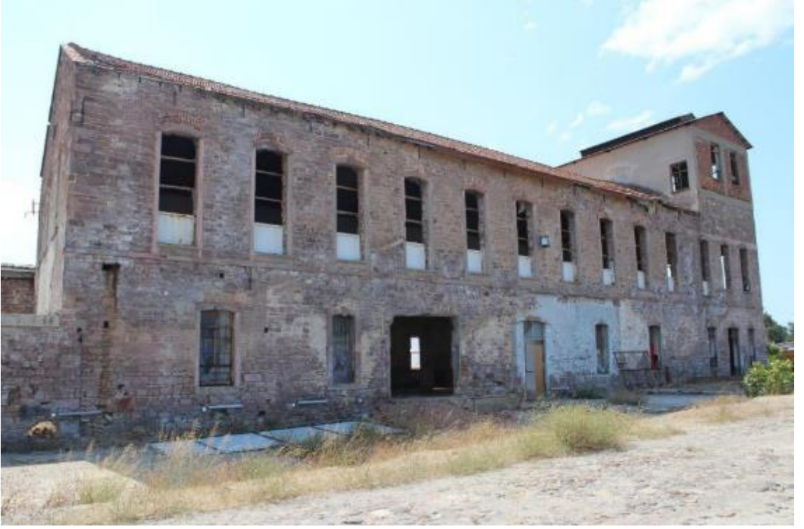
Fotoğraf 119: Ayvalık Fazıl Doğan Sabunhanesi Kuzeybatı Cephe (M. Çiftiyürek)
