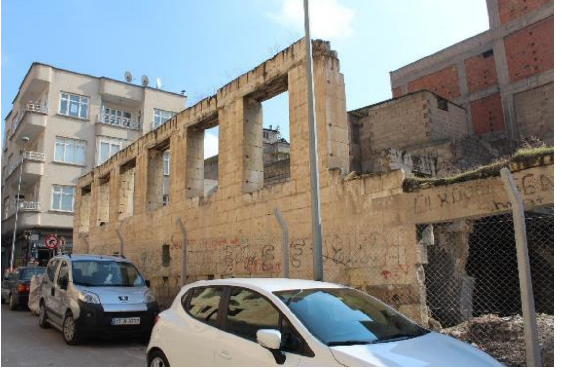
Fotoğraf 746: Nizip Özkaya Sabunhanesi Kuzey Cephe (M. Çiftyürek)
