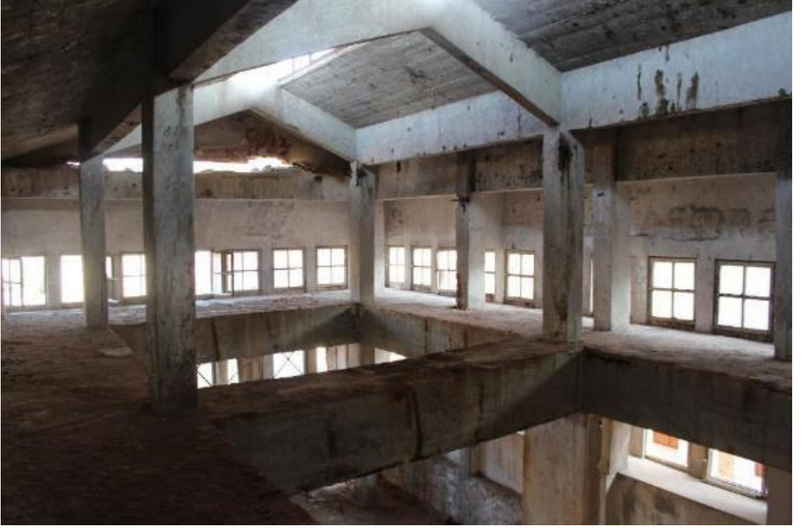
Fotoğraf 145: Ayvalık Cömertler Sabunhanesi Sabun Kazanlarının Döşemedeki Yerleri (M. Çiftyürek)
