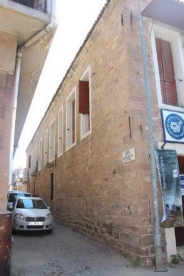
Fotoğraf 106: Ayvalık Sabuncugil Sabunhanesi Kuzey Cephe (M. Çiftyürek)
