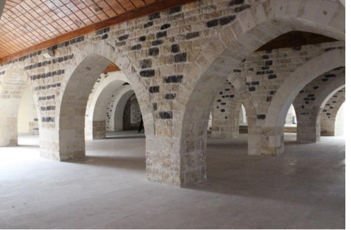
Fotoğraf 771: Kilis Kalaycılar Sabunhanesi Birinci Katı (M. Çiftyürek)
