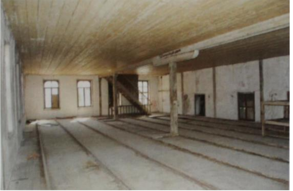
Fotoğraf 840: Ayvalık Sezai Ömer Madra Sabunhanesi Üçüncü Kütle İkinci Kattaki Sabun Kalıpları, 2010 (Bursa KVKBKM Arşivi)
