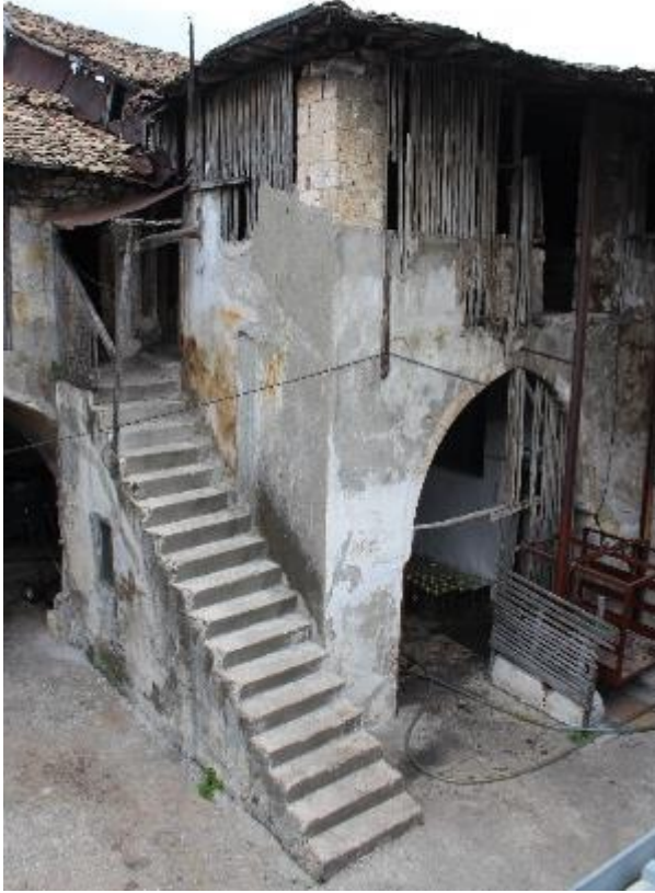
Fotoğraf 447: Antakya Kuseyri Sabunhanesi Avlunun Kuzeybatı Köşesi (M. Çiftyürek)
