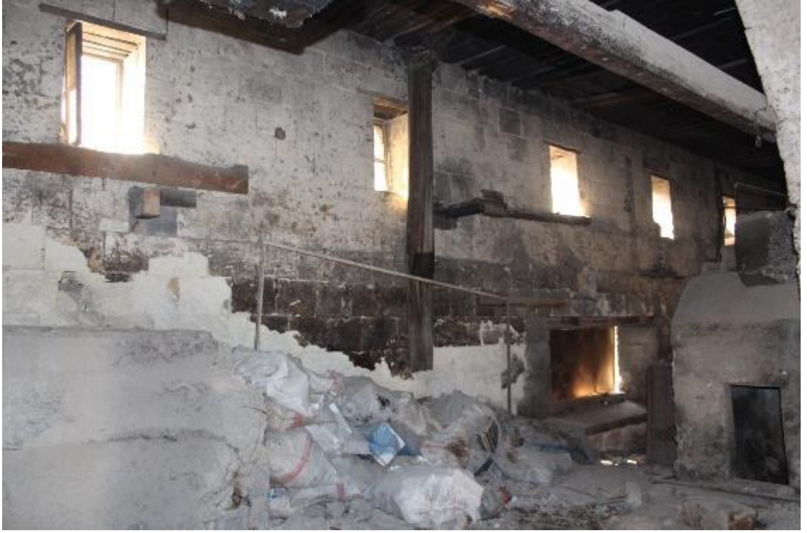
Fotoğraf 718: Nizip Okanlar Sabunhanesi Doğu Bölümün Güney Duvarı (M.Çiftyürek)
