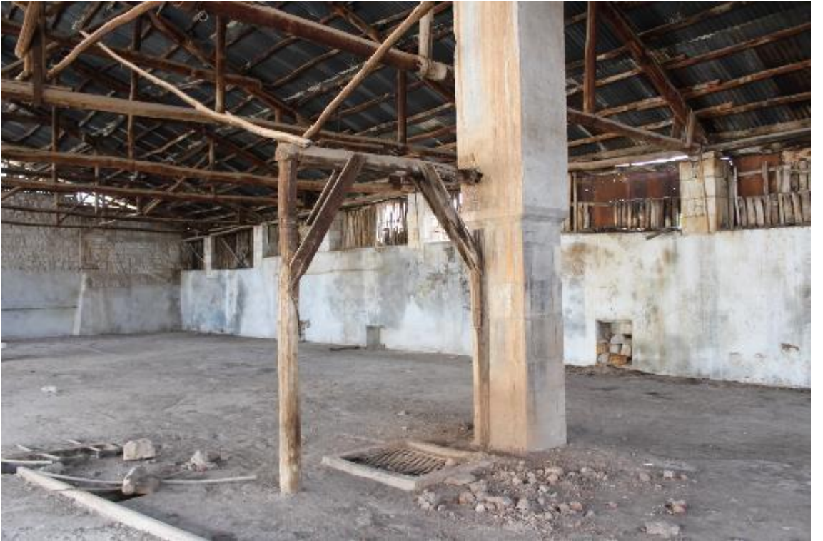
Fotoğraf 657: Kilis Muharrem Bey Sabunhanesi Birinci Kattaki Baca ve Zemindeki Kare Boşluk (M. Çiftyürek)
