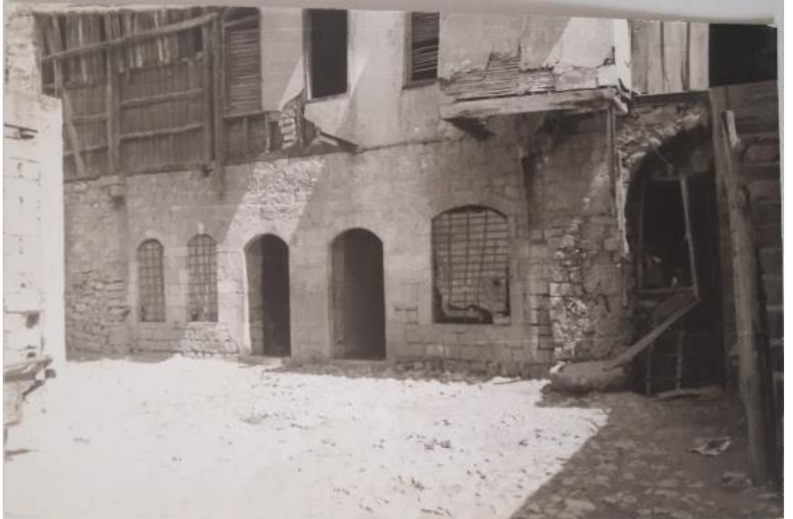
Fotoğraf 813: Kahramanmaraş Cumhuriyet Hanı Sabunhanesi Batı Kütlenin Güney Cephesi, 1986 (Gaziantep KVKBKM Arşivi)
