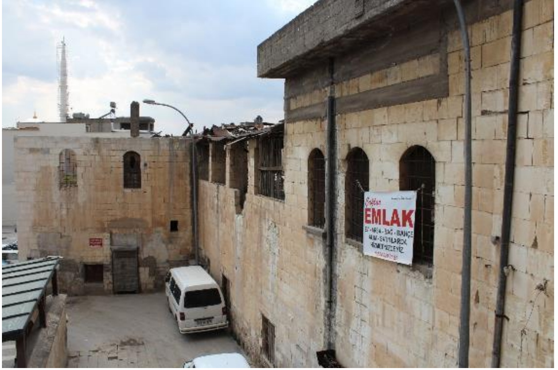
Fotoğraf 622: Nizip Sayınlar Sabunhanesi Güney Cephe (M. Çiftyürek)
