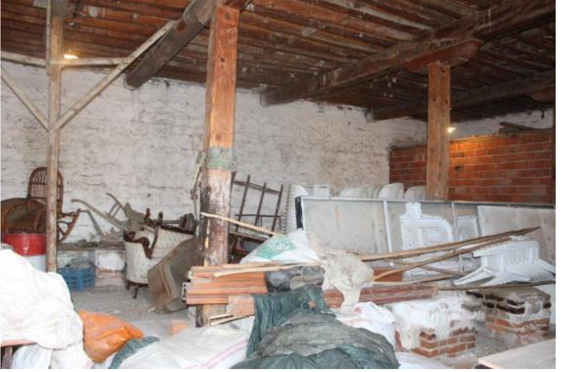
Fotoğraf 173: Havran Eminzade Sabunhanesi Batı Kütlenin Zemin Katı (M.Çiftyürek)
