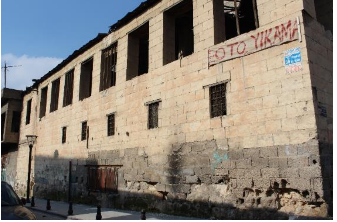
Fotoğraf 728: Nizip Okanlar Sabunhanesi Güney Cephe (M.Çiftyürek)
