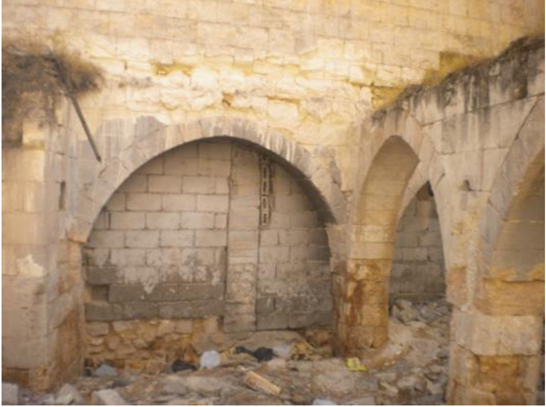
Fotoğraf 740: Nizip Özkaya Sabunhanesi Zemin Kattaki Kemerli Bölümler (Gaziantep KVKBKM Arşivi)
