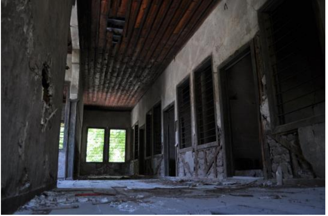
Fotoğraf 806: Kahramanmaraş Cumhuriyet Hanı Sabunhanesi Batı Kütle İkinci Kattaki Sofa ve Odalar, 2011 (Kahramanmaraş Belediyesi Arşivi)
