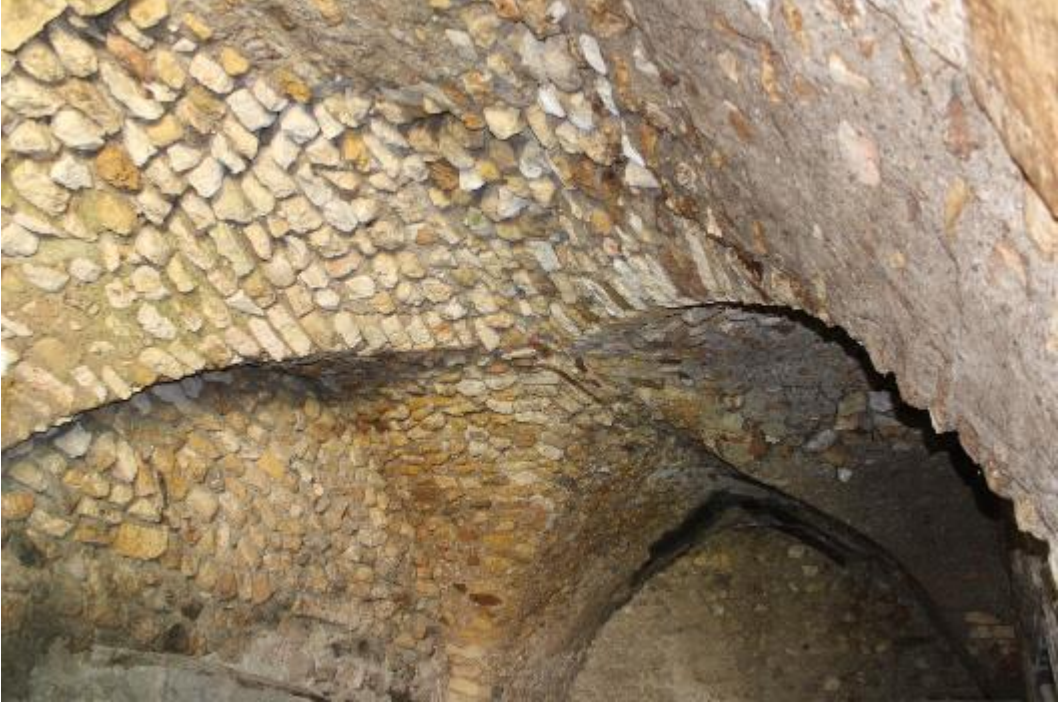
Fotoğraf 353: Antakya Aselciođlu Sabunhanesi Batı Bölümdeki Mekânların apraz Tonozu (M. iftiyrek
