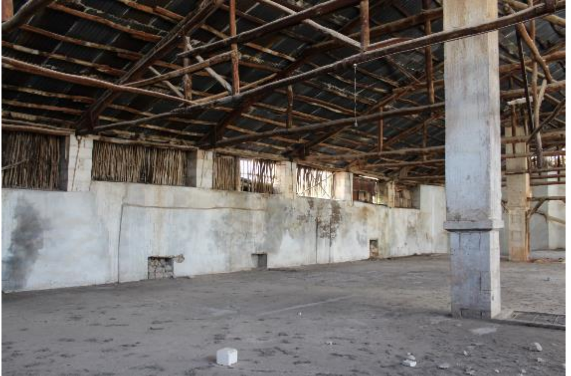
Fotoğraf 659: Kilis Muharrem Bey Sabunhanesi Birinci Katın Doğu Duvarı (M. Çiftyürek)
