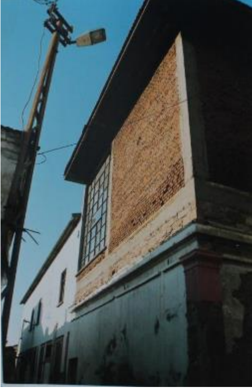
Fotoğraf 81: Ayvalık Hüsnü Rıfki Kazaz Sabunhanesi Restorasyon Öncesi Güney Cephe (Ayvalık Belediyesi Arşivi)
