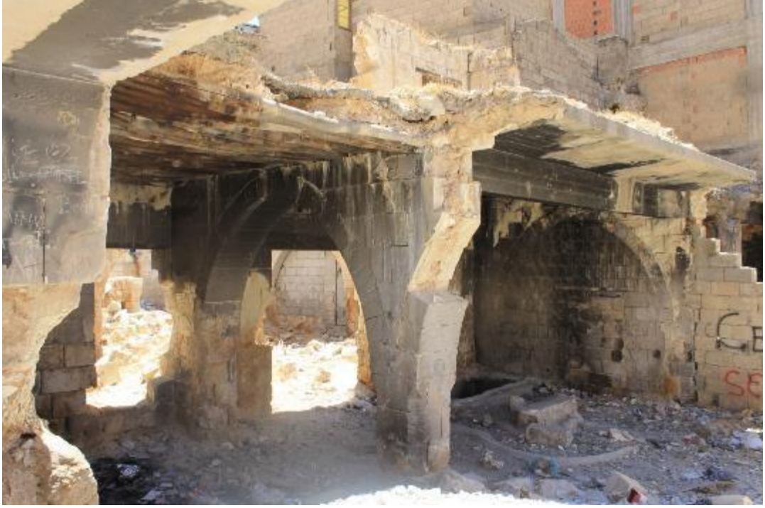
Fotoğraf 738: Nizip Özkaya Sabunhanesi Zemin Kattaki Kemerli Bölümler (Gaziantep KVKBKM Arşivi)
