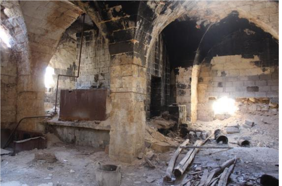
Fotoğraf 597: Nizip Sayınlar Sabunhanesi Kuzeybatı Köşedeki Sabun Kazanı (M. Çiftyürek)
