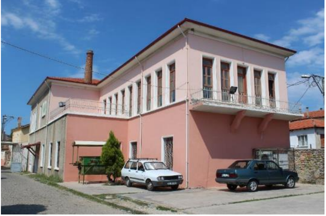
Fotoğraf 219: Burhaniye Hüsnü Pazarbaşı Sabunhanesi Avluya Bakan Kuzey ve Doğu Cephe (M.Çiftyürek)
