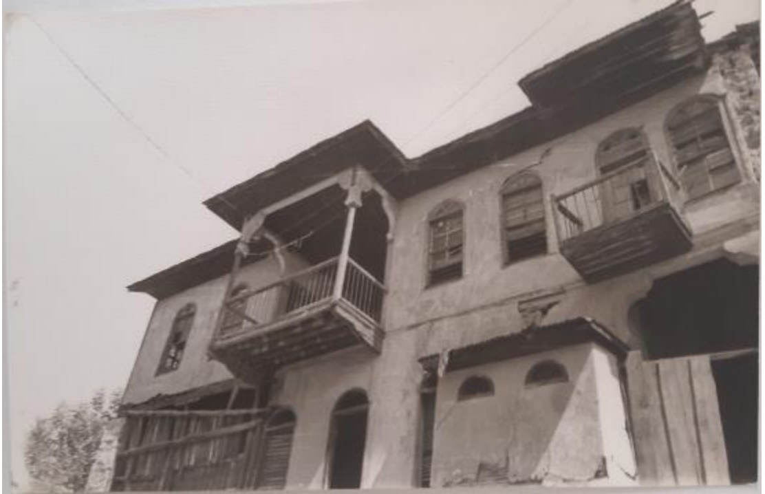
Fotoğraf 815: Kahramanmaraş Cumhuriyet Hanı Sabunhanesi Batı Kütlenin Güney Cephesi, 1986 (Gaziantep KVKBKM Arşivi)
