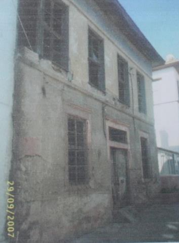
Fotoğraf 134: Ayvalık Fevzi Paşa Mahallesi Sabunhanesi Güneydoğu Cephe, 2007 (Bursa KVKBKM Arşivi)
