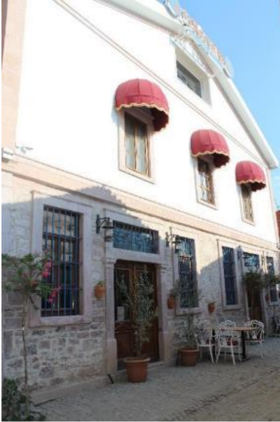
Fotoğraf 86: Ayvalık Hüsnü Rıfkı Kazaz Sabunhanesi Restorasyon Sonrası Batı Cephe (M. Çiftyürek)
