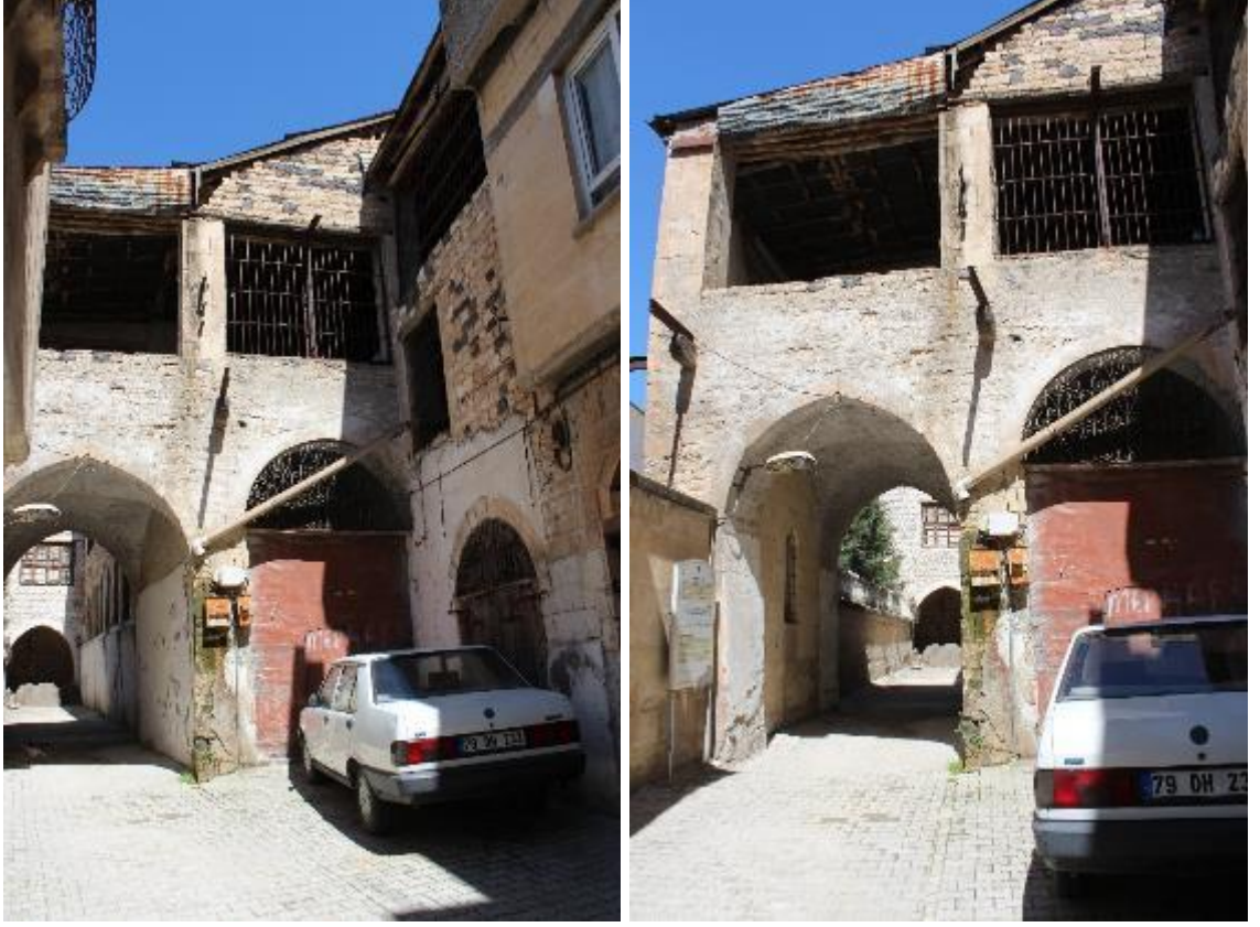
Fotoğraf 628: Kilis Muharrem Bey Sabunhanesi Güneybatı Cephe ve Güneybatıdaki Kabaltı (M. Çiftyürek)
