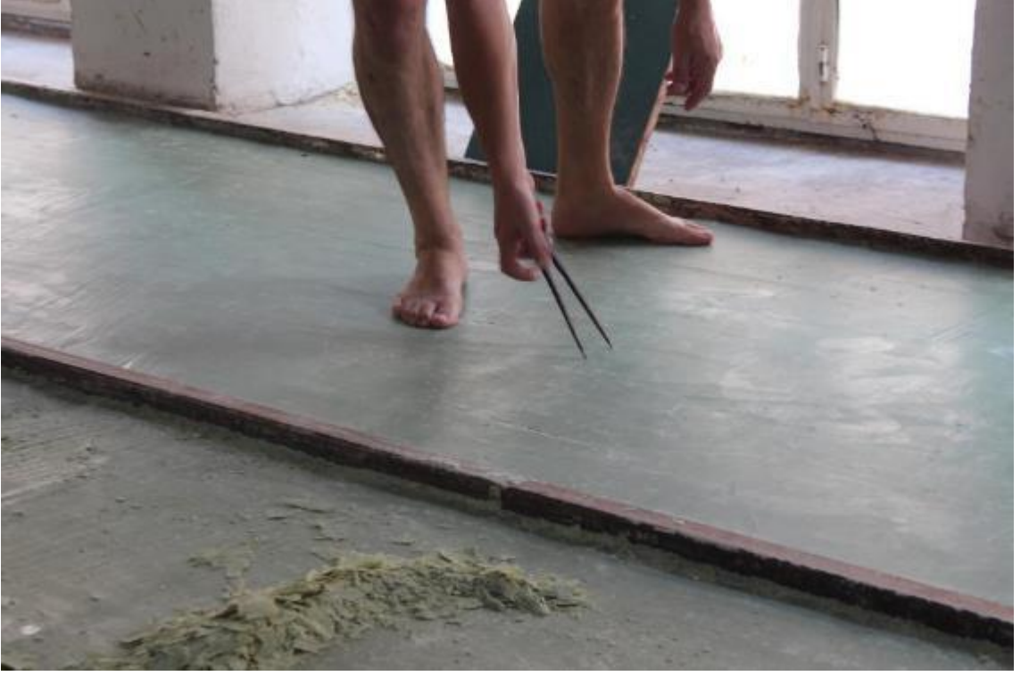
Fotoğraf 41: Pergel Atma İşlemi (Ayvalık Karşınlar Sabunhanesi)
