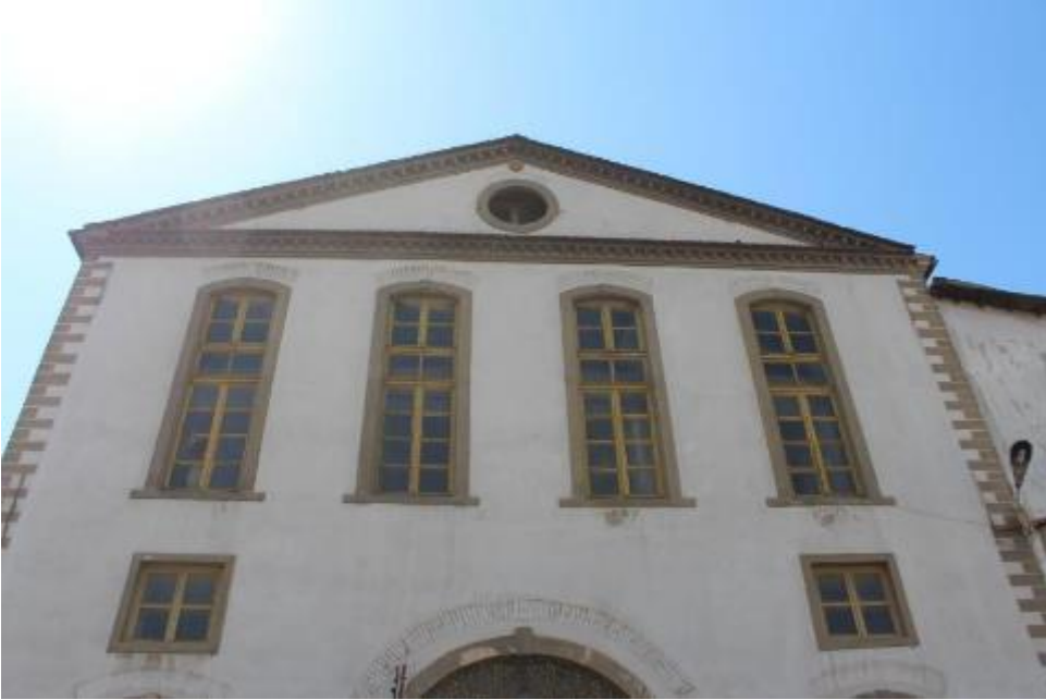
Fotoğraf 300: Konak Sabunhanesi Kuzey Cephe (M. Çiftyürek)
