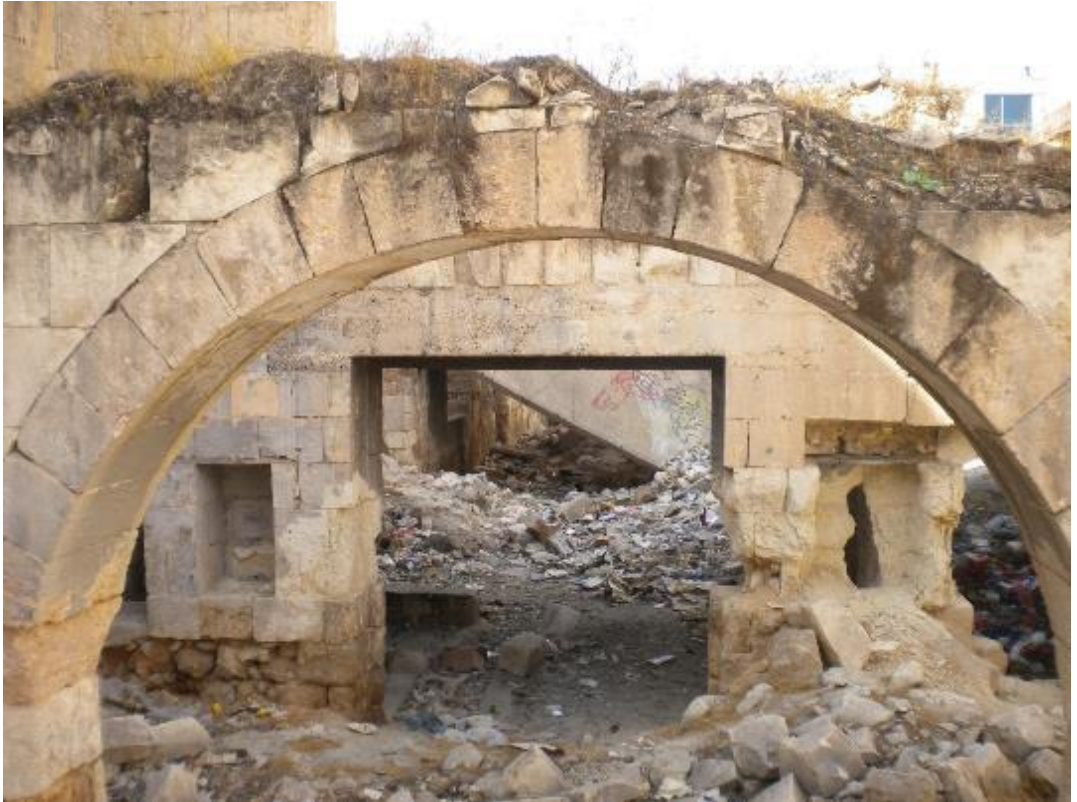
Fotoğraf 739: Nizip Özkaya Sabunhanesi Zemin Kattaki Kemerli Bölümler (Gaziantep KVKBKM Arşivi)
