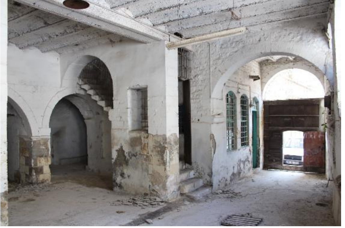
Fotoğraf 632: Kilis Muharrem Bey Sabunhanesi Zemin Katı ve İdari Oda (M. Çiftyürek)
