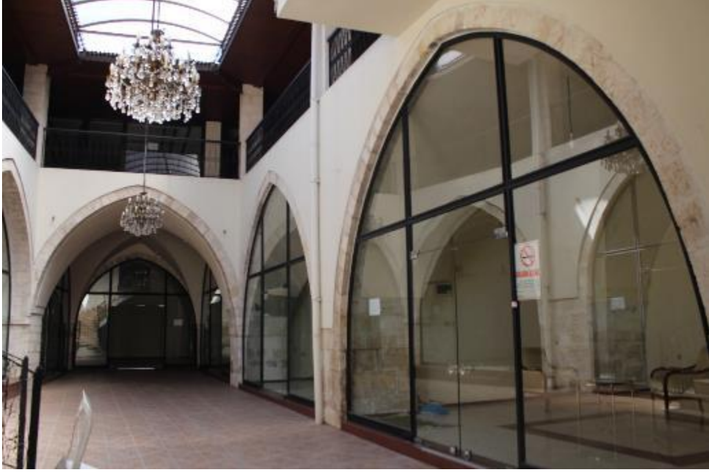
Fotoğraf 470: Antakya Müftüoğlu Sabunhanesi Avluya Bakan Güney Cephe (M. Çiftyürek)
