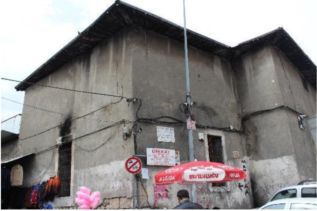
Fotoğraf 454: Antakya Kuseyri Sabunhanesi Kuzey Cephe (M. Çiftyürek)
