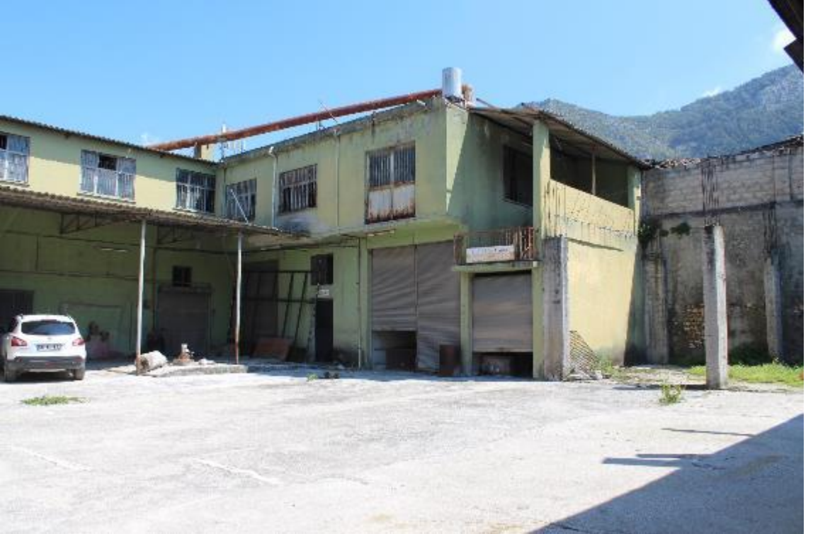
Fotoğraf 386: Antakya Hasan Ökten Sabunhanesi Avluya Bakan Doğu Cephe (M. Çiftyürek)
