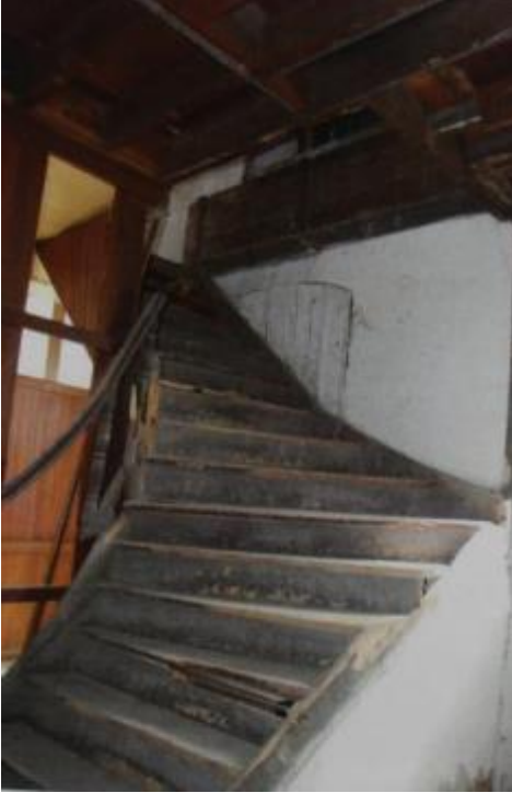
Fotoğraf 835: Ayvalık Sezai Ömer Madra Sabunhanesi Üçüncü Kütlenin Ahşap Merdiveni, 2010 (Bursa KVKBKM Arşivi)
