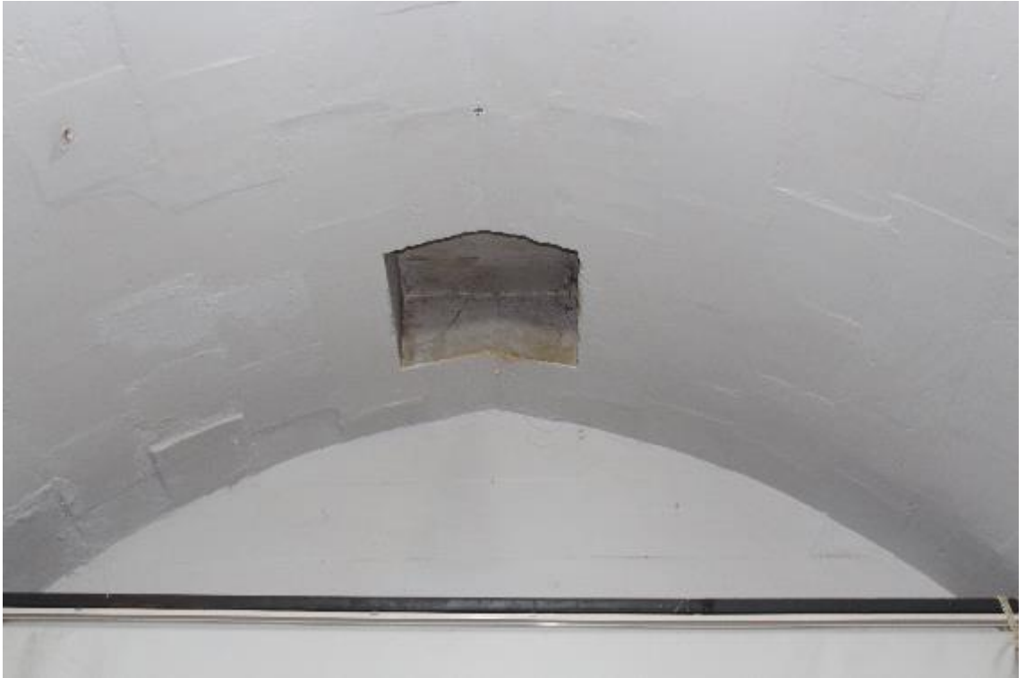
Fotoğraf 683: Nizip Fındıklar Sabunhanesi Çapraz Tonoz Yüzeyindeki Kare Boşluk (M. Çiftyürek)
