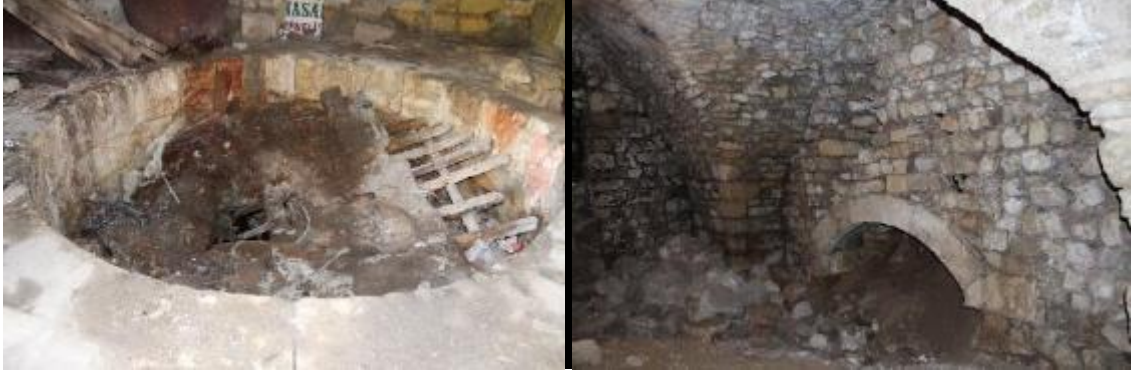
Fotoğraf 21: Ateşleme Sistemi ile Çalışan Taş Kazan ve Ocaklık (Antakya Aselcioğlu ve Kuseyri Sabunhanesi)
