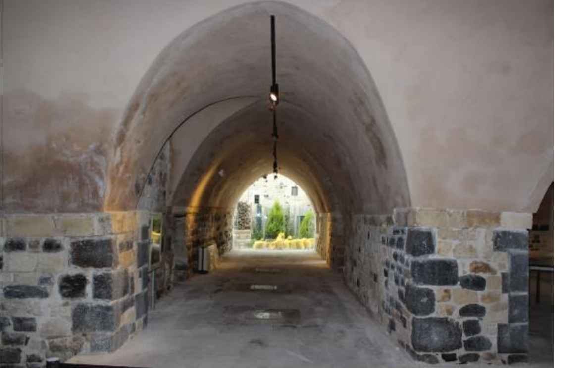
Fotoğraf 765: Kilis Kalaycılar Sabunhanesi Zeytinyağı Kuyularının Bulunduğu Mekân (M. Çiftyürek)
