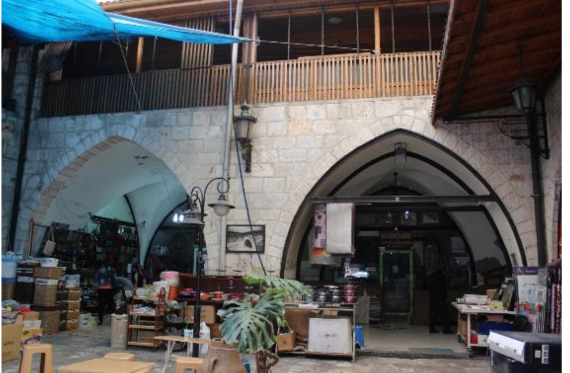
Fotoğraf 328: Antakya Haytoğlu Sabunhanesi Avluya Bakan Güneybatı Cephe (M. Çiftyürek)
