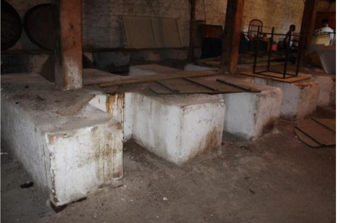
Fotoğraf 174: Havran Eminzade Sabunhanesi Batı Kütlenin Zemin Katındaki Tuğla Setler (M.Çiftyürek)
