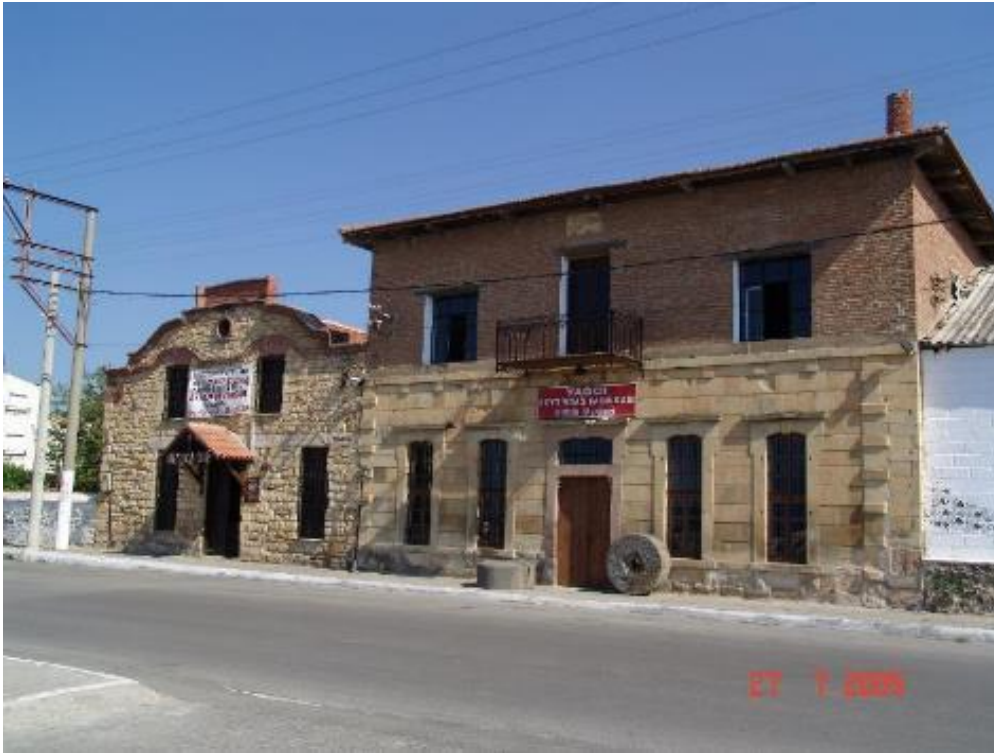
Fotoğraf 108: Burhaniye Yağcı Sabunhanesi ve Yağhanesi Kuzey Cephe, 2005 (Balıkesir KVKBKM Arşivi)
