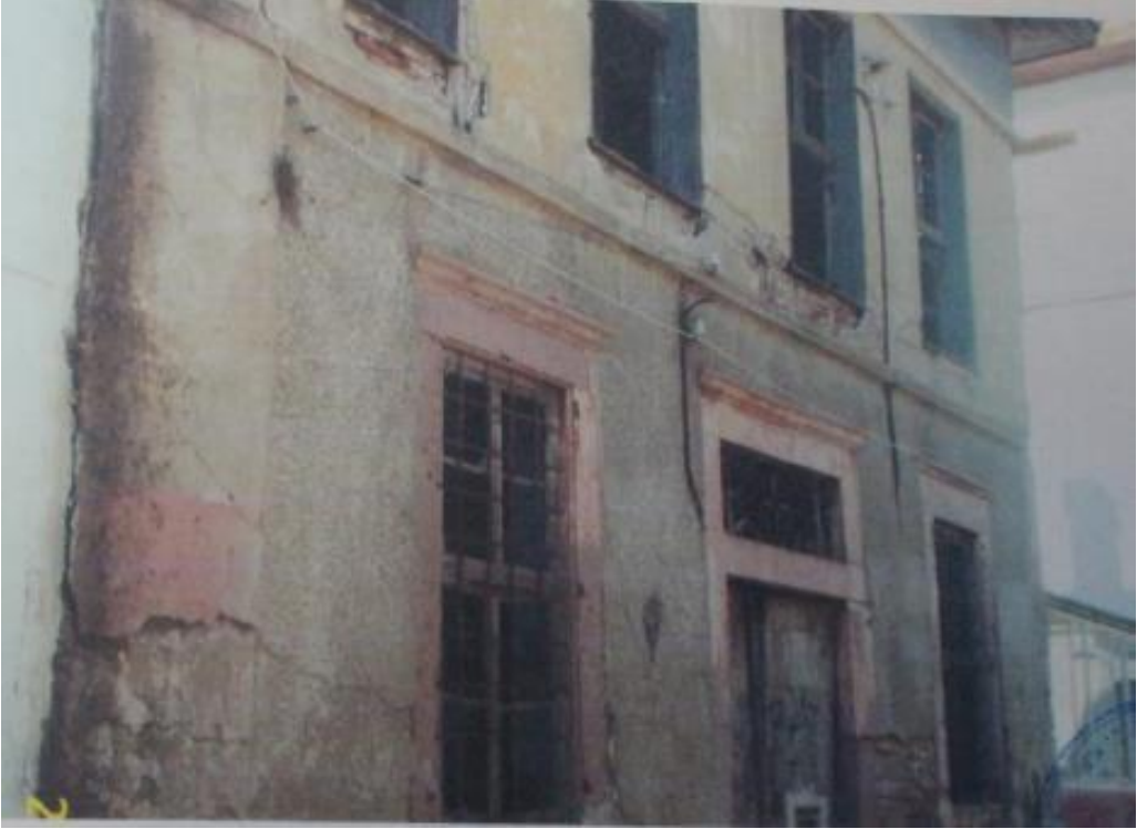
Fotoğraf 140: Ayvalık Fevzi Paşa Mahallesi Sabunhanesi Güneydoğu Cephe, 2007 (Bursa KVKBKM Arşivi)
