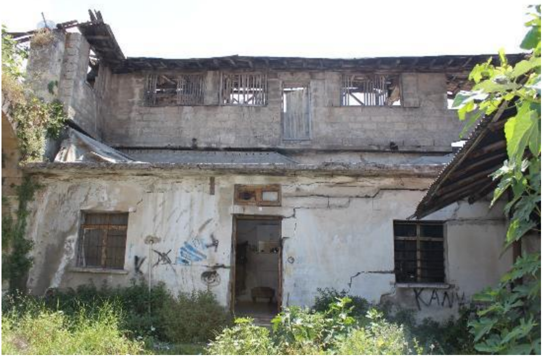
Fotoğraf 357: Antakya Aselcioğlu Sabunhanesi Avluya Bakan Güney Cephe (M. Çiftyürek)
