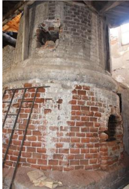
Fotoğraf 160: Ayvalık Ertemler Sabunhanesi Sabun Kazanı Ocağı ve Tuğla Baca (M. Çiftyürek)
