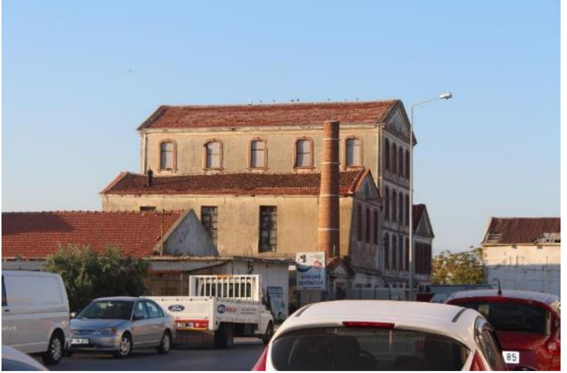
Fotoğraf 848: Ayvalık Sezai Ömer Madra Sabunhanesi Batı ve Güney Cephe (M. Çiftyürek)
