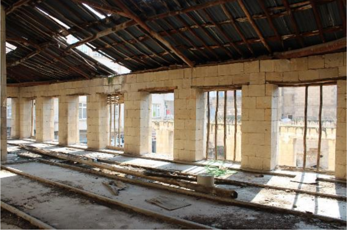
Fotoğraf 726: Nizip Okanlar Sabunhanesi Doğu Bölüm Birinci Katın Güney Duvarı (M.Çiftyürek)
