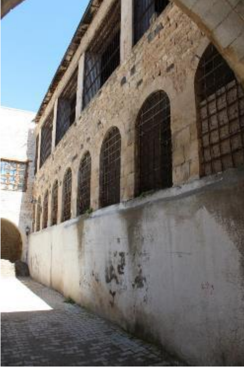
Fotoğraf 662: Kilis Muharrem Bey Sabunhanesi Batı Cephe (M. Çiftyürek)
