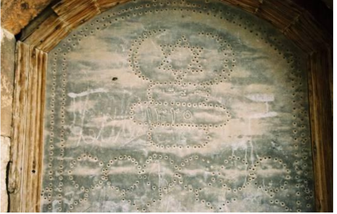
Fotoğraf 674: Nizip Fındıklar Sabunhanesi Avlu Geçidine Açılan Merdivenin Kapısı (H. Eker, agt, L. CLXI)
