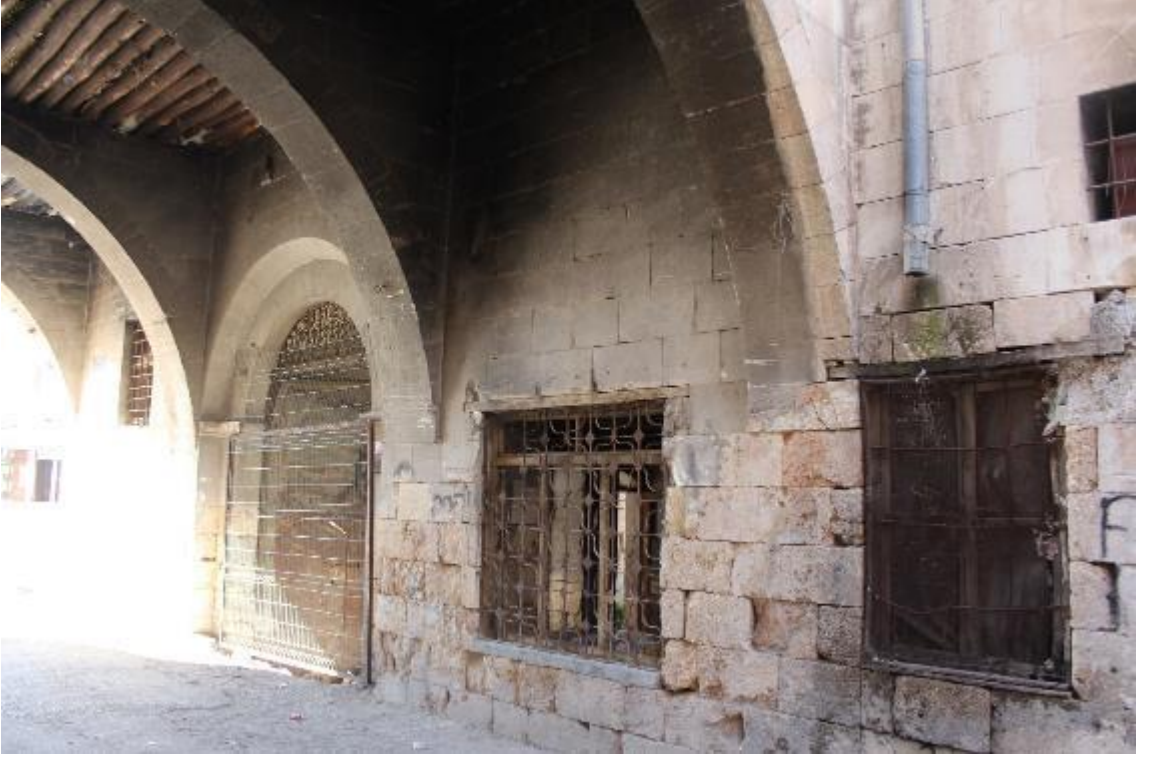
Fotoğraf 588: Nizip Sayınlar Sabunhanesi Kabaltı (M. Çiftiyürek)
