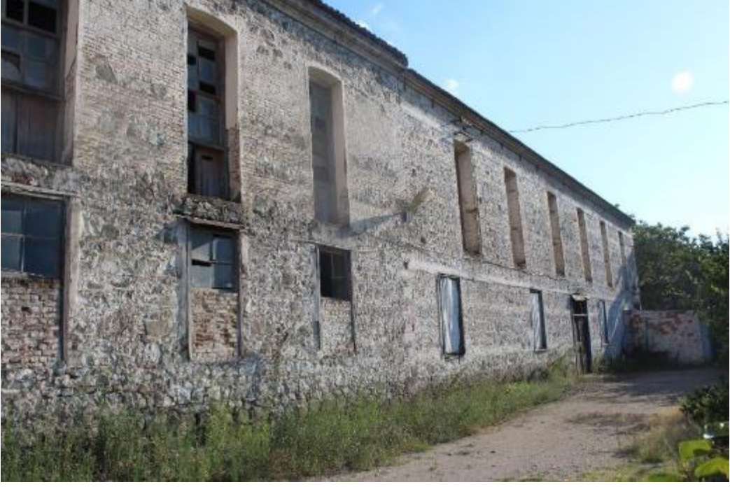
Fotoğraf 177: Havran Eminzade Sabunhanesi Doğu ve Batı Kütlenin Kuzey Cephesi (M.Çiftyürek)
