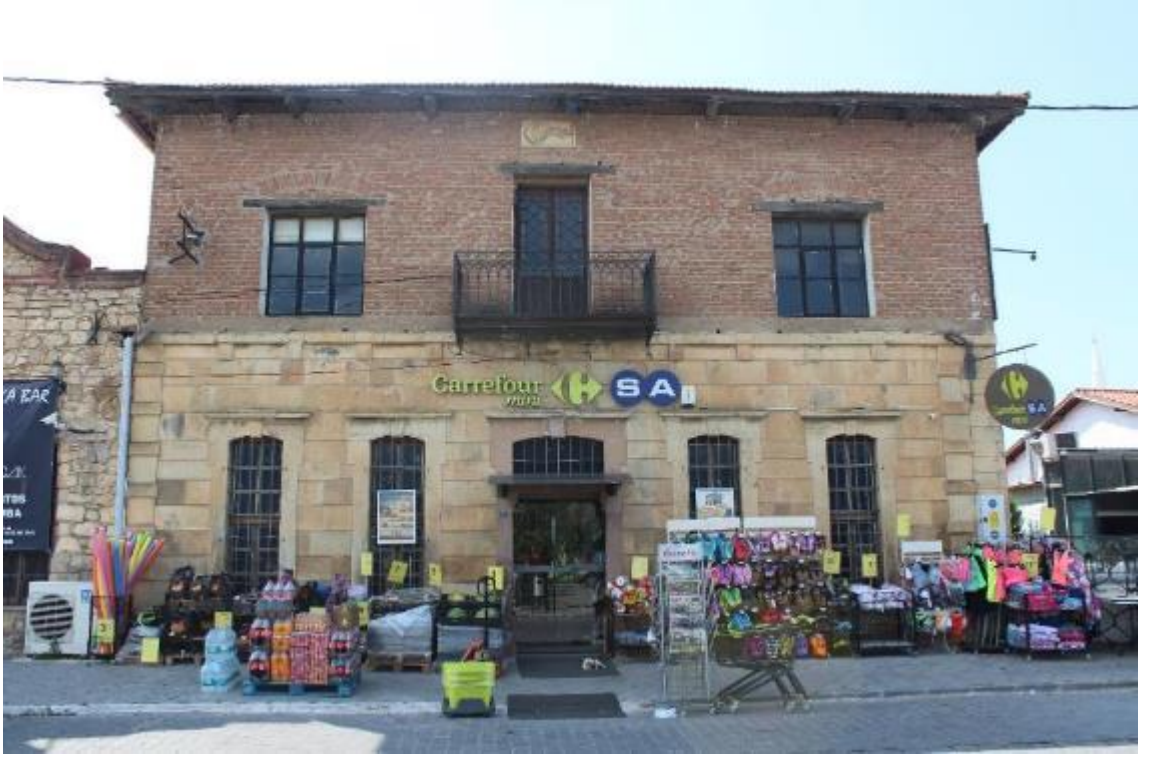
Fotoğraf 113: Burhaniye Yađcı Sabunhanesi Kuzey Cephe (M.Çiftyürek)
