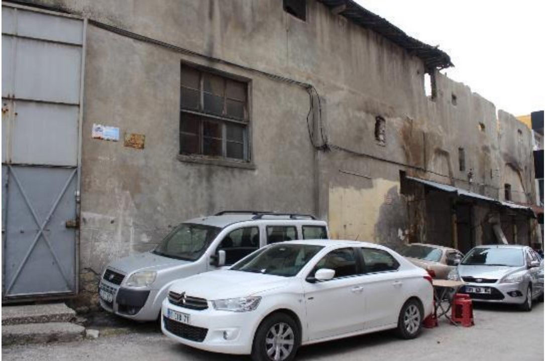
Fotoğraf 453: Antakya Kuseyri Sabunhanesi Kuzey Cephe (M. Çiftyürek)
