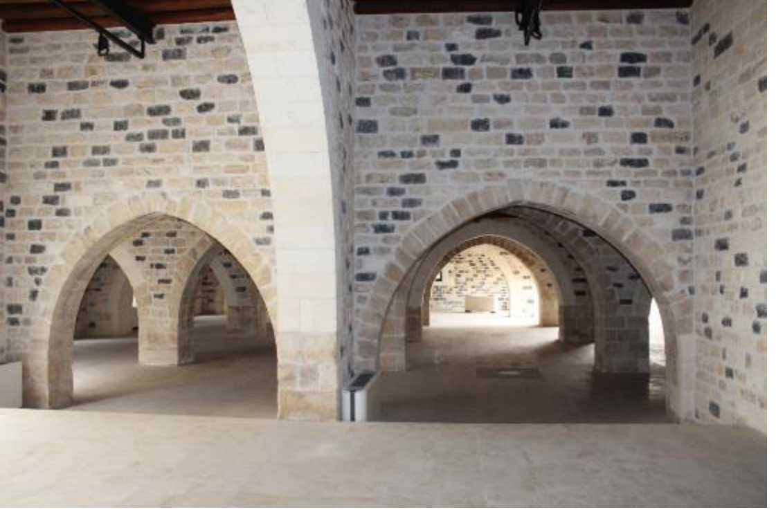
Fotoğraf 770: Kilis Kalaycılar Sabunhanesi Birinci Katı (M. Çiftyürek)
