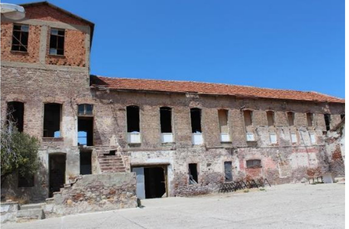
Fotoğraf 120: Ayvalık Fazıl Doğan Sabunhanesi Güneydoğu Cephe (M. Çiftiyürek)
