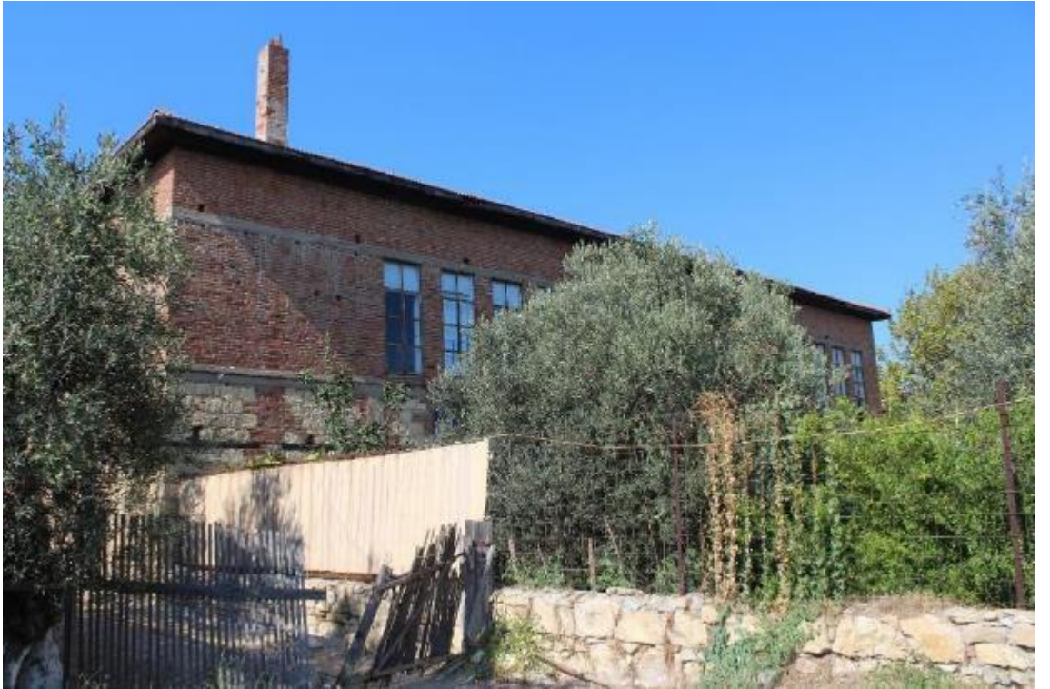
Fotoğraf 274: Ayvacık Küçükkuşu Burnaz Sabunhanesi Güney Cephe (M. Çiftyürek)
