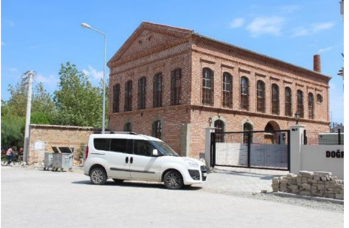
Fotoğraf 200: Burhaniye Hüsnü Tolun Sabunhanesi Batı ve Güney Cephe (M. Çiftyürek)
