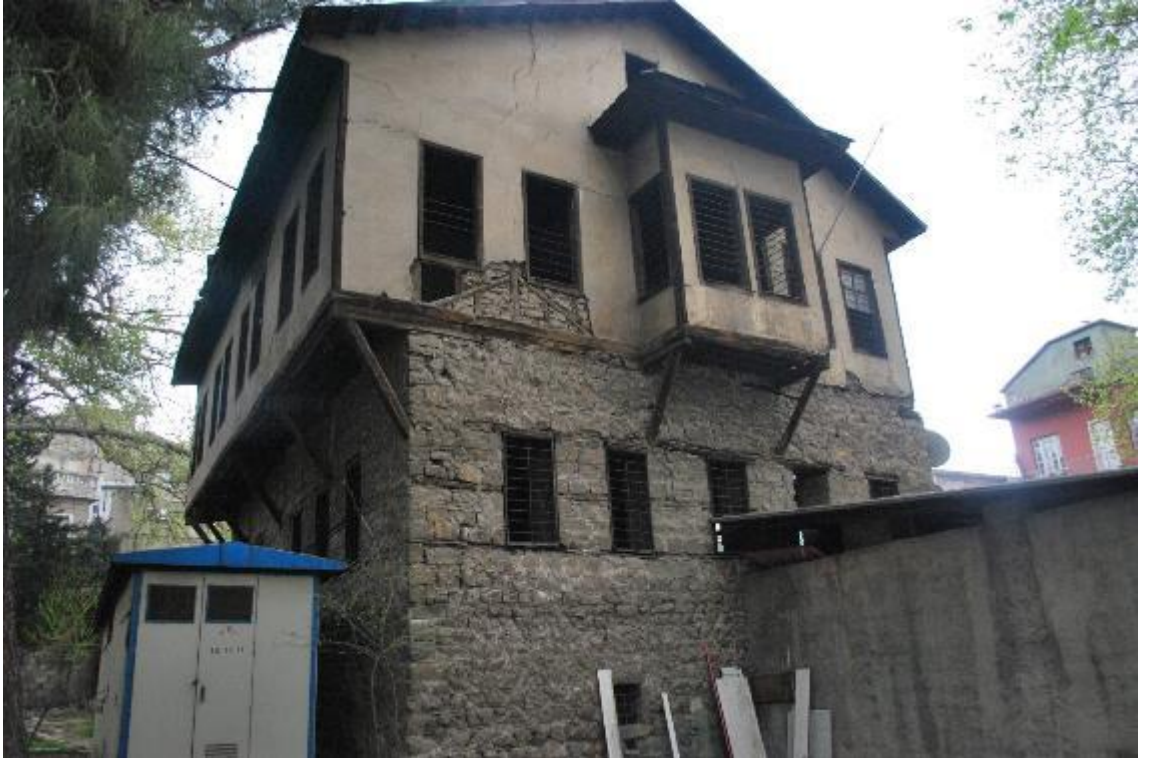
Fotoğraf 819: Kahramanmaraş Cumhuriyet Hanı Sabunhanesi Batı Kütlenin Batı Cephesi, 2010 (Kahramanmaraş Belediyesi Arşivi)
