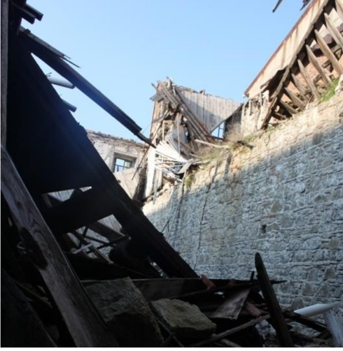
Fotoğraf 281: Konak Hamdi Dalan Sabunhanesi Yağ Deposu, 2015 (Konak Belediyesi Arşivi)
