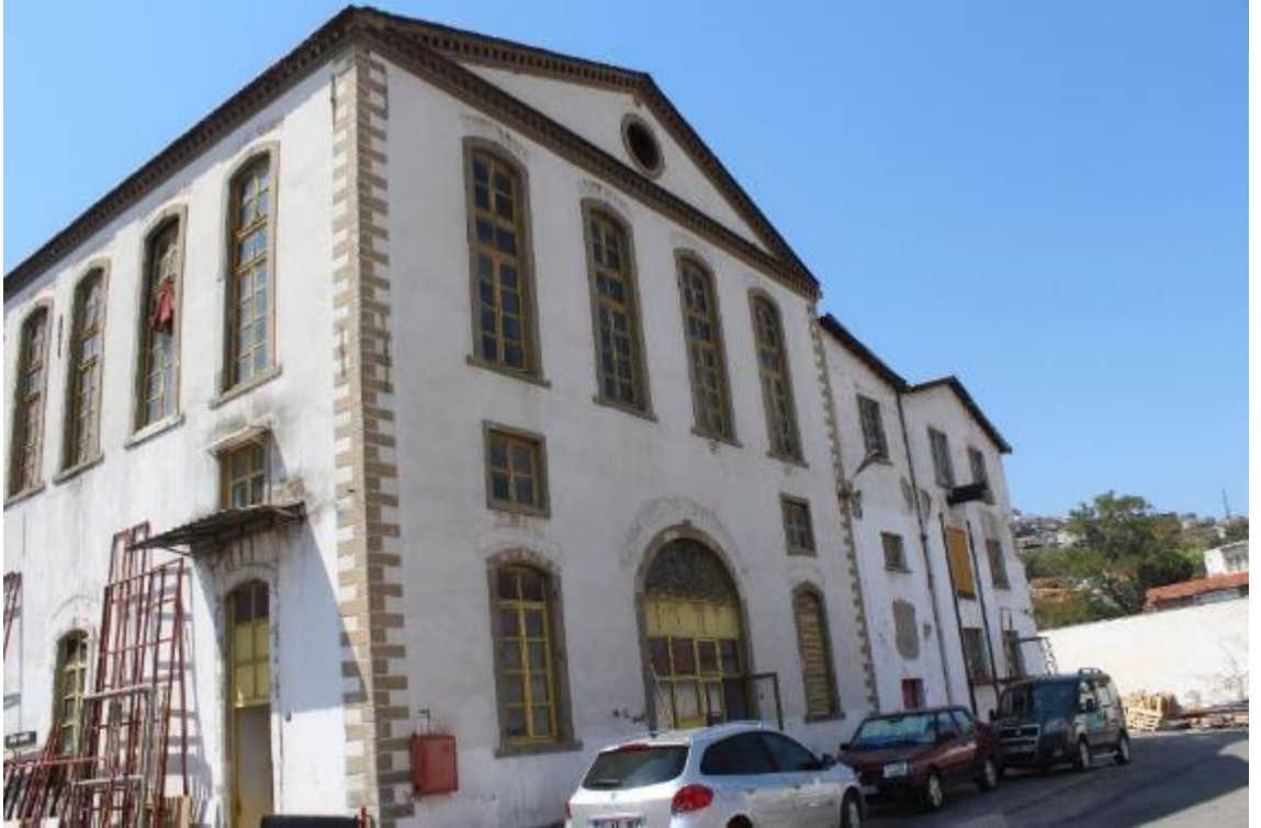
Fotoğraf 298: Konak Sabunhanesi Kuzey Cephe (M. Çiftyürek)
