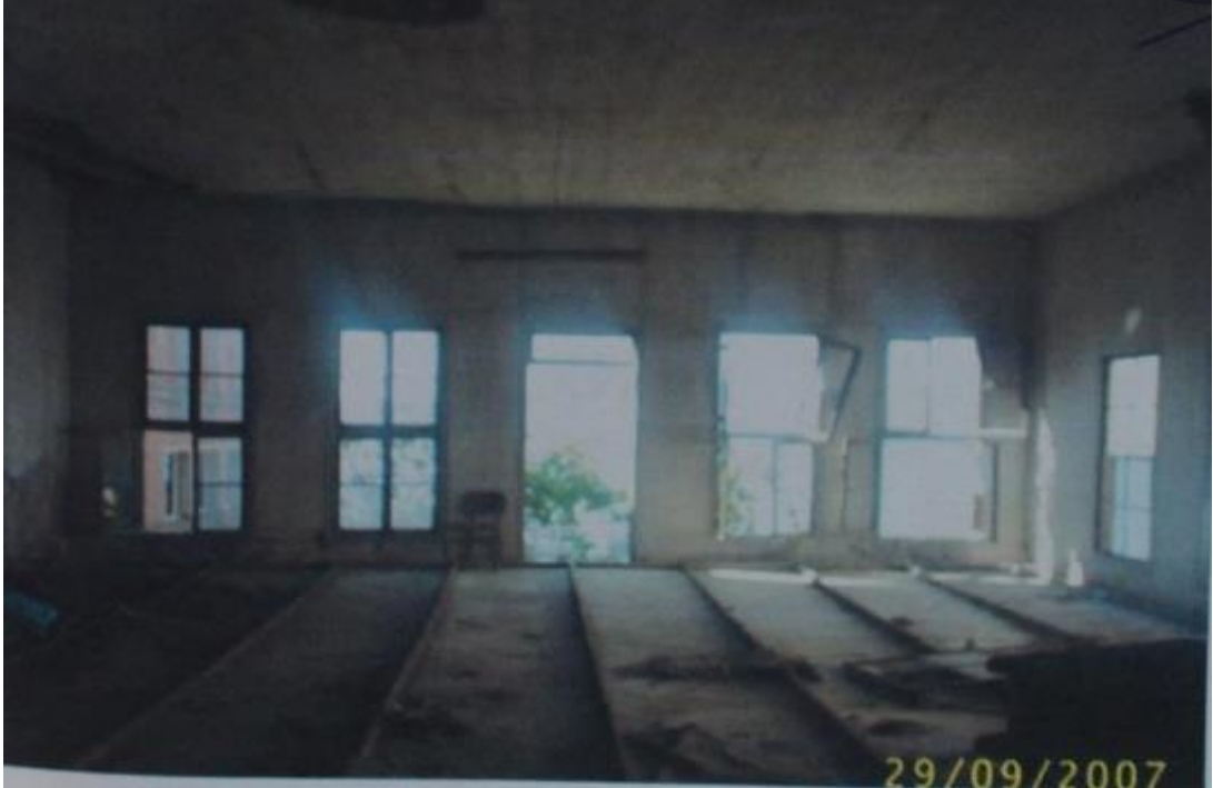
Fotoğraf 138: Ayvalık Fevzi Paşa Mahallesi Sabunhanesi Birinci Kat Kuzeybatı Duvarı ve Sabun Kalıpları, 2007 (Bursa KVKBKM Arşivi)
