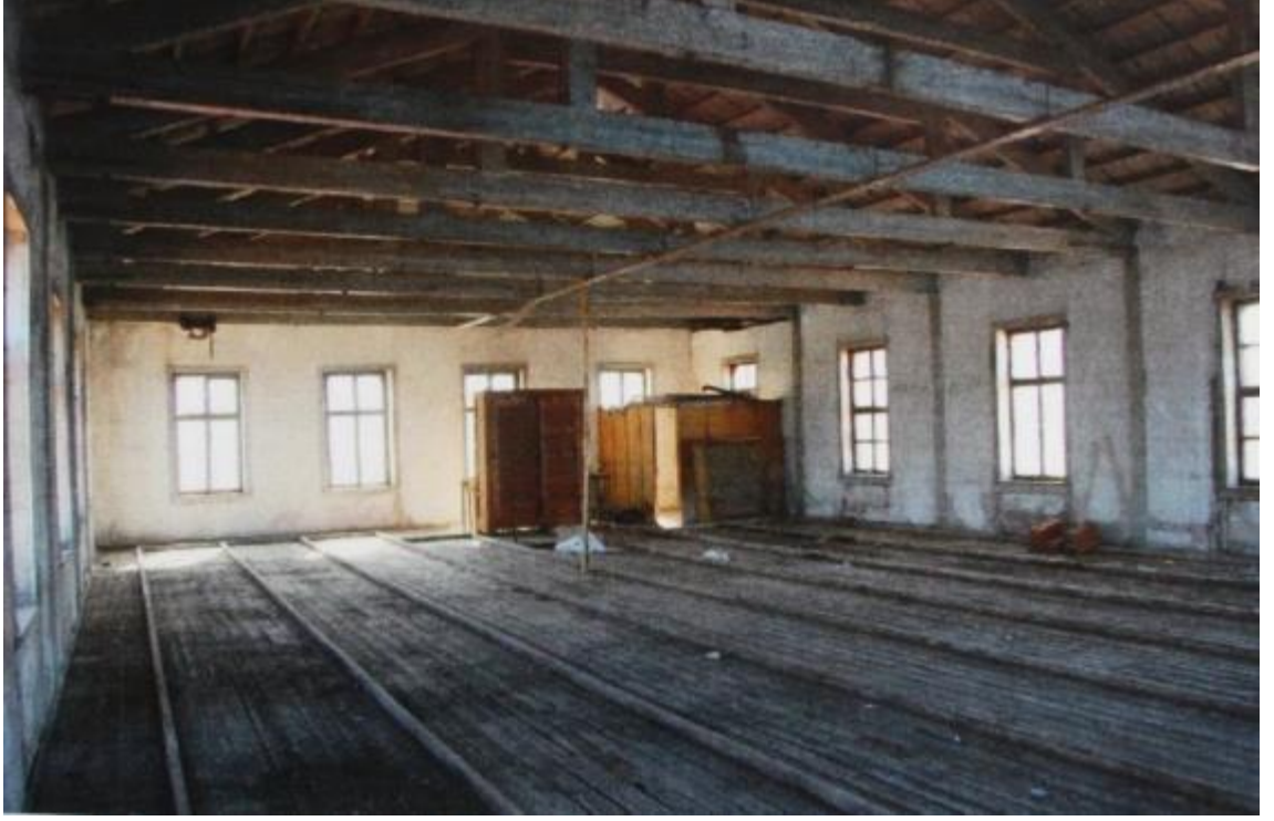
Fotoğraf 844: Ayvalık Sezai Ömer Madra Sabunhanesi Üçüncü Kütle Üçüncü Katın Güney ve Batı Duvarı, 2010 (Bursa KVKBKM Arşivi)
