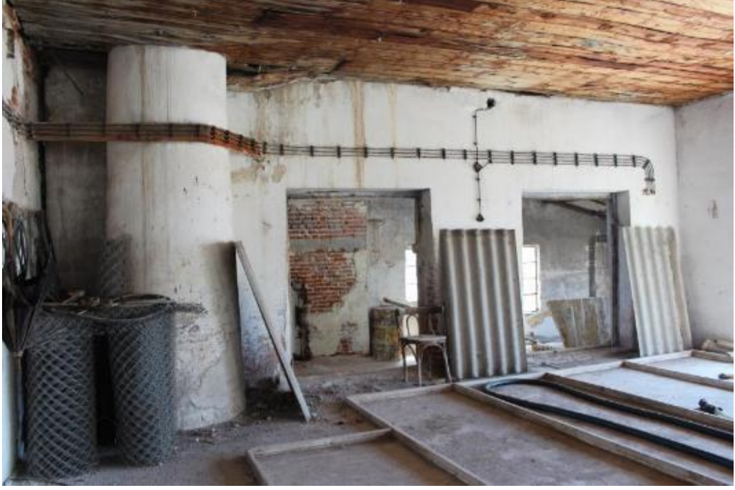
Fotoğraf 261: Burhaniye Pelitköy Halil İbrahim Selçuk Sabunhanesi Birinci Kat Birinci Kısımın Güney Duvarı ve Baca (M. Çiftyürek)
