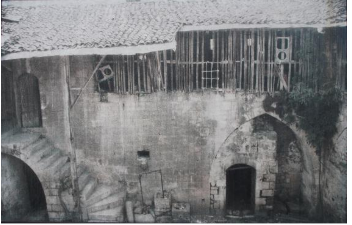
Fotoğraf 327: Antakya Haytoğlu Sabunhanesi Avluya Bakan Güneydoğu Cephe, 2003 (Hatay KVKBKM Arşivi)
