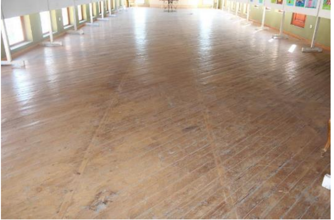
Fotoğraf 230: Burhaniye Hüsnu Pazarbaşı Sabunhanesi Restorasyon Sonrası Kaldırılan Sabun Kalıplarının İzleri (M.Çiftyürek)
