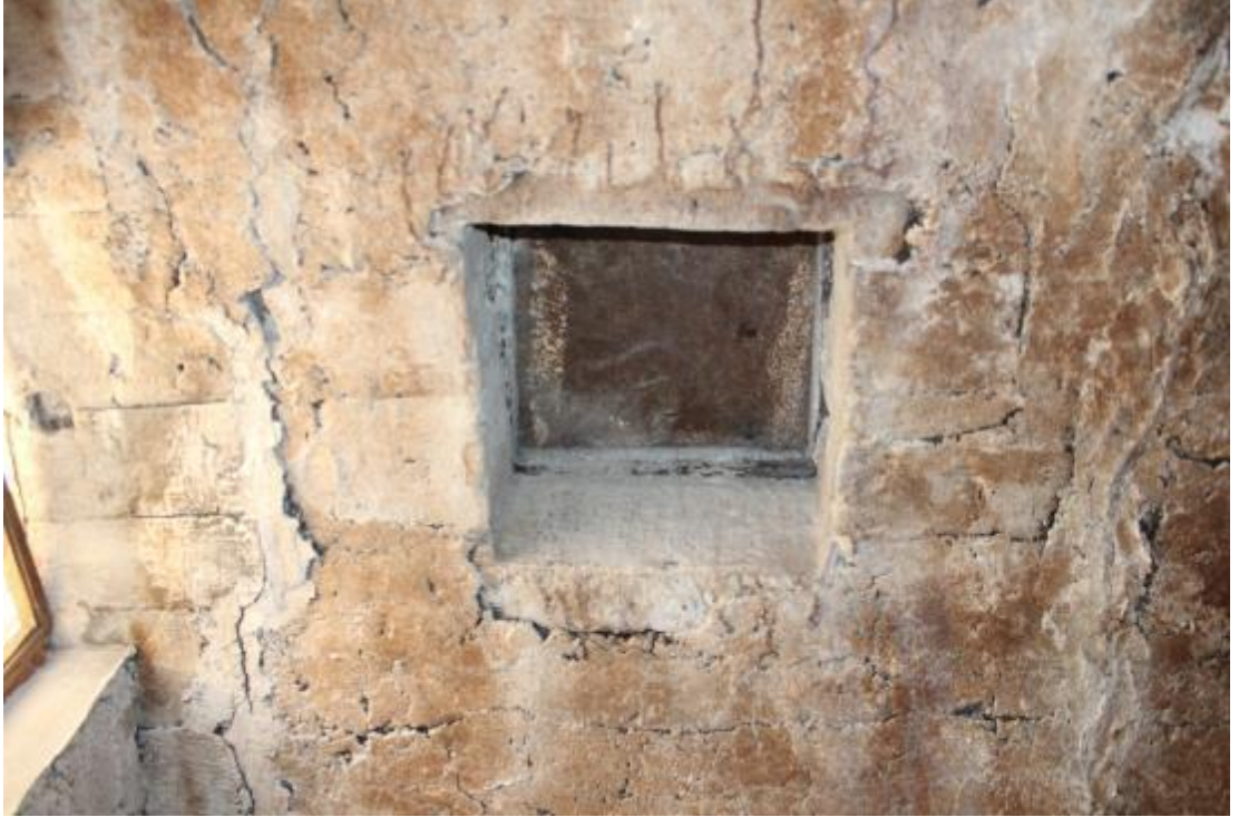
Fotoğraf 421: Antakya Selahattin Ökten Sabunhanesi Çapraz Tonoz Yüzeyindeki Kare Boşluk (M. Çiftyürek)
