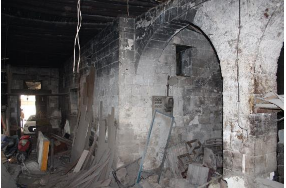
Fotoğraf 711: Nizip Okanlar Sabunhanesi Doğu Bölümün Kuzeybatı Köşesindeki Mekân (M.Çiftyürek)
