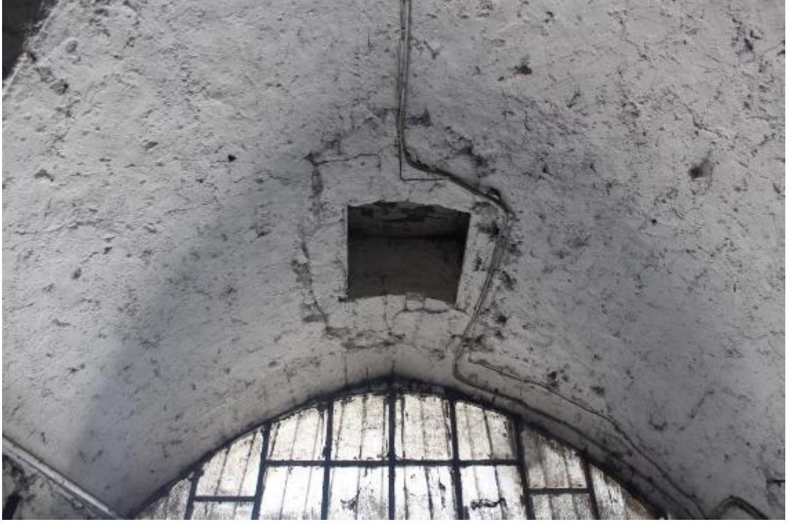
Fotoğraf 383: Antakya Hasan Ökten Sabunhanesi Çapraz Tonoz Yüzeyindeki Kare Boşluk (M. Çiftyürek)
