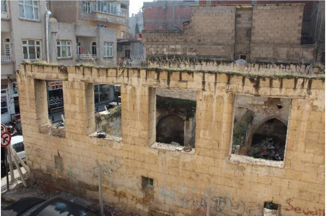
Fotoğraf 747: Nizip Özkaya Sabunhanesi Kuzey Cephe (M. Çiftyürek)
