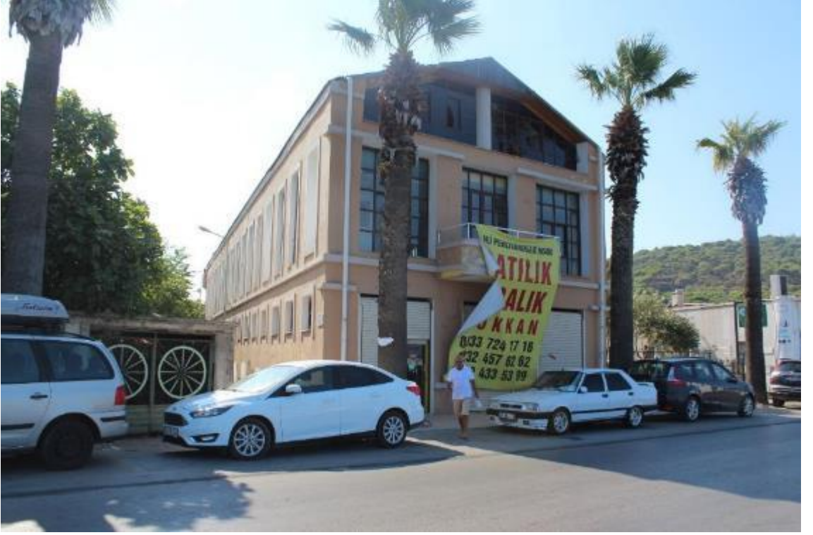
Fotoğraf 93: Ayvalık Erman Sabunhanesi Batı ve Kuzey Cephe (M.Çiftyürek)
