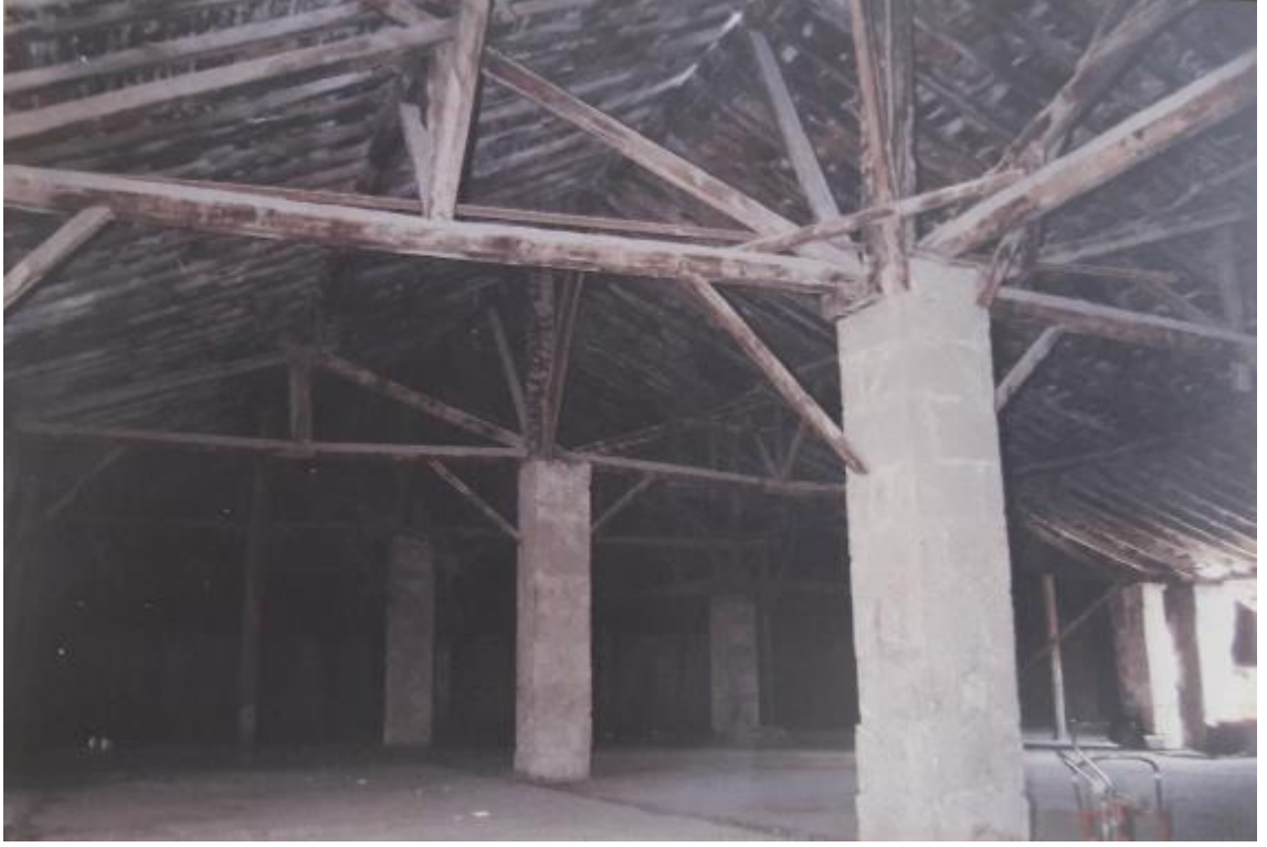
Fotoğraf 474: Antakya Müftüoğlu Sabunhanesi Birinci Katı, 1996 (Hatay KVKBKM Arşivi)
