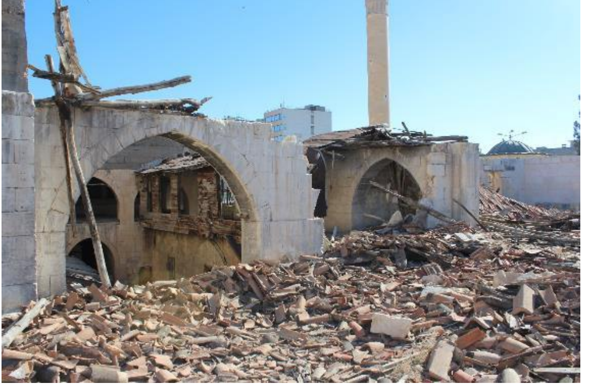
Fotoğraf 620: Nizip Sayınlar Sabunhanesi Batı Bölümün Birinci Katı (M. Çiftyürek)
