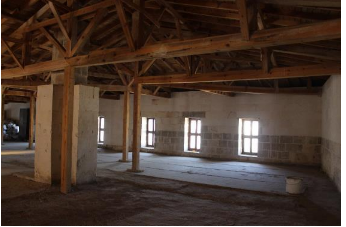
Fotoğraf 523: Gaziantep Elbeyli Sabunhanesi İkinci Kattaki Baca (M. Çiftyürek)
