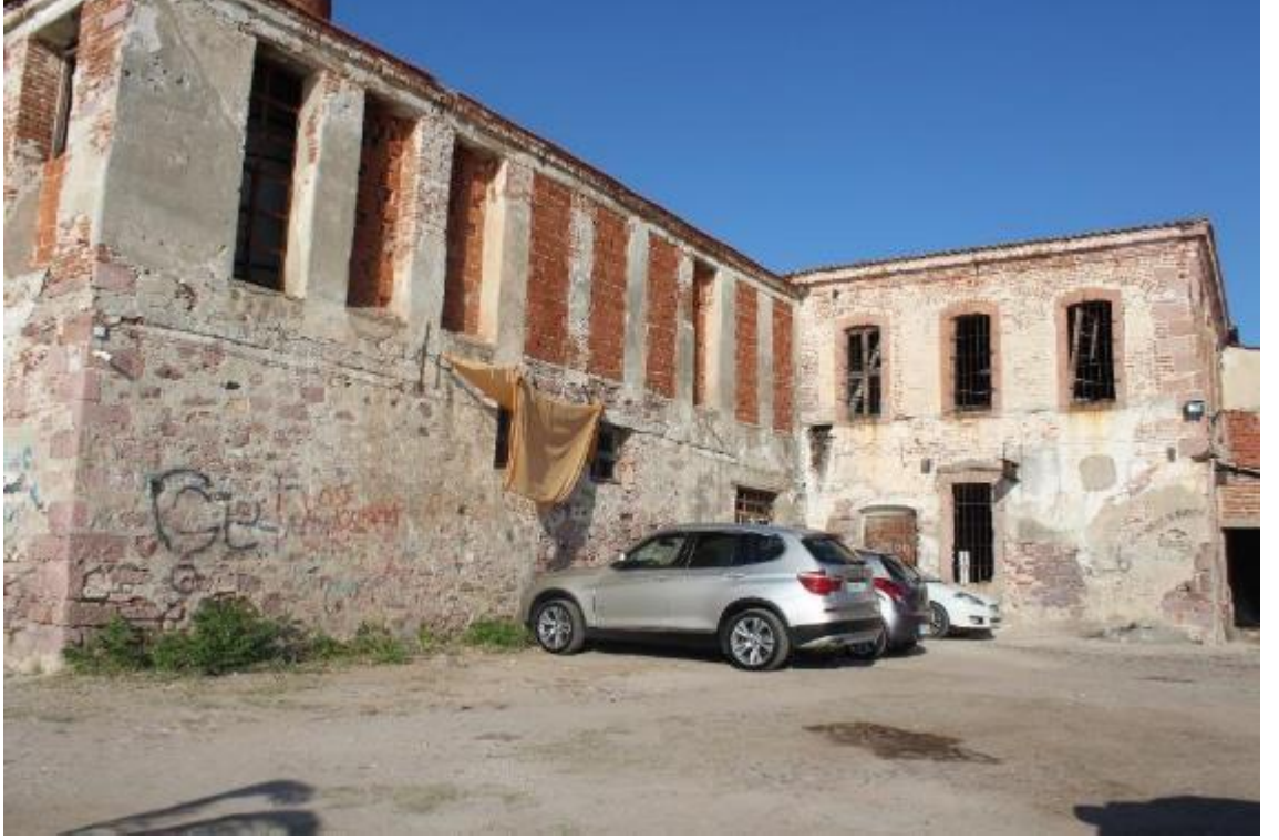
Fotoğraf 151: Ayvalık Ertemler Sabunhanesi Güneybatı Cephe ve Yağhane (M.Çiftyürek)
