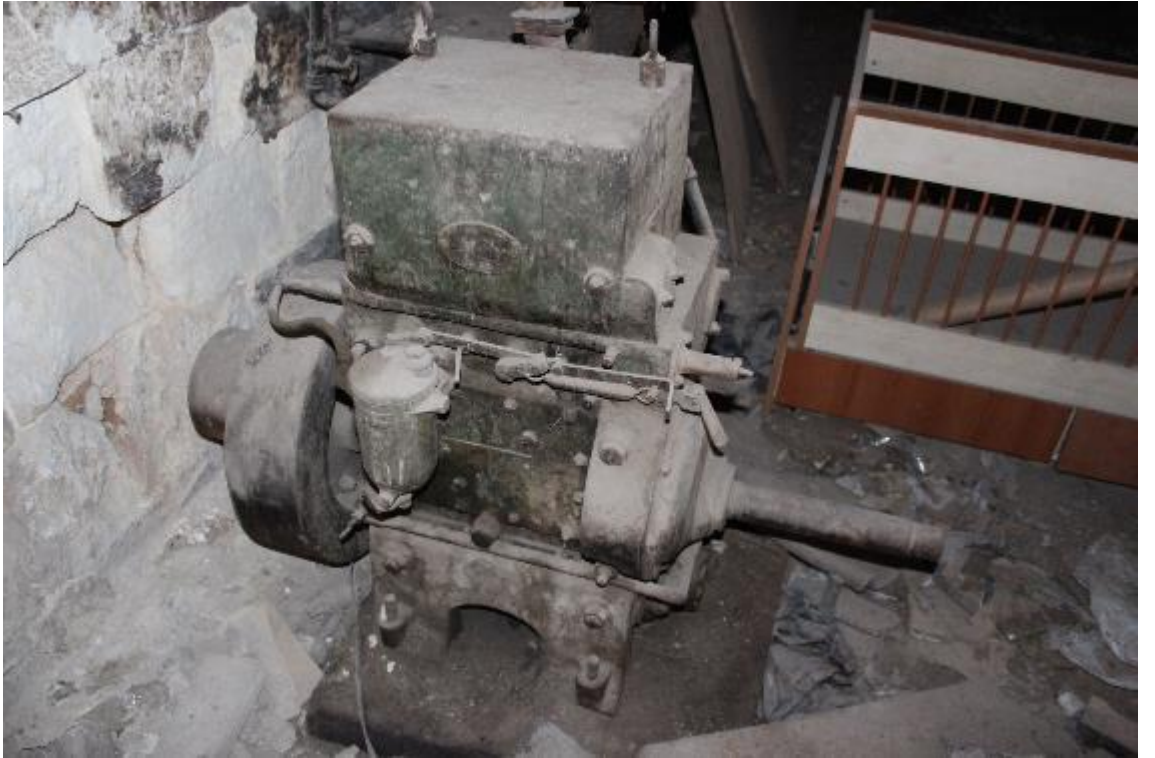
Fotoğraf 709: Nizip Okanlar Sabunhanesi “Ruston&Hornsby” Marka Motor (M.Çiftyürek)
