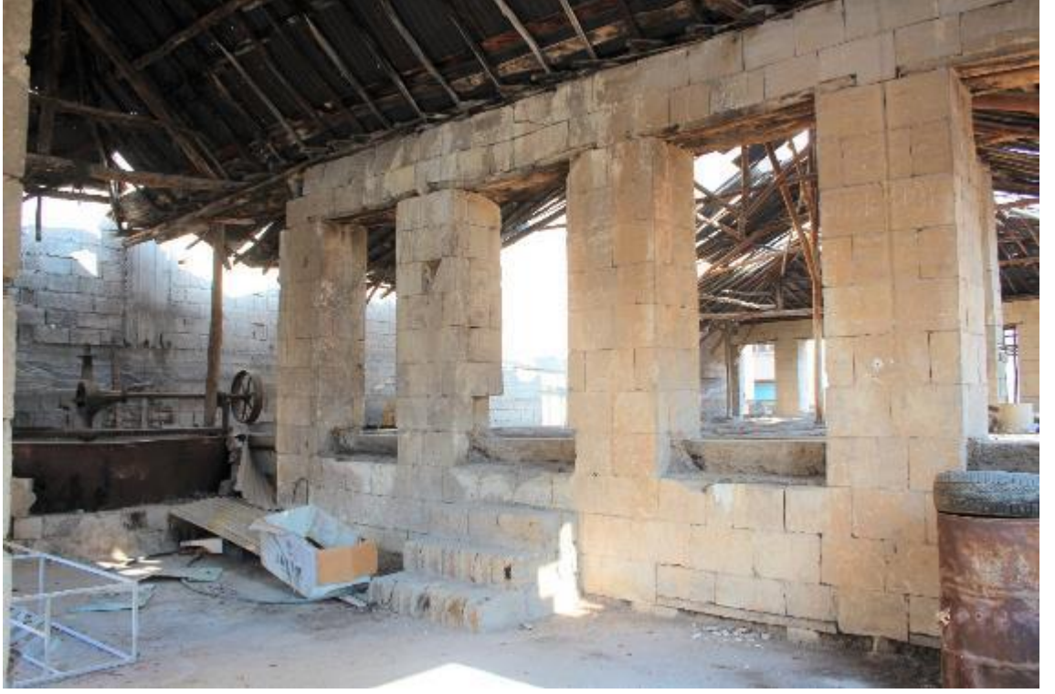
Fotoğraf 720: Nizip Okanlar Sabunhanesi Batı Bölümün Birinci Katı (M.Çiftyürek)
