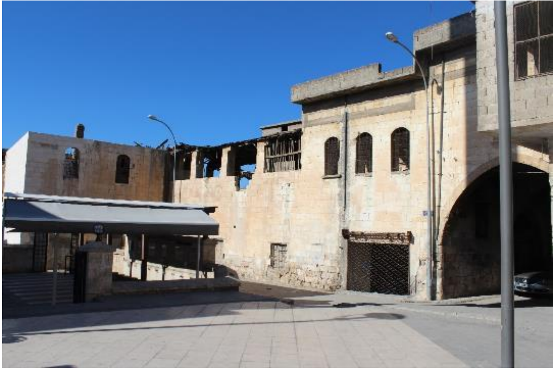
Fotoğraf 583: Nizip Sayınlar Sabunhanesi Güney Cephe (M. Çiftyürek)
