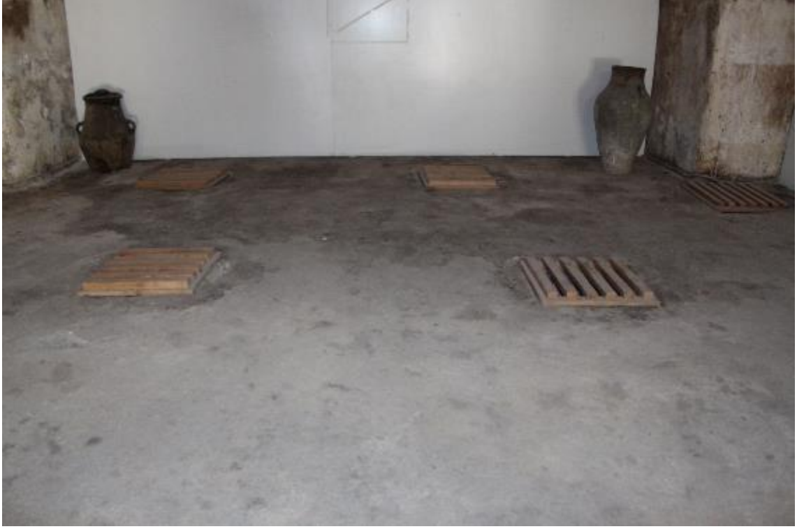
Fotoğraf 424: Antakya Selahattin Ökten Sabunhanesi Zeytinyağı Kuyuları (M. Çiftyürek)
