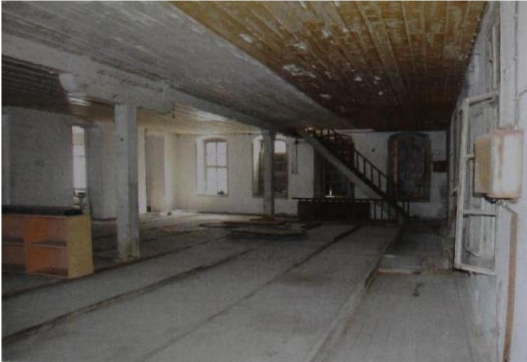
Fotoğraf 839: Ayvalık Sezai Ömer Madra Sabunhanesi Üçüncü Kütle Birinci Katın Güney Duvarı ve Zemindeki Sabun Kalıpları, 2010 (Bursa KVKBKM Arşivi)
