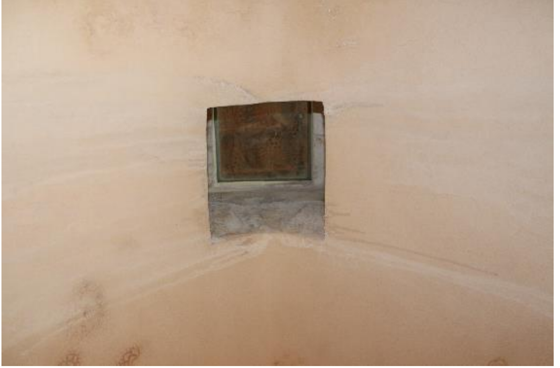
Fotoğraf 762: Kilis Kalaycılar Sabunhanesi Beşik Tonz Yüzeyindeki Kare Boşluk (M. Çiftyürek)
