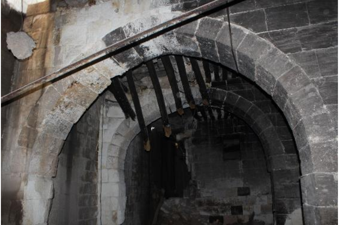
Fotoğraf 713: Nizip Okanlar Sabunhanesi Doğu Bölümün Kuzeybatı Köşesindeki Mekânın Doğu Duvarı (M.Çiftyürek)
