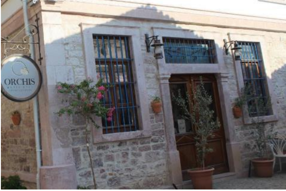
Fotoğraf 87: Ayvalık Hüsnü Rıfkı Kazaz Sabunhanesi Restorasyon Sonrası Kapı ve Pencereler (M. Çiftyürek)
