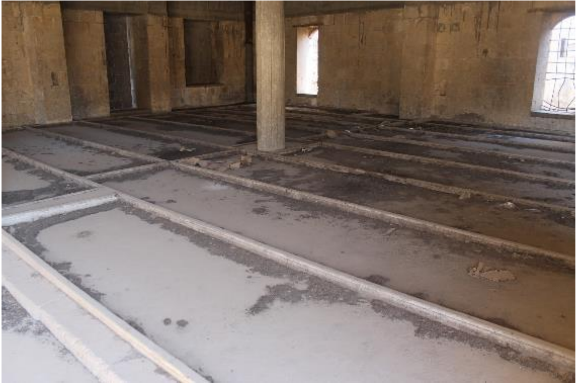
Fotoğraf 613: Nizip Sayınlar Sabunhanesi Doğu Bölümün Birinci Katındaki Sabun Kalıpları (M. Çiftyürek)
