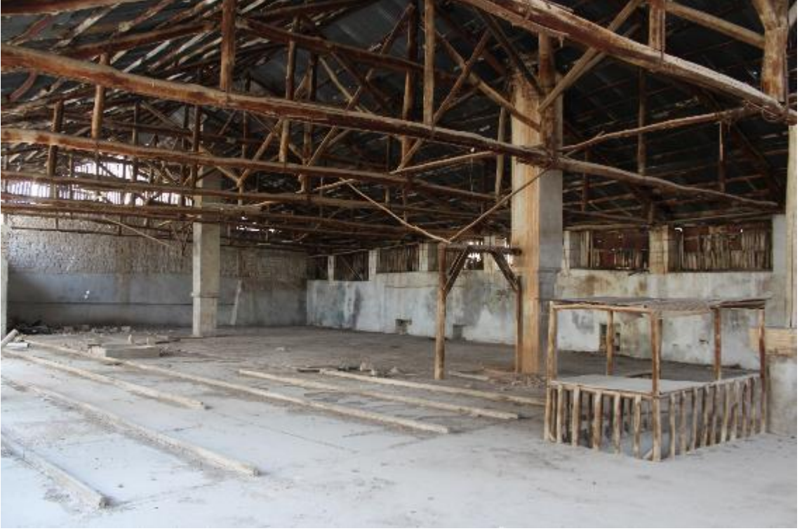
Fotoğraf 656: Kilis Muharrem Bey Sabunhanesi Birinci Katı (M. Çiftyürek)
