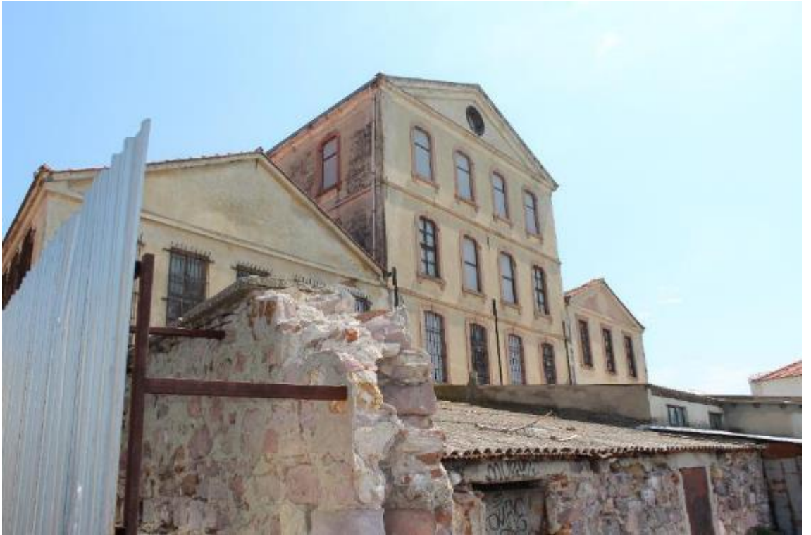
Fotoğraf 847: Ayvalık Sezai Ömer Madra Sabunhanesi Kuzey Cephe (M. Çiftyürek)
