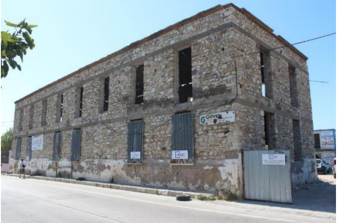
Fotoğraf 310: Urala Sabunhanesi Kuzey Cephe (M. Çiftyürek)
