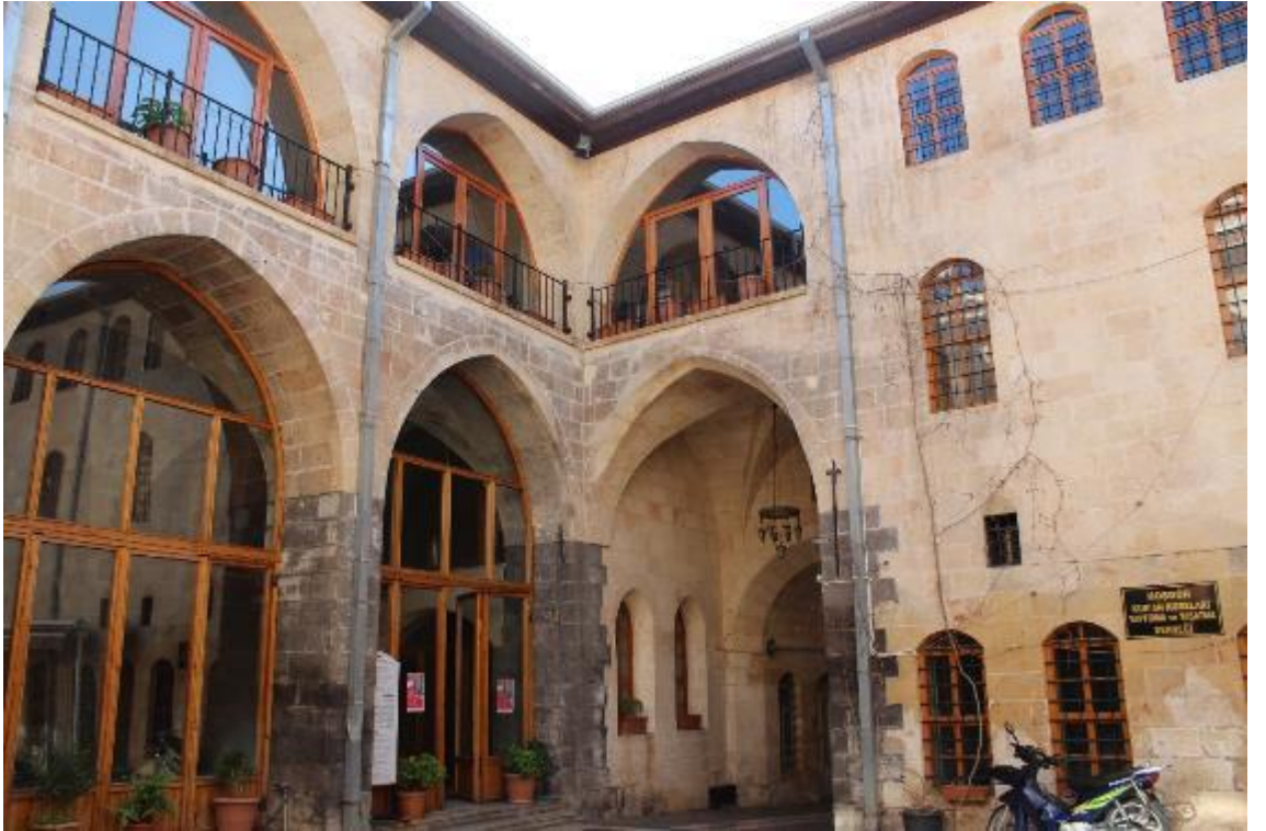
Fotoğraf 485: Gaziantep Kürkçü Sabunhanesi Avluya Bakan Güney ve Doğu Cephe (M. Çiftyürek)
