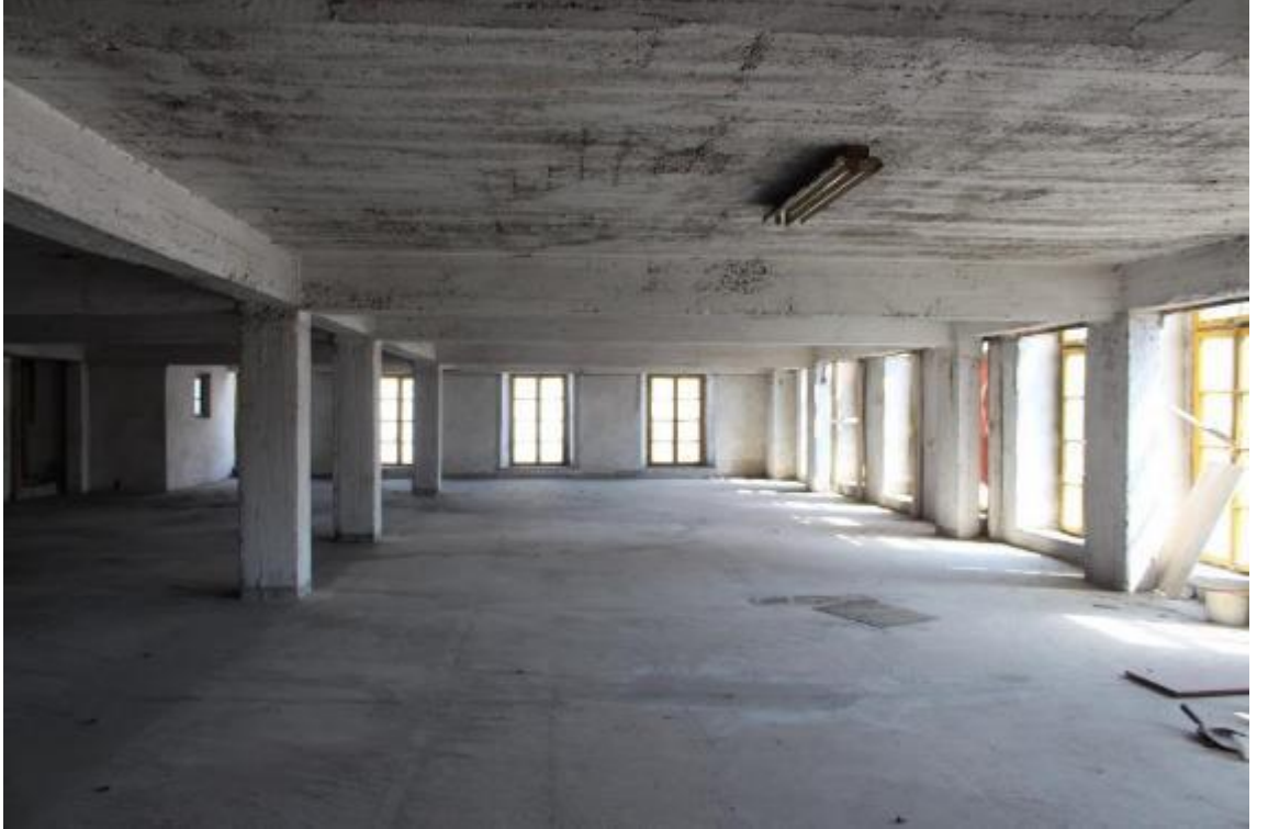
Fotoğraf 296: Konak Sabunhanesi Birinci Katın Kuzey ve Doğu Duvarı (M. Çiftyürek)
