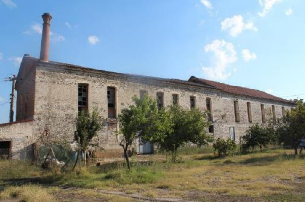
Fotoğraf 171: Havran Eminzade Sabunhanesi Doğu ve Batı Kütlenin Kuzey Cephesi (M.Çiftyürek)
