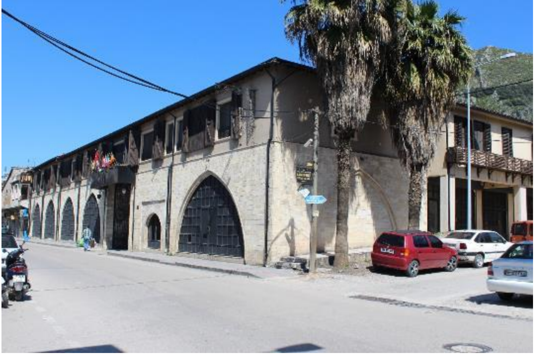
Fotoğraf 397: Antakya Şehoğlu Sabunhanesi Batı ve Güney Cephe (M. Çiftiyürek)
