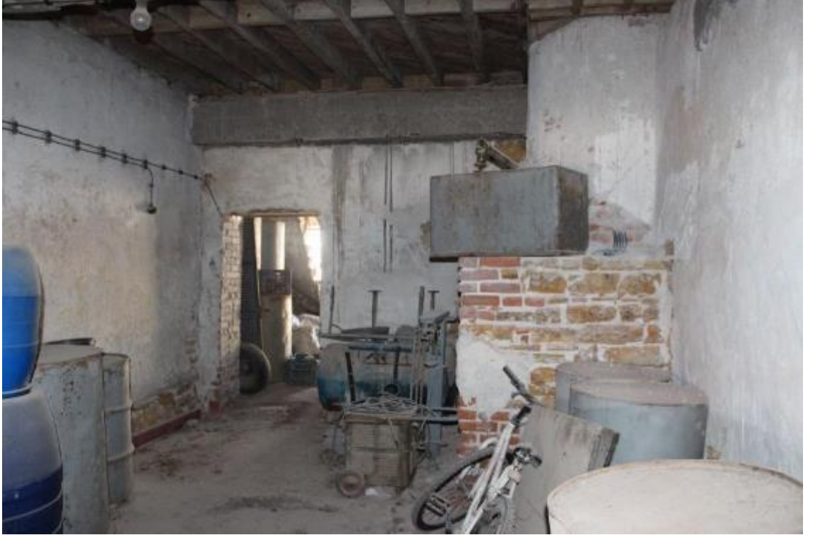
Fotoğraf 256: Burhaniye Pelitköy Halil İbrahim Selçuk Sabunhanesi Kare Kaideli Silindirik Bacadan Görünüş (M. Çiftyürek)
