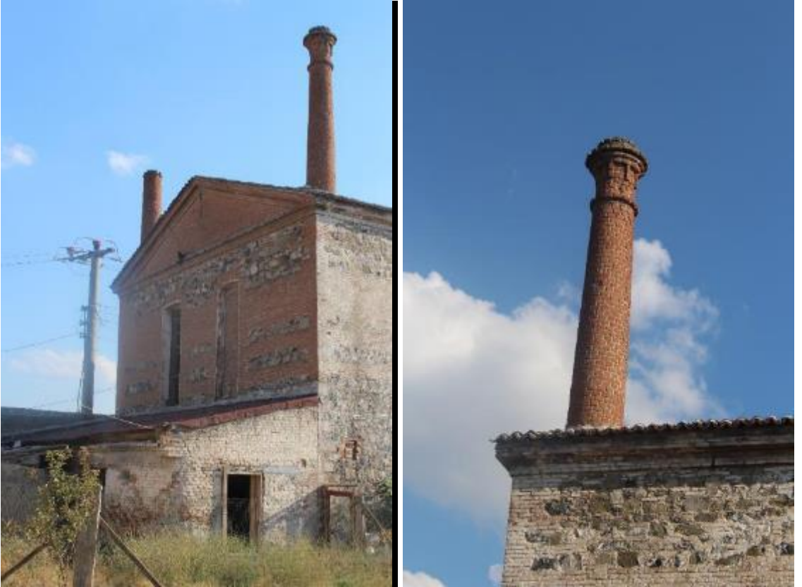
Fotoğraf 172: Havran Eminzade Sabunhanesi Doğu Cephe ve Tuğla Bacalar (M.Çiftyürek)
