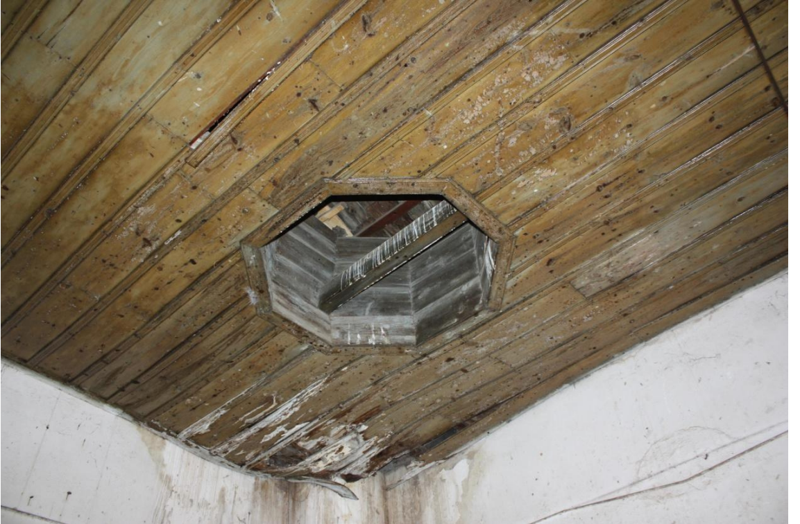
Fotoğraf 190: Burhaniye Hüsni Tolun Sabunhanesi Birinci Katın Tavanındaki Sekizgen Delik (D. Akın, agt, s. 132)
