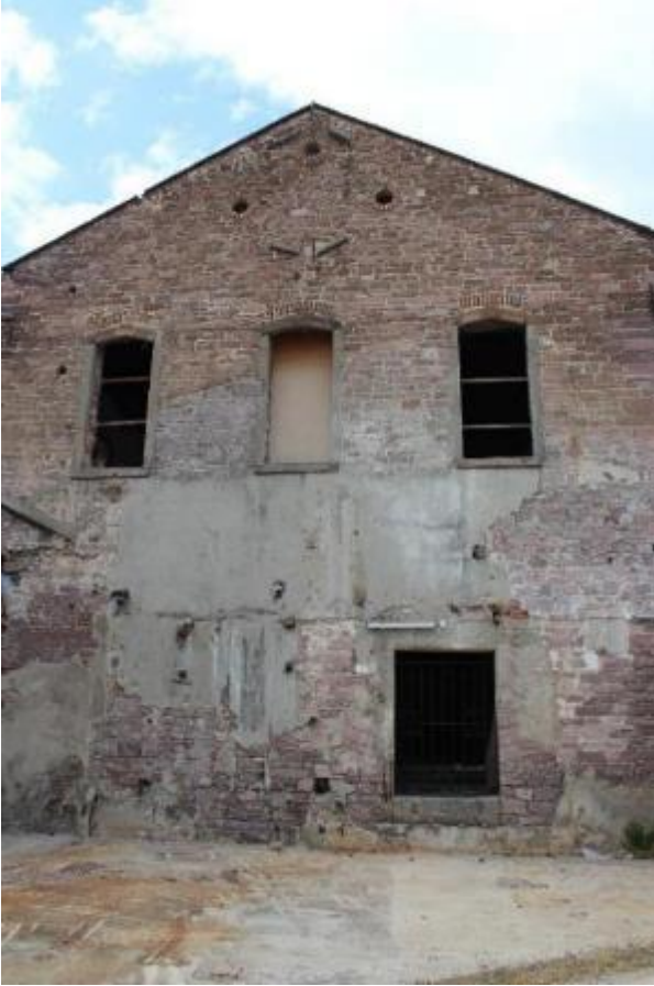
Fotoğraf 130: Ayvalık Fazıl Doğan Sabunhanesi Kuzeydoğu Cephe (M. Çiftyürek)
