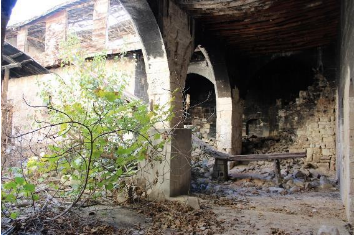
Fotoğraf 603: Nizip Sayınlar Sabunhanesi Batı Bölümdeki Revak (M. Çiftyürek)
