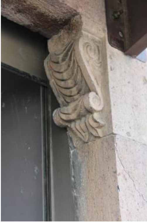
Fotoğraf 114: Burhaniye Yađcı Sabunhanesi Kuzey Cephedeki Kapı Konsolu (M.Çiftyürek)
