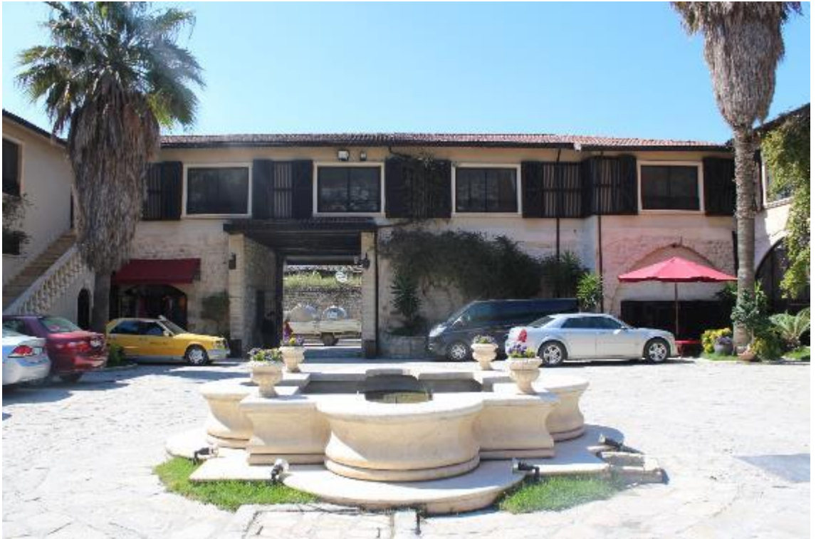
Fotoğraf 407: Antakya Şehoğlu Sabunhanesi Avluya Bakan Batı Cephe (M. Çiftyürek)
