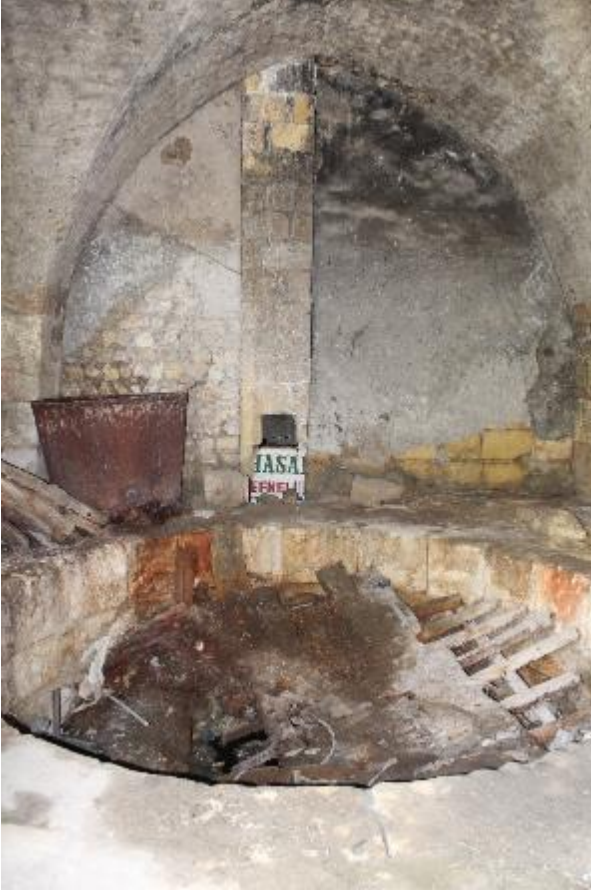
Fotoğraf 349: Antakya Aselcioğlu Sabunhanesi Sabun Kazanı ve Baca (M. Çiftyürek)
