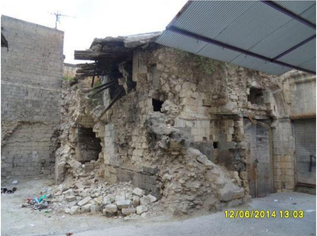
Fotoğraf 853: Birecik Akçakanat Sabunhanesi Doğu ve Güney Cephe, 2014 (Şanlıurfa KVKBKM Arşivi)
