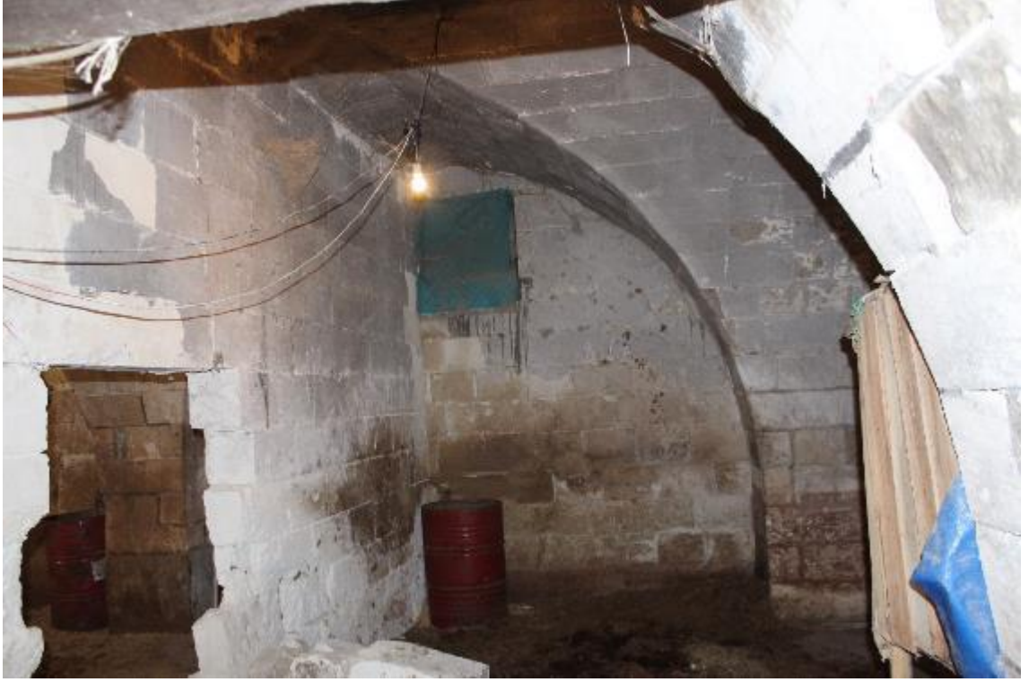
Fotoğraf 542: Birecik Mıstıkođlu Sabunhanesi Avlu Geçidinin Batısındaki Mekân (M. Çiftyürek)
