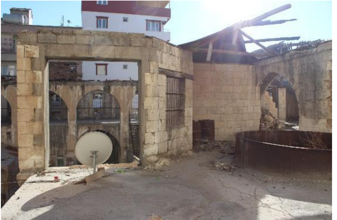
Fotoğraf 687: Nizip Fındıklar Sabunhanesi Birinci Katta Sabun Kazanı (M. Çiftyürek)
