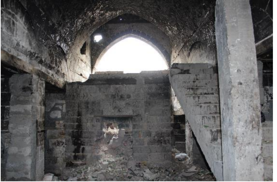
Fotoğraf 861: Birecik Akçakanat Sabunhanesi Zemin Kattaki Sabun Kazanı Ocağı (M. Çiftyürek)
