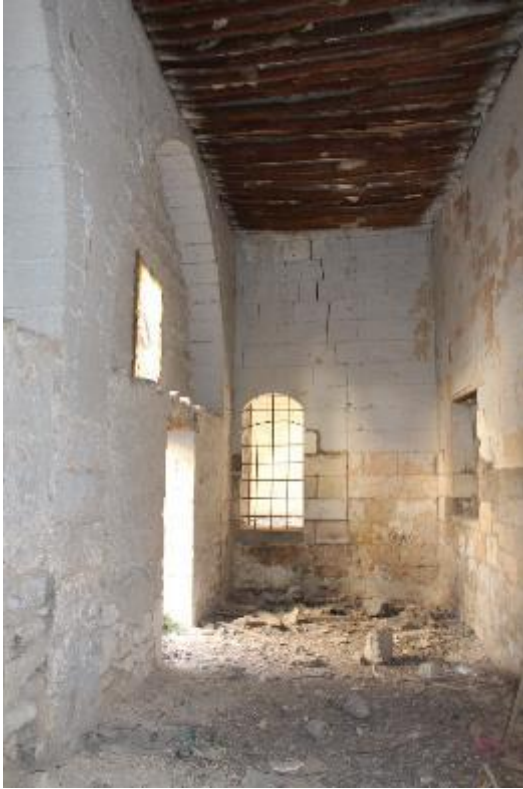
Fotoğraf 609: Nizip Sayınlar Sabunhanesi Güney Bölümdeki Deponun Doğu Duvarı (M. Çiftyürek)
