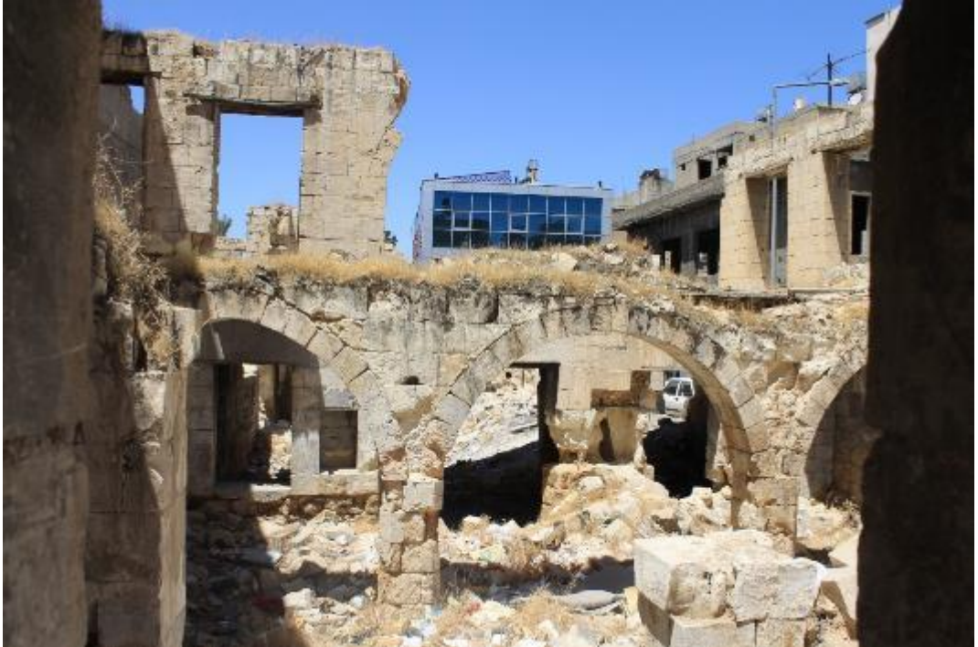
Fotoğraf 741: Nizip Özkaya Sabunhanesi Zemin Kattaki Kemerli Bölümler (Gaziantep KVKBKM Arşivi)
