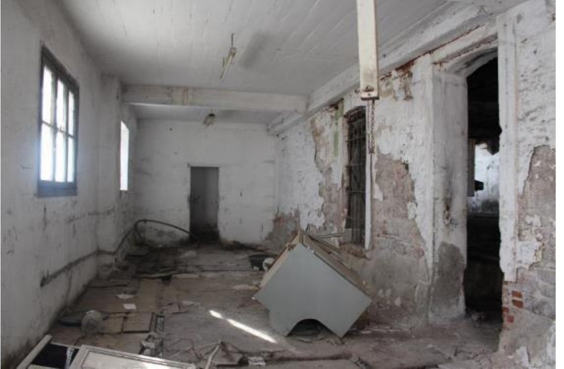
Fotoğraf 168: Ayvalık Ertemler Yağ Deposunun Zemin Katı (M. Çiftyürek)
