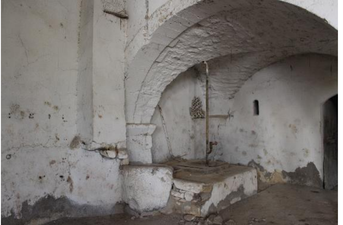
Fotoğraf 645: Kilis Muharrem Bey Sabunhanesi Birinci Sabun Kazanının Bulunduđu Kısım ve Duvara Bağlı Baca (M. Çiftiyörek)
