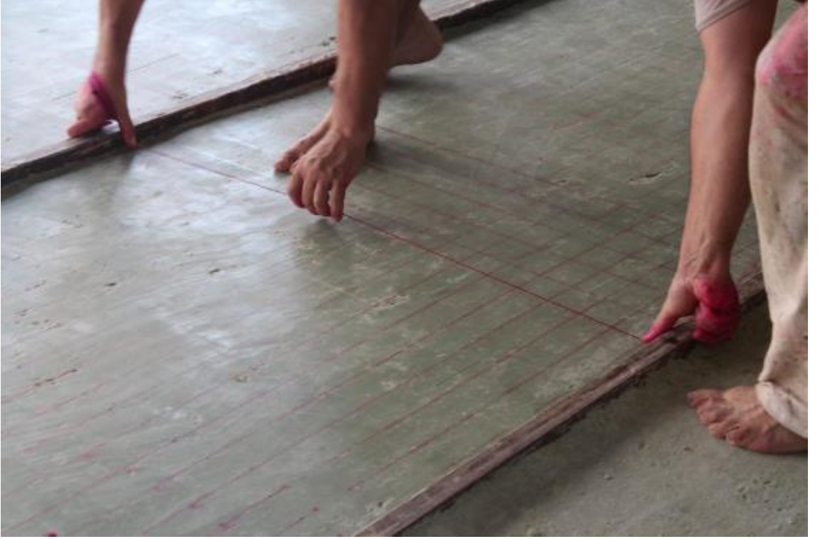
Fotoğraf 42: Çırpılama İşlemi (Ayvalık Karşınlar Sabunhanesi)
