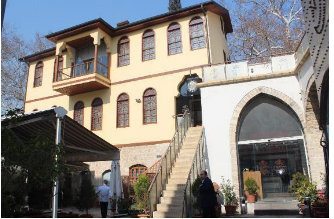
Fotoğraf 784: Kahramanmaraş Cumhuriyet Hanı Sabunhanesi Batı ve Doğu Kütlenin Güney Cephesi (M. Çiftiyürek)
