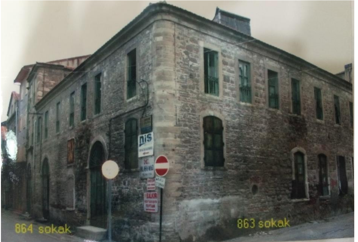
Fotoğraf 288: Konak Hamdi Dalan Sabunhanesi Kuzey ve Batı Cephe, 2009 (Konak Belediyesi Arşivi)
