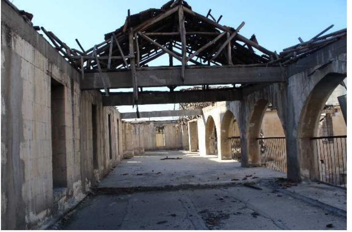
Fotoğraf 690: Nizip Fındıklar Sabunhanesi Güney Bölümün Birinci Katı (M. Çiftyürek)
