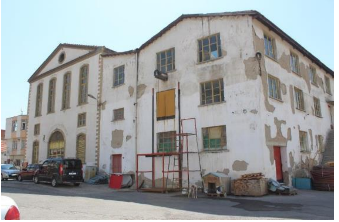
Fotoğraf 295: Konak Sabunhanesi Kuzey Cephe (M. Çiftyürek)
