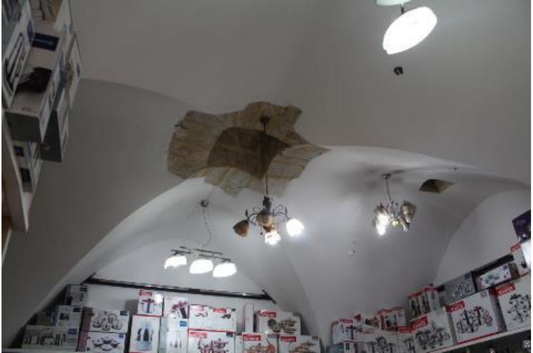
Fotođraf 324: Antakya Haytođlu Sabunhanesi Kuzeybatı apraz Tonozlu Blmdeki Kare Bořluk (M. iftiyrek)
