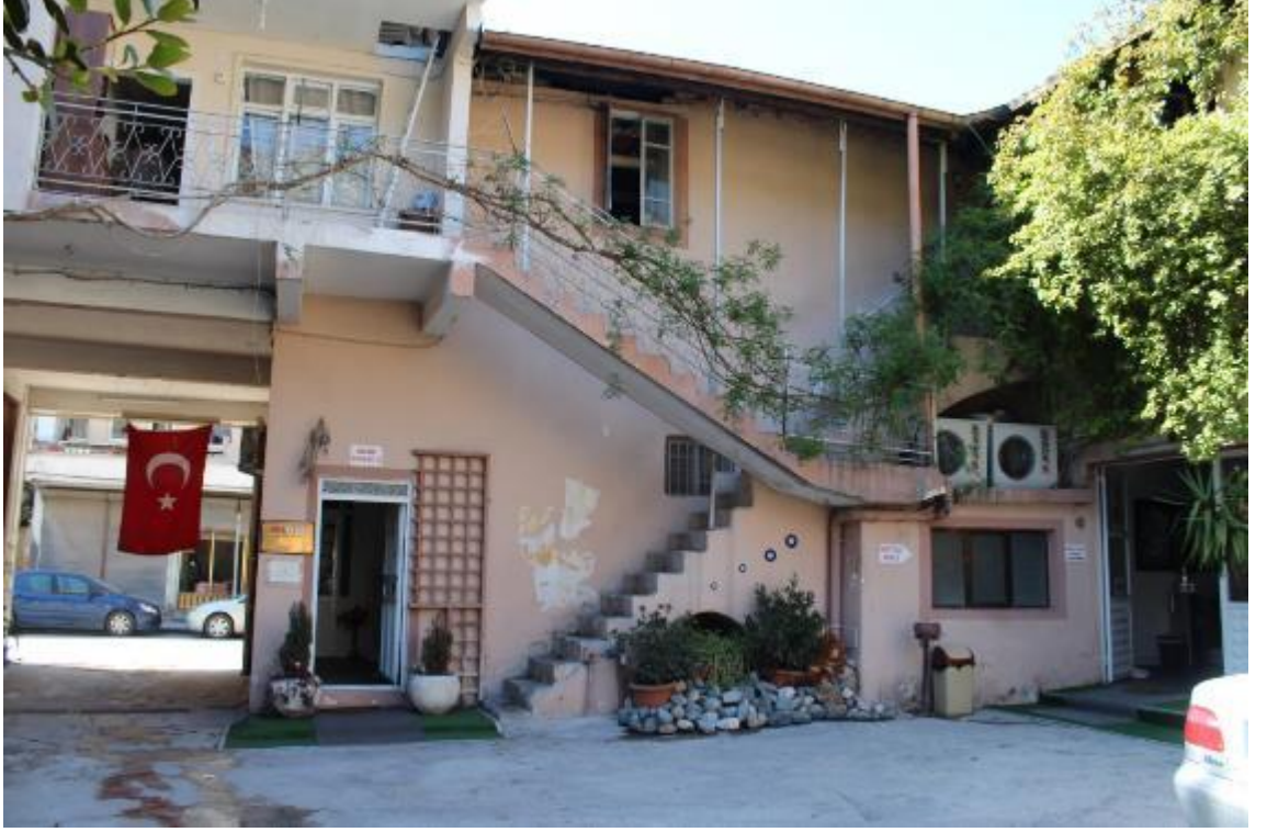
Fotoğraf 428: Antakya Selahattin Ökten Sabunhanesi Avluya Bakan Batı Cephe (M. Çiftyürek)
