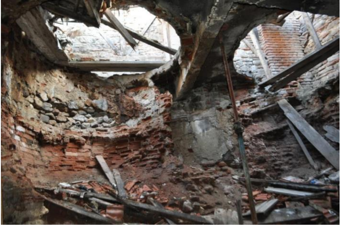
Fotoğraf 278: Konak Hamdi Dalan Sabunhanesi Sabun Kazanlarının Döşemedeki Yeri, 2015 (Konak Belediyesi Arşivi)
