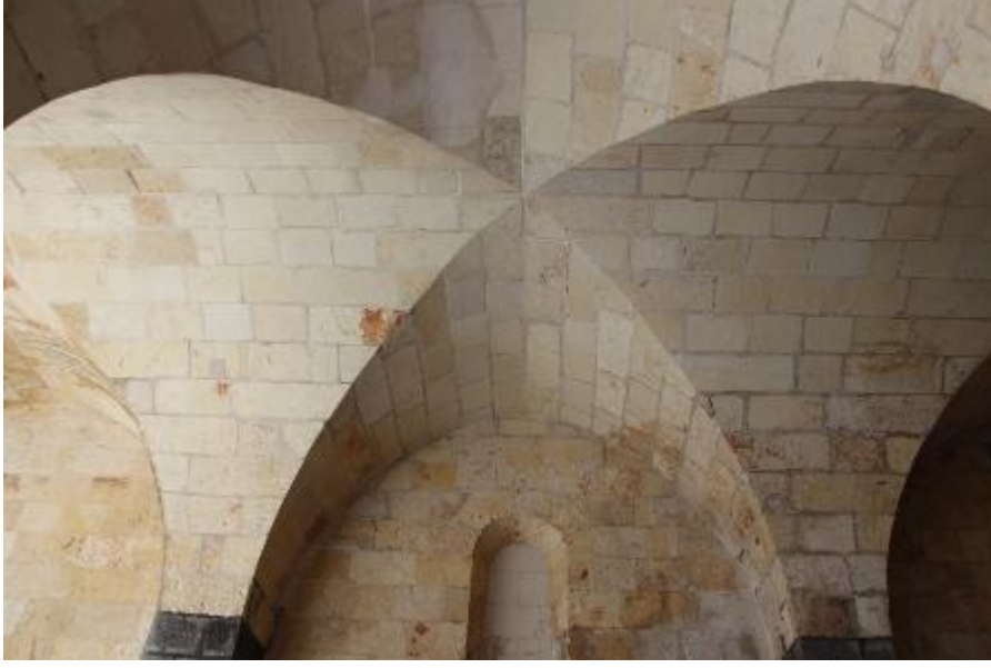
Fotoğraf 496: Gaziantep Kürkçü Sabunhanesi Çapraz Tonoz (M. Çiftyürek)
