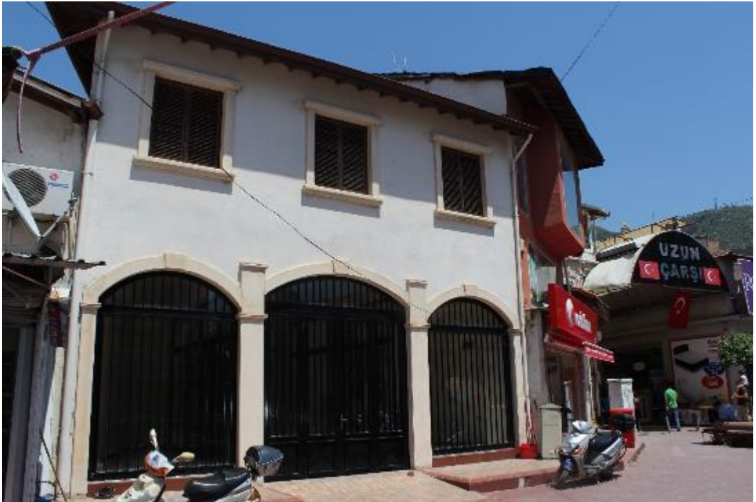
Fotoğraf 461: Antakya Müftüoğlu Sabunhanesi Batı Cephe (M. Çiftyürek)
