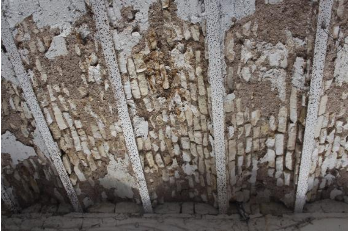
Fotoğraf 667: Kilis Muharrem Bey Sabunhanesi Volta Döşeme (M. Çiftyürek)
