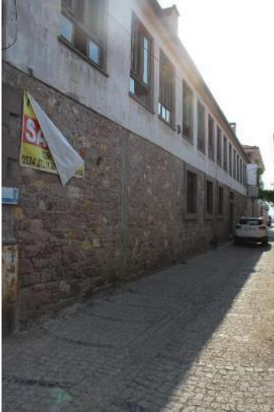
Fotoğraf 142: Ayvalık Cömertler Sabunhanesi Kuzey Cephe (M. Çiftyürek)
