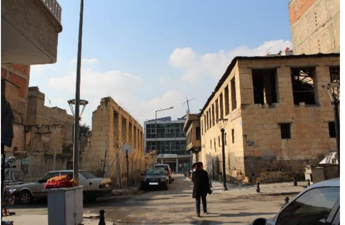
Fotoğraf 731: Nizip Okanlar (sağda) ve Özkaya (solda) Sabunhaneleri (M.Çiftiyürek)
