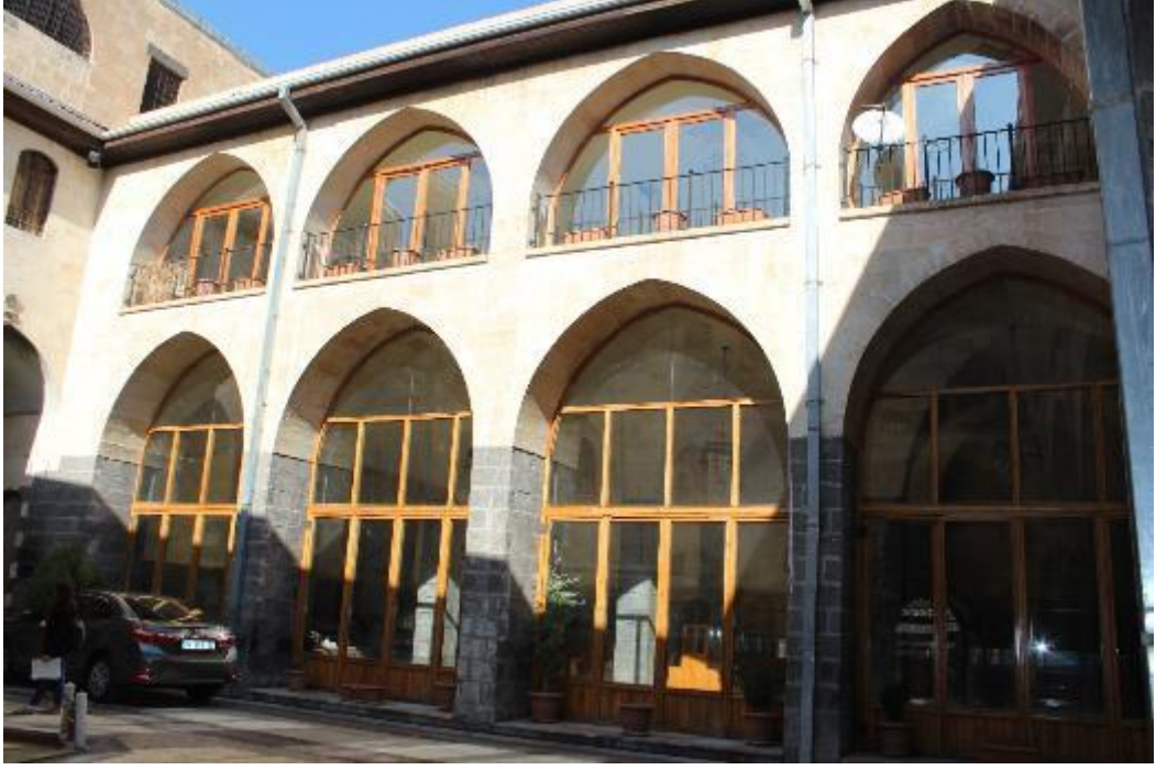
Fotoğraf 494: Gaziantep Kürkçü Sabunhanesi Avluya Bakan Kuzey Cephe (M. Çiftyürek)
