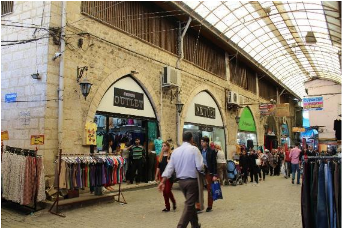
Fotoğraf 336: Antakya Haytoğlu Sabunhanesi Kuzeybatı Cephe (M. Çiftiyürek)
