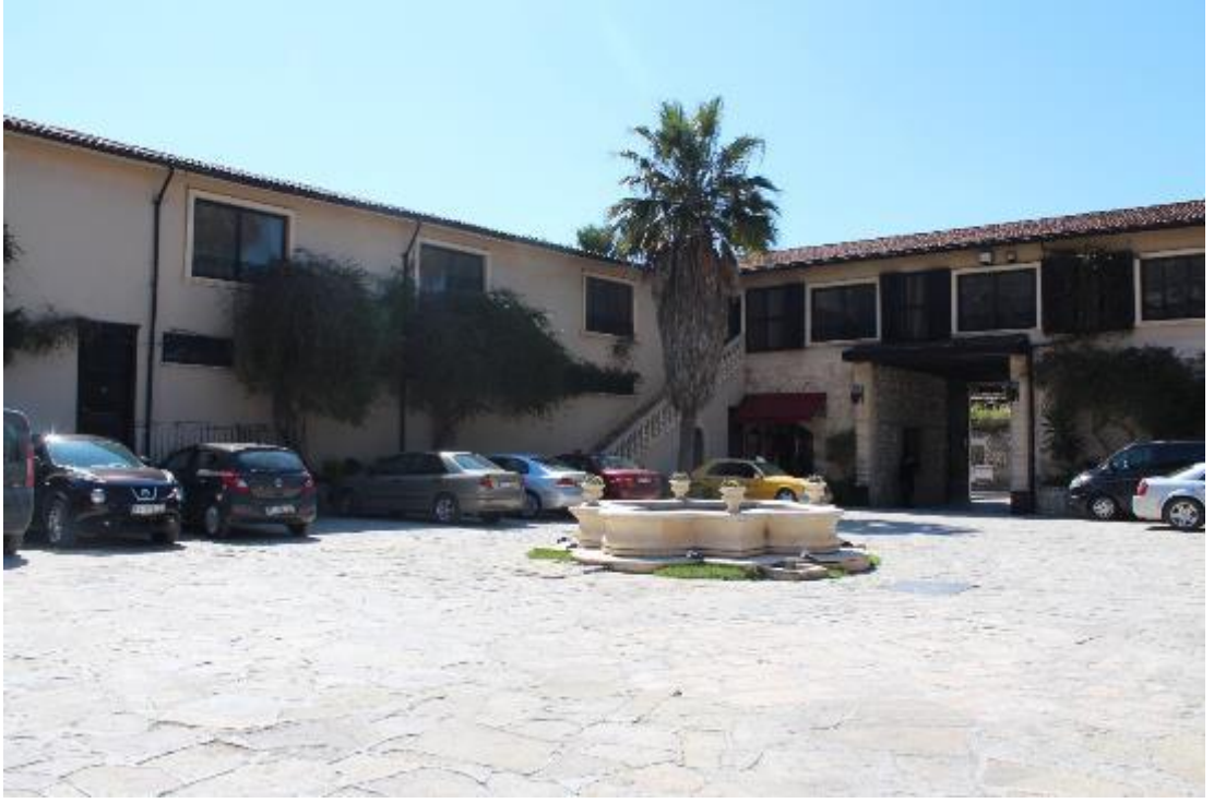
Fotoğraf 408: Antakya Şehoğlu Sabunhanesi Avluya Bakan Batı ve Güney Cephe (M. Çiftyürek)
