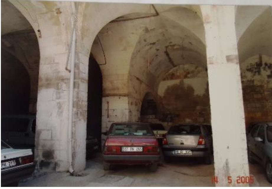
Fotoğraf 488: Gaziantep Kürkçü Sabunhanesi Doğudaki Tonozlu Bölüm, 2005 (Gaziantep KVKBKM Arşivi)
