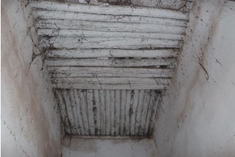
Fotoğraf 637: Kilis Muharrem Bey Sabunhanesi İdari Odanın Doğusundaki Deponun Tavanı (M. Çiftyürek)
