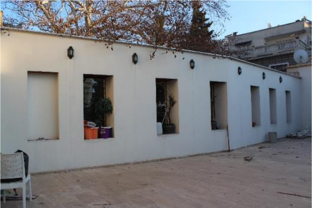
Fotoğraf 793: Kahramanmaraş Cumhuriyet Hanı Sabunhanesi Doğu Kütle Birinci Katın Kuzey Duvarı (M. Çiftyürek)
