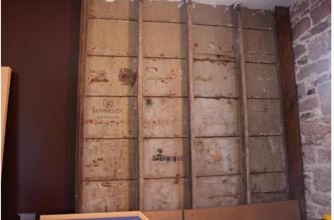
Fotoğraf 104: Ayvalık Sabuncugil Sabunhanesi Birinci Kattaki Sabun Kasalarından Yapılan Bölme Duvar (M.Çiftyürek)
