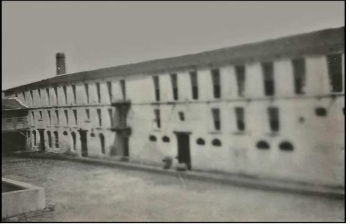
Fotoğraf 242: Ayvalık Gümüşlü Eminzade Sabunhanesi Avluya Bakan Batı Cephe, 1950 (Yakup İçten Arşivi)
