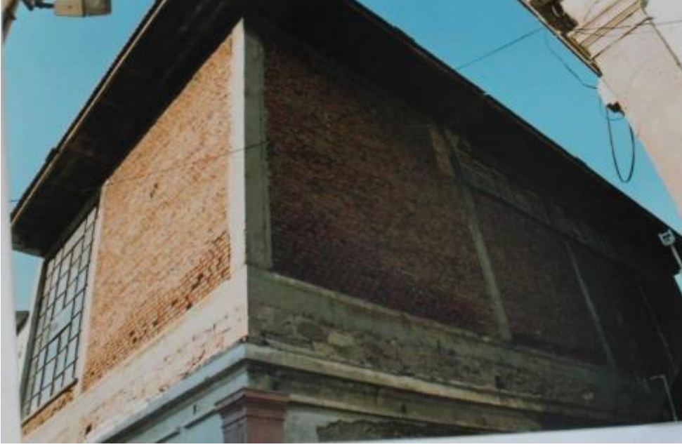
Fotoğraf 83: Ayvalık Hüsni Rıfkı Kazaz Sabunhanesi Restorasyon Öncesi Doğu Cephe (Ayvalık Belediyesi Arşivi)
