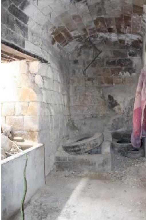
Fotoğraf 539: Birecik Mıstıkoğlu Sabunhanesi Avlu Geçidinin Doğusundaki İlk Mekân (M. Çiftyürek)
