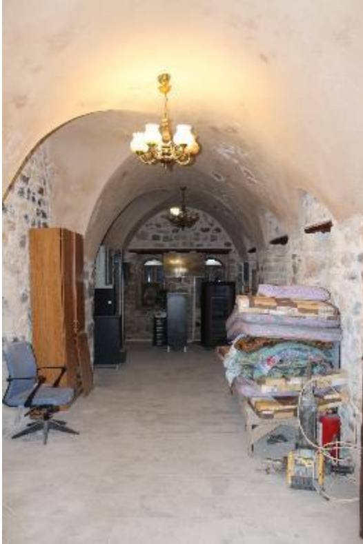
Fotoğraf 757: Kilis Kalaycılar Sabunhanesi Avlu Geçidi Batısındaki Mekân (M. Çiftyürek)
