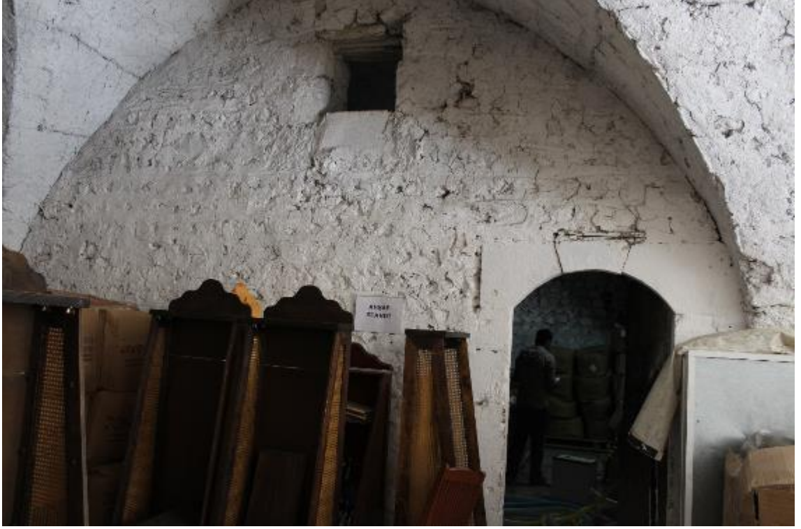
Fotoğraf 426: Antakya Selahattin Ökten Sabunhanesi Kuzeydoğu Köşedeki Mekân (M. Çiftyürek)
