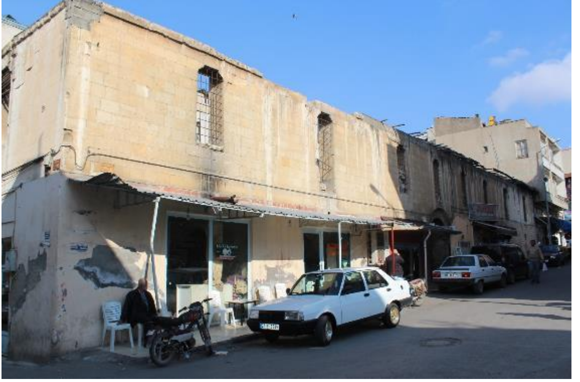
Fotoğraf 670: Nizip Fındıklar Sabunhanesi Güney Cephe (M. Çiftyürek)
