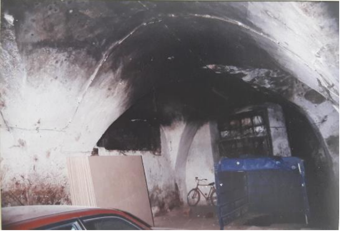
Fotoğraf 464: Antakya Müftüoğlu Sabunhanesi Çapraz Tonozlu Bölümler, 1996 (Hatay KVKBKM Arşivi)
