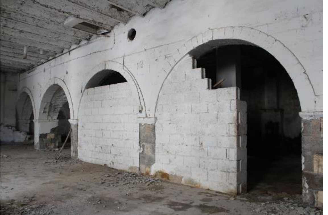
Fotoğraf 643: Kilis Muharrem Bey Sabunhanesi Yuvarlak Kemerleri (M. Çiftyürek)
