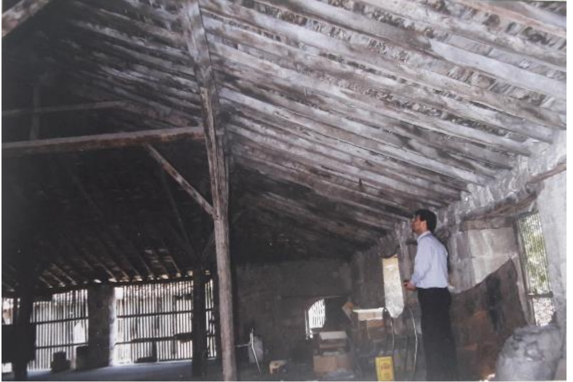
Fotoğraf 473: Antakya Müftüoğlu Sabunhanesi Birinci Katı, 1996 (Hatay KVKBKM Arşivi)
