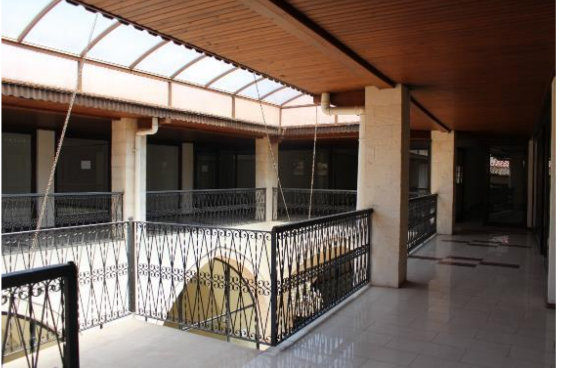
Fotoğraf 476: Antakya Müftüoğlu Sabunhanesi Birinci Katı (M. Çiftürek)
