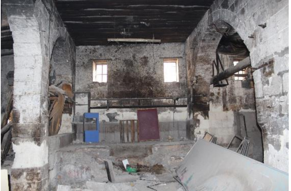
Fotoğraf 719: Nizip Okanlar Sabunhanesi Doğu Bölümün Doğu Duvarı (M.Çiftyürek)
