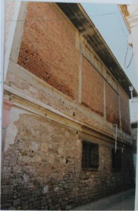
Fotoğraf 84: Ayvalık Hüsni Rıfkı Kazaz Sabunhanesi Restorasyon Öncesi Doğu Cephe (Ayvalık Belediyesi Arşivi)
