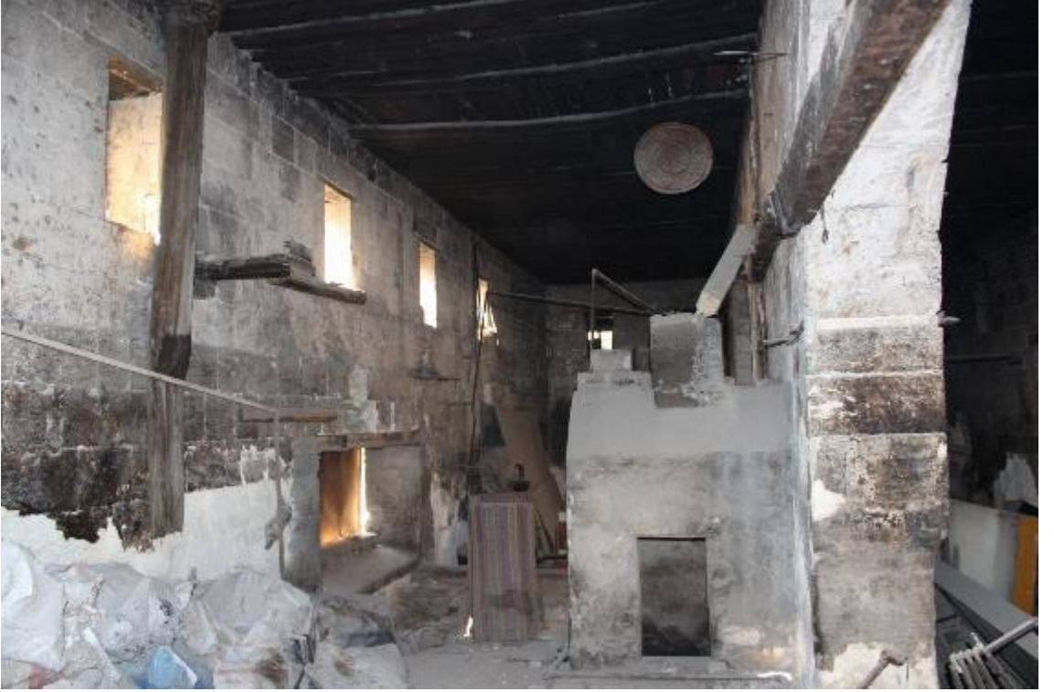
Fotoğraf 707: Nizip Okanlar Sabunhanesi Doğu Bölümün Güney Duvarı ve Ocak (M.Çiftyürek)
