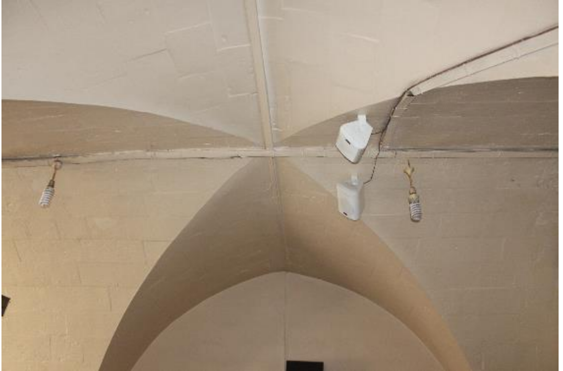
Fotoğraf 679: Nizip Fındıklar Sabunhanesi Çapraz Tonozu (M. Çiftyürek)
