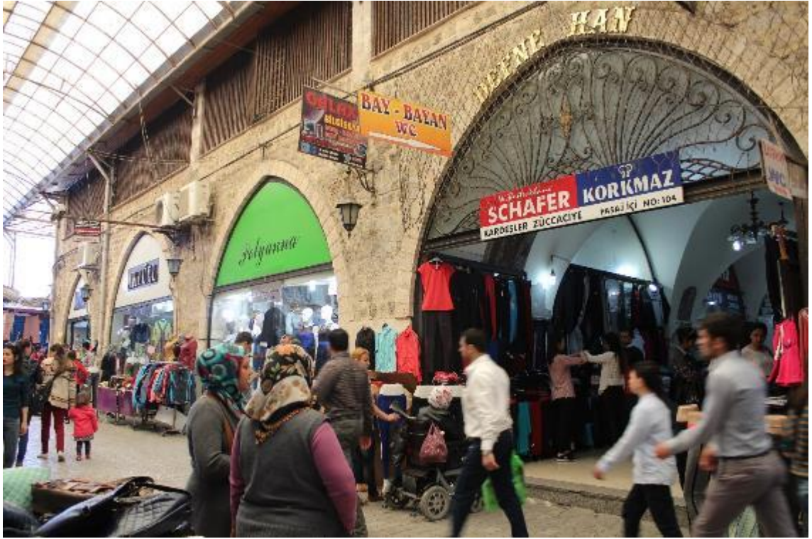
Fotoğraf 335: Antakya Haytoğlu Sabunhanesi Kuzeybatı Cephe (M. Çiftiyürek)
