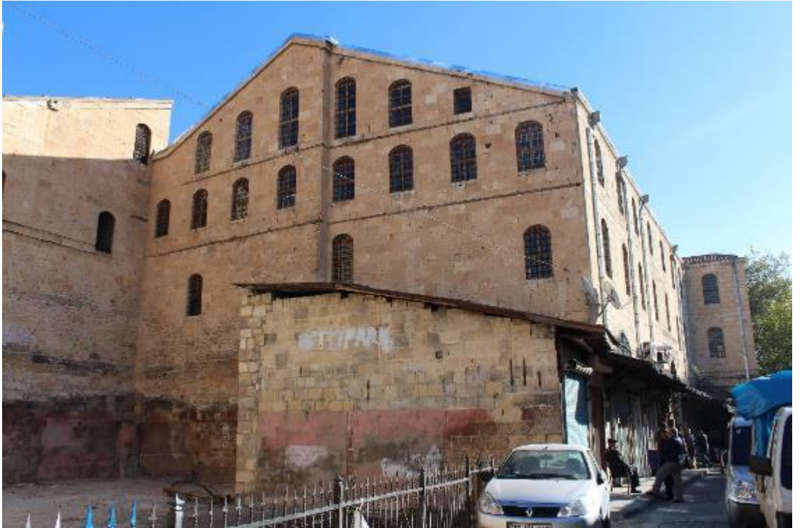
Fotoğraf 505: Gaziantep Kürkçü Sabunhanesi Batı Cephe (M. Çiftiyürek)
