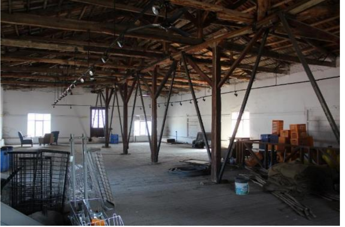
Fotoğraf 109: Burhaniye Yağcı Sabunhanesi Birinci Katın Kuzey ve Doğu Duvarı (M.Çiftyürek)
