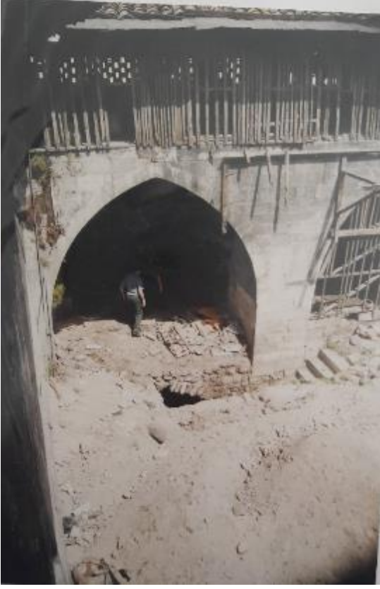
Fotoğraf 325: Antakya Haytoğlu Sabunhanesi Avluya Bakan Kuzeybatı Cephe, 2003 (Hatay KVKBKM Arşivi)
