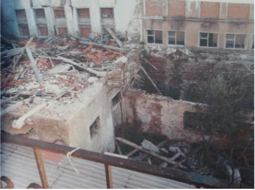
Fotoğraf 137: Ayvalık Fevzi Paşa Mahallesi Sabunhanesi Kuzeybatı Cephe ve Müştemilat, 2012 (Bursa KVKBKM Arşivi)
