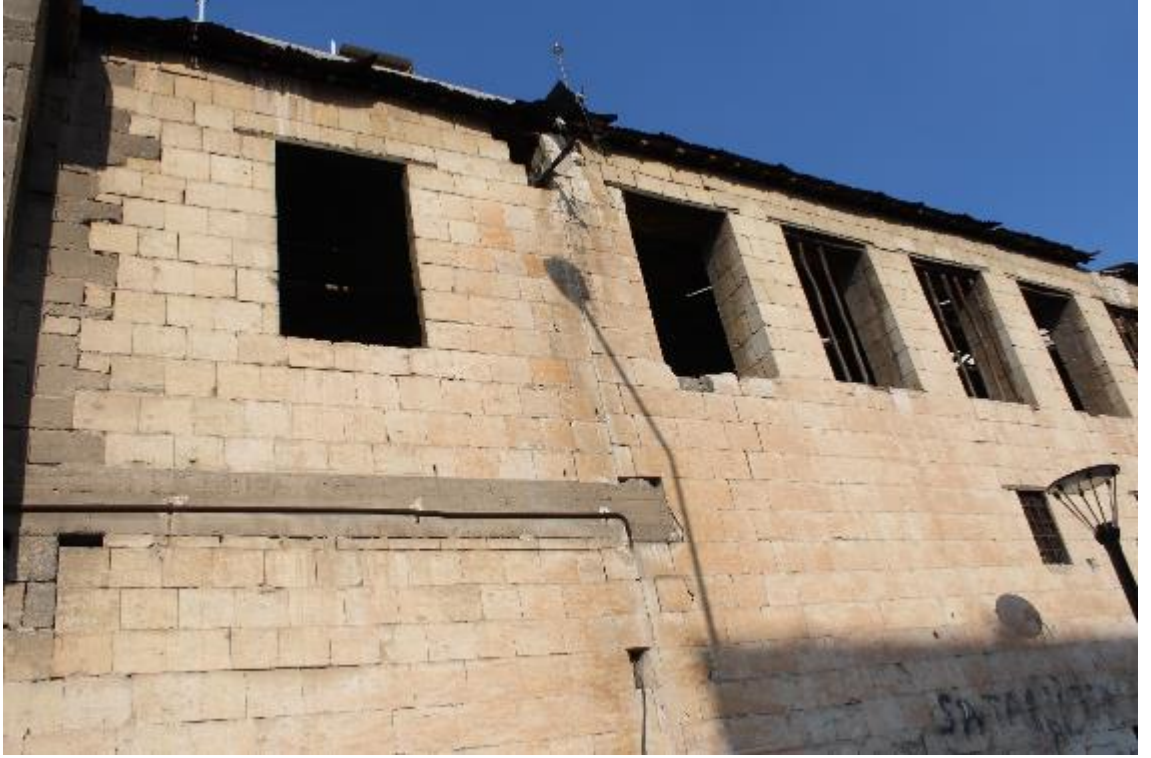
Fotoğraf 729: Nizip Okanlar Sabunhanesi Güney Cephe (M.Çiftyürek)
