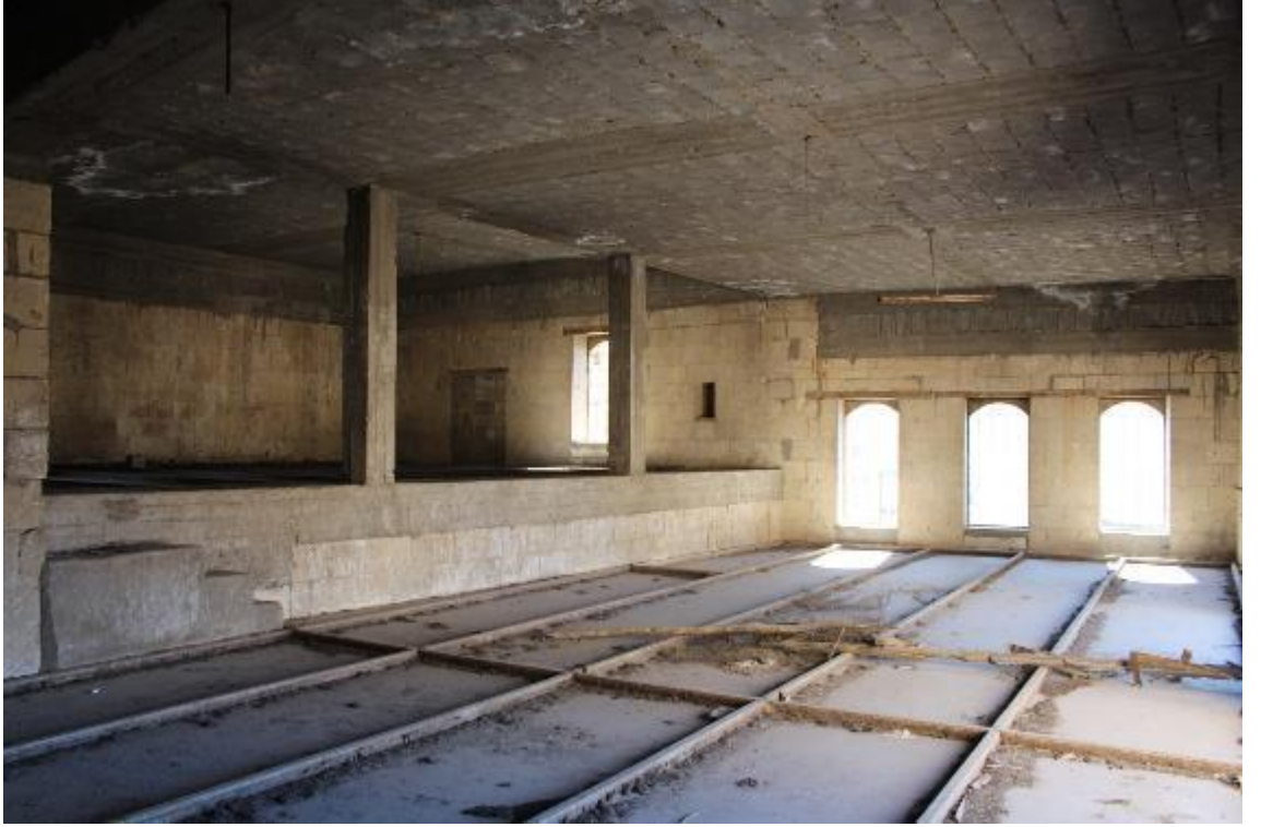
Fotoğraf 615: Nizip Sayınlar Sabunhanesi Doğu Bölümün Birinci Katı (M. Çiftyürek)
