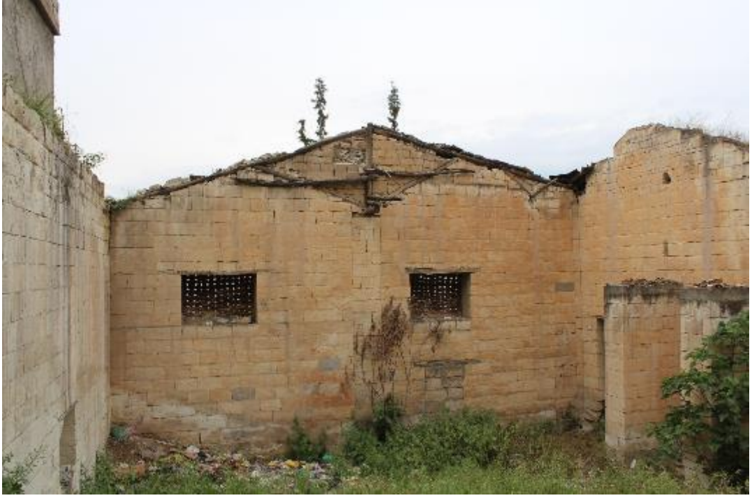
Fotoğraf 554: Birecik Mıstıkođlu Sabunhanesi Güney Bölümün Gerisindeki Mekânlar (M. Çiftyürek)
