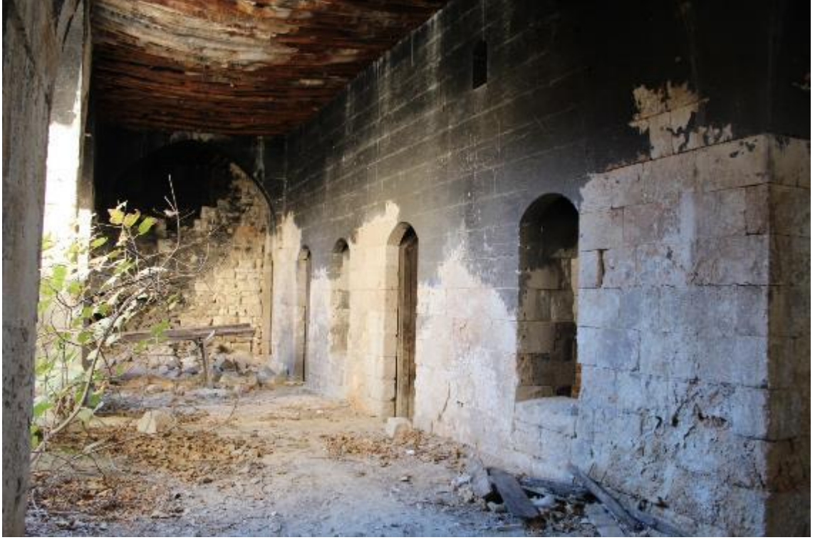
Fotoğraf 602: Nizip Sayınlar Sabunhanesi Batı Bölümdeki Revak ve Odalar (M. Çiftyürek)
