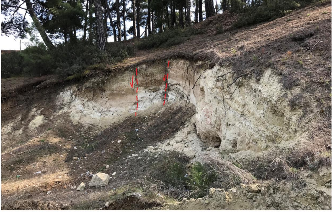
Şekil 3.9 : Şekil 3.8’de gözlenen fayın güneyindeki faya paralel gelişen küçük faylar (GD’ya bakış)
