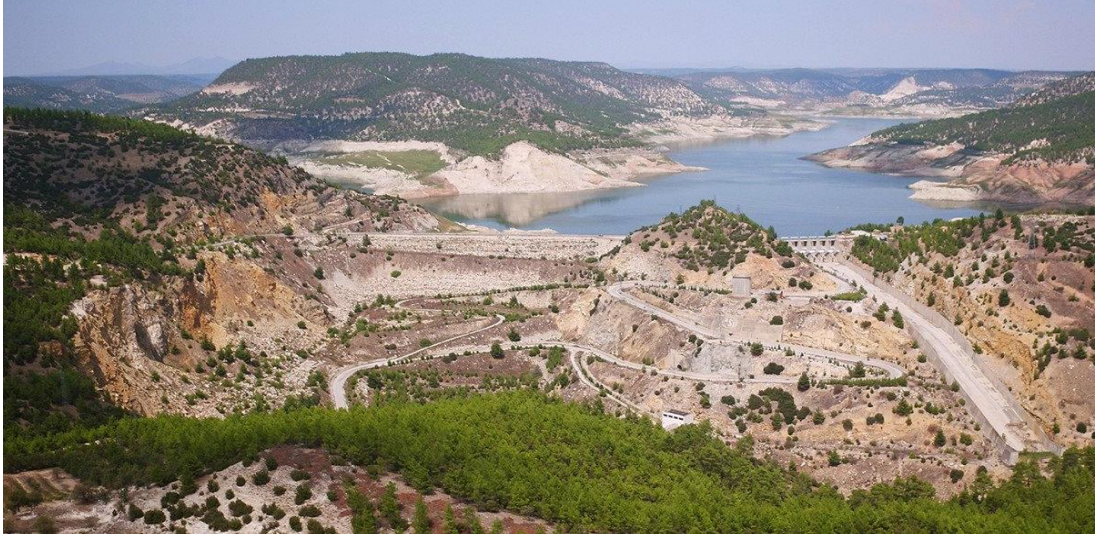
Şekil 2.3: Adıgüzel barajı ( https://bolge21.dsi.gov.tr/ ).
