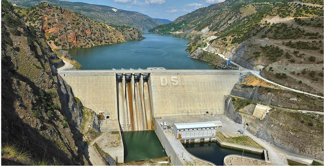
Şekil 2.8: Cindere barajı( http://www.ozaltin.com.tr/ ).
