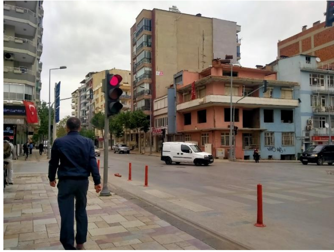
Şekil 4. 130: Mevcut yıkık yapılar
