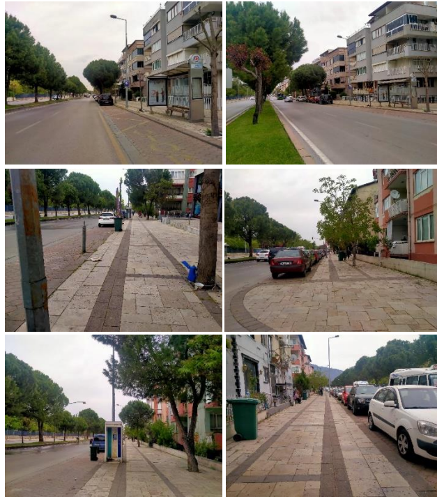
Şekil 4. 113: Mevcut yolun bir tarafından görünüm
